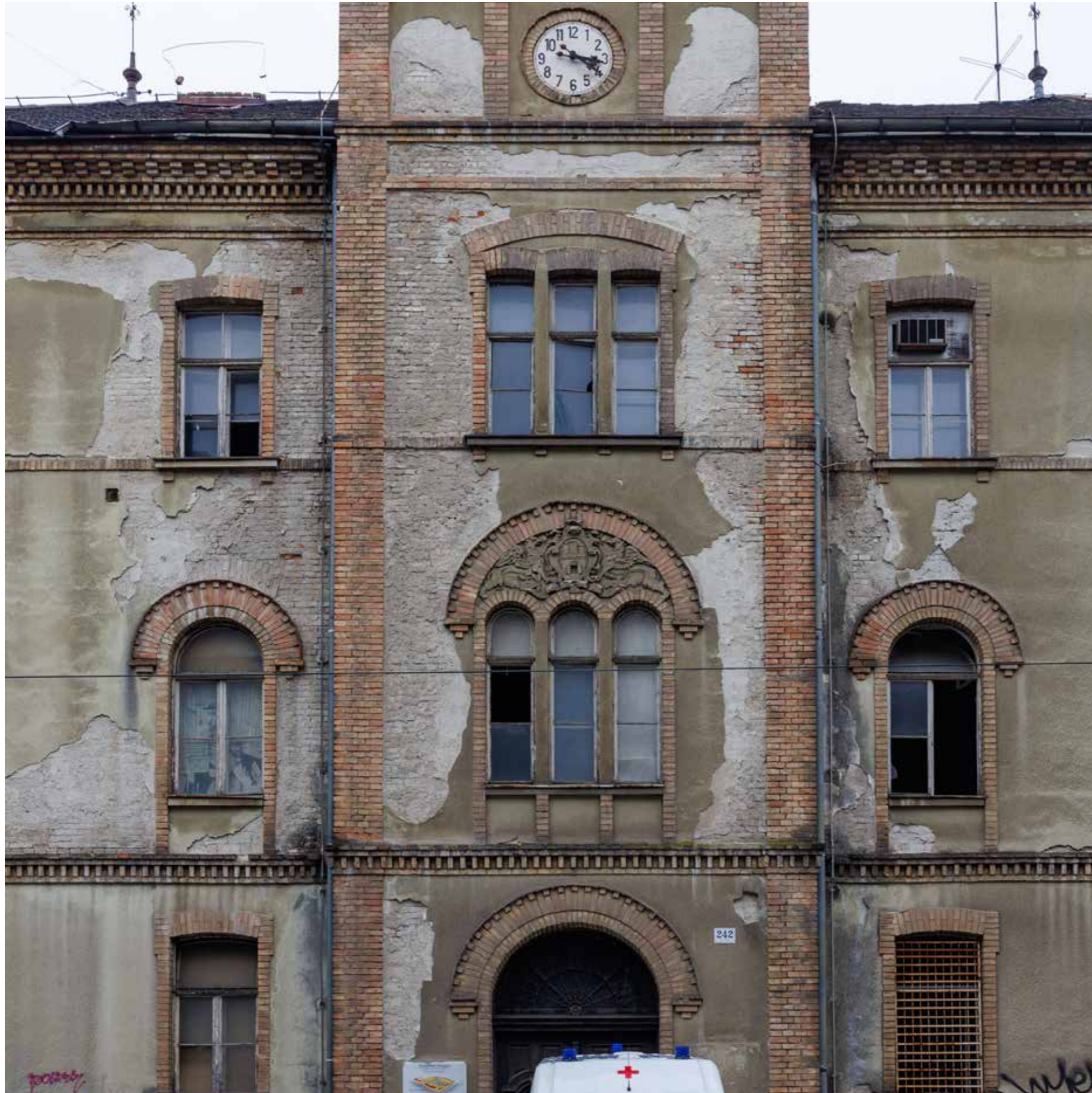
Južno pročelje, detalj rizalita
