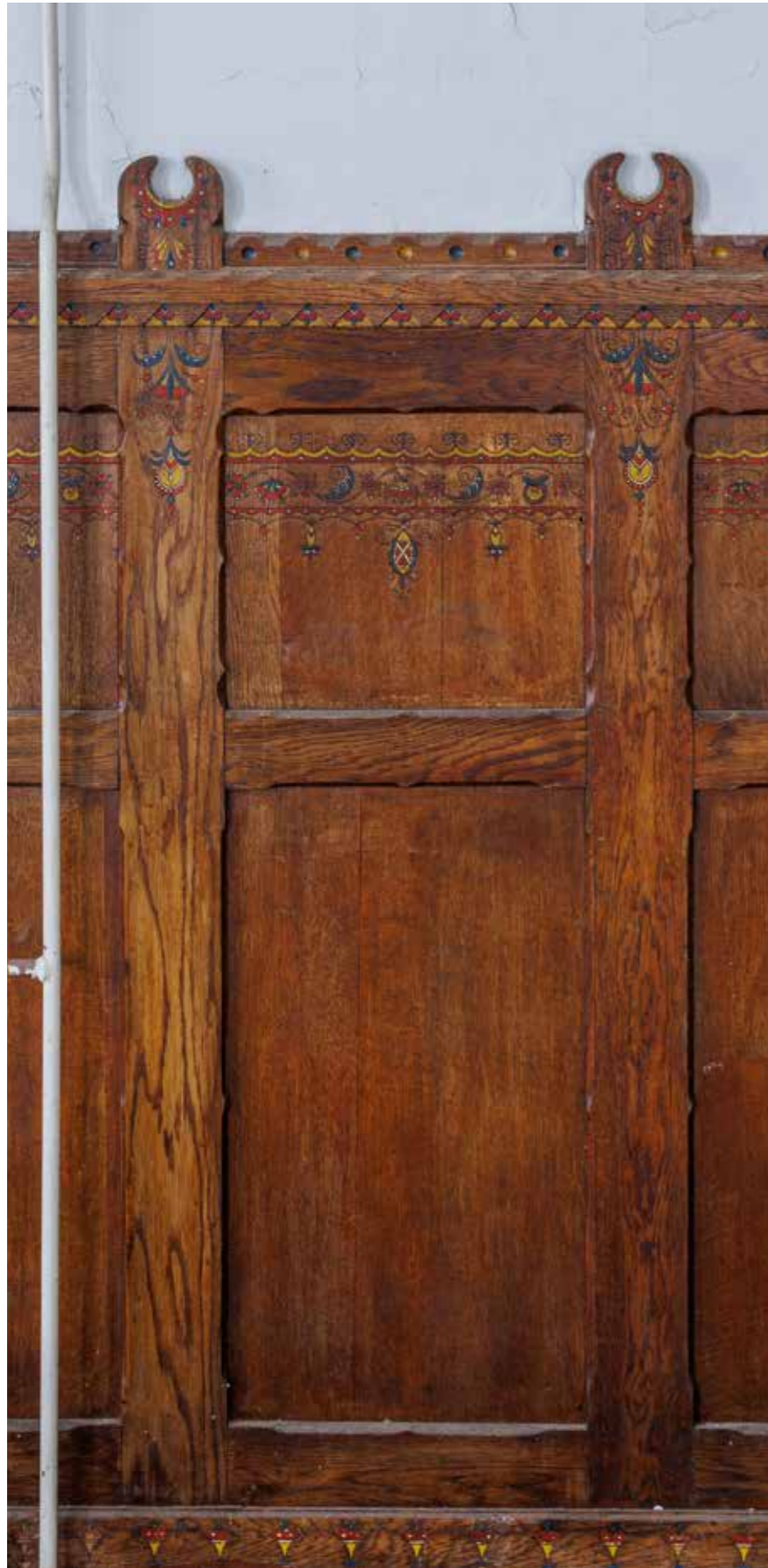
Drvena oplata na drugom katu
