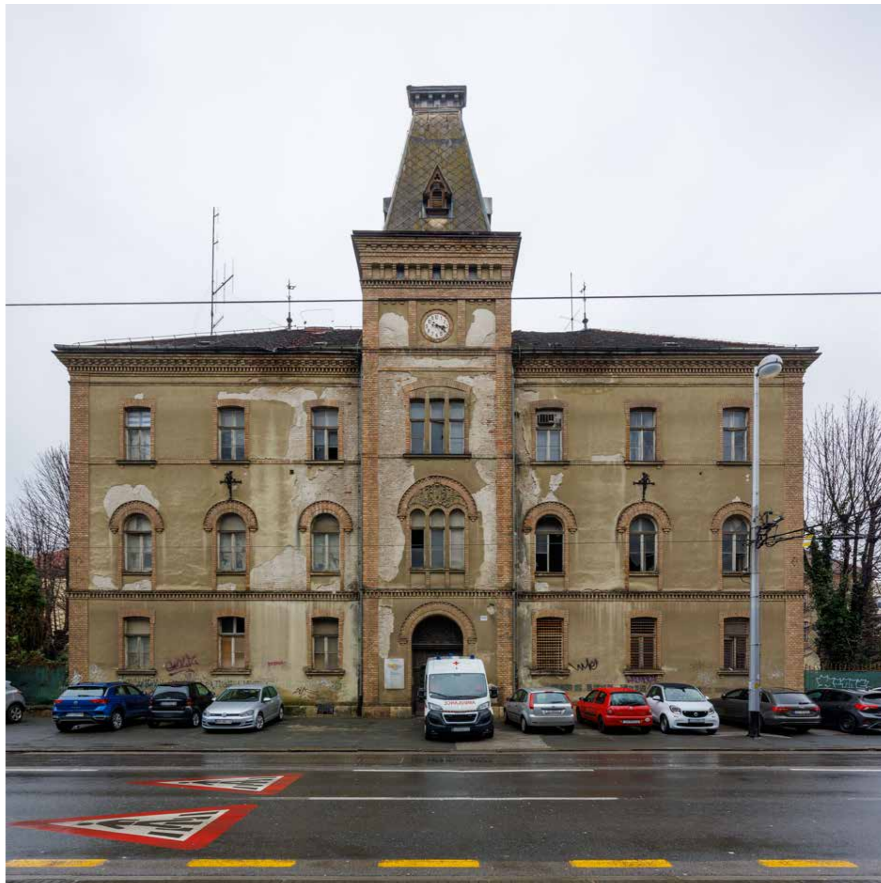
Zgrada pisarnice, južno pročelje
