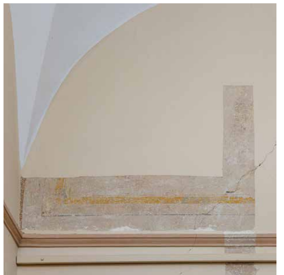
Trijem atrija u prizemlju, sonde na svodu, pojasnici i u luneti
