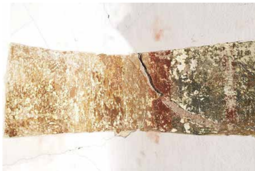
Sonde na zidu i stropu
