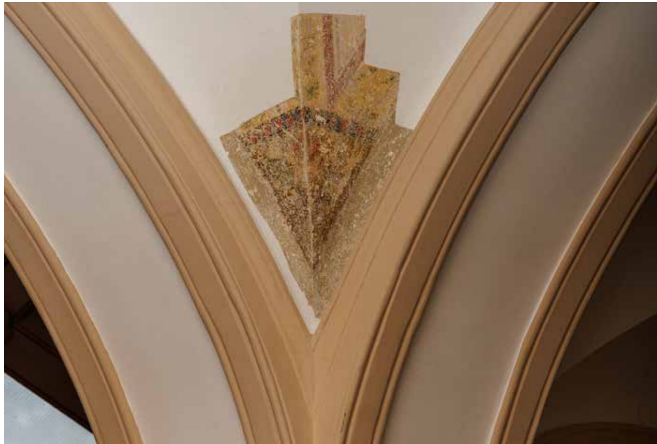
Trijem atrija na drugom katu Sonde na svodu i kapitelu
