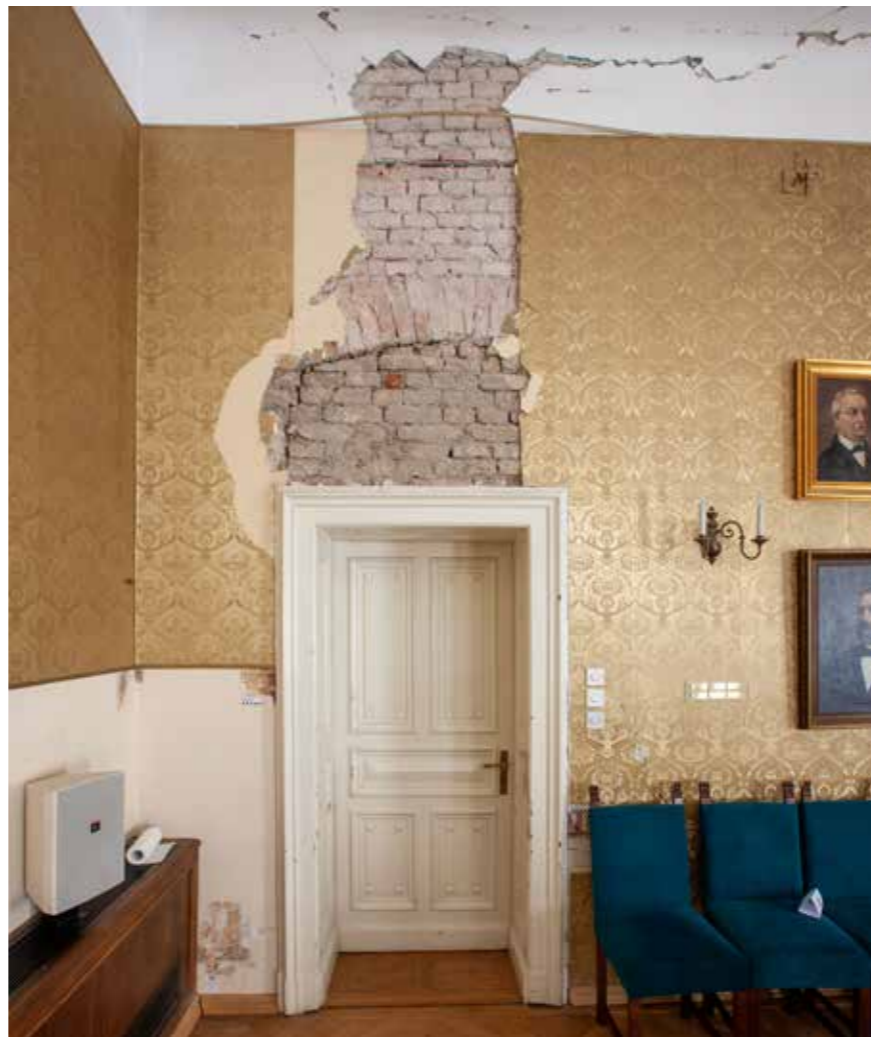
Velika sjednička dvorana na prvom katu Sonde na zidu i stropu
