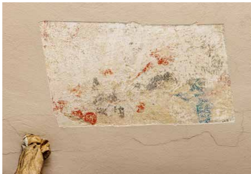
Sjeveroistočni salon na prvom katu Sonda na stropu
