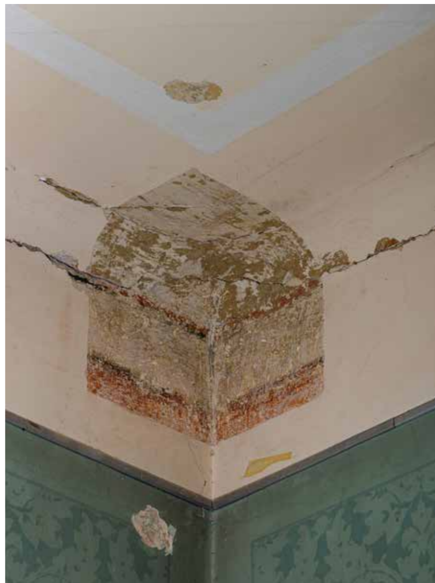
Sonde na zidu i stropu
