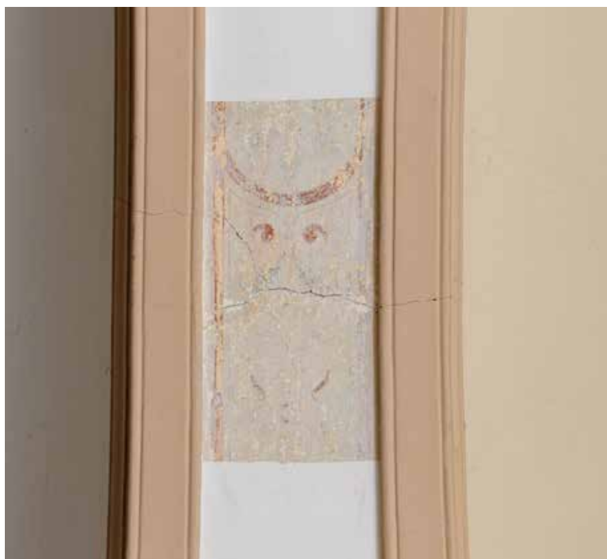
Ulazni prostor u prizemlju Sonde na svodu, pojasnici i zidu
