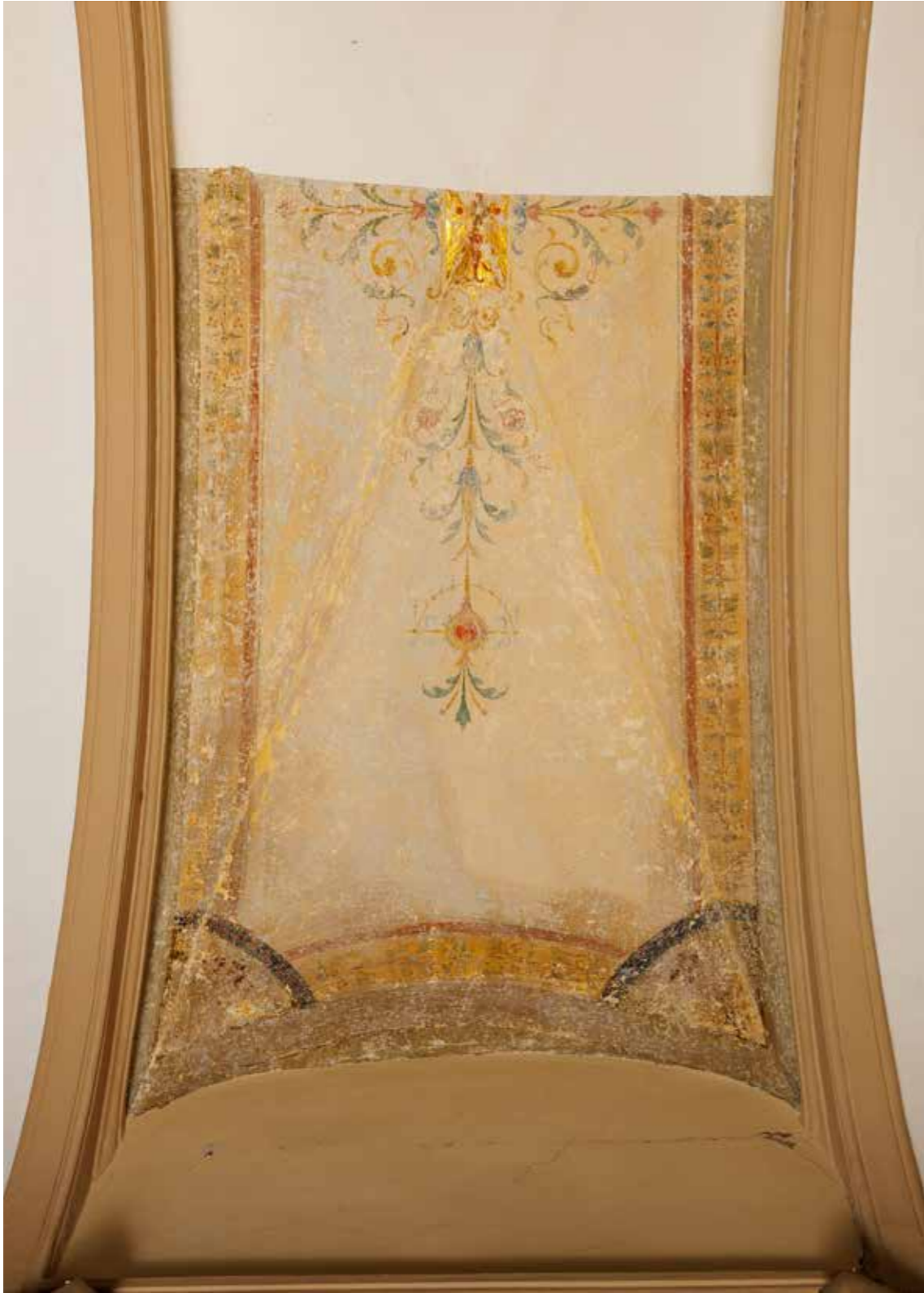
Trijem atrija na drugom katu, sonde na svodovima
