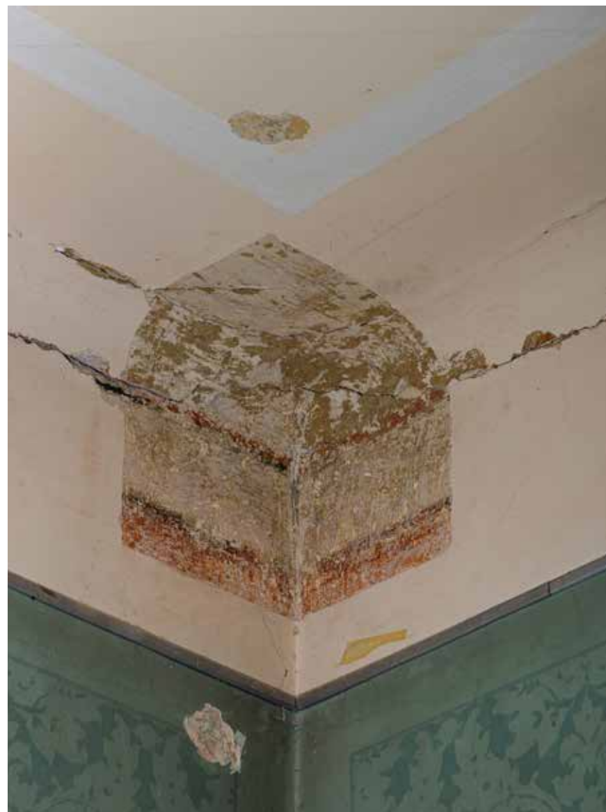
Sonde na zidu i stropu
