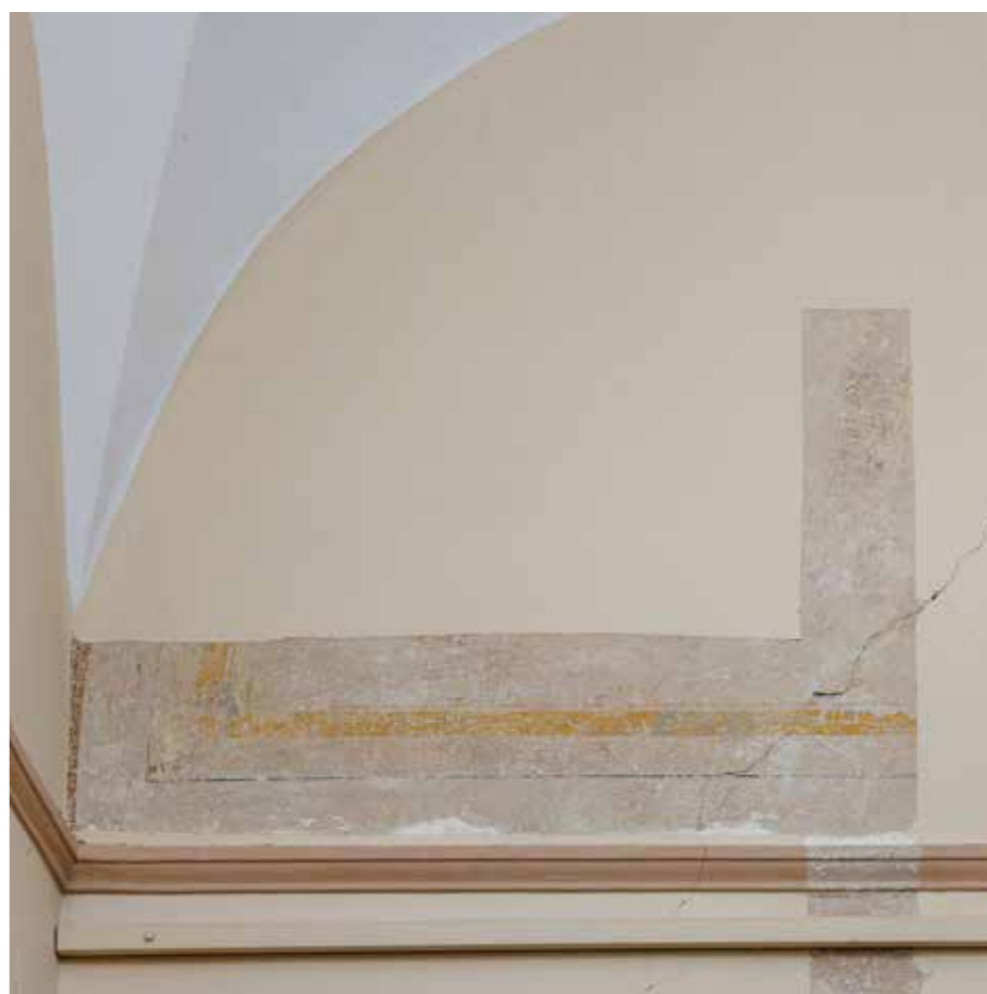
Trijem atrija u prizemlju, sonde na svodu, pojasnici i u luneti
