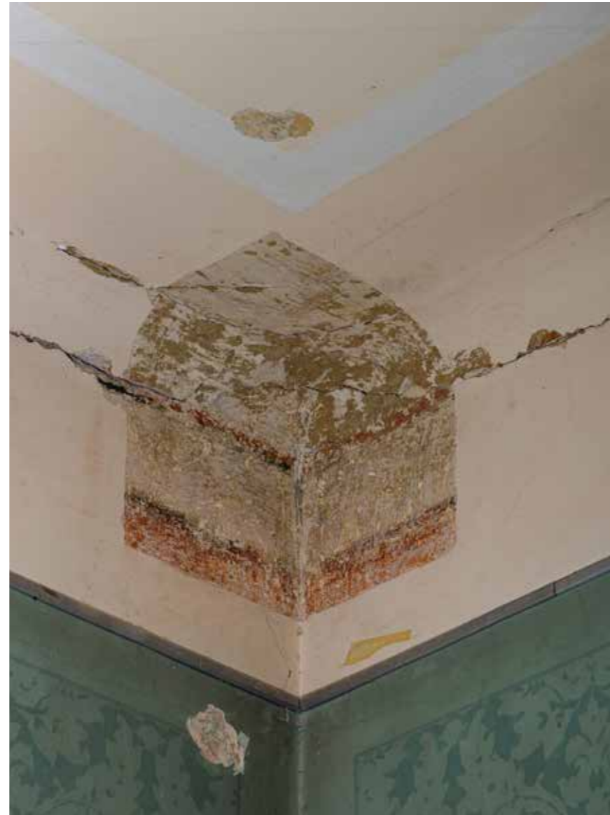
Sonde na zidu i stropu
