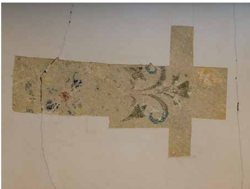
Velika sjednička dvorana, sonde na stropu
