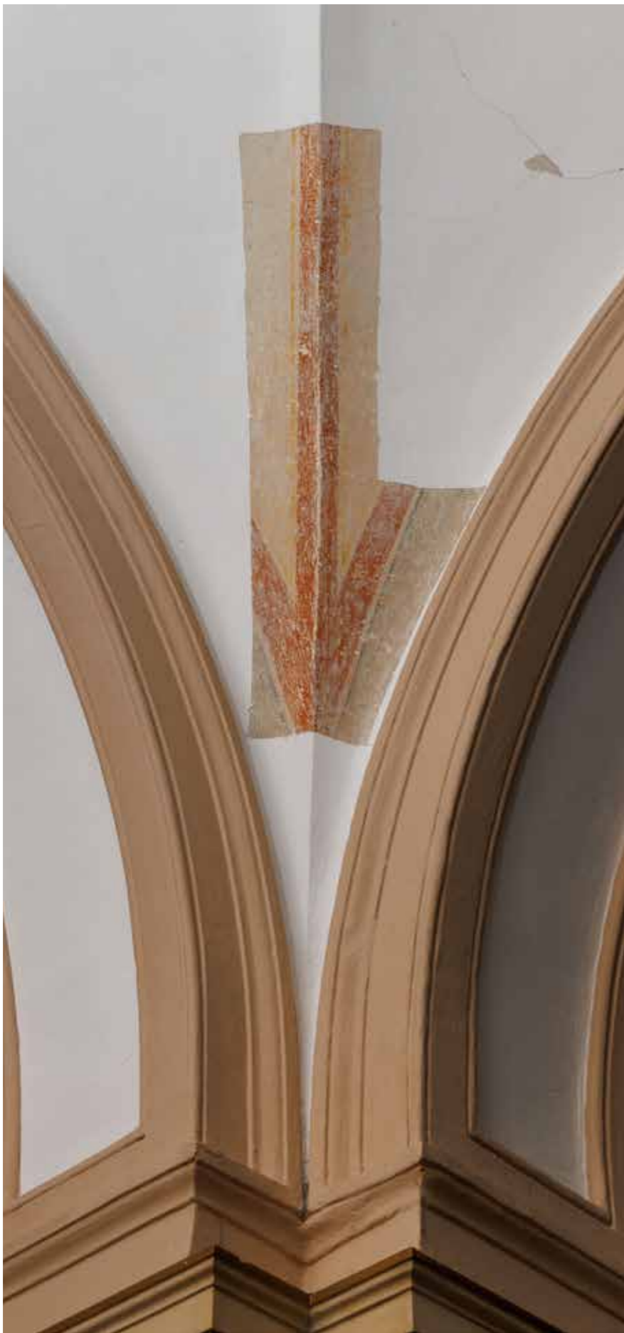
Trijem atrija u prizemlju, sonde na svodu, pojasnici i u luneti
