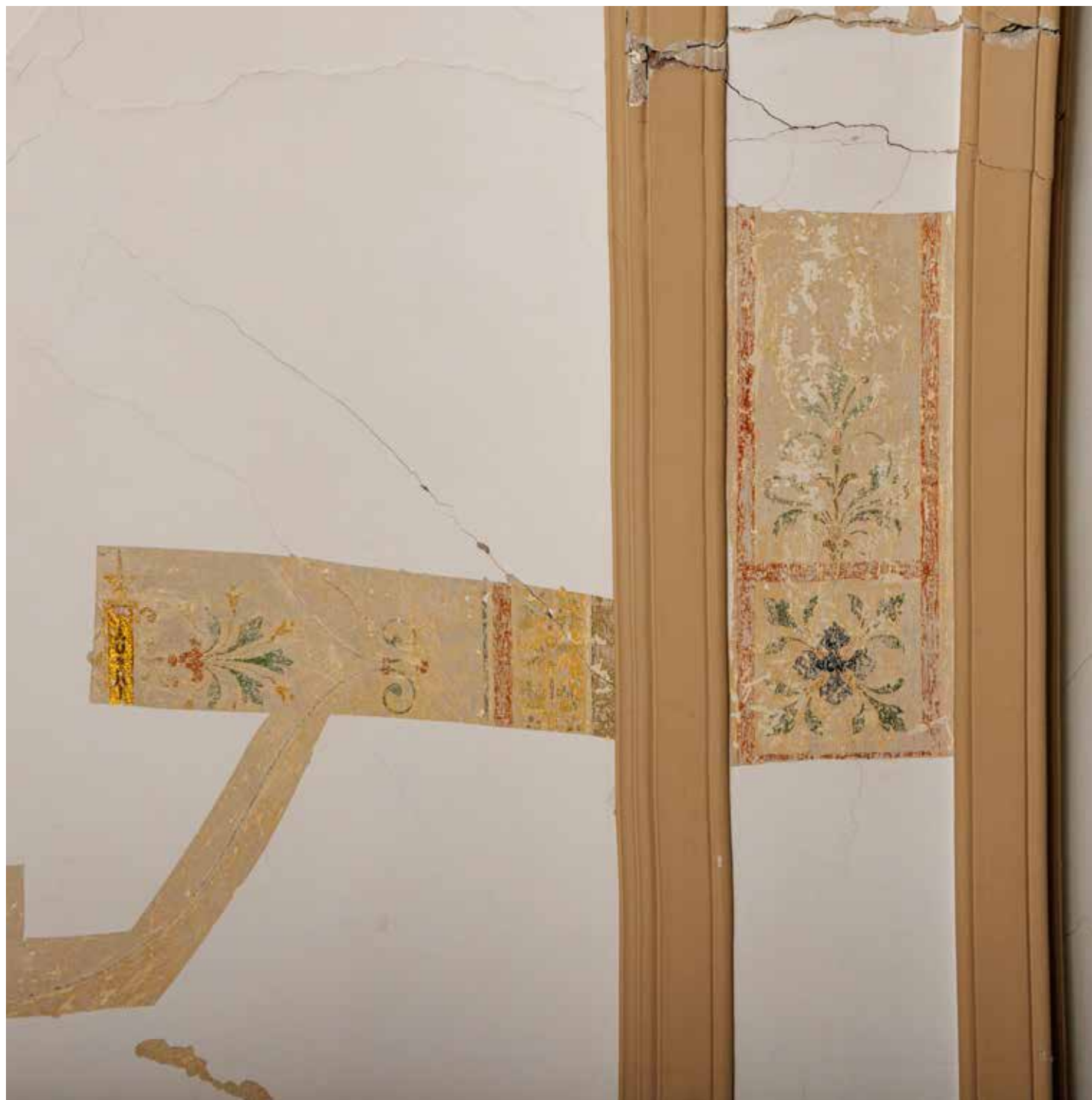
Trijem atrija na drugom katu, sonde na pojasnici i svodu
