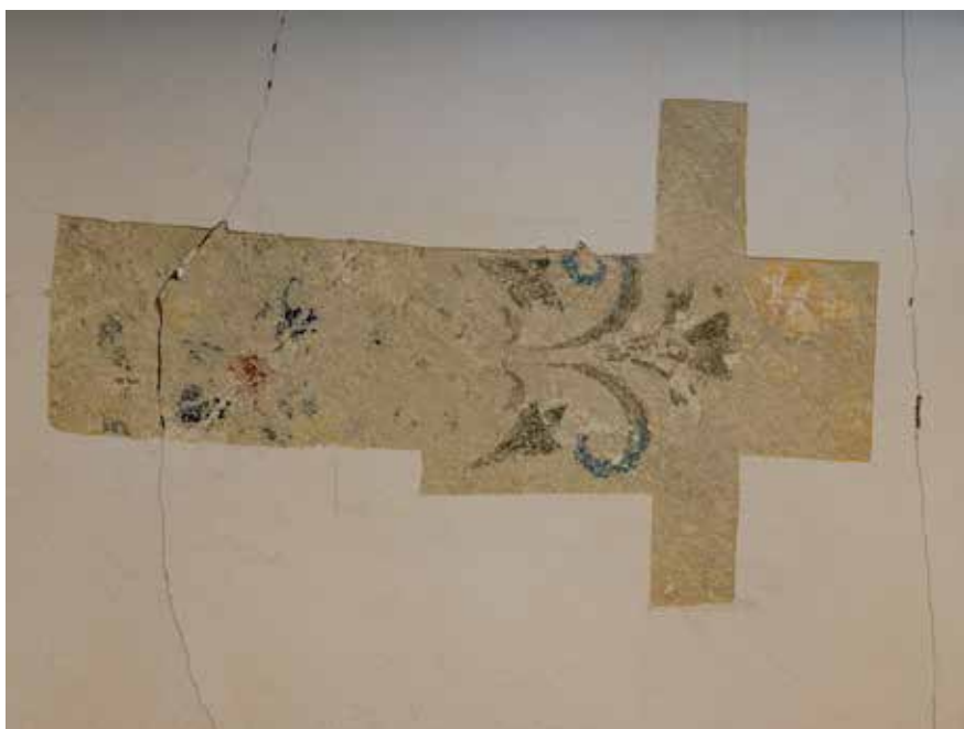
Velika sjednička dvorana, sonde na stropu
