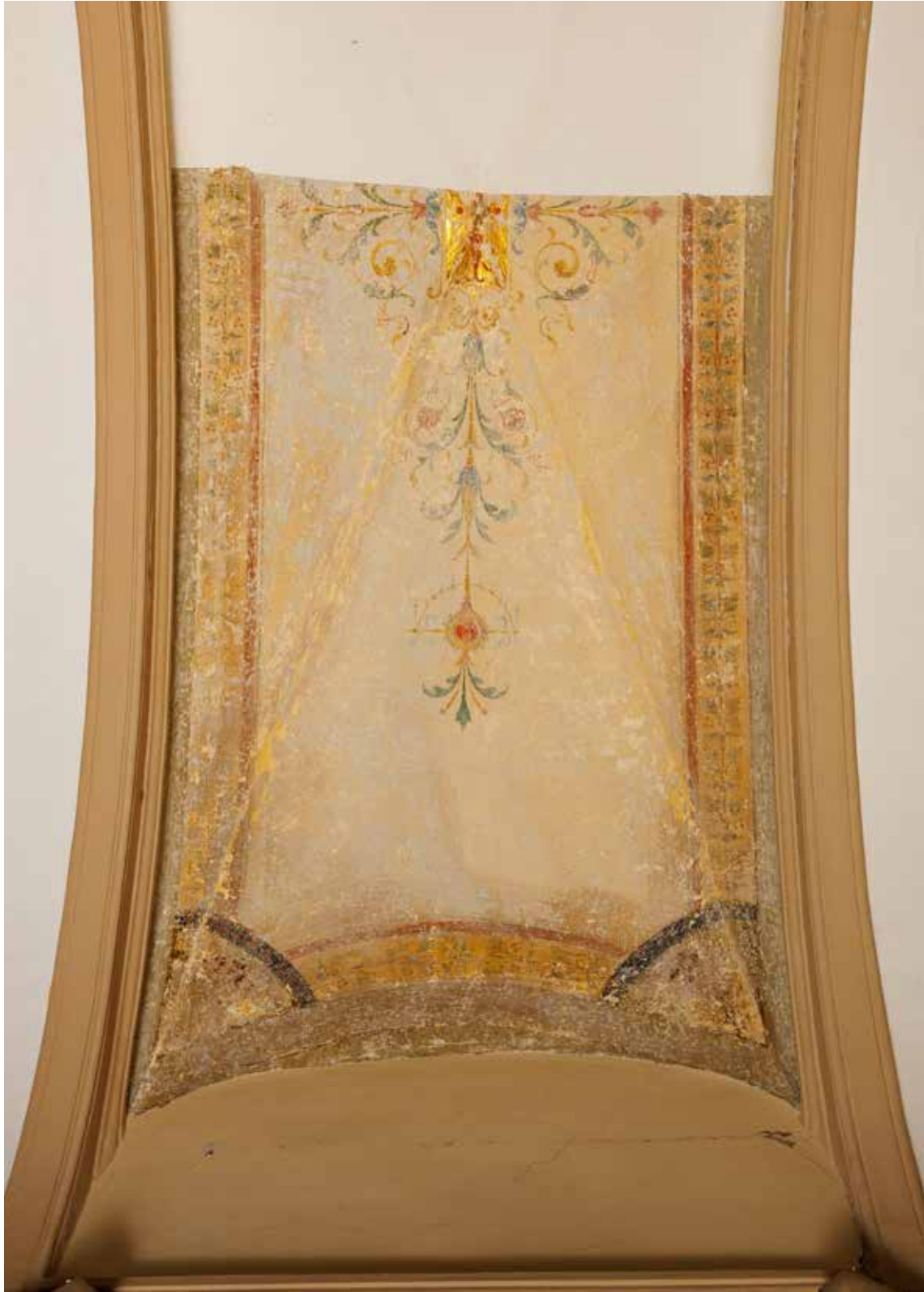
Trijem atrijsa na drugom katu, sonde na svodovima
