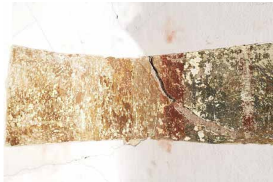
Sonde na zidu i stropu
