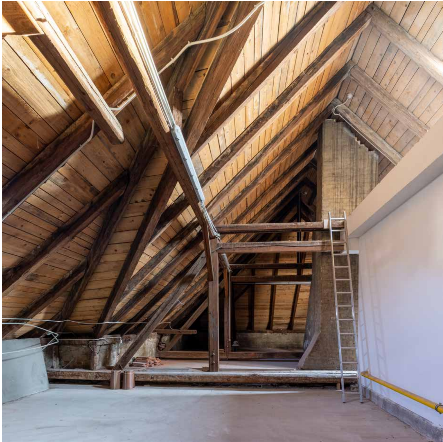
Potkrovlje pročelnog (sjevernog) krila
