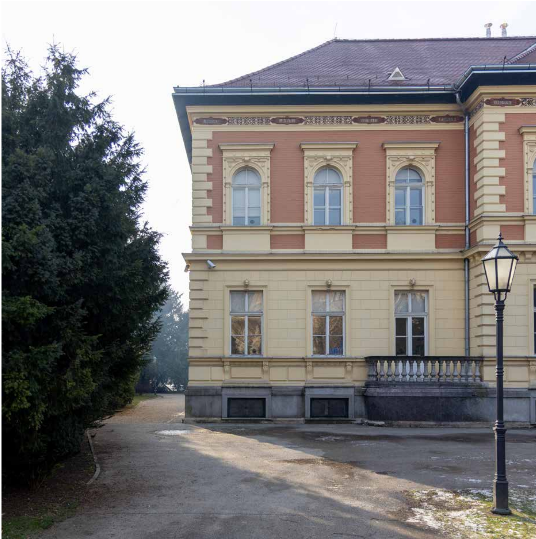
Sjeverno pročelje, detalj
