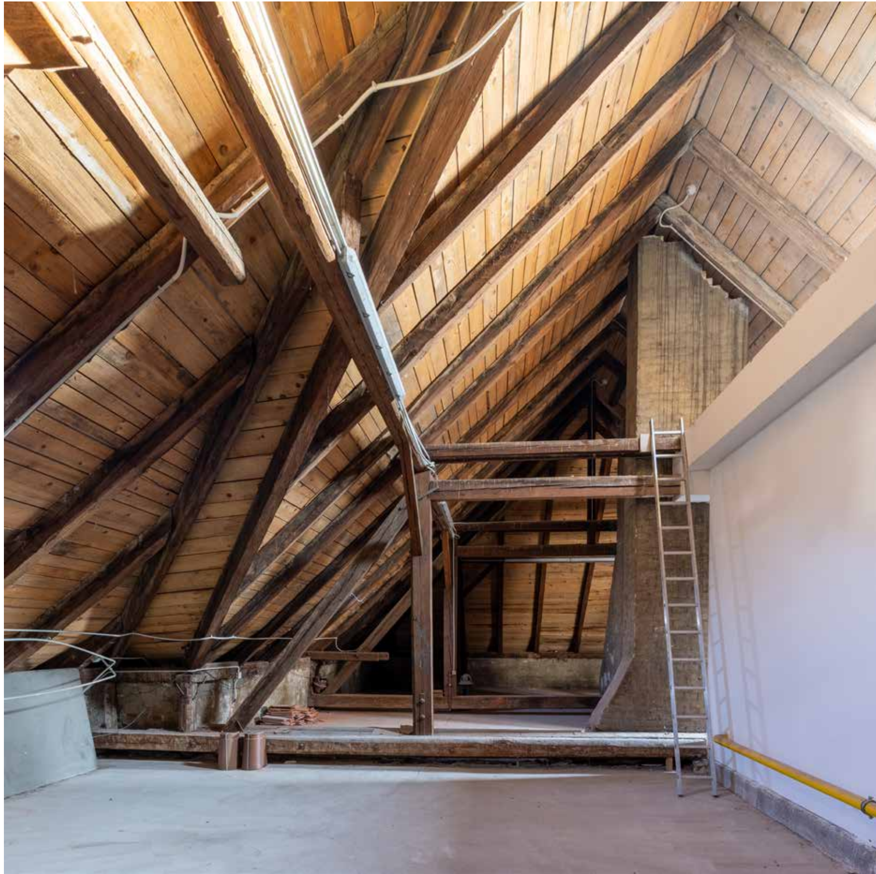
Potkrovlje pročelnog (sjevernog) krila
