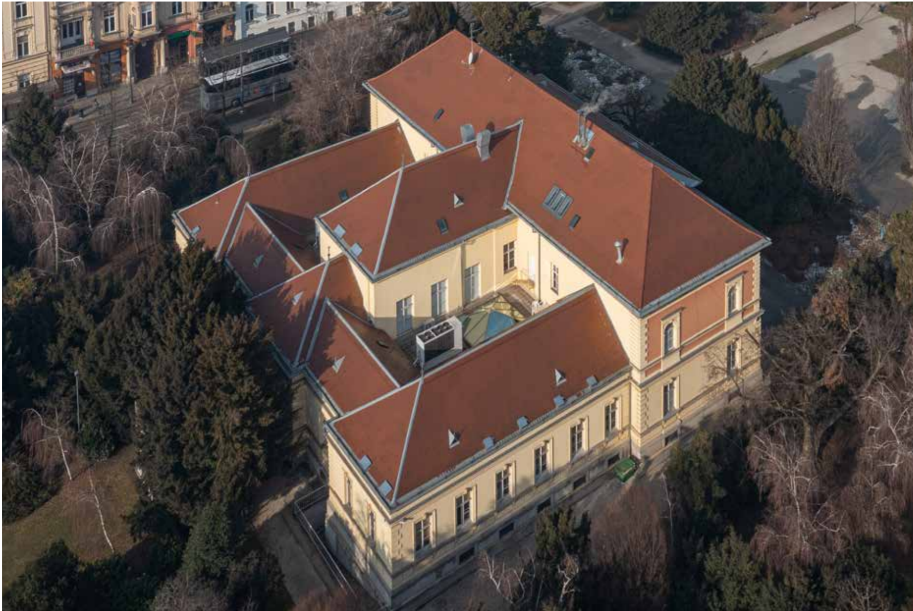
Pogled na krovšte
