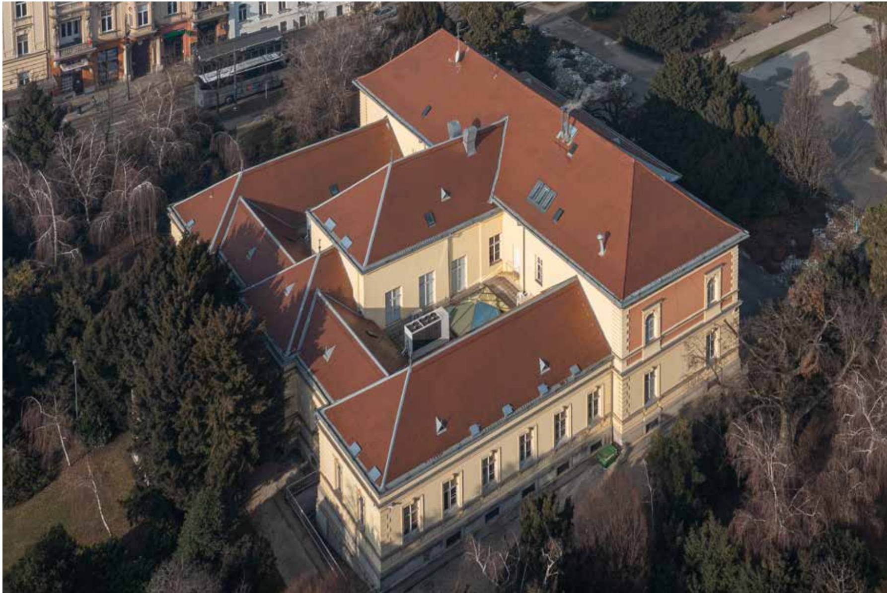
Pogled na krovšte
