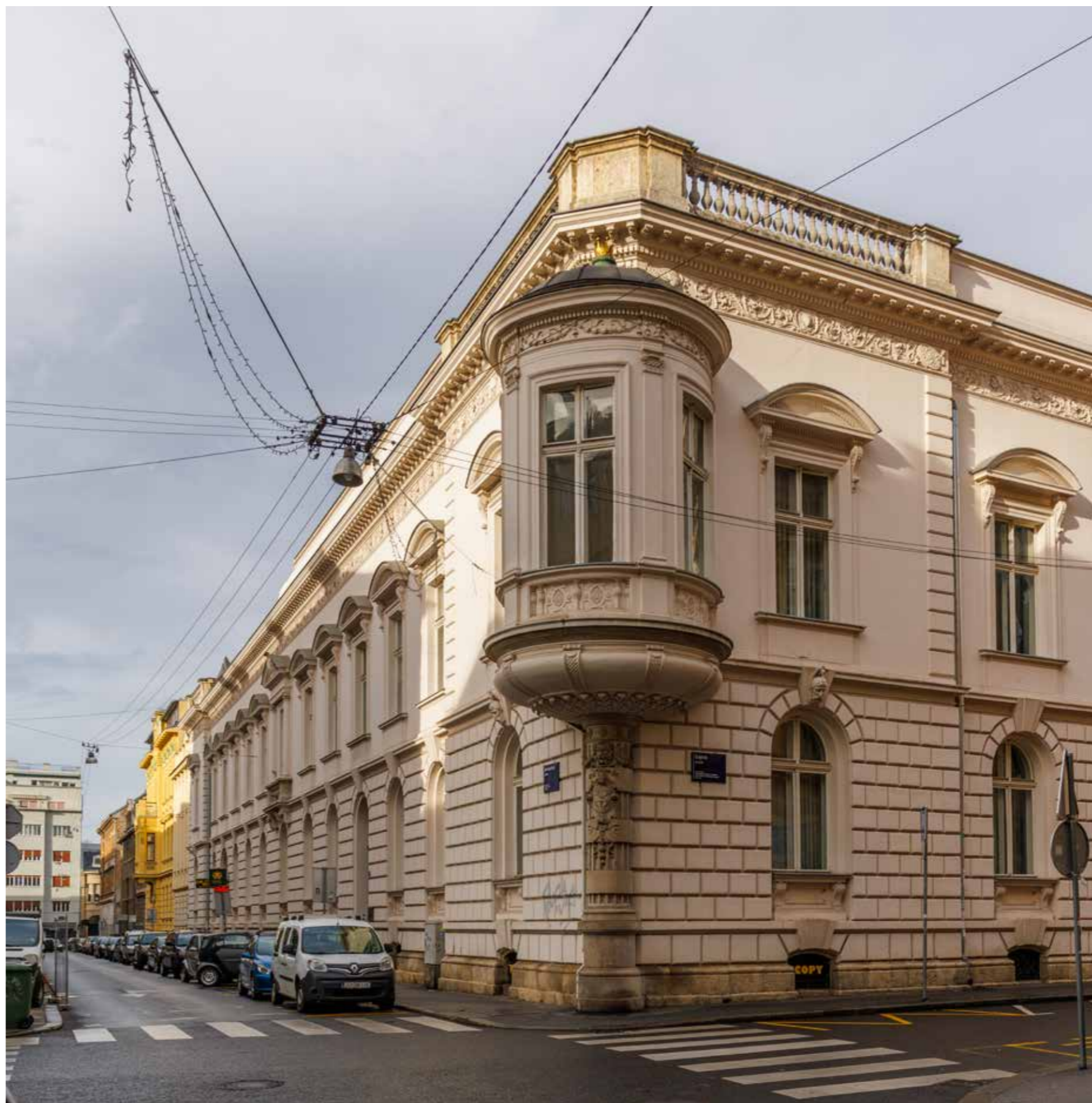
Južno i istočno pročelje s ugaonim erkerom
