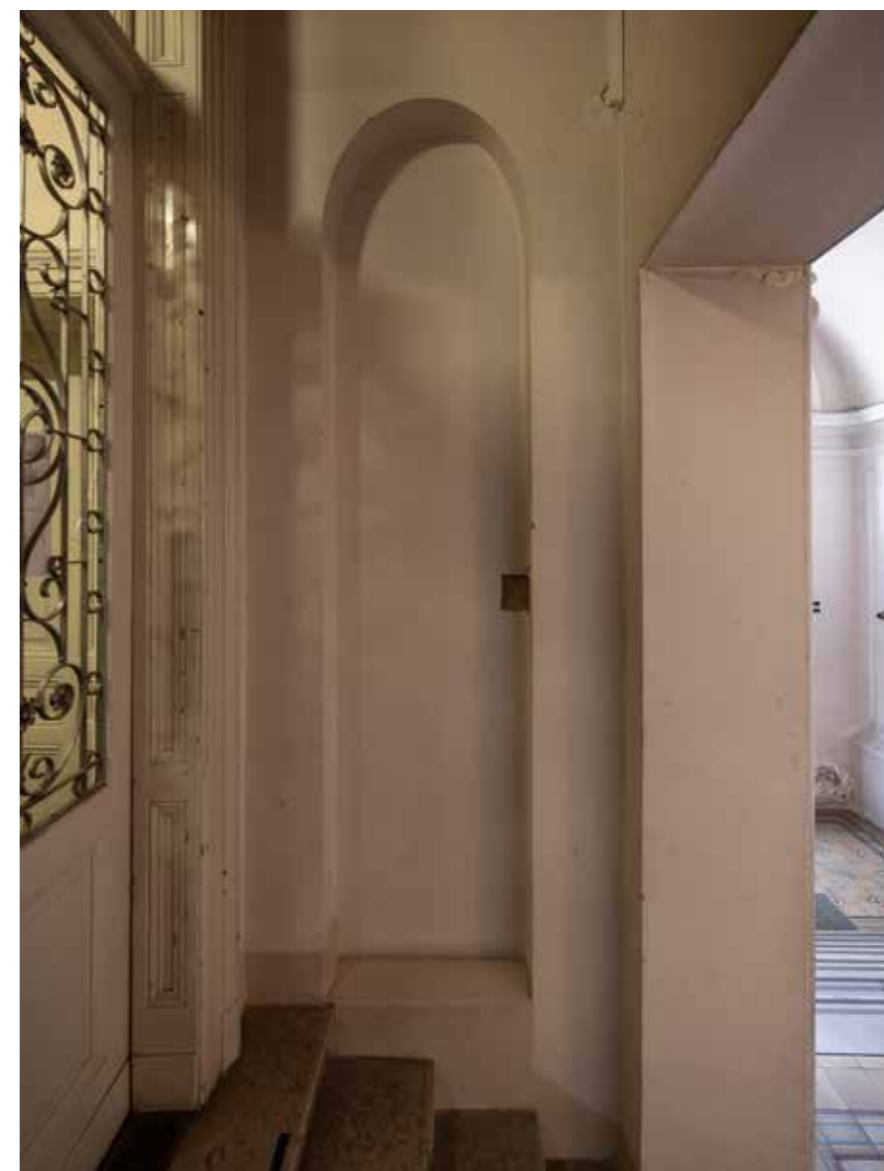
Svod u veži (izmijenjen u gradnji u odnosu na projekt)
