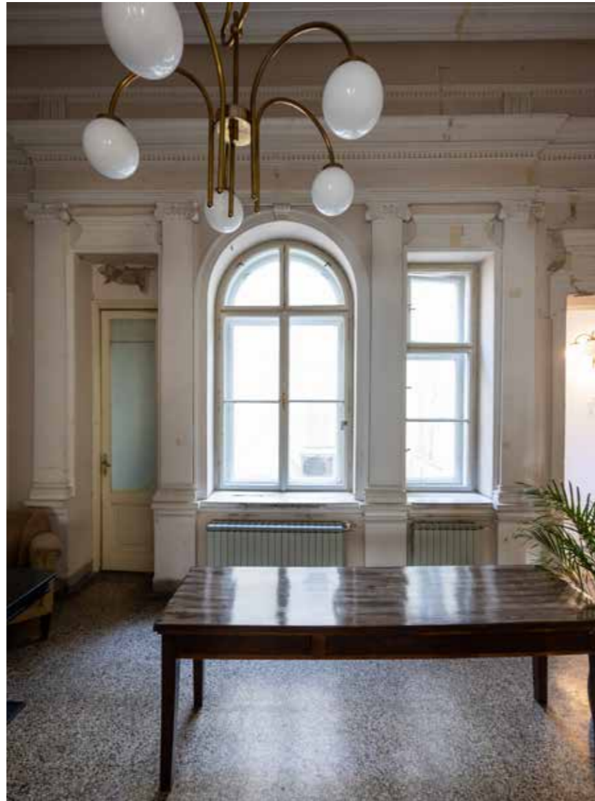
Vestibul na prvom katu, pogled na prozore prema svjetlarniku (lijeva vrata treba vratiti u prozor nakon što se ukloni ugradnja iz svjetlarnika)
