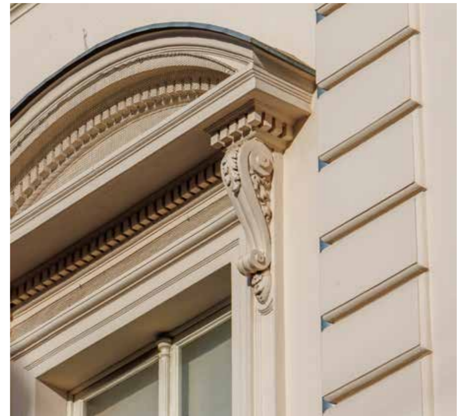
Balkon na prvom katu Konzola i detalj balkona Prozor na katu, detalj
