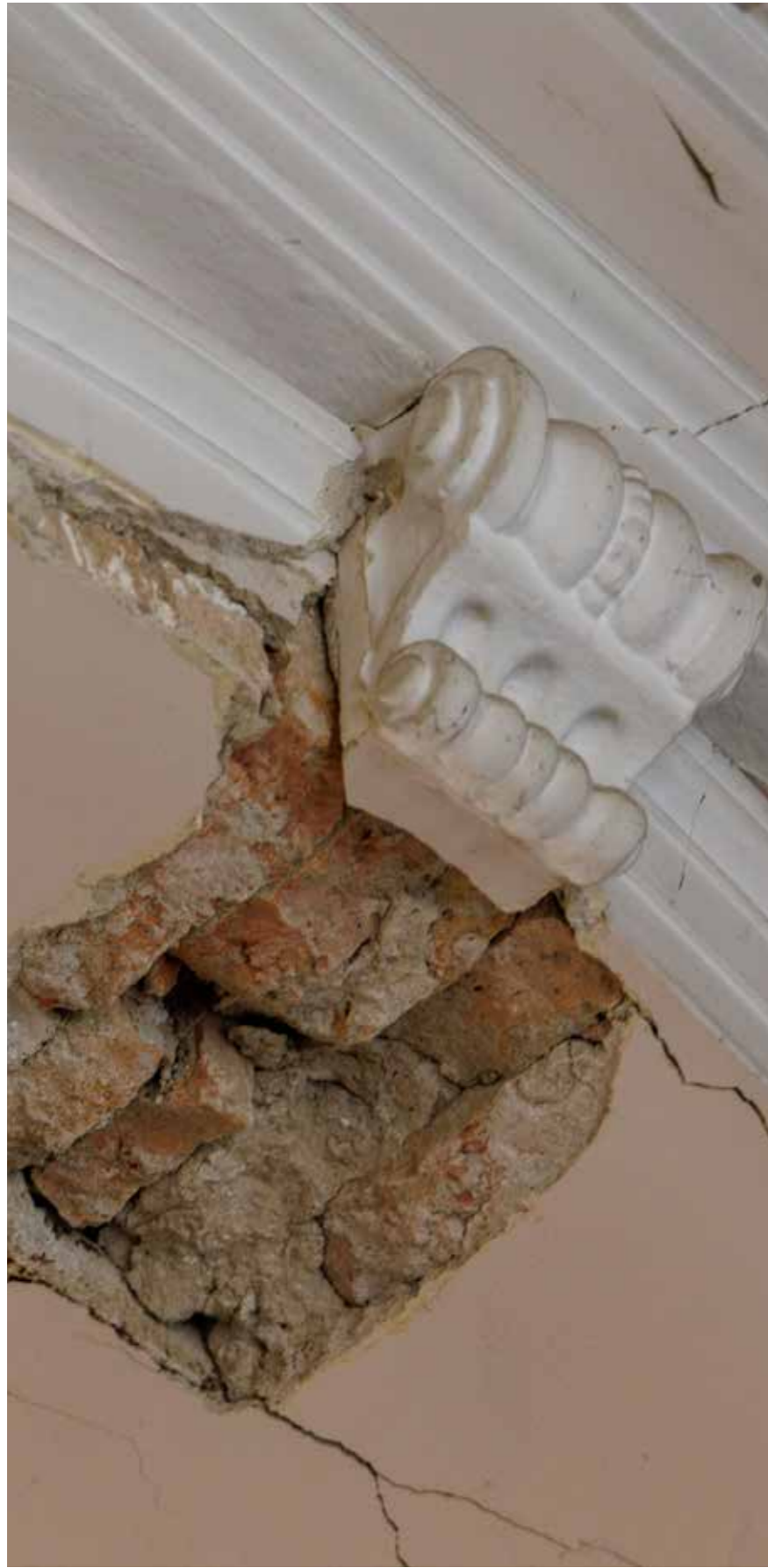
Oštećenja od potresa u interijeru
