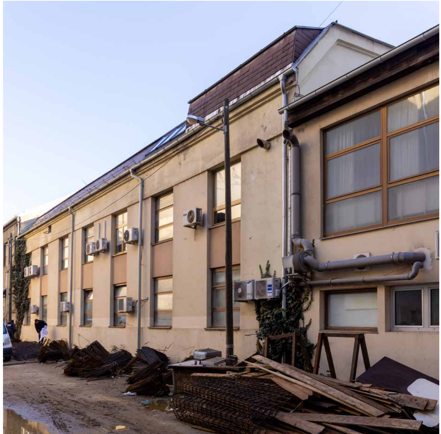
Zapadna dvorišna zgrada (nekadašnji strojarški laboratorij)
