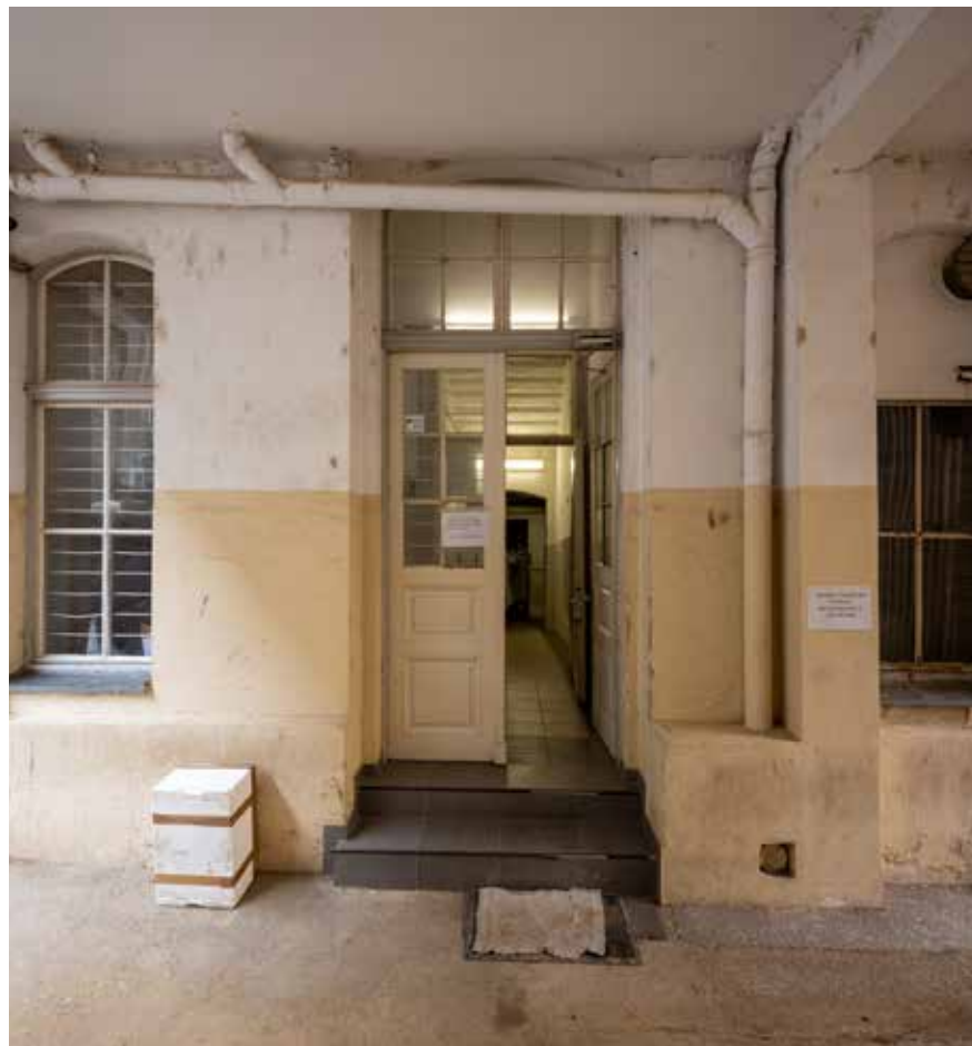
Glavna zgrada – sjeverno dvorišno začelje
