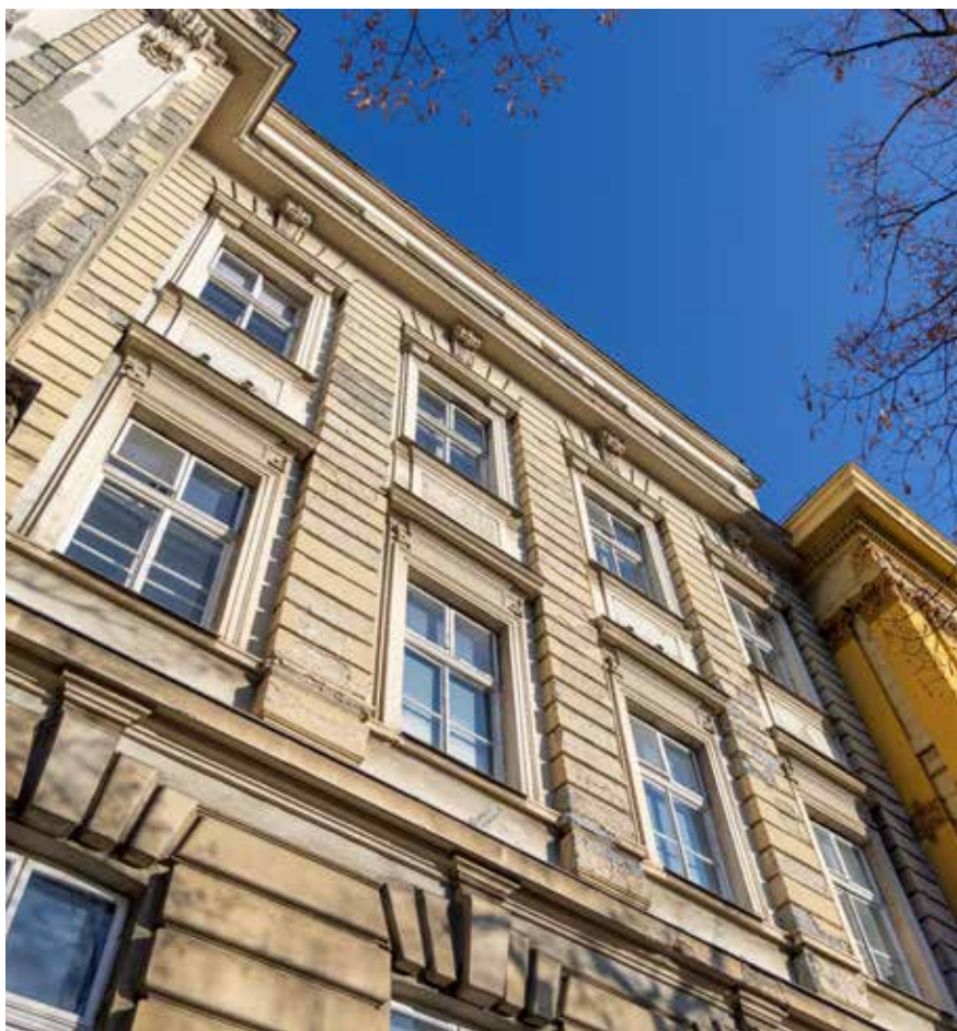
Južno pročelje, detalji
