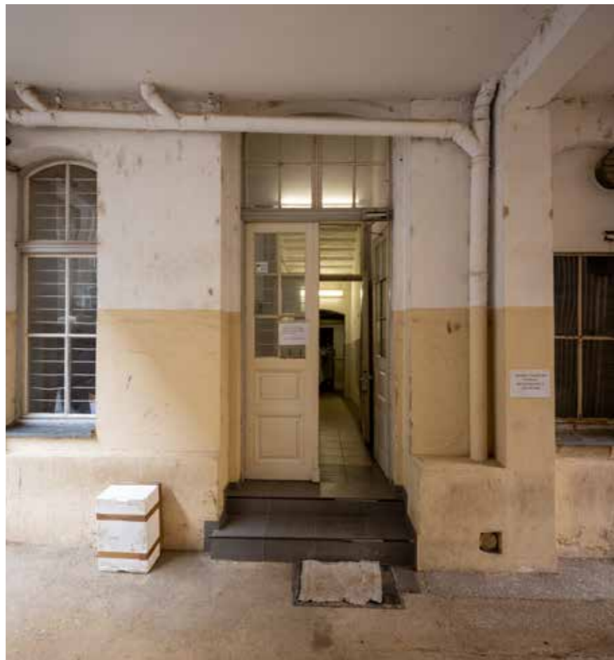
Glavna zgrada – sjeverno dvorišno začelje
