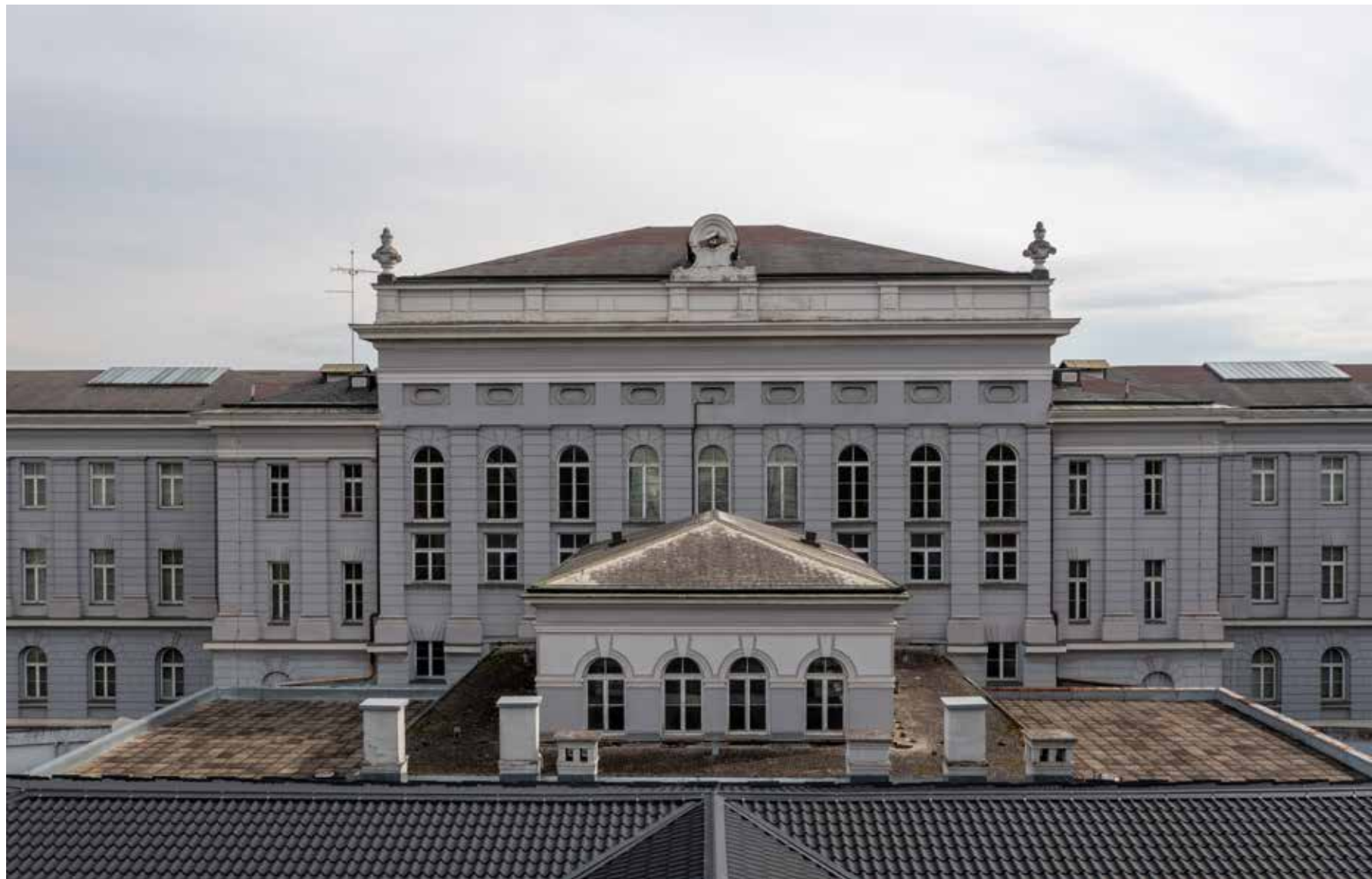
Zapadno pročelje Muzeja Mimara
