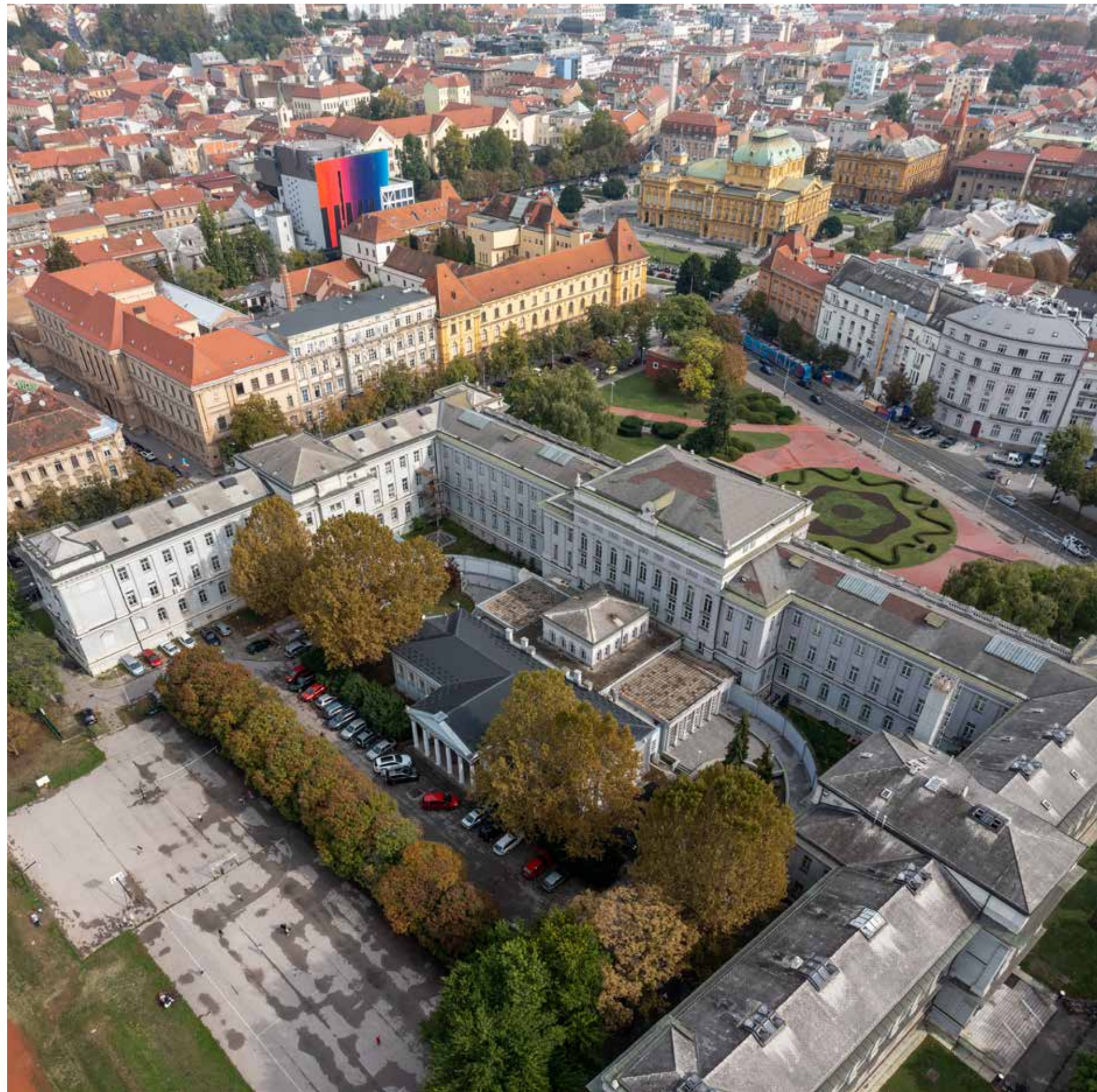
Muzej Mimara i školske zgrade, pogled s jugozapada
