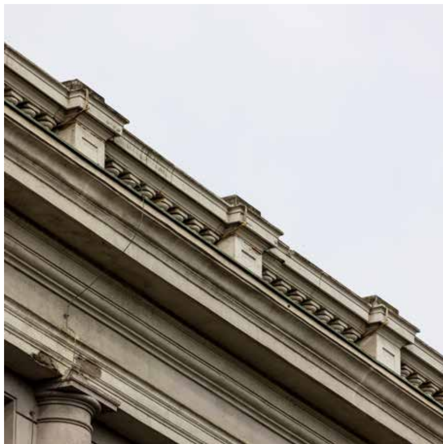
Detalj nadozida na istočnom pročelju
