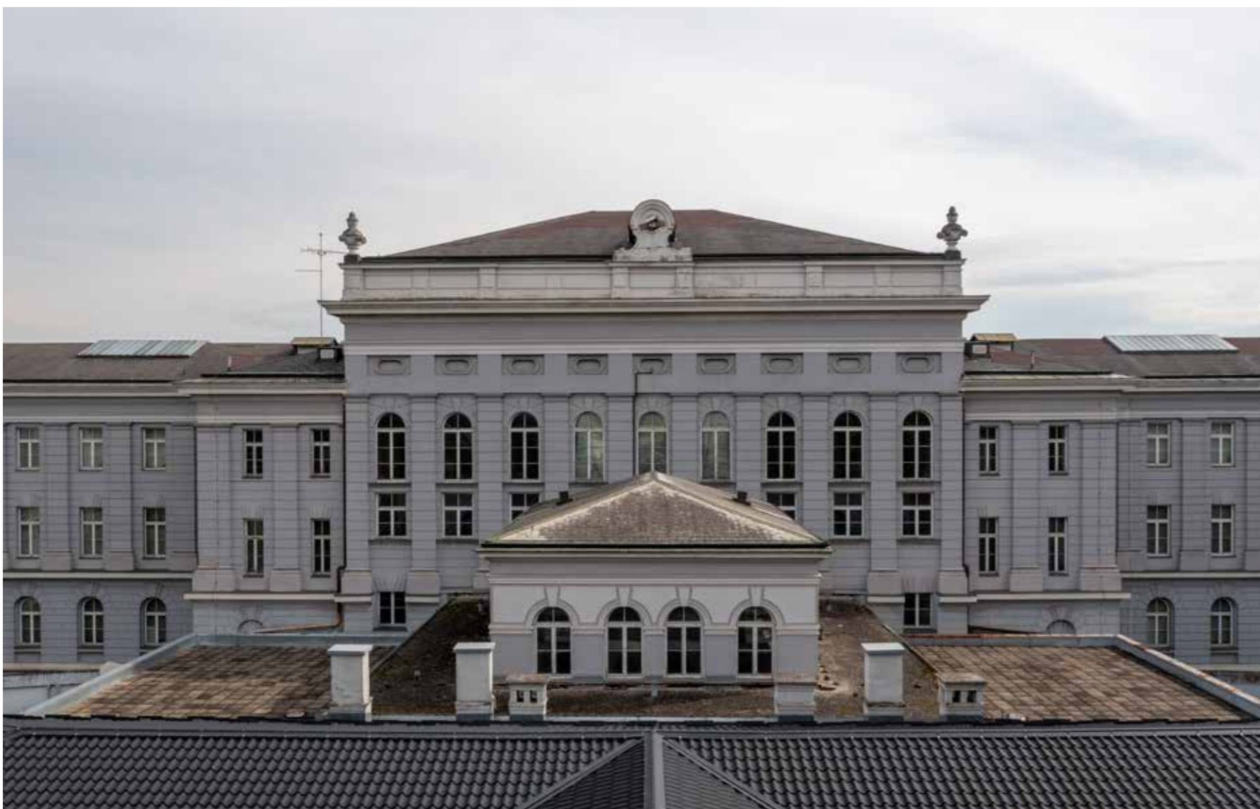
Zapadno pročelje Muzeja Mimara
