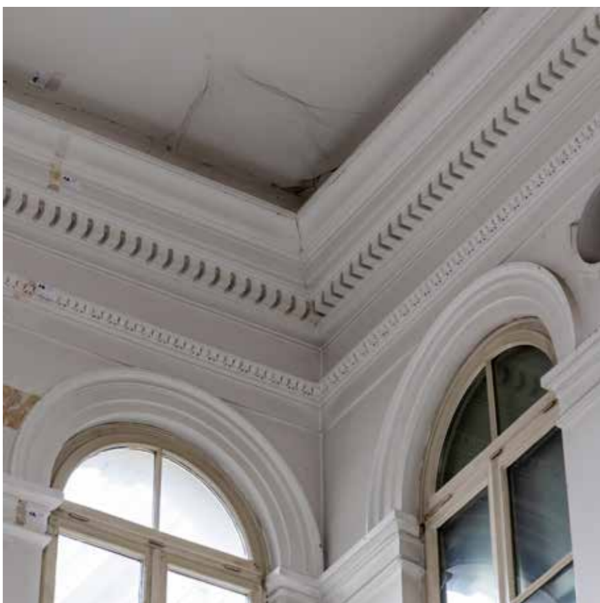
Detalji razdjelnog i krunskog vijenca u atriju
