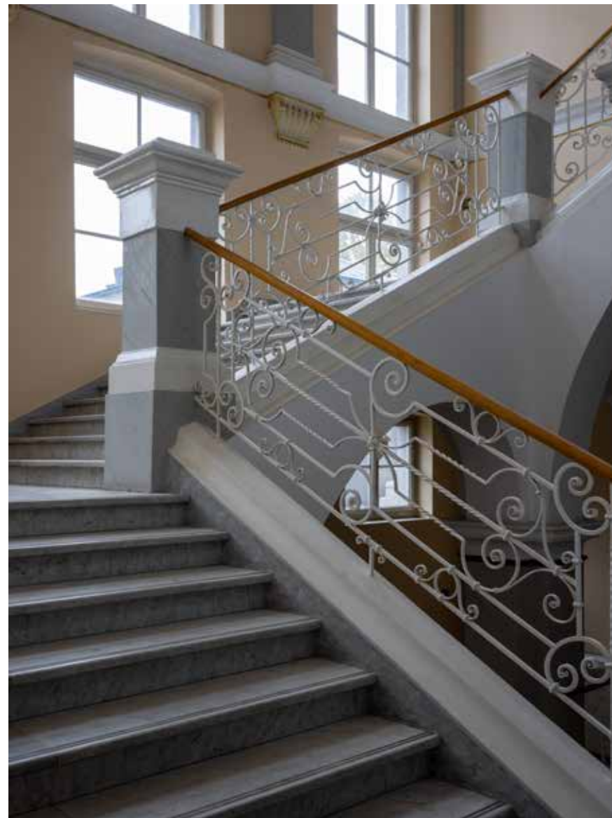
Ograda u stubištu
