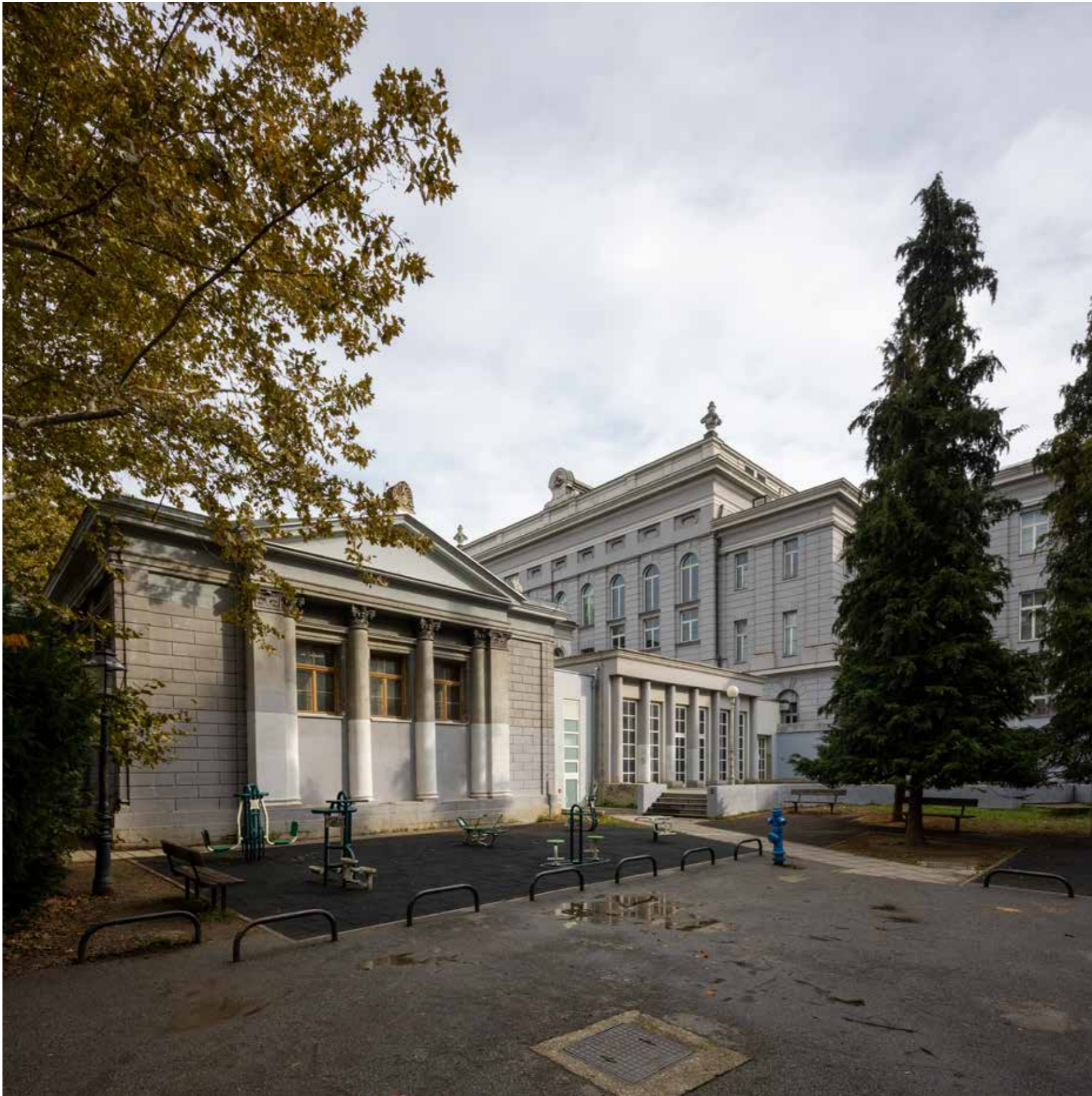
Bočno pročelje gombaone i pročelje dograđene svlačionice (danas multimedijske dvorane)
