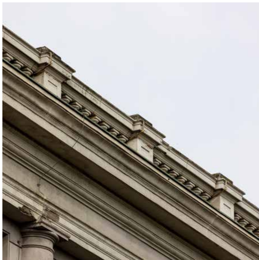
Detalj nadozida na istočnom pročelju
