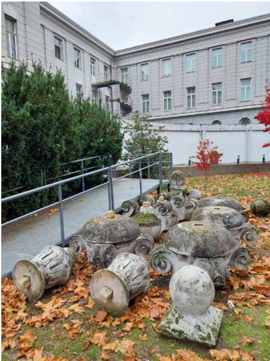
Akroteriji (vaze) s atike pročelja demontirani nakon oštećenja u potresu 2020.
