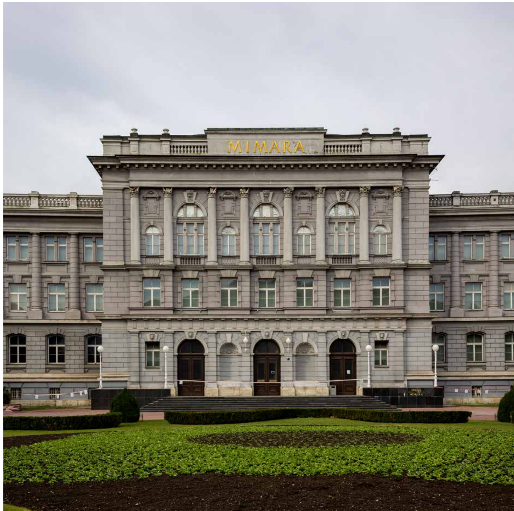
Istočno pročelje, središnji rizalit
