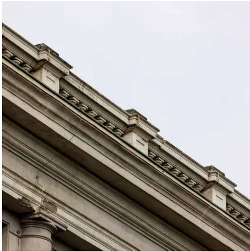
Detalj nadozida na istočnom pročelju
