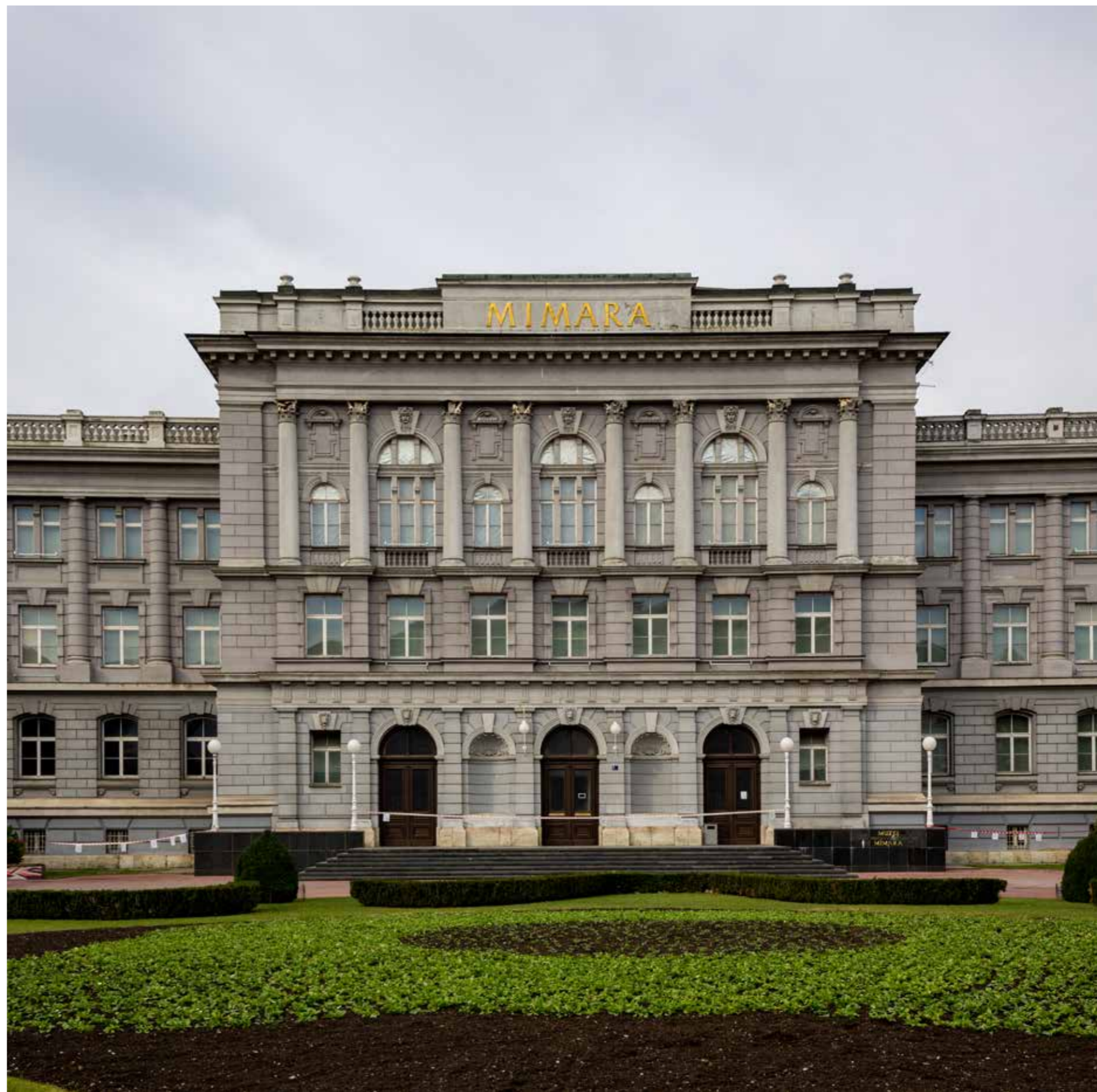
Istočno pročelje, središnji rizalit
