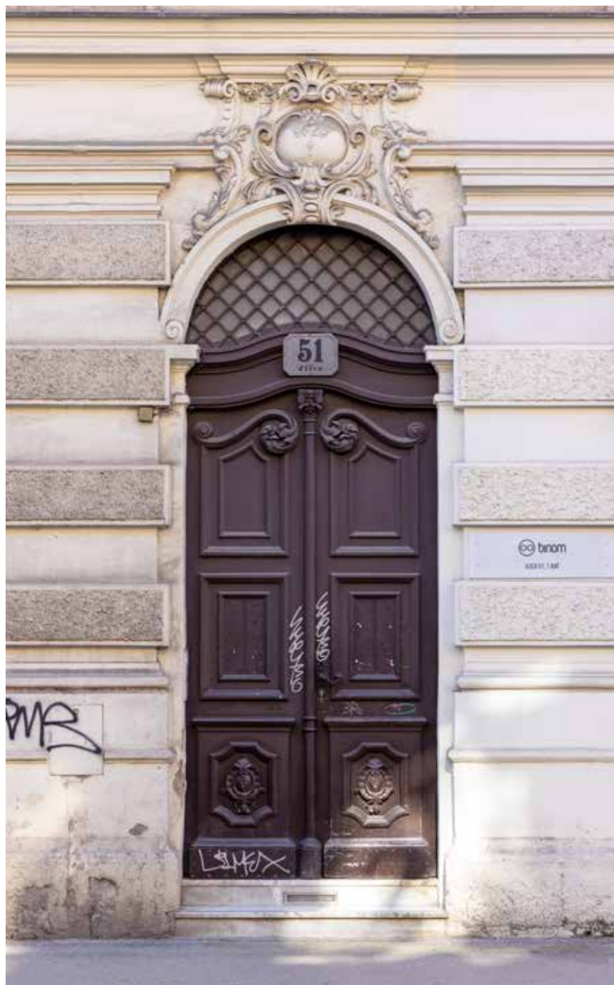
Pročelni portal • Prozor na prvom katu
