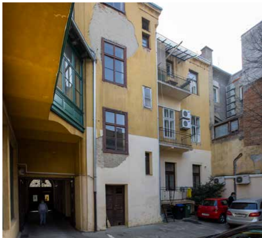
Dvorišno zapadno začelje
