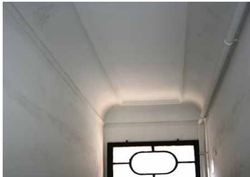
Lučni nadvoji uz stubišne krakove Zrcalni strop u ulaznom prostoru
