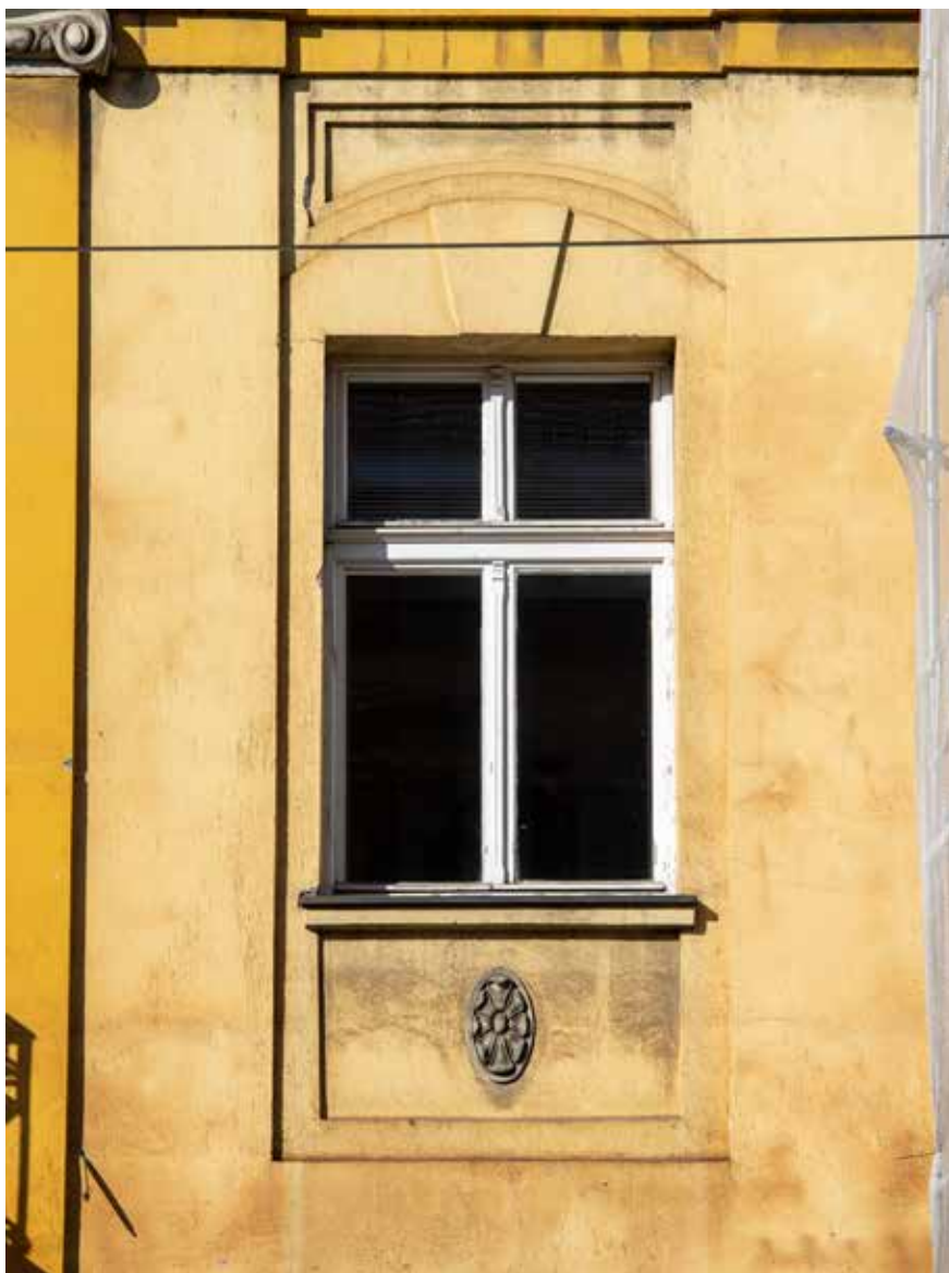
Prozor na prvom katu • Akroterij • Pilastar
