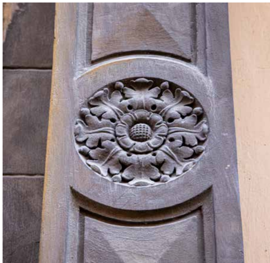
Detalj dovratnika portala
