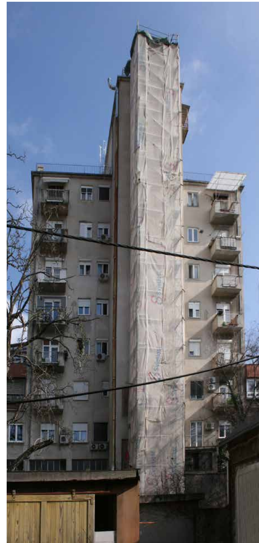
Prva dvorišna zgrada, zapadno pročelje
