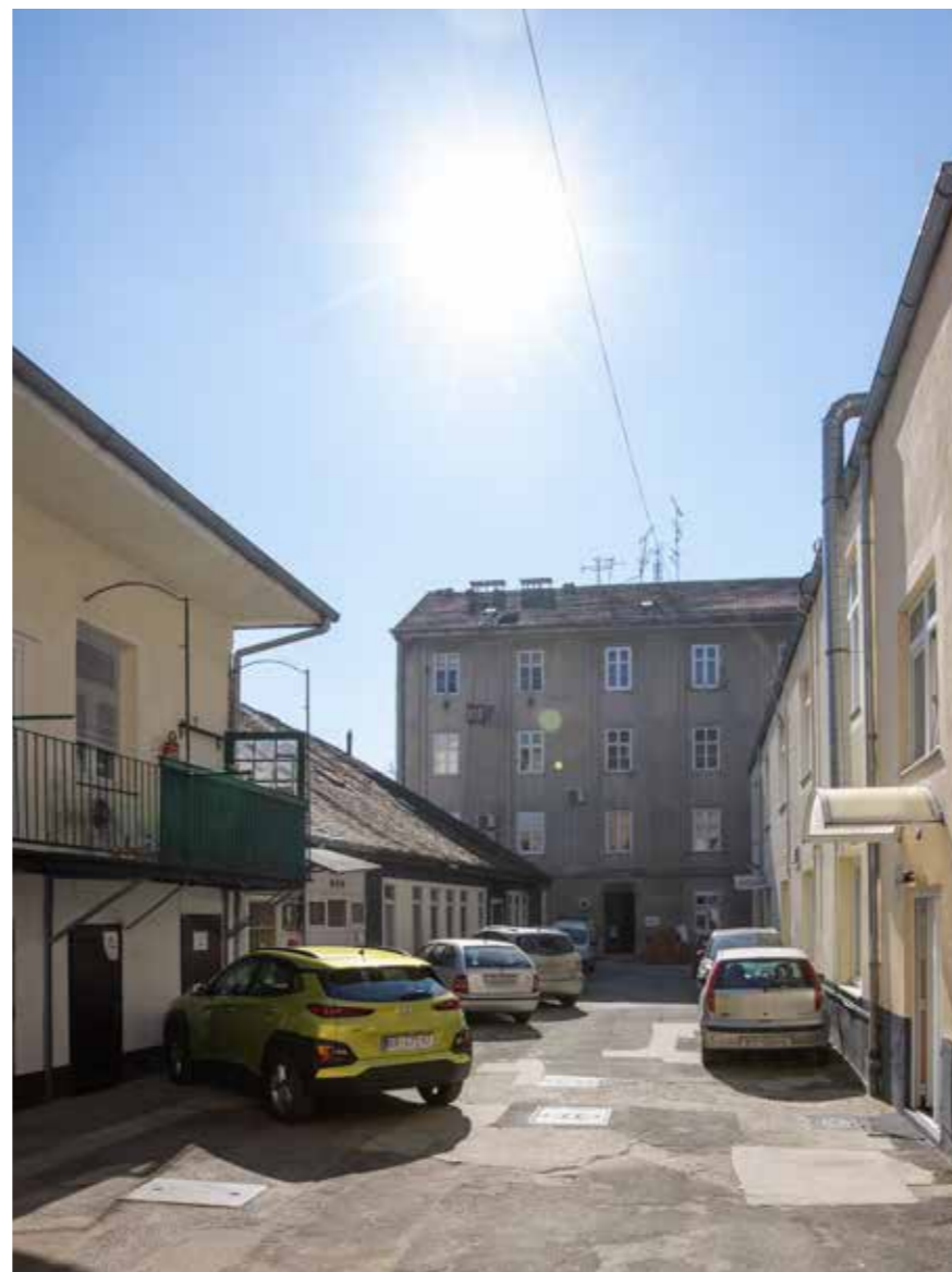
Dvorišno sjeverno pročelje
