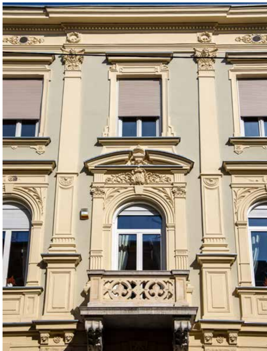
Balkon na prvom katu
