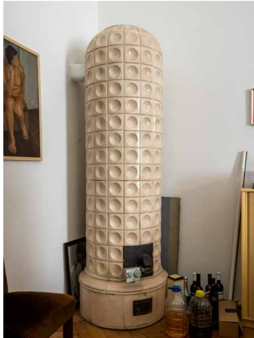
Kaljeve peći u istočnom stanu na prvom katu
