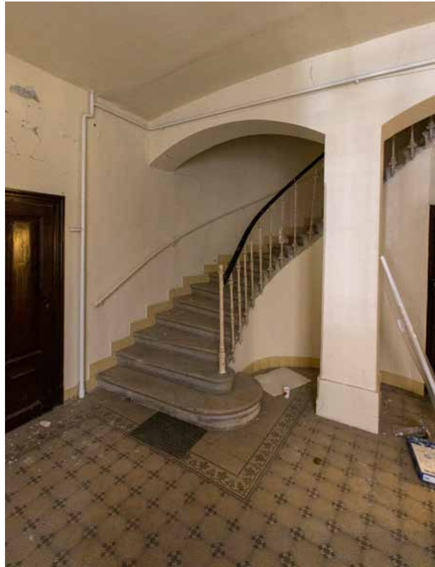
Predvorje sa stubištem unutrašnjeg (dvorišnoga) krila
