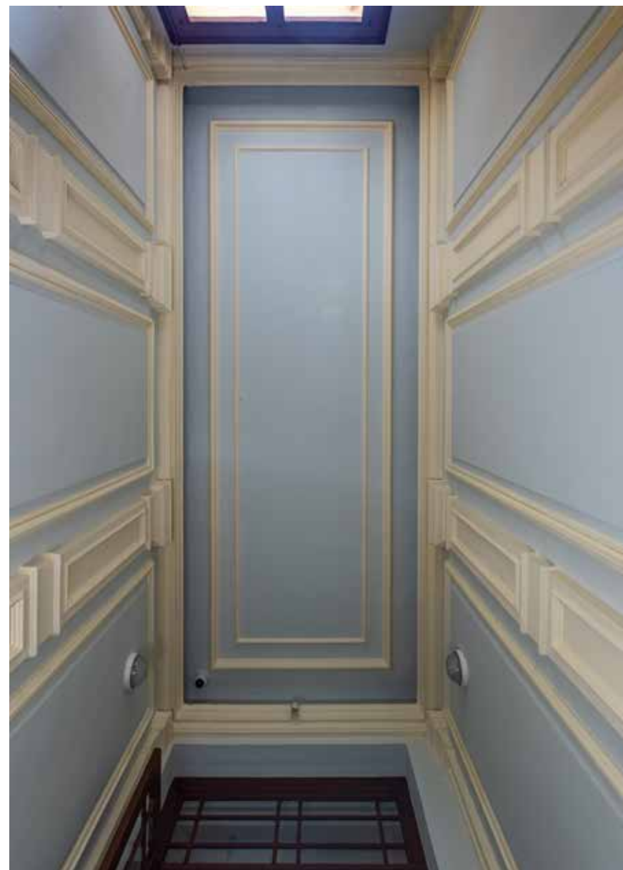
Strop u ulaznom prostoru
