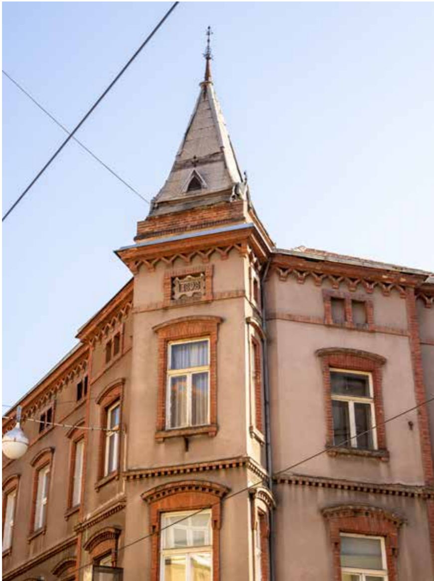
Kuća Rossipal, Medulićeva 2, ugaoni toranj
