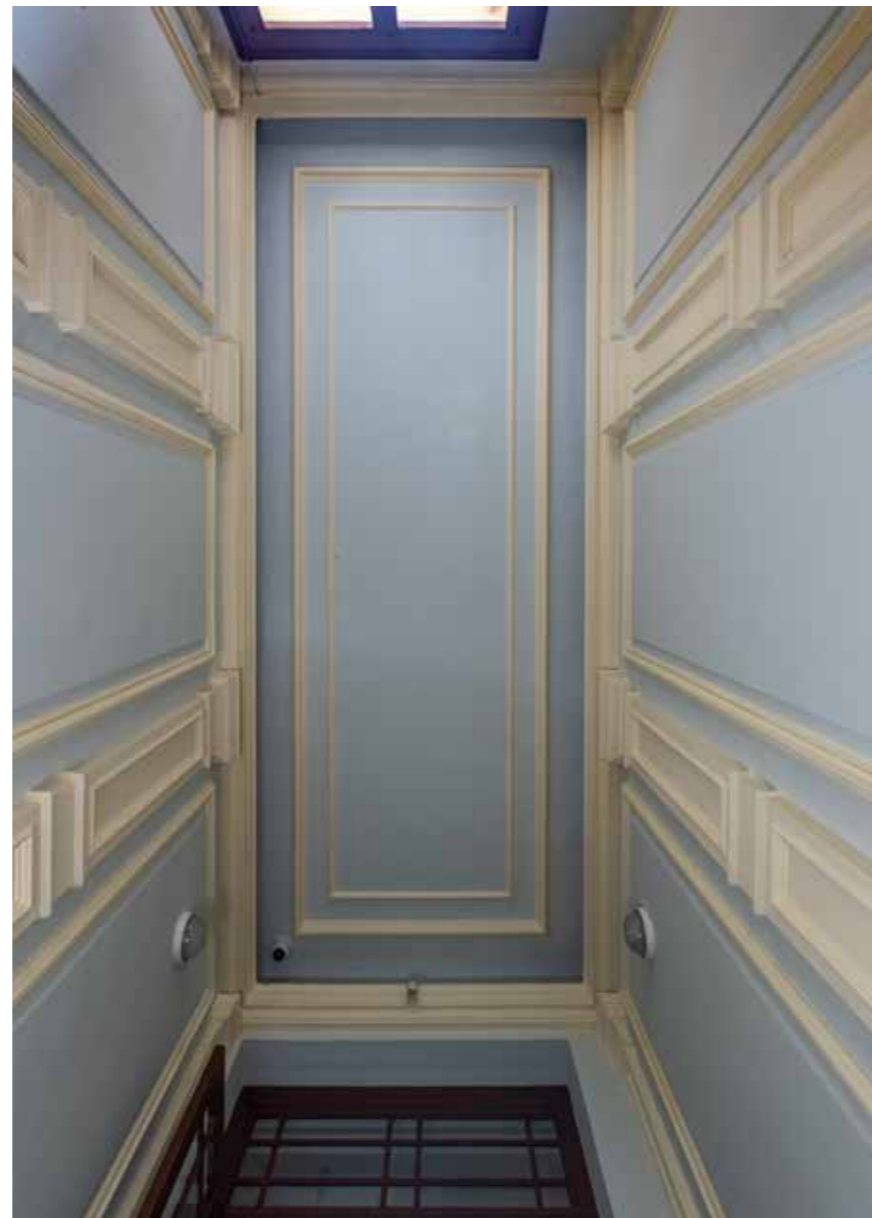
Strop u ulaznom prostoru
