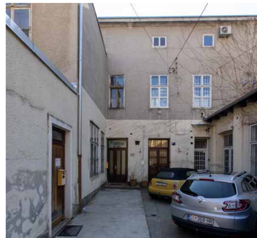
Dvorišno sjeverno pročelje
