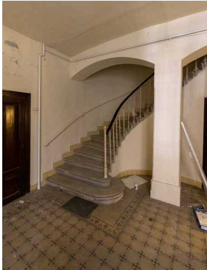
Predvorje sa stubištem unutrašnjeg (dvorišnoga) krila
