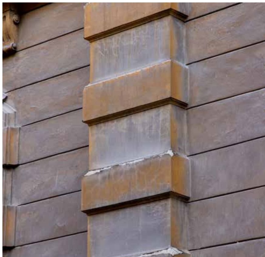
Pilastar u prizemnoj zoni pročelja
