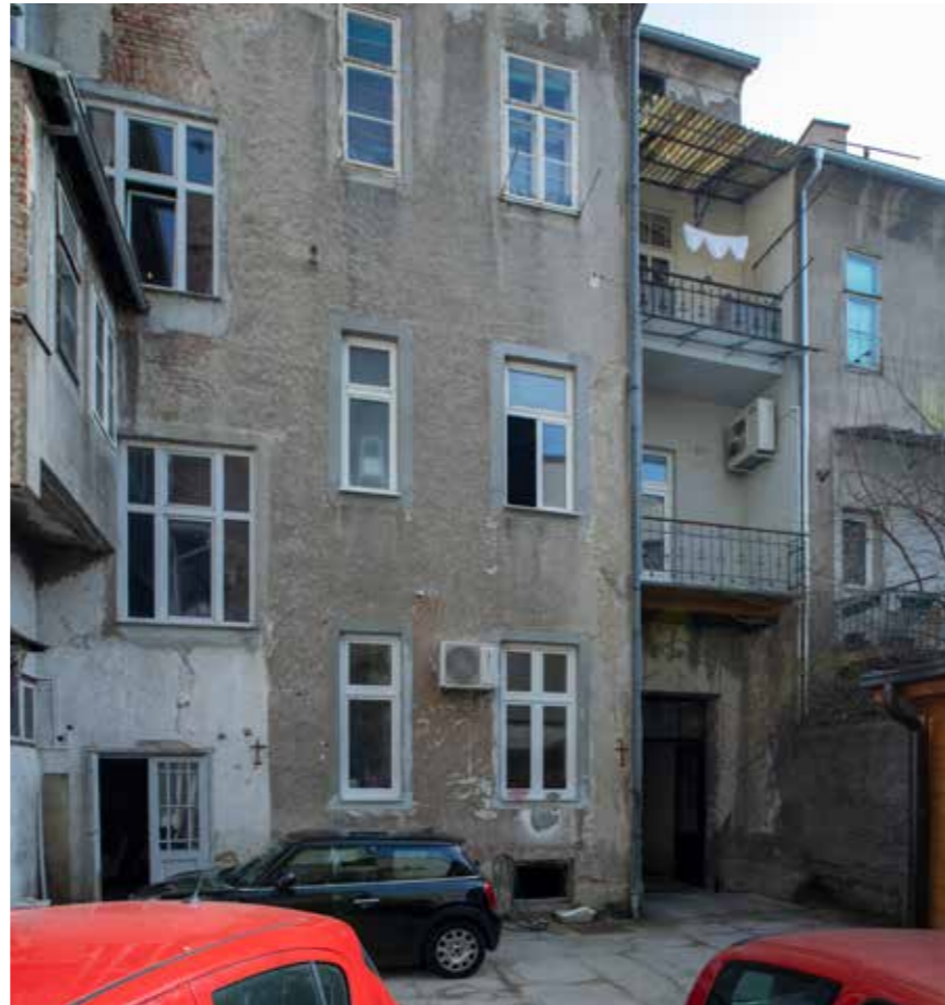
Dvorišno zapadno začelje
