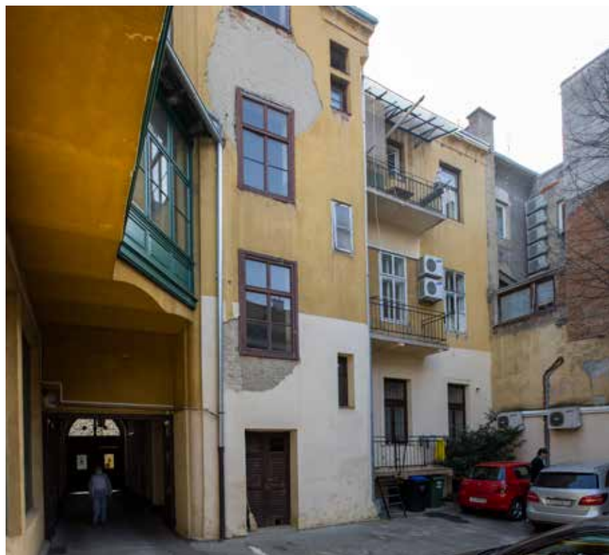
Dvorišno zapadno začelje
