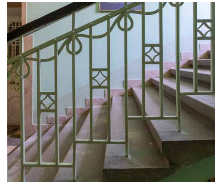
Ograda u stubištu
