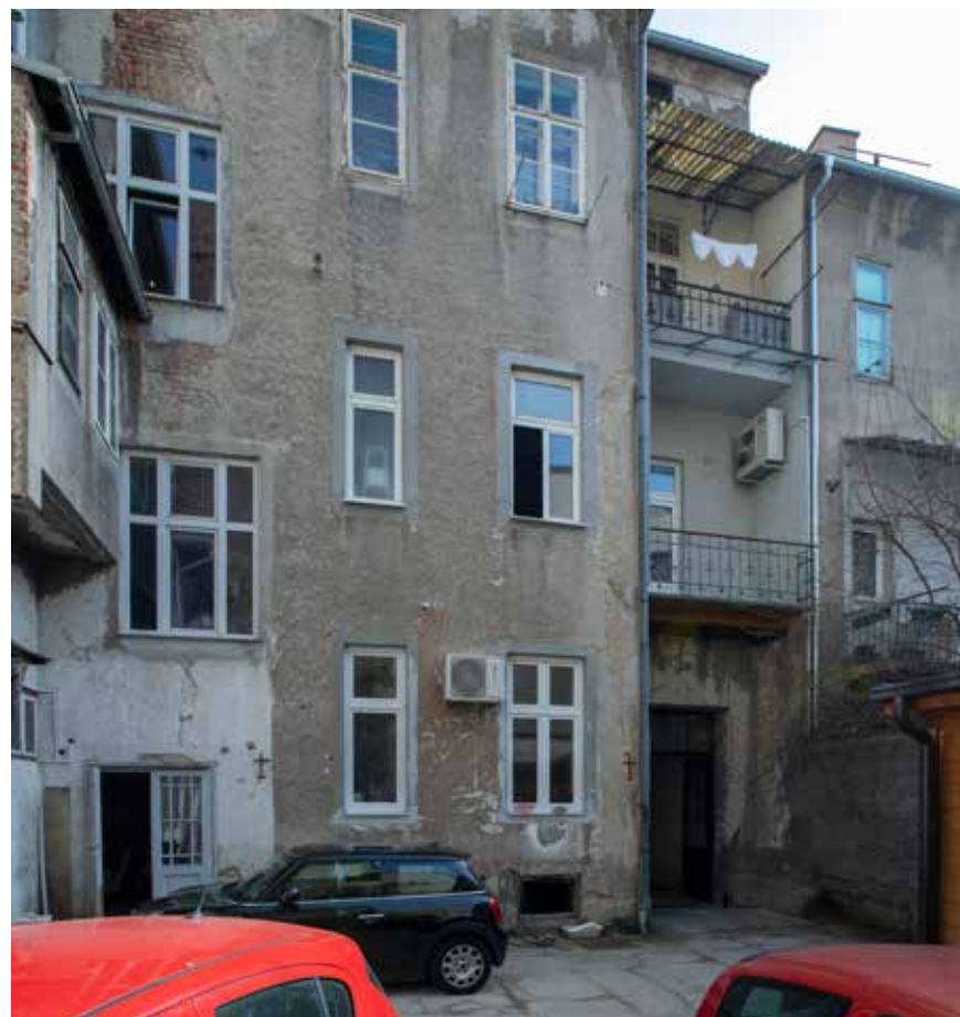
Dvorišno zapadno začelje
