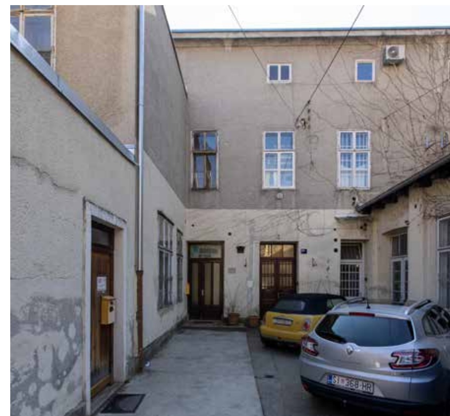
Dvorišno sjeverno pročelje
