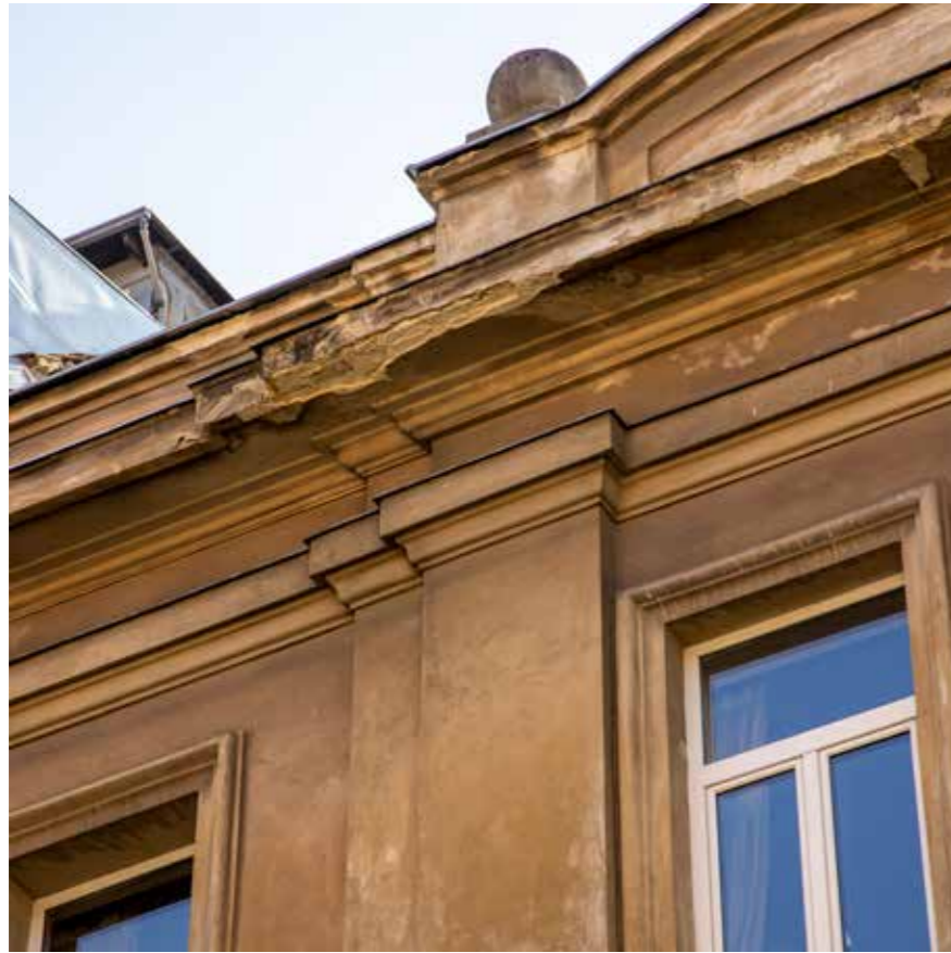
Detalj pilastra i završnog vijenca pročelja
