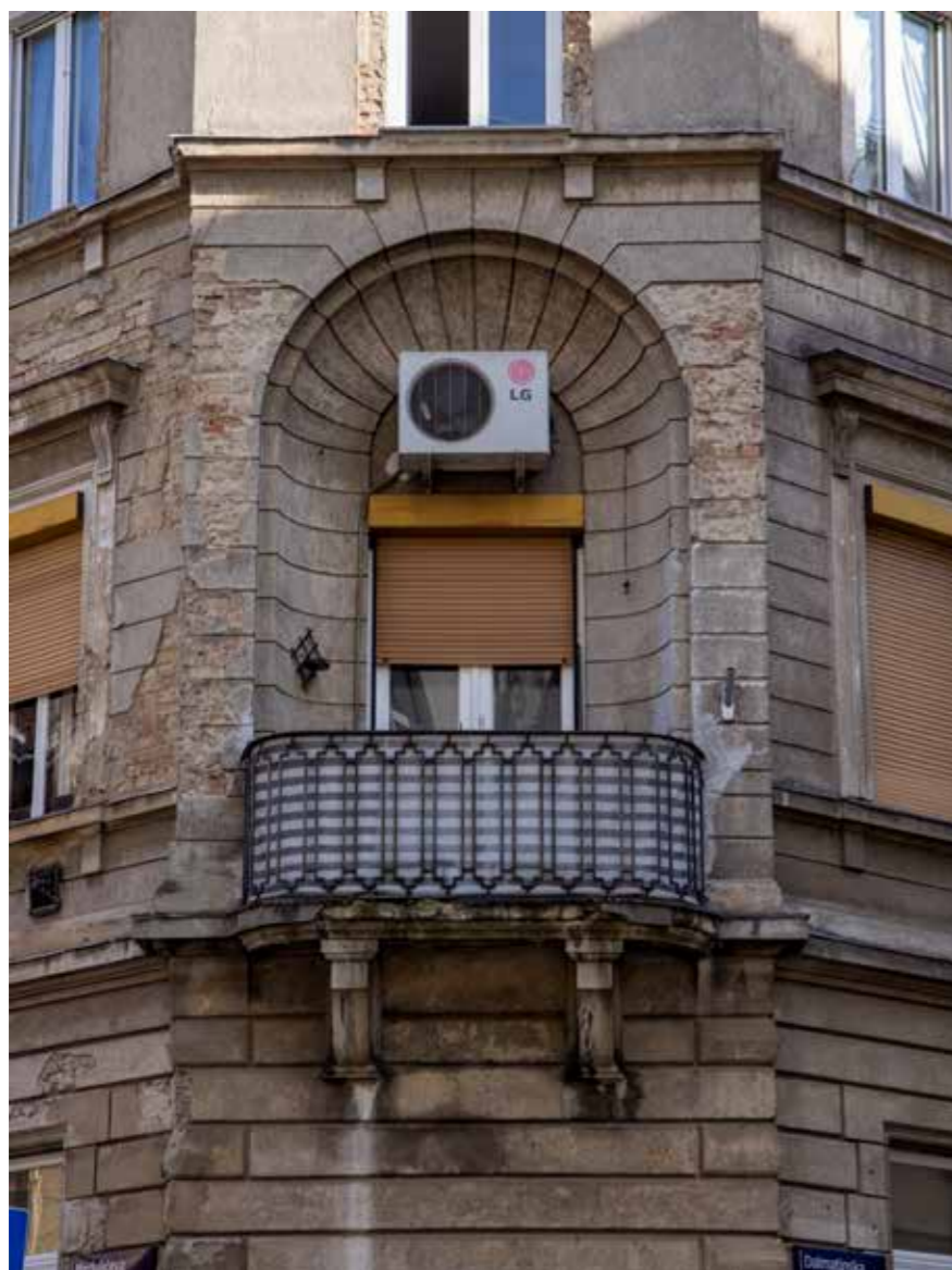
Ugaoni rizalit s balkonom
