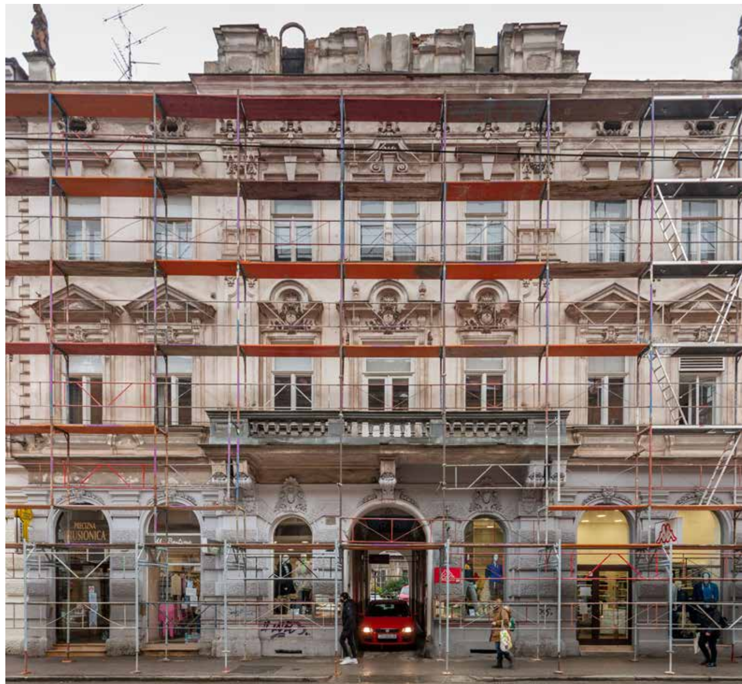
Ulično sjeverno pročelje (br. 53)
