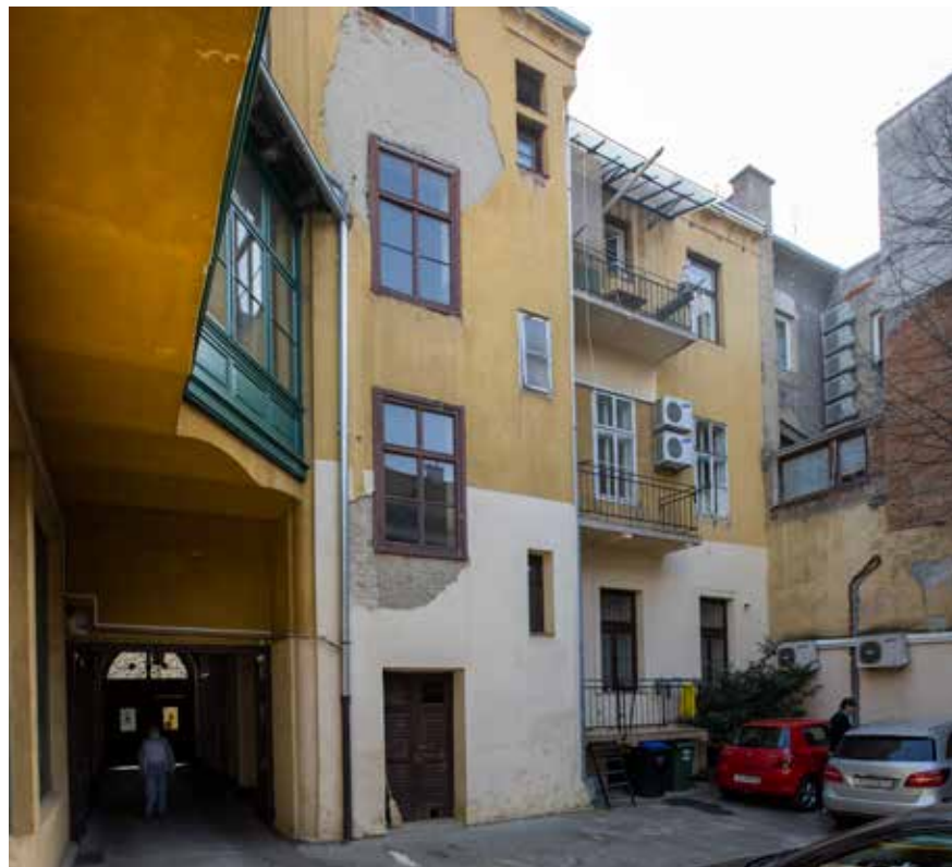
Dvorišno zapadno začelje
