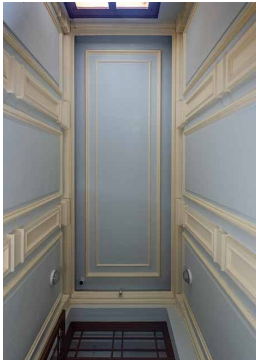
Strop u ulaznom prostoru
