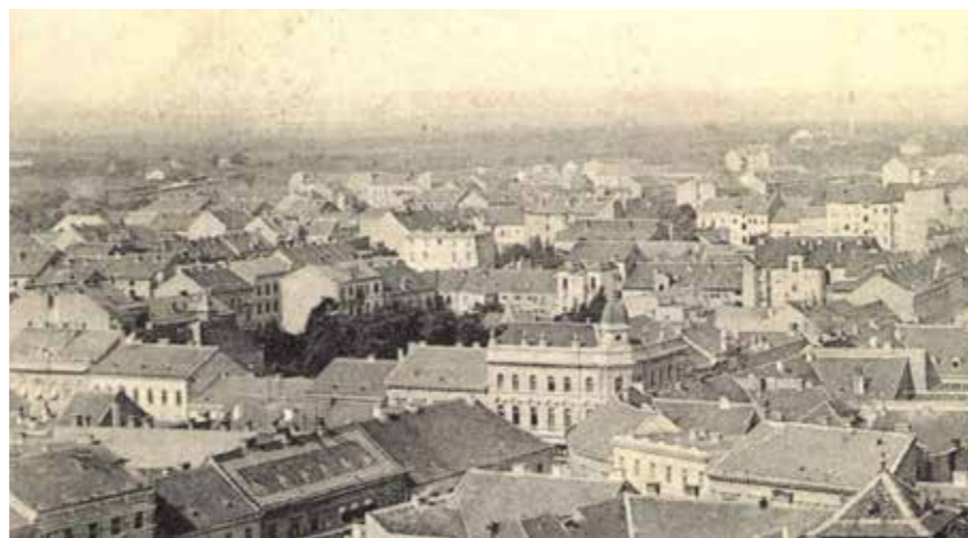
Pogled na Blok 19, 19./20. stoljeće
