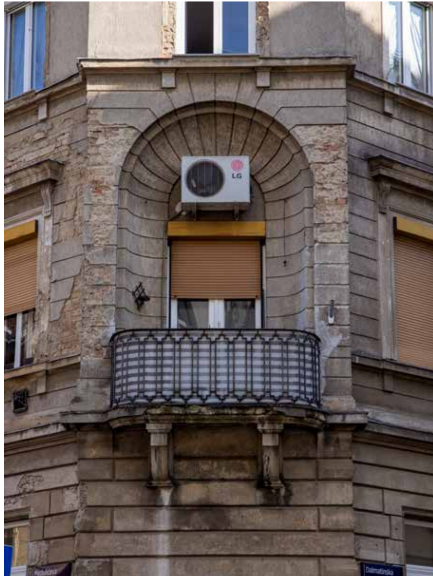
Ugaoni rizalit s balkonom
