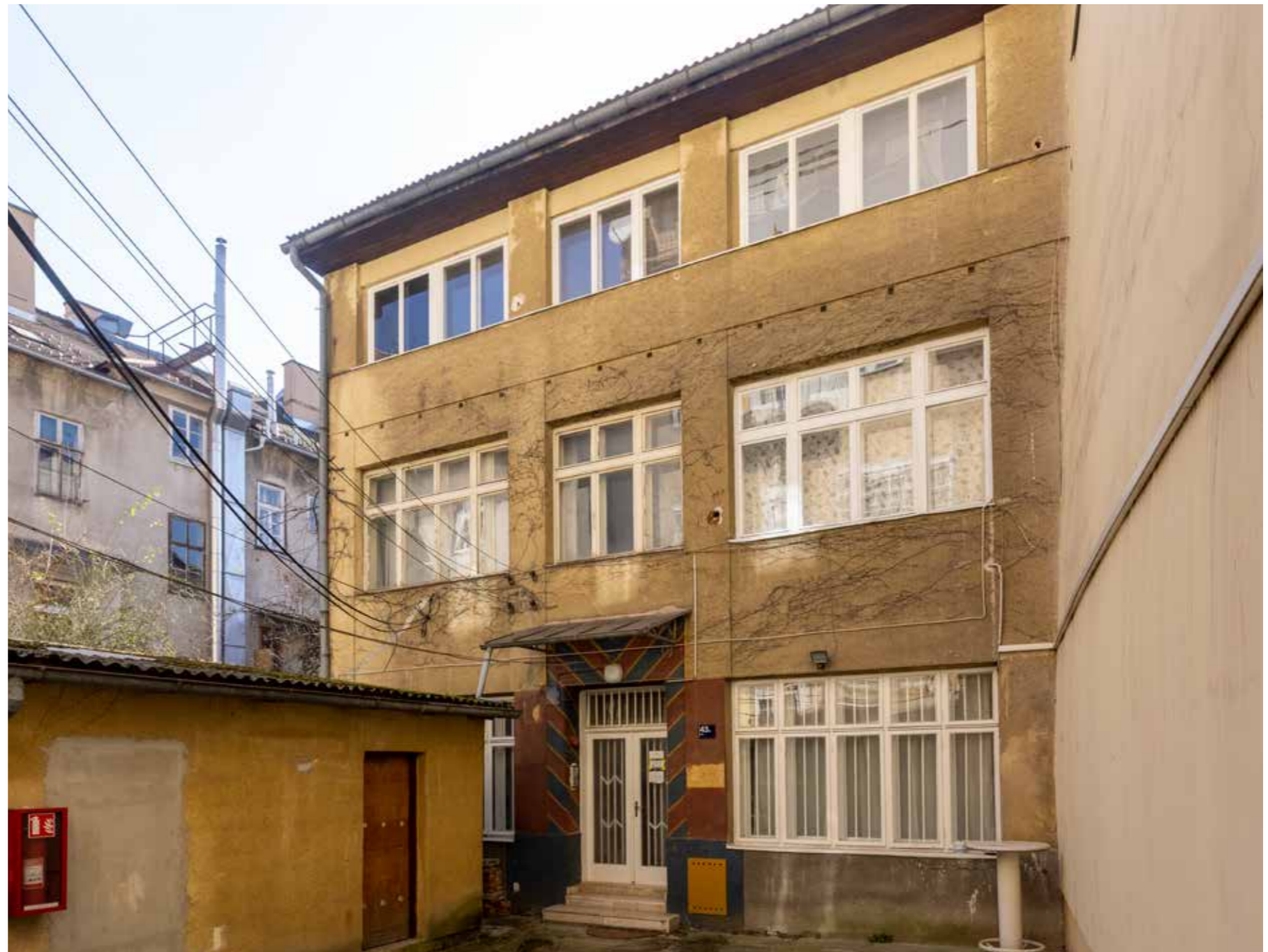
Dvorišno sjeverno pročelje
