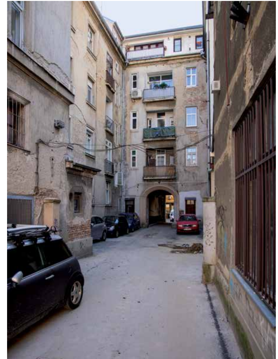
Dvorišno sjeverno začelje
