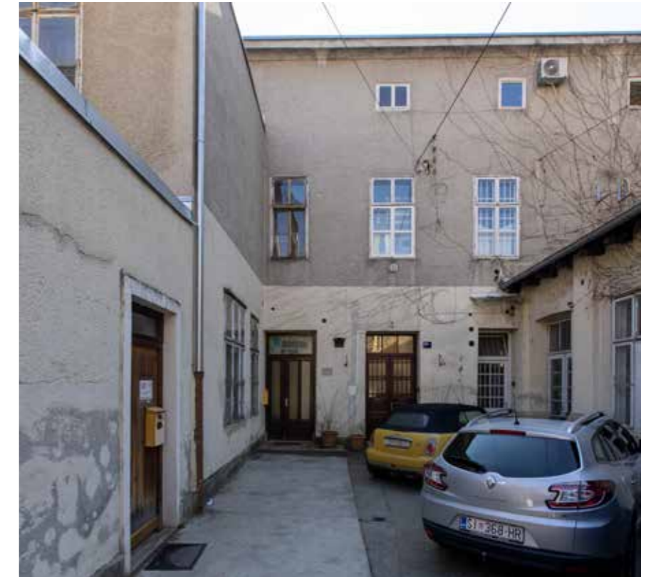
Dvorišno sjeverno pročelje
