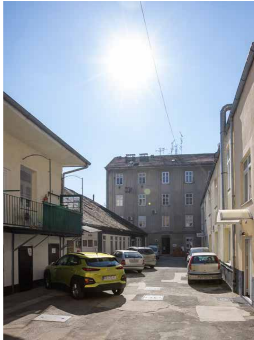
Dvorišno sjeverno pročelje
