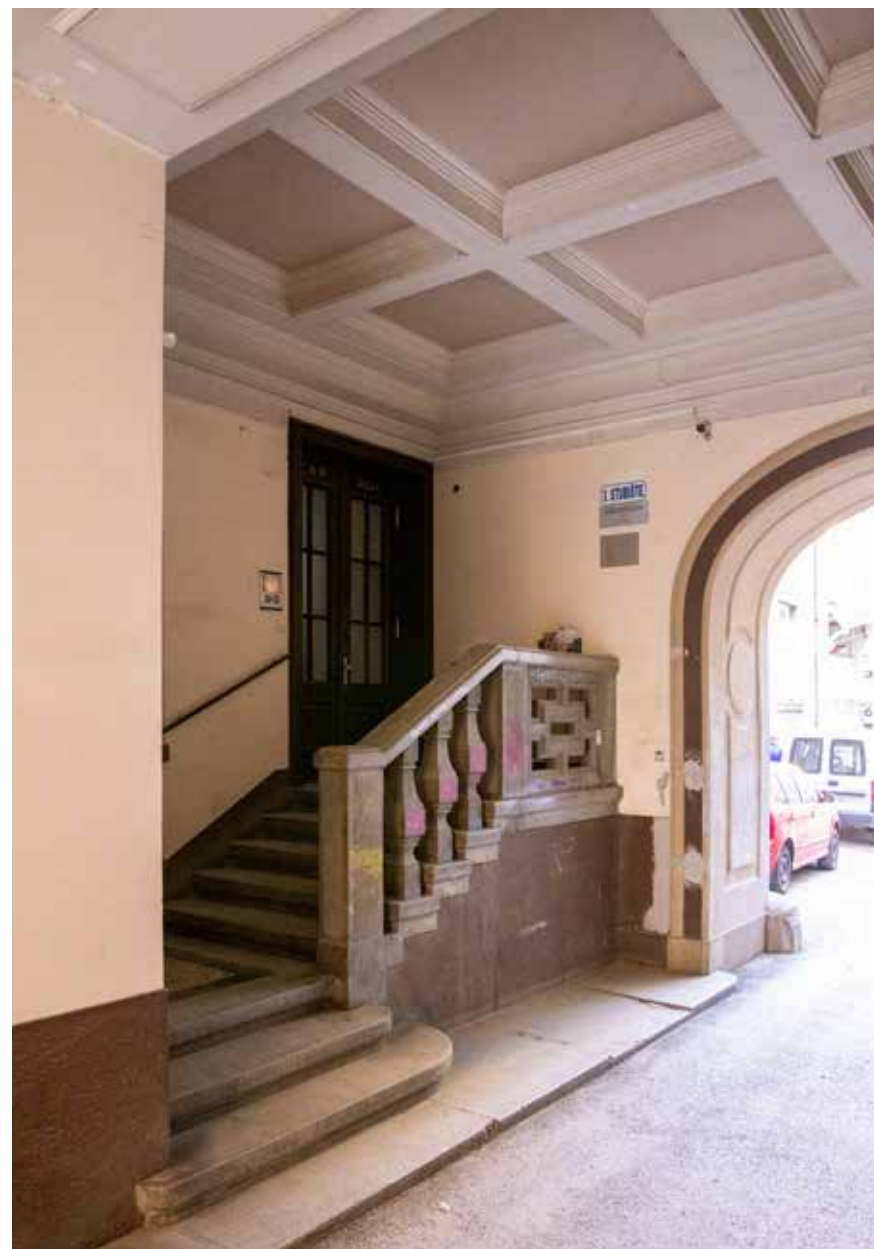
Stubište u veži
