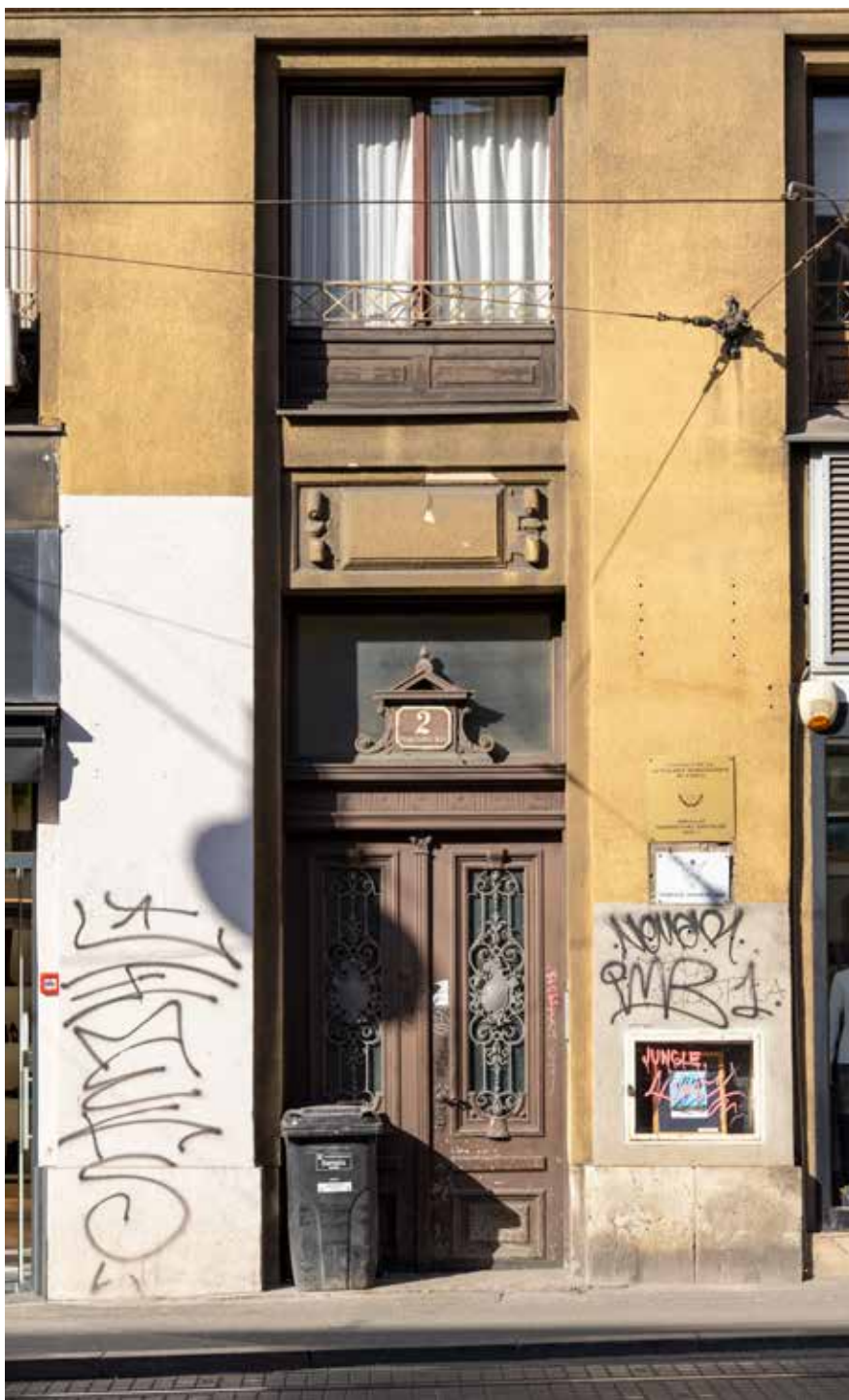
Glavni ulaz na istočnom pročelju
