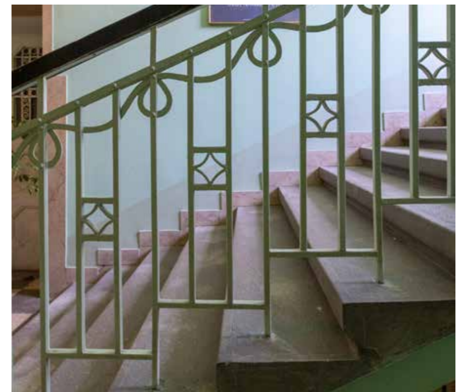
Ograda u stubištu
