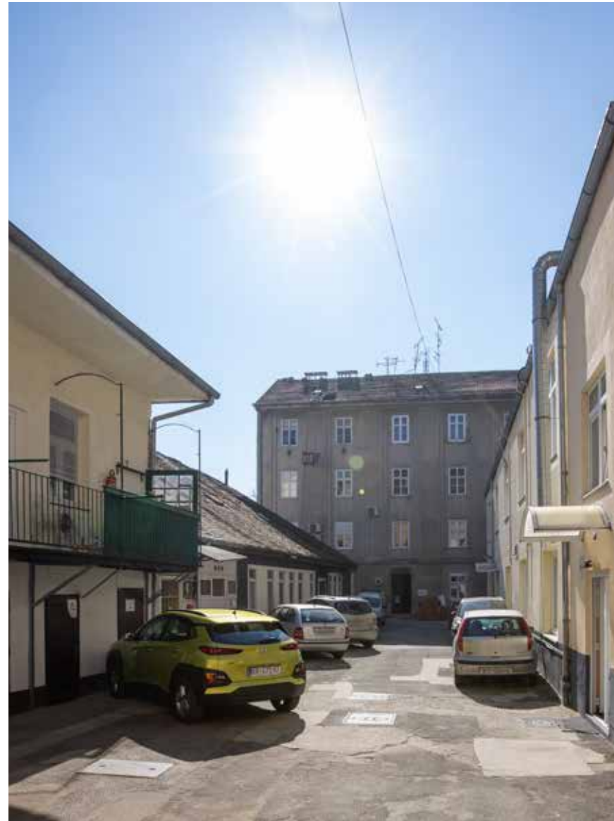
Dvorišno sjeverno pročelje
