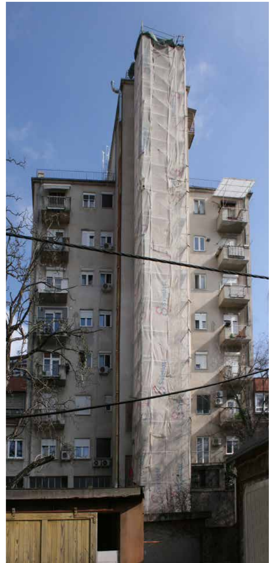
Prva dvorišna zgrada, zapadno pročelje
