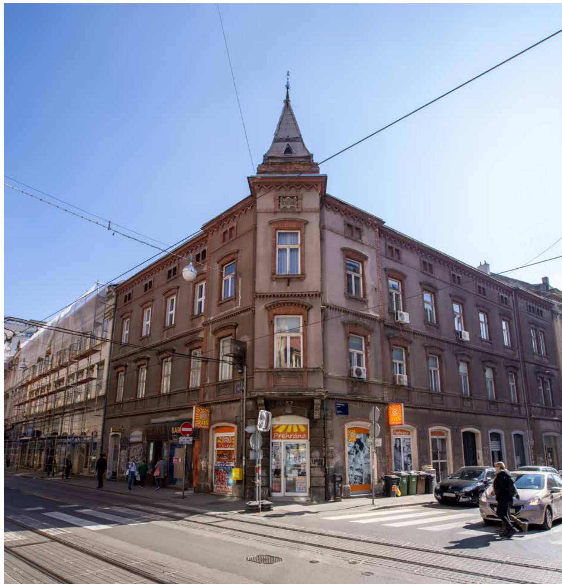
Uglovnica Rossipal, sjeverno i zapadno pročelje
