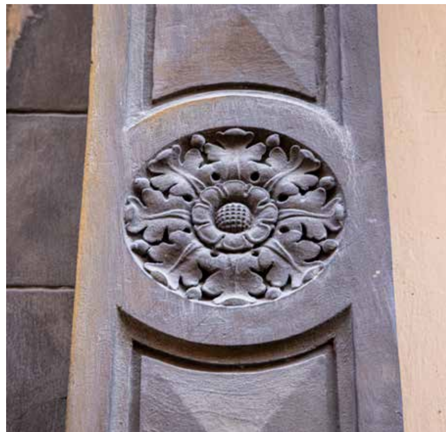
Detalj dovratnika portala
