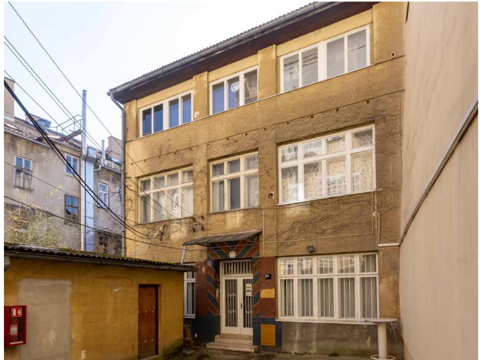
Dvorišno sjeverno pročelje
