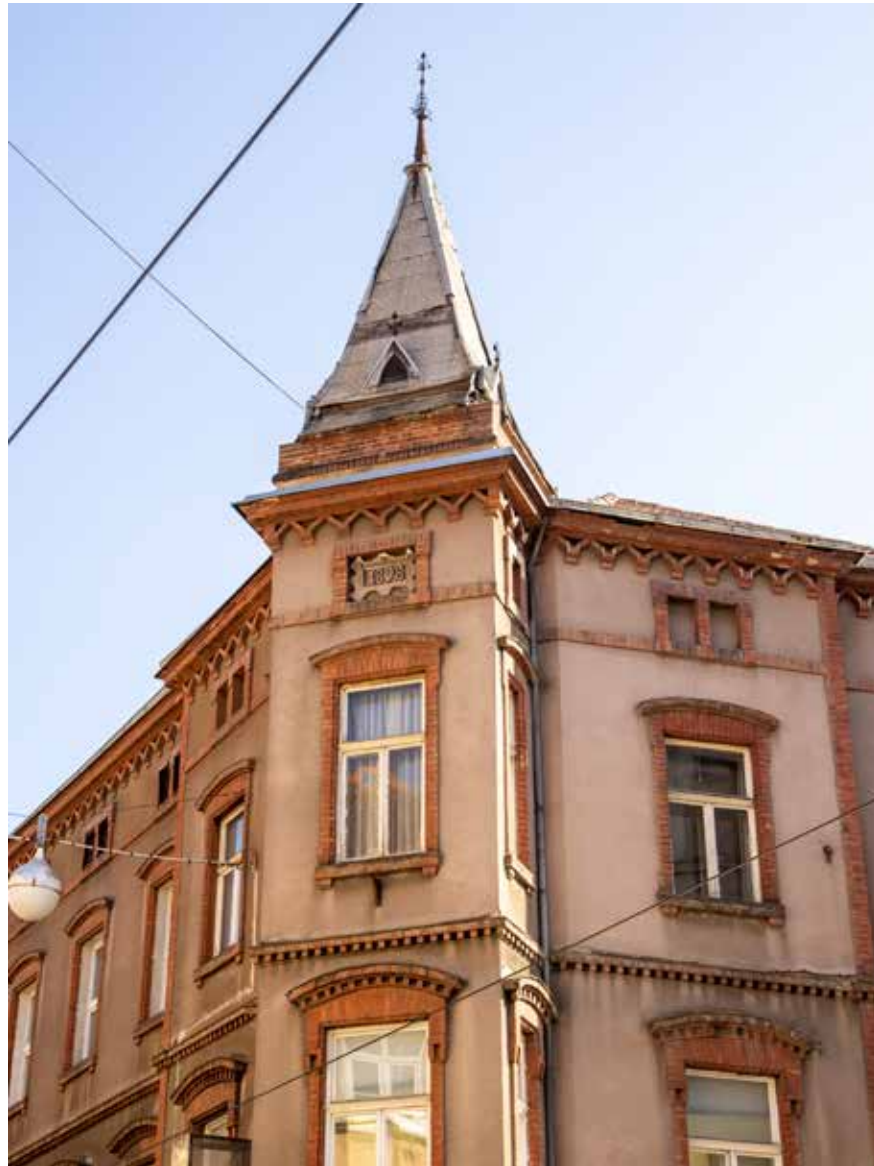
Kuća Rossipal, Medulićeva 2, ugaoni toranj
