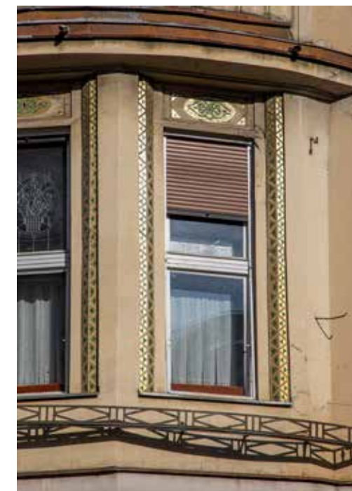
Kuća Pavelić, Dalmatinska 2, secesijski detalj proćelja
