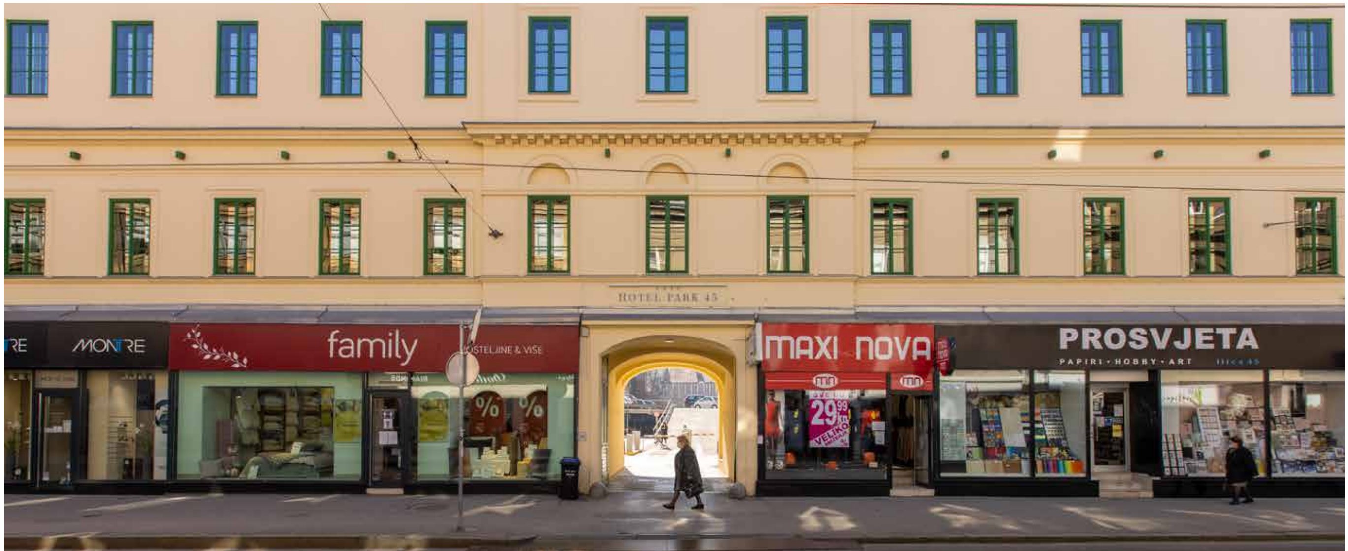
Ulično sjeverno pročelje
