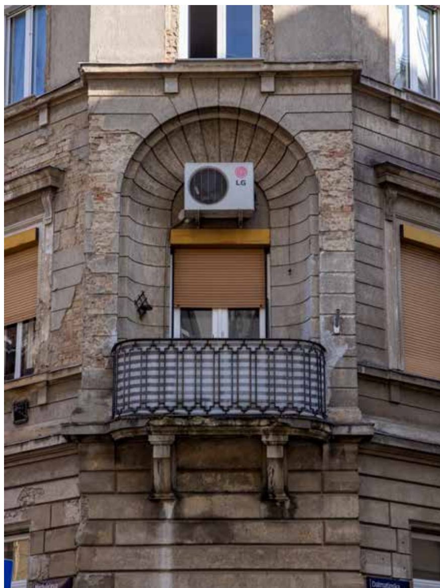
Ugaoni rizalit s balkonom
