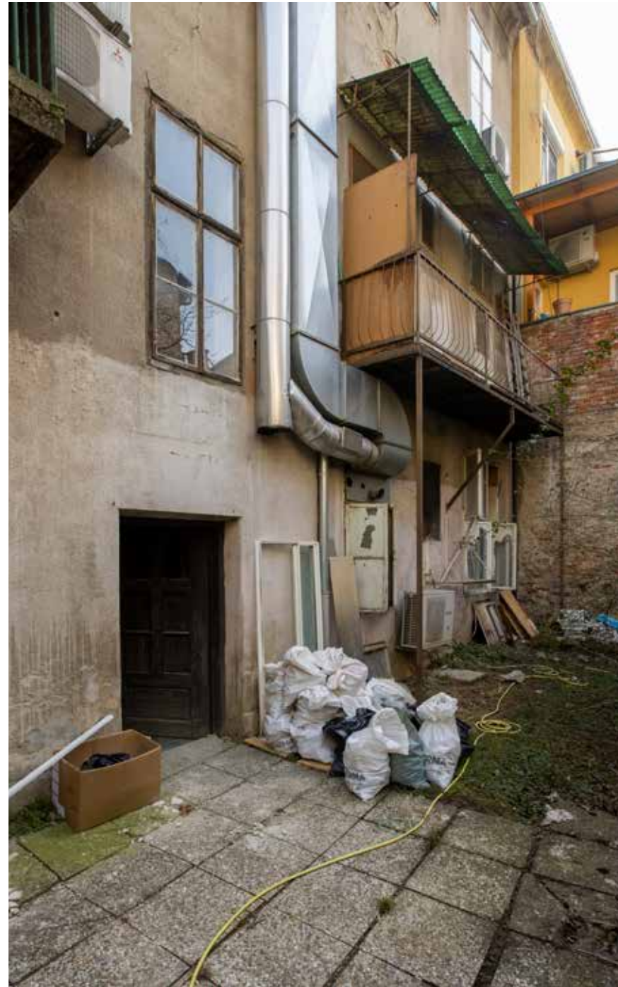
Dvorišno zapadno začelje
