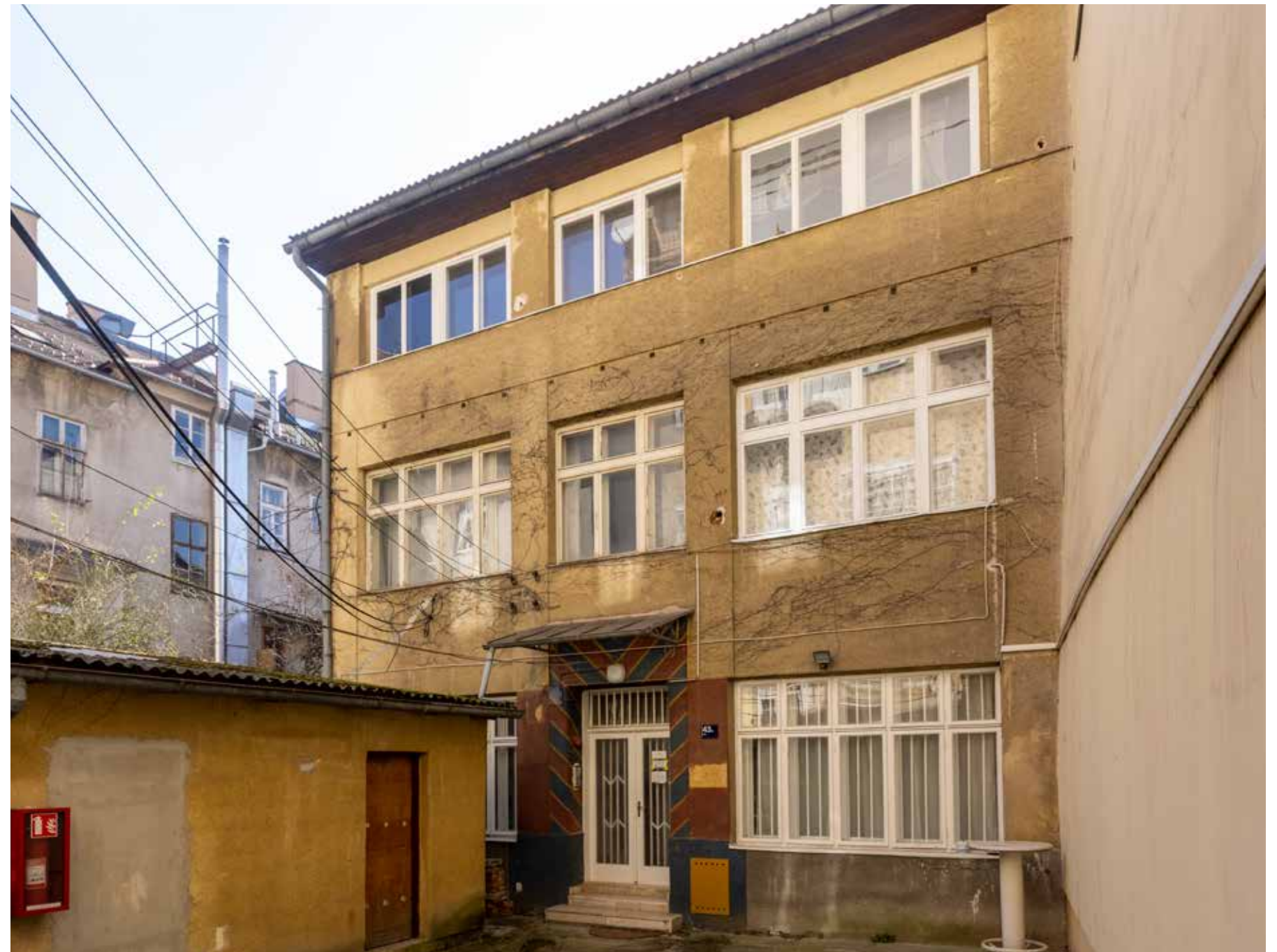
Dvorišno sjeverno pročelje
