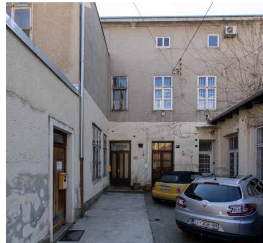
Dvorišno sjeverno pročelje
