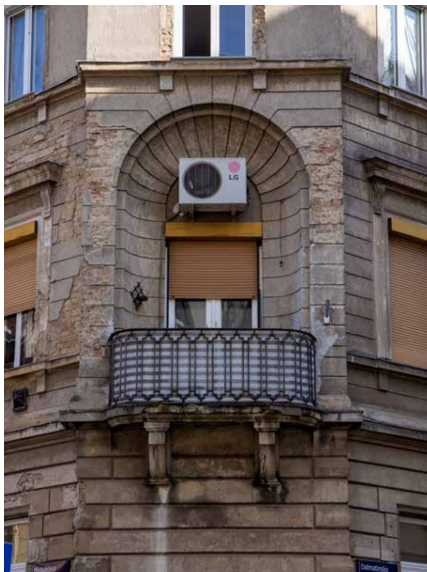
Ugaoni rizalit s balkonom
