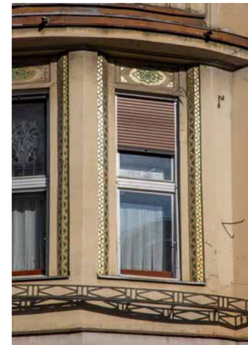
Kuća Pavelić, Dalmatinska 2, secesijski detalj pročelja
