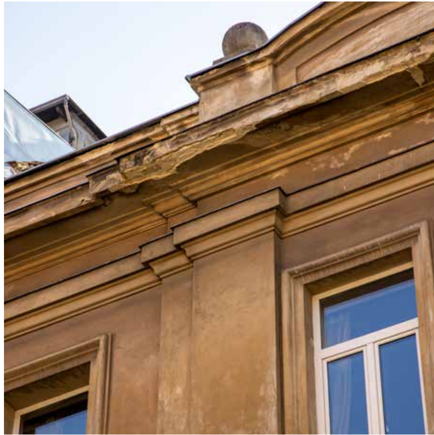
Detalj pilastra i završnog vijenca pročelja
