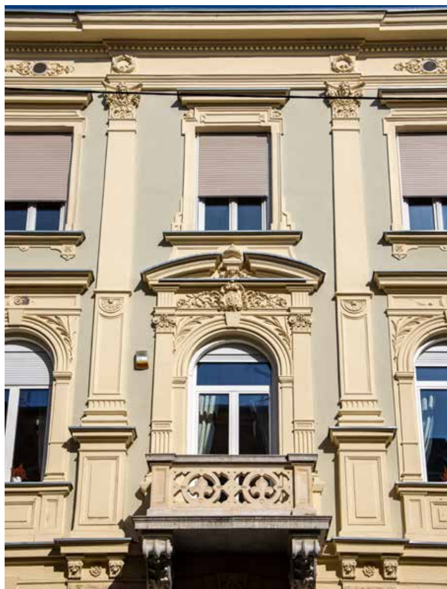
Balkon na prvom katu
