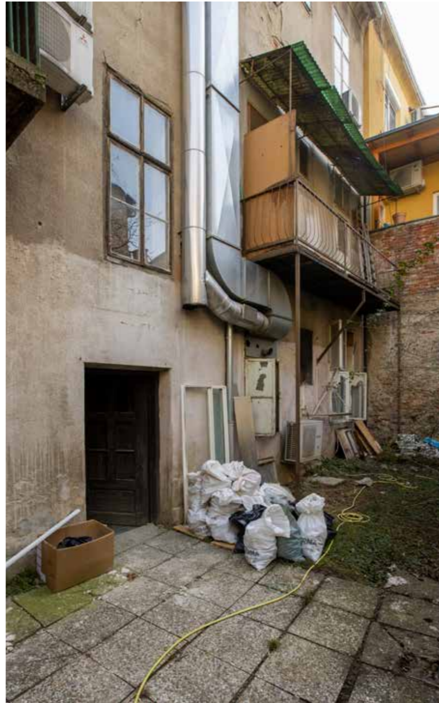
Dvorišno zapadno začelje
