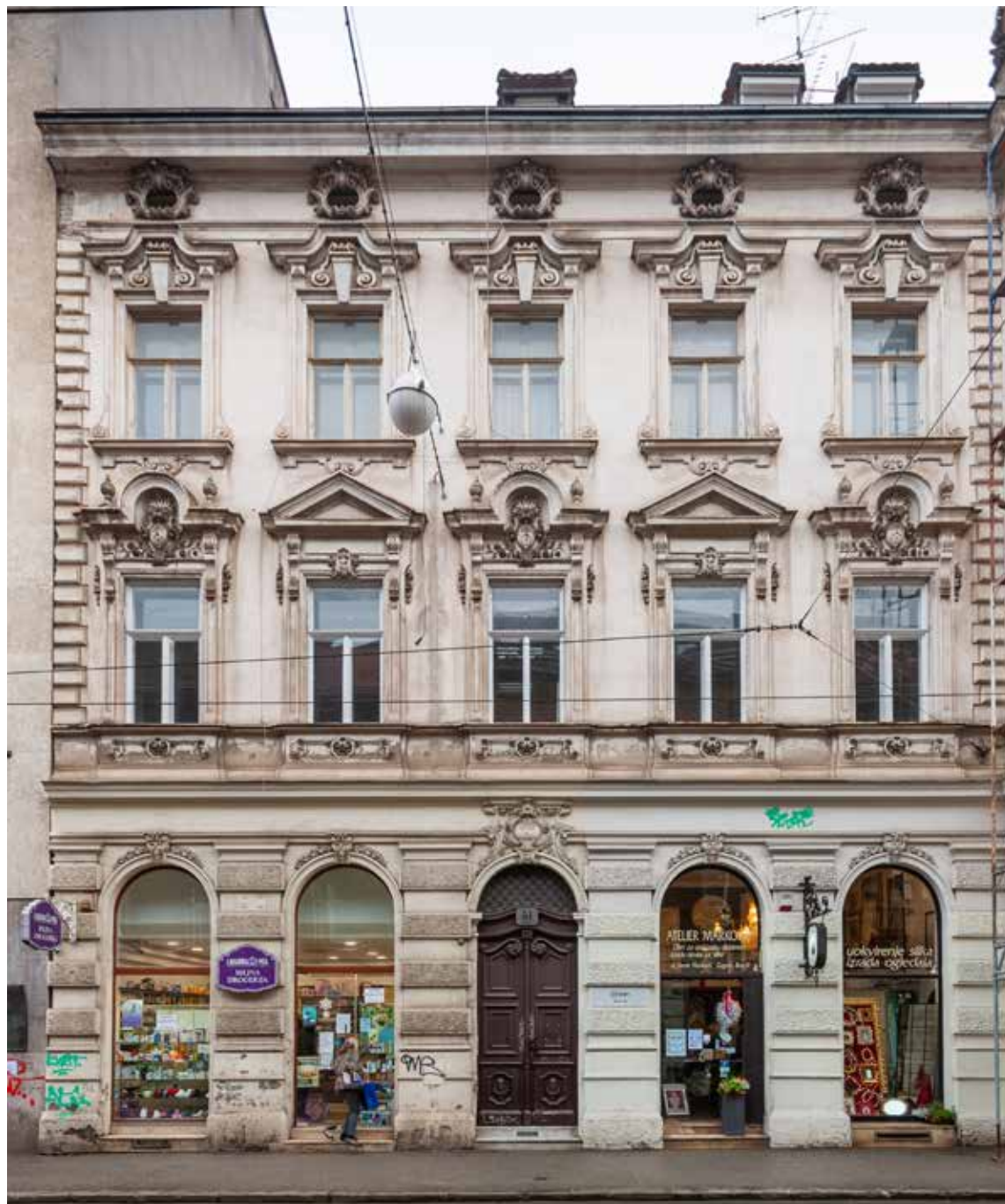
Ulično sjeverno pročelje (br. 51)
