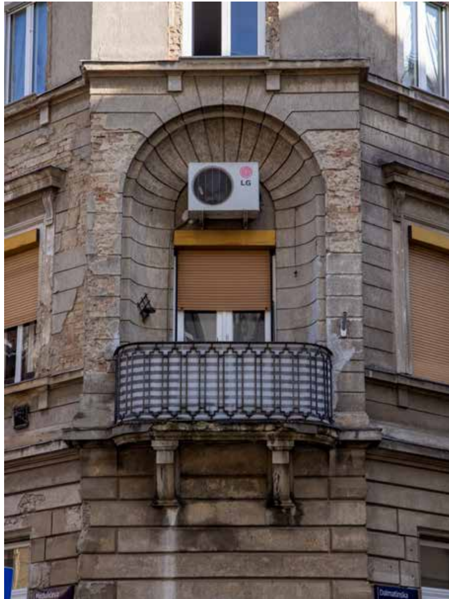
Ugaoni rizalit s balkonom
