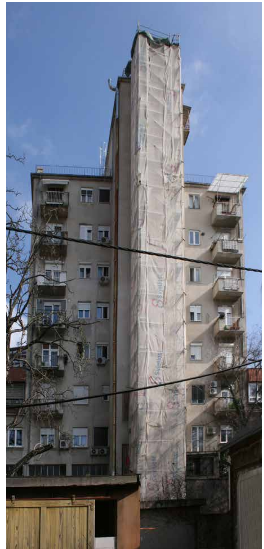
Prva dvorišna zgrada, zapadno pročelje
