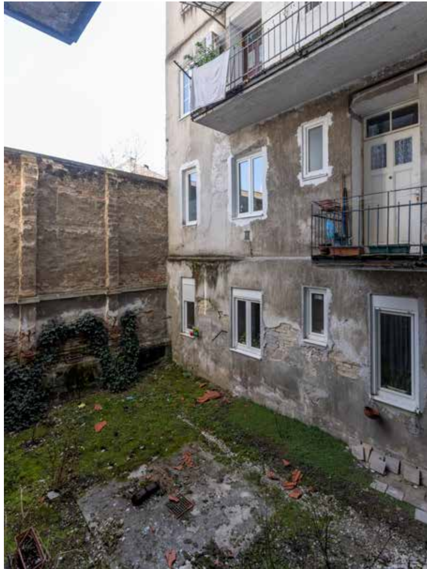
Dvorište uz južno začelje
