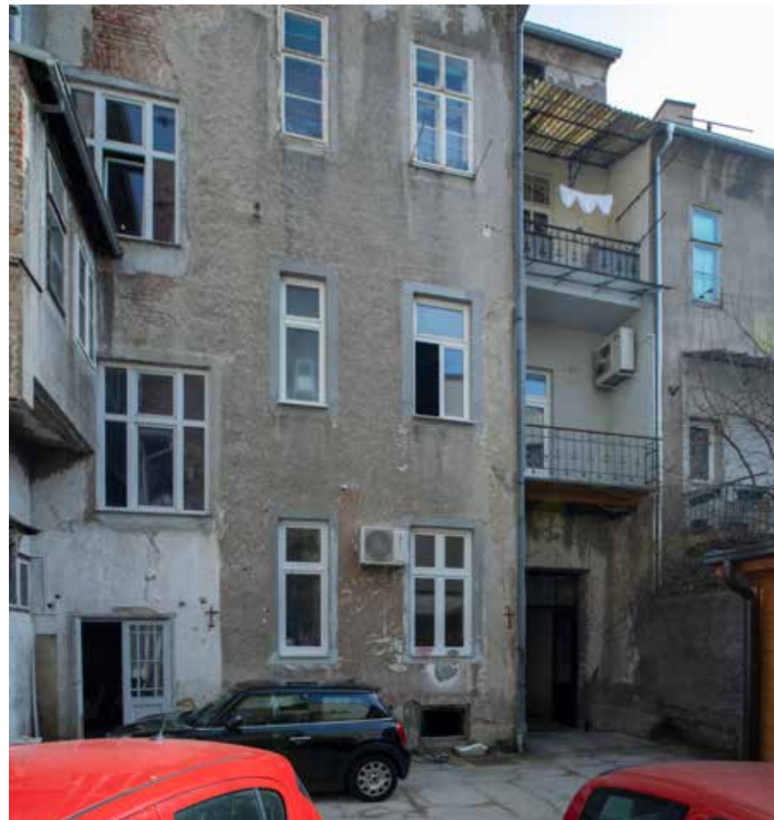
Dvorišno zapadno začelje
