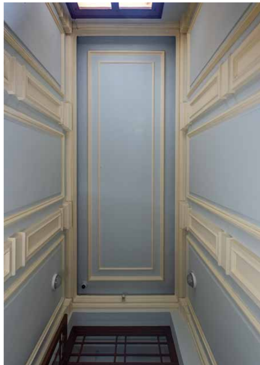
Strop u ulaznom prostoru
