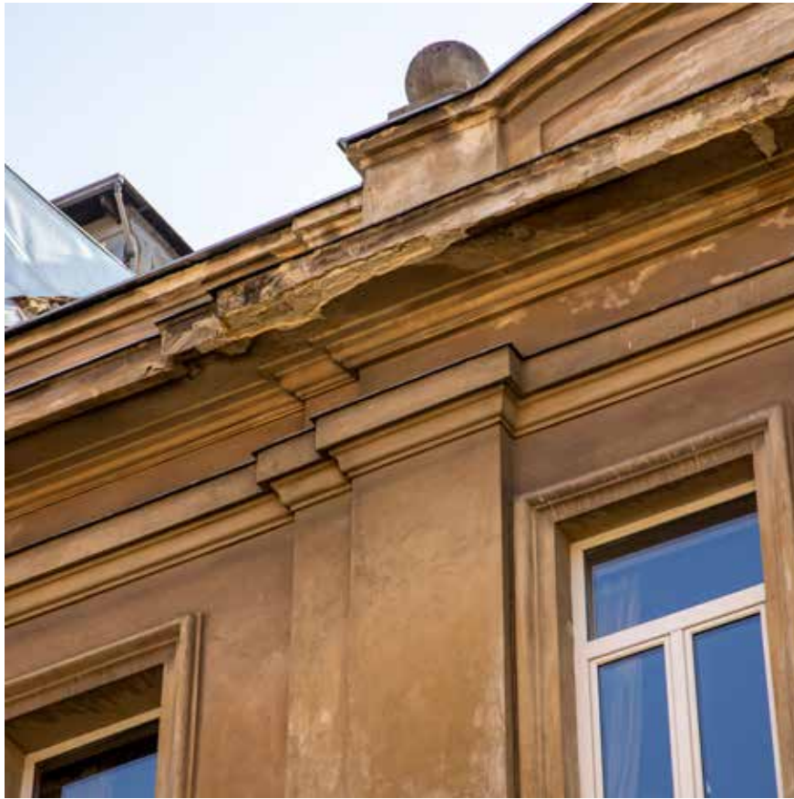
Detalj pilastra i završnog vijenca pročelja
