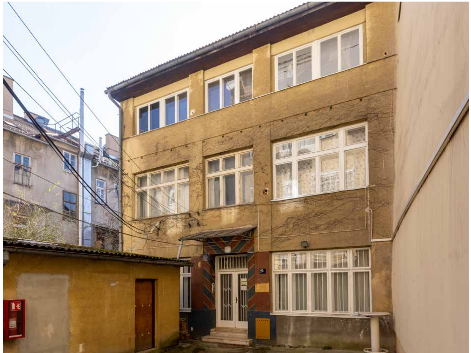
Dvorišno sjeverno pročelje
