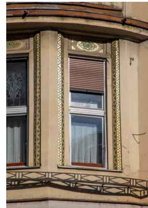
Kuća Pavelić, Dalmatinska 2, secesijski detalj proćelja
