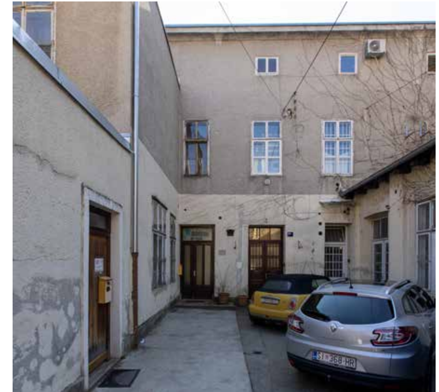
Dvorišno sjeverno pročelje
