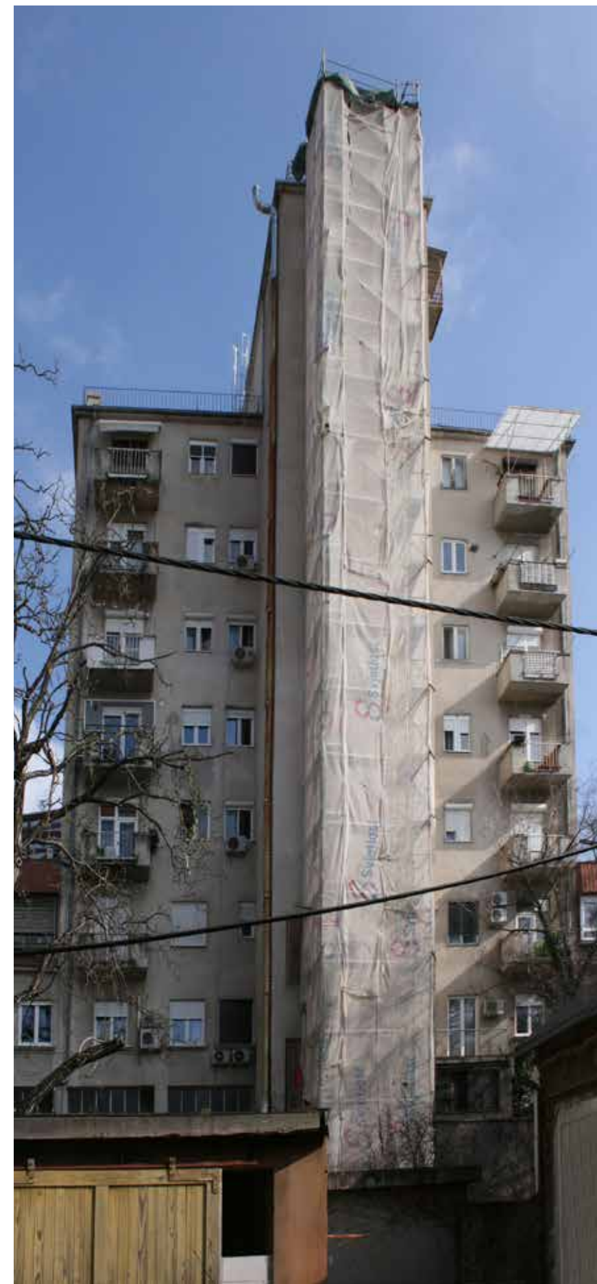
Prva dvorišna zgrada, zapadno pročelje
