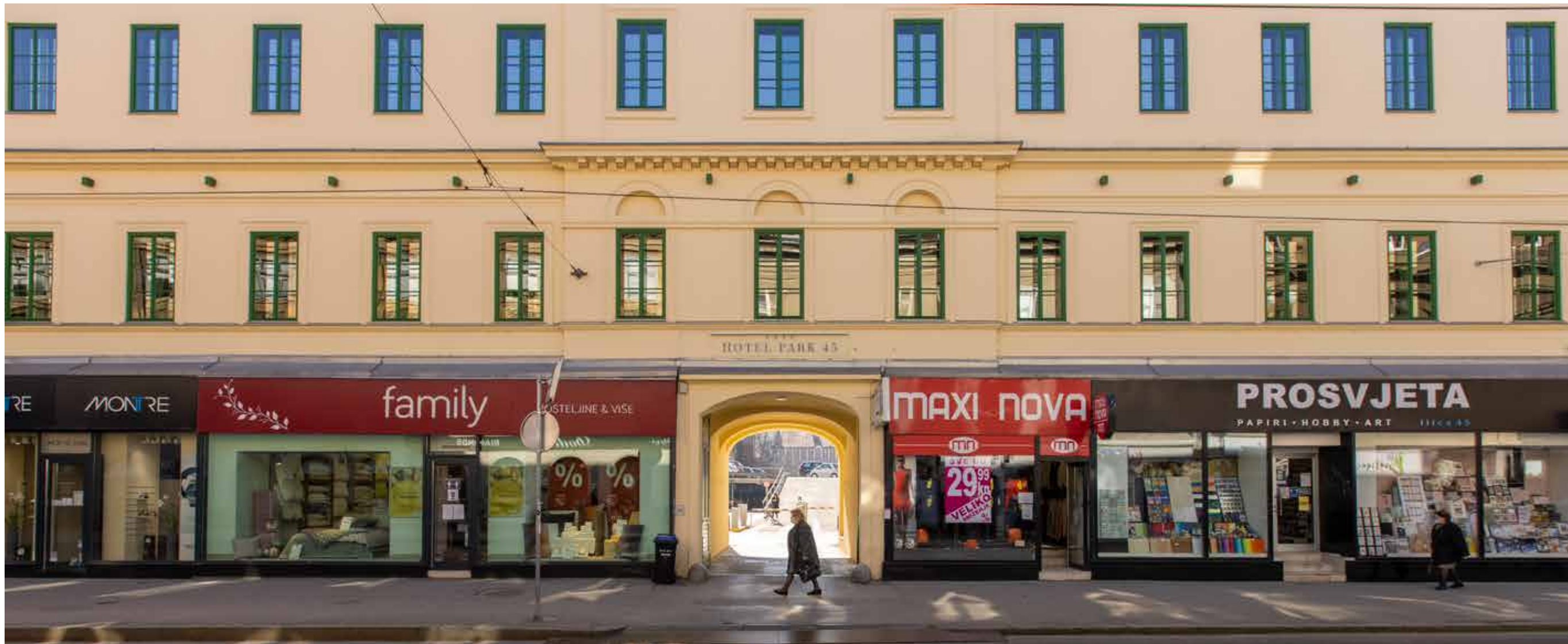
Ulično sjeverno pročelje
