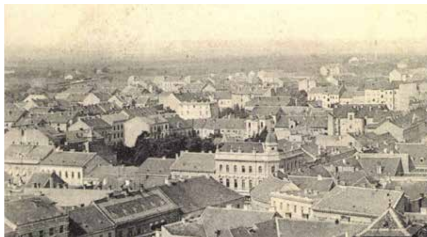
Pogled na Blok 19, 19./20. stoljeće
