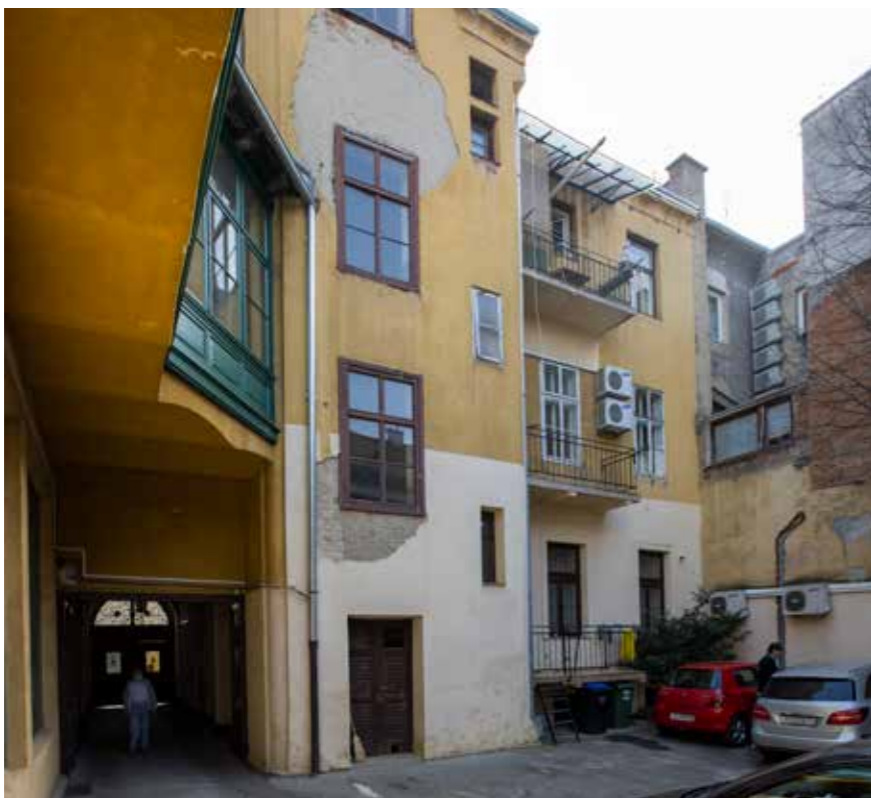
Dvorišno zapadno začelje
