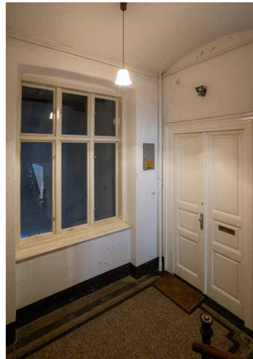
Prozor u stubištu i ulaz u stan
