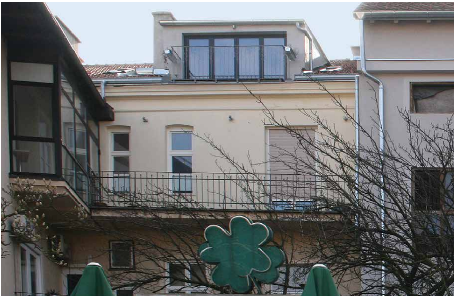
Dvorišno sjeverno začelje
