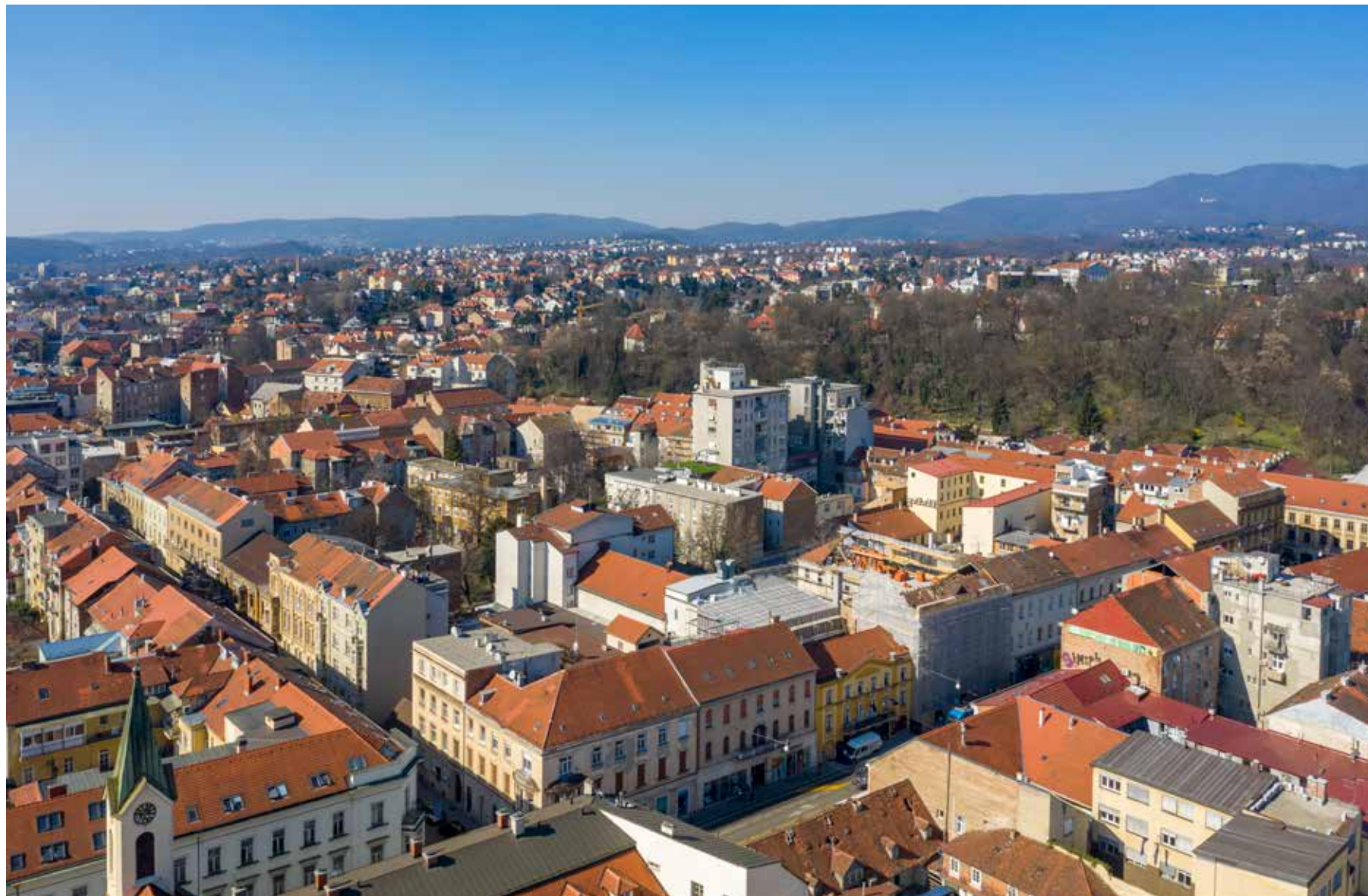
Pogled na Blok 19 s jugoistoka
