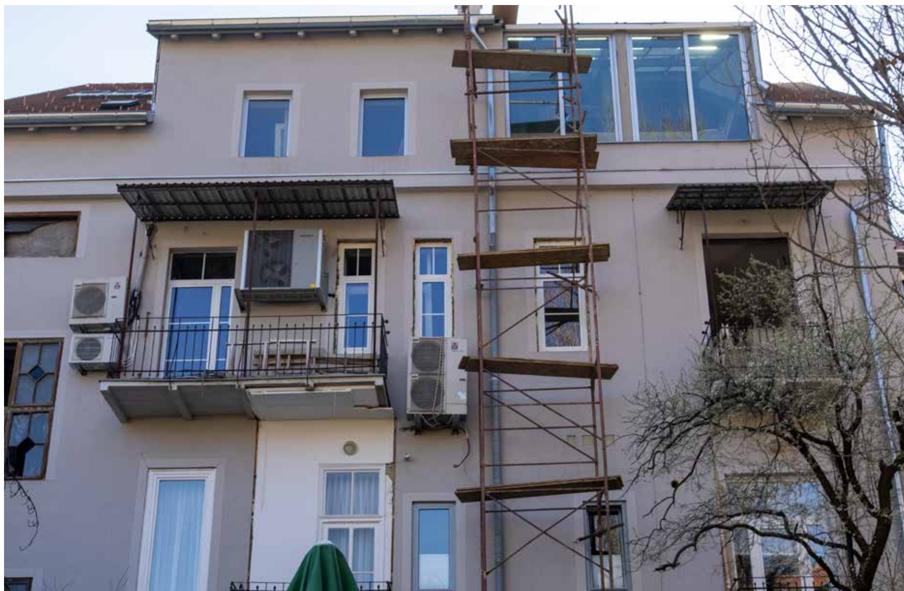
Dvorišno sjeverno začelje
