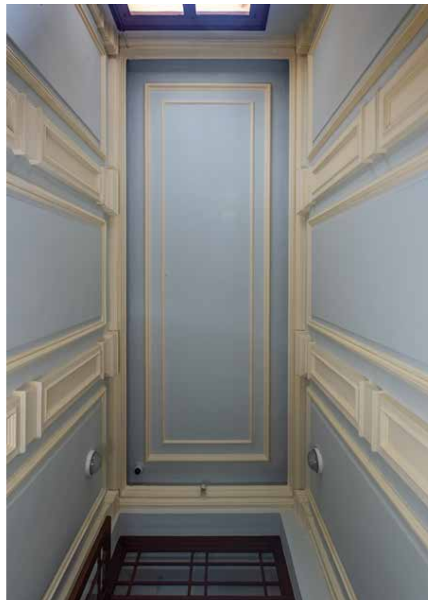
Strop u ulaznom prostoru
