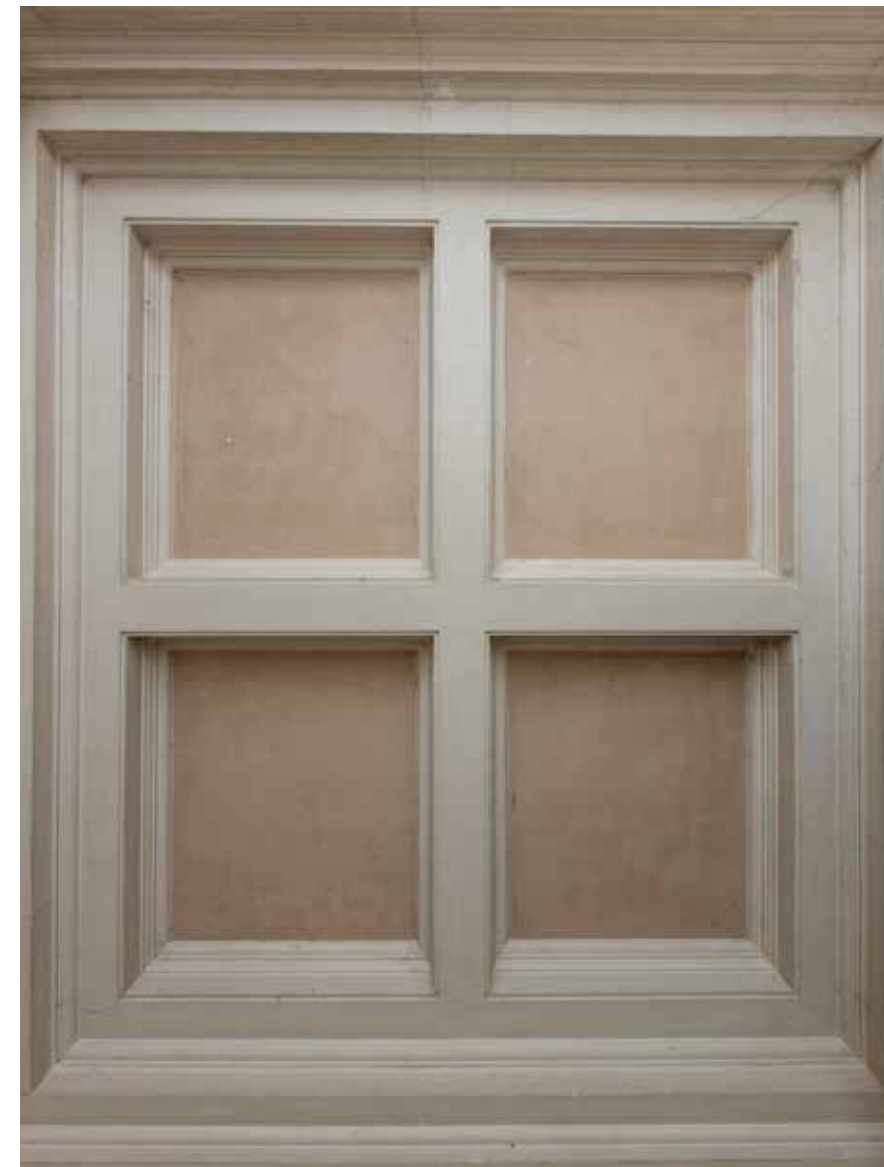
Zgrada Zemaljskog društva općinskih činovnika Hrvatske i Slavonije, Dalmatinska 12, detalj kazetiranog stropa u veži
