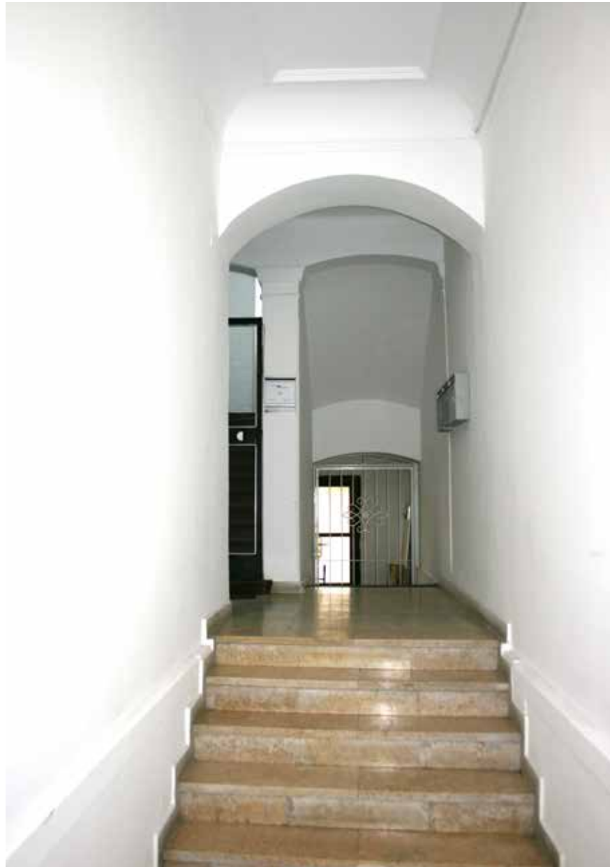
Ulazni prostor i stubište
