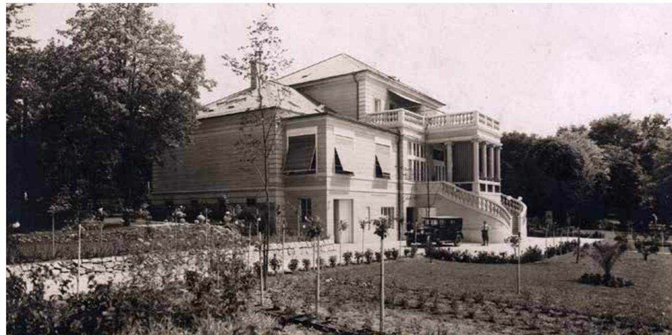
Vila Marić, pogled s jugozapada, nakon rekonstrukcije 1928. godine, MUO
