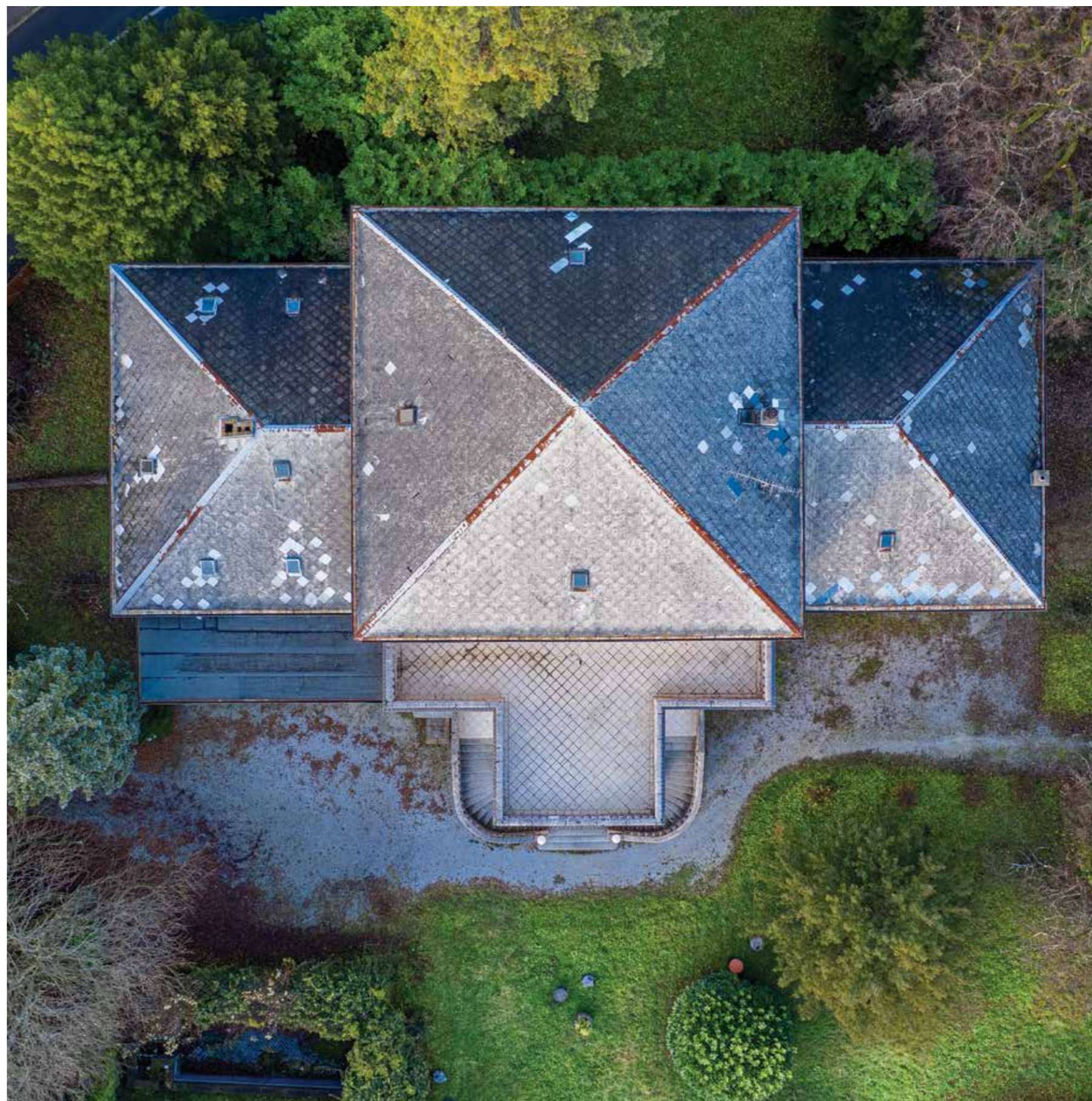
Pogled na krovište, terasu kata i glavno stubište
