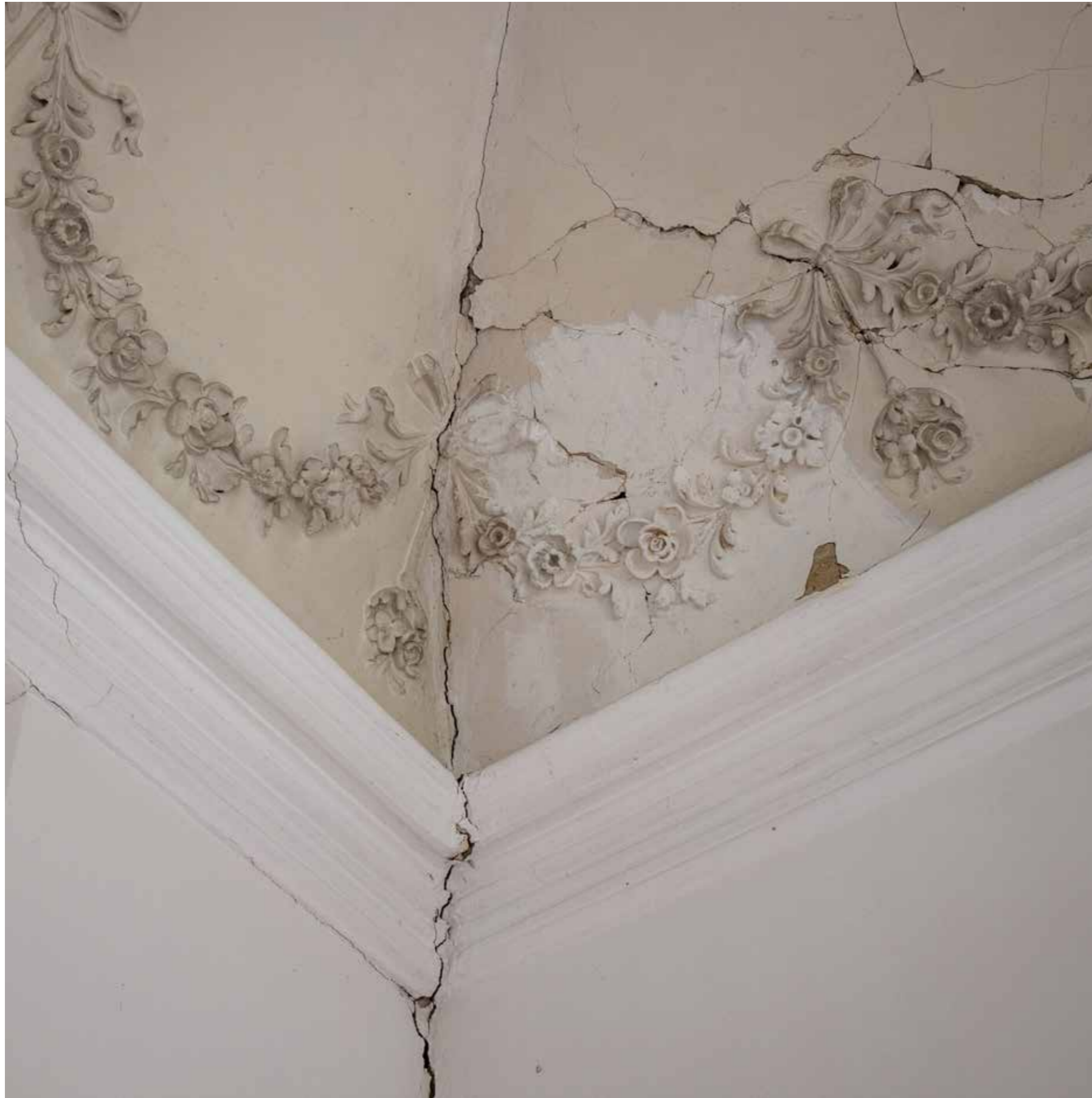
Prizemlje, oprema izložbene prostorije – južnog salona, štuko-dekoracija zrcalnog svoda
