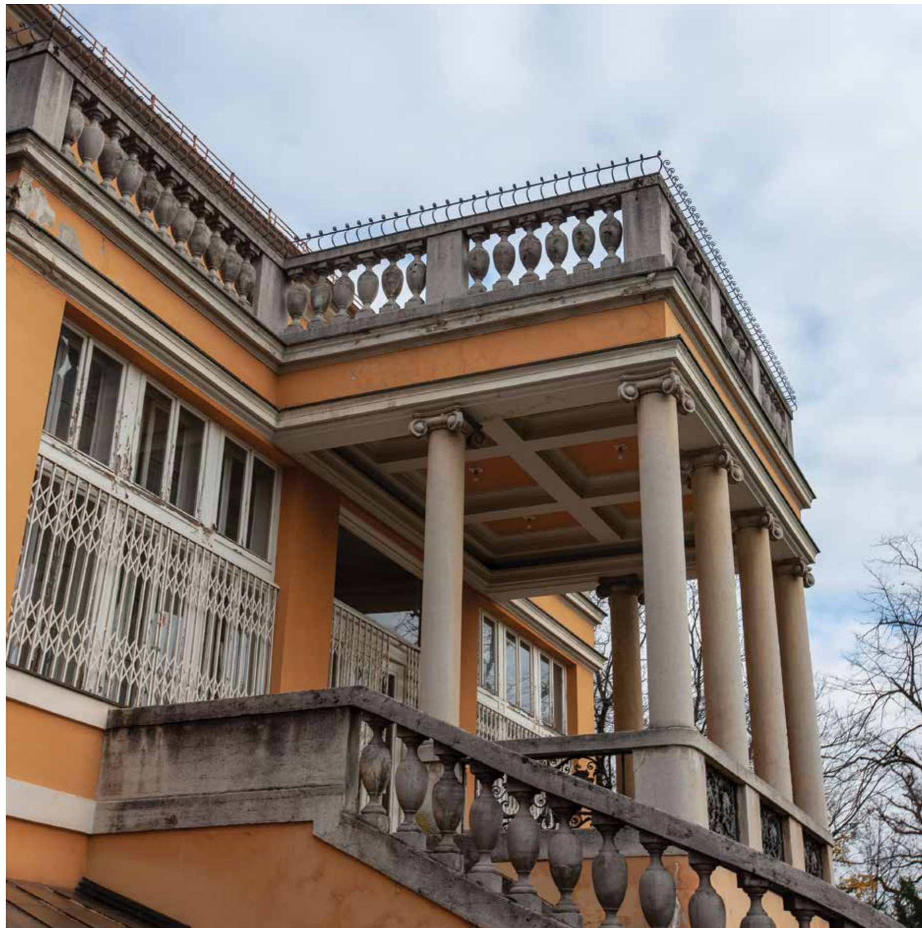
Južno pročelje, kolonada jonskih stupova ulaznog trijema
