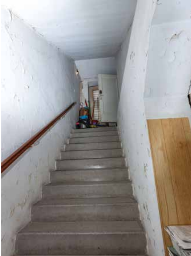
Podrum, unutrašnje stubište između podruma i prizemlja
