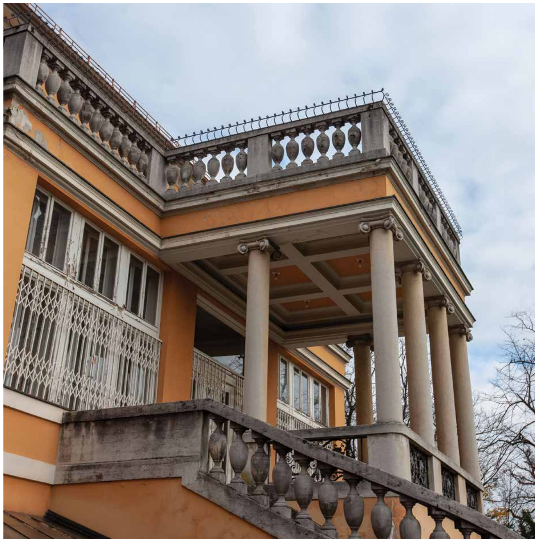
Južno pročelje, kolonada jonskih stupova ulaznog trijema
