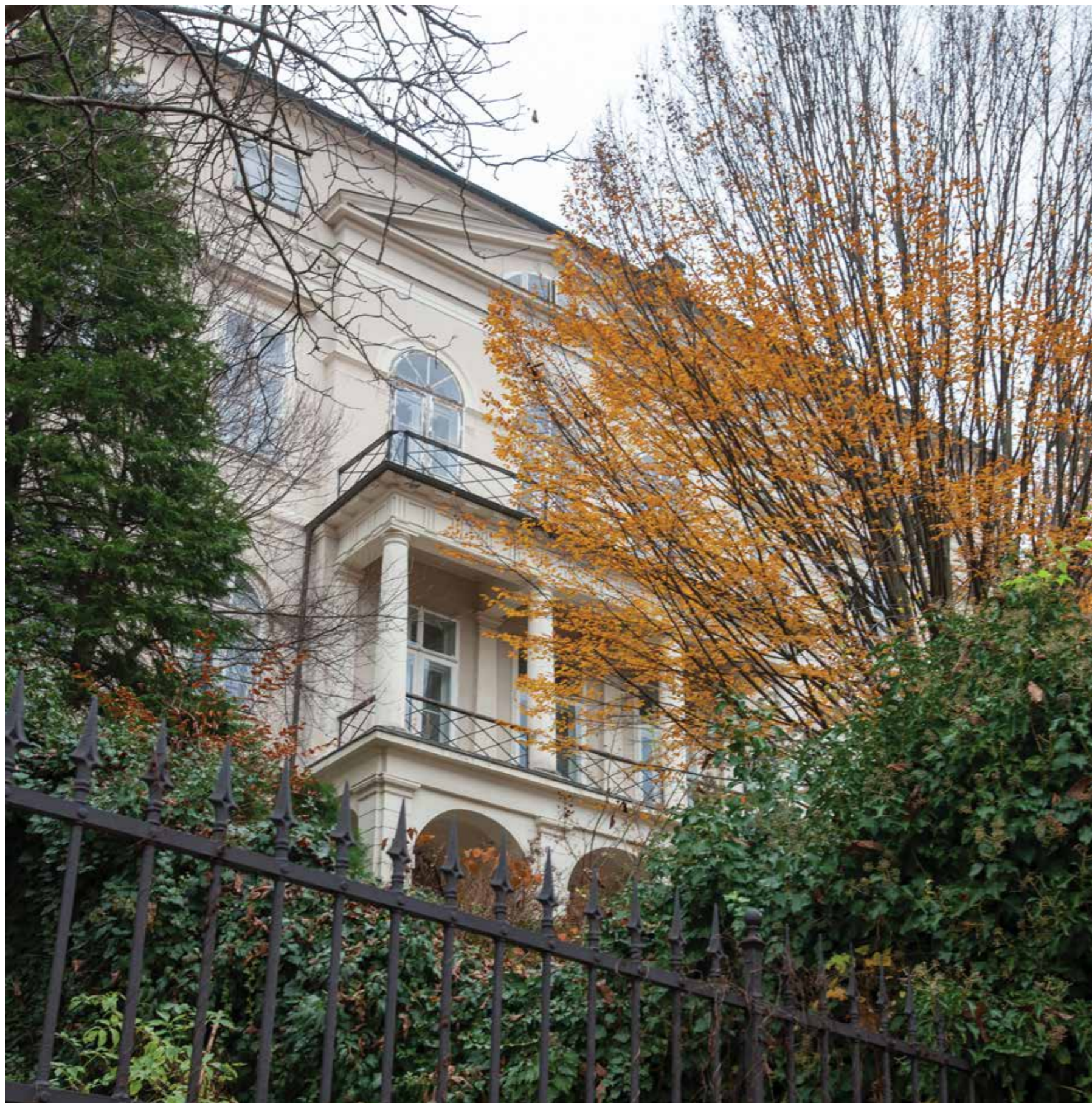
Istočno pročelje s altanom
