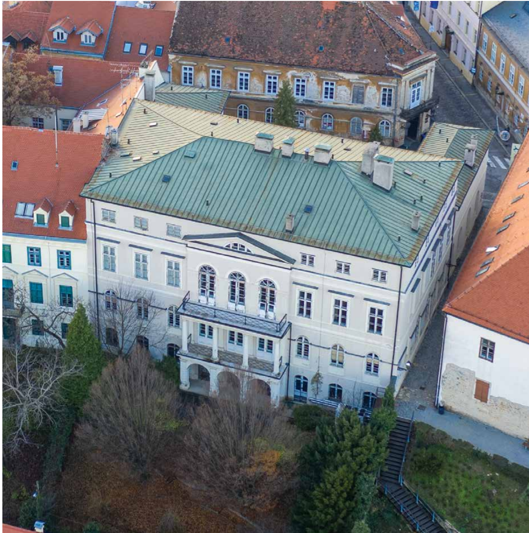
Istočno pročelje s altanom
