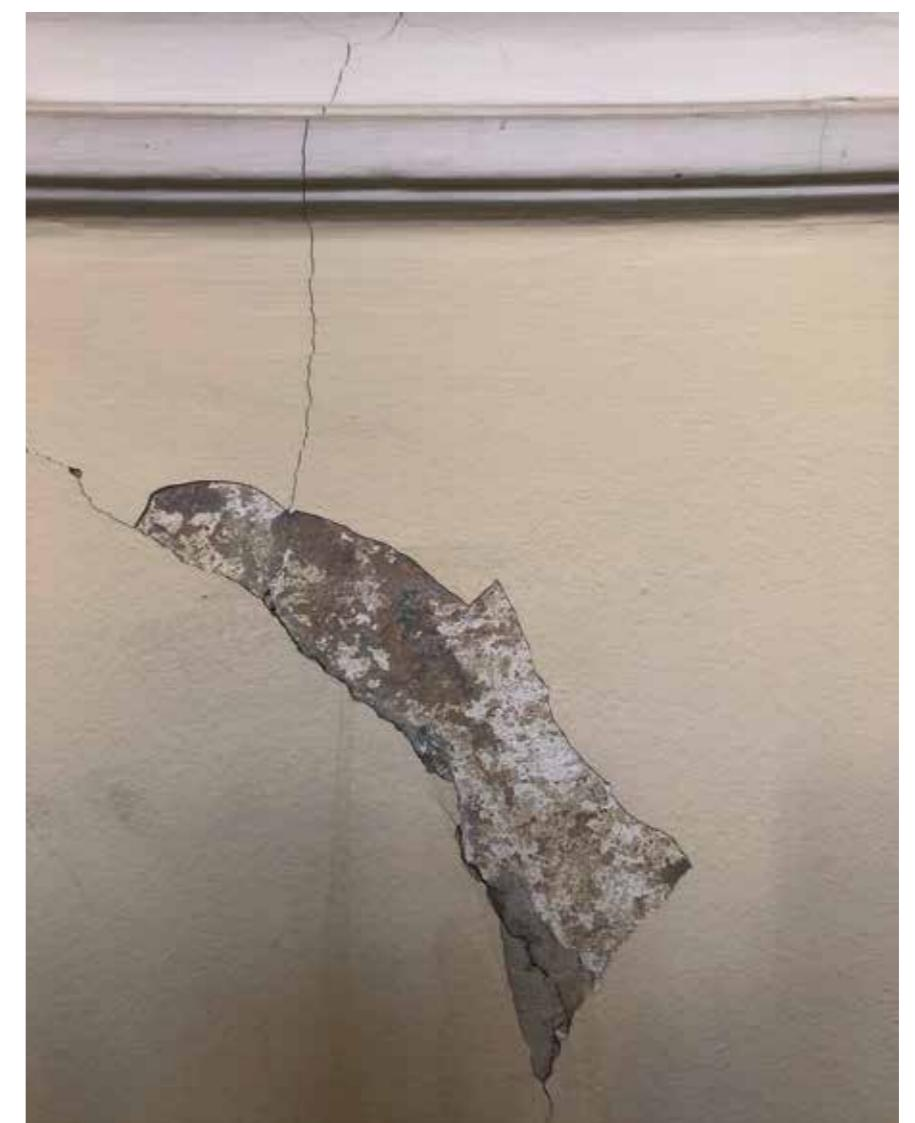
Tipični primjeri oštećenja nastalih u potresu
