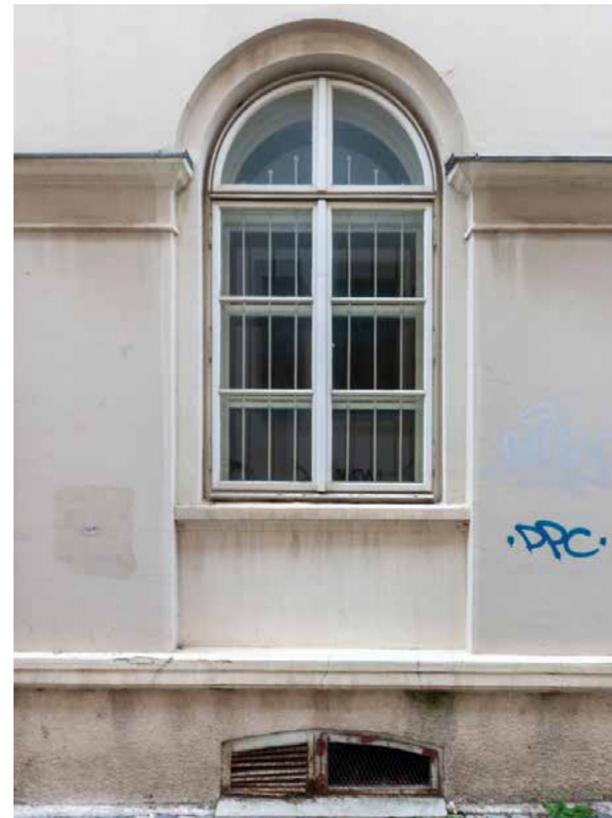
Prozor na sjevernom pročelju
