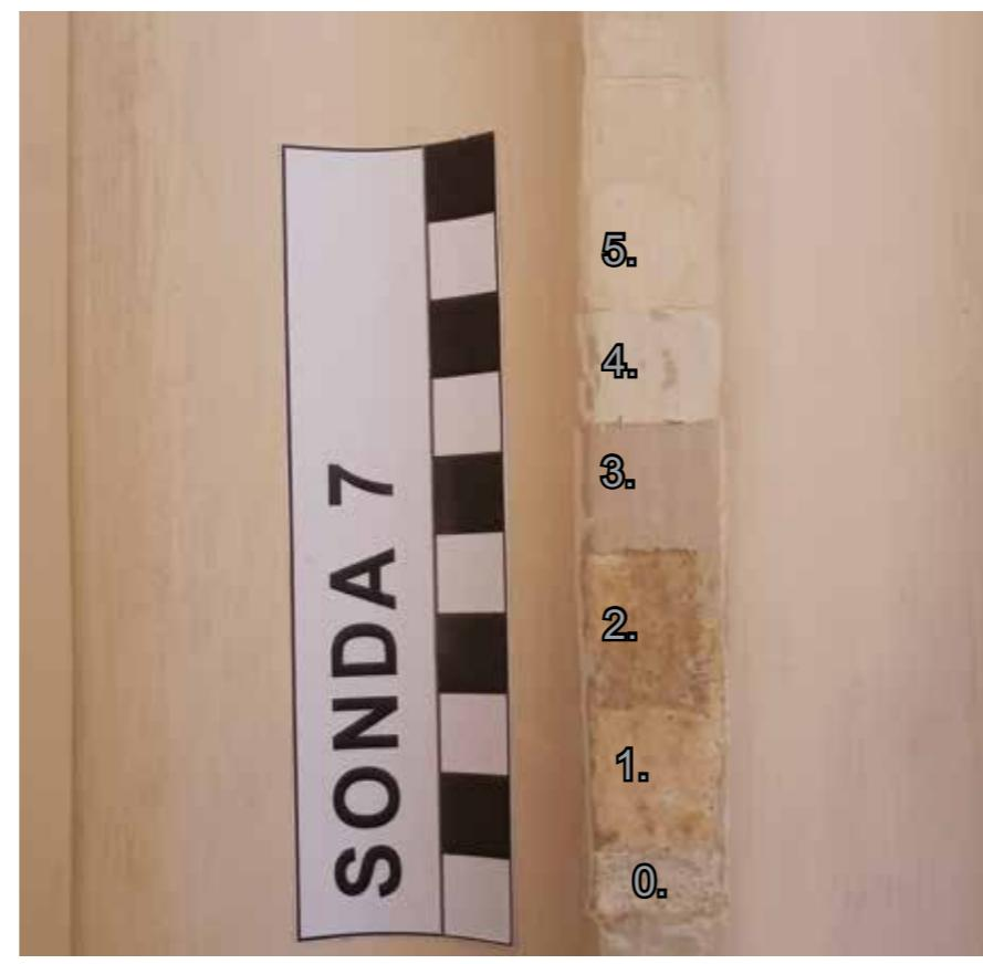
Sonde u stubištu s nalazima starijih oslika i sonda na stupu predvorja prvog kata s izvornim naličem oker boje (sonda 7)
