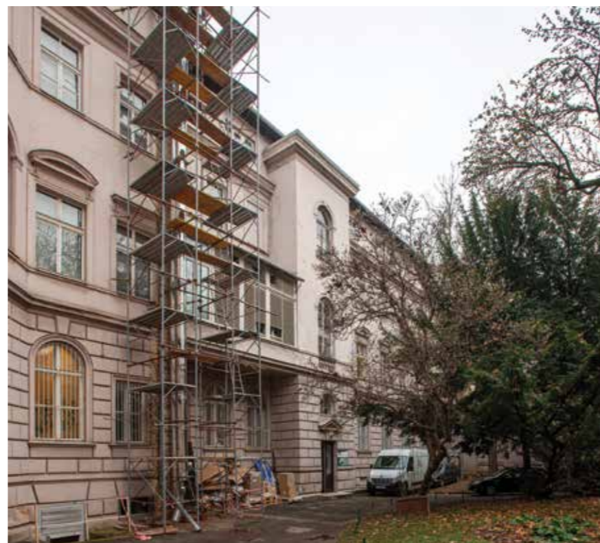
Dvorišna pročelja sjevernog i istočnog krila
