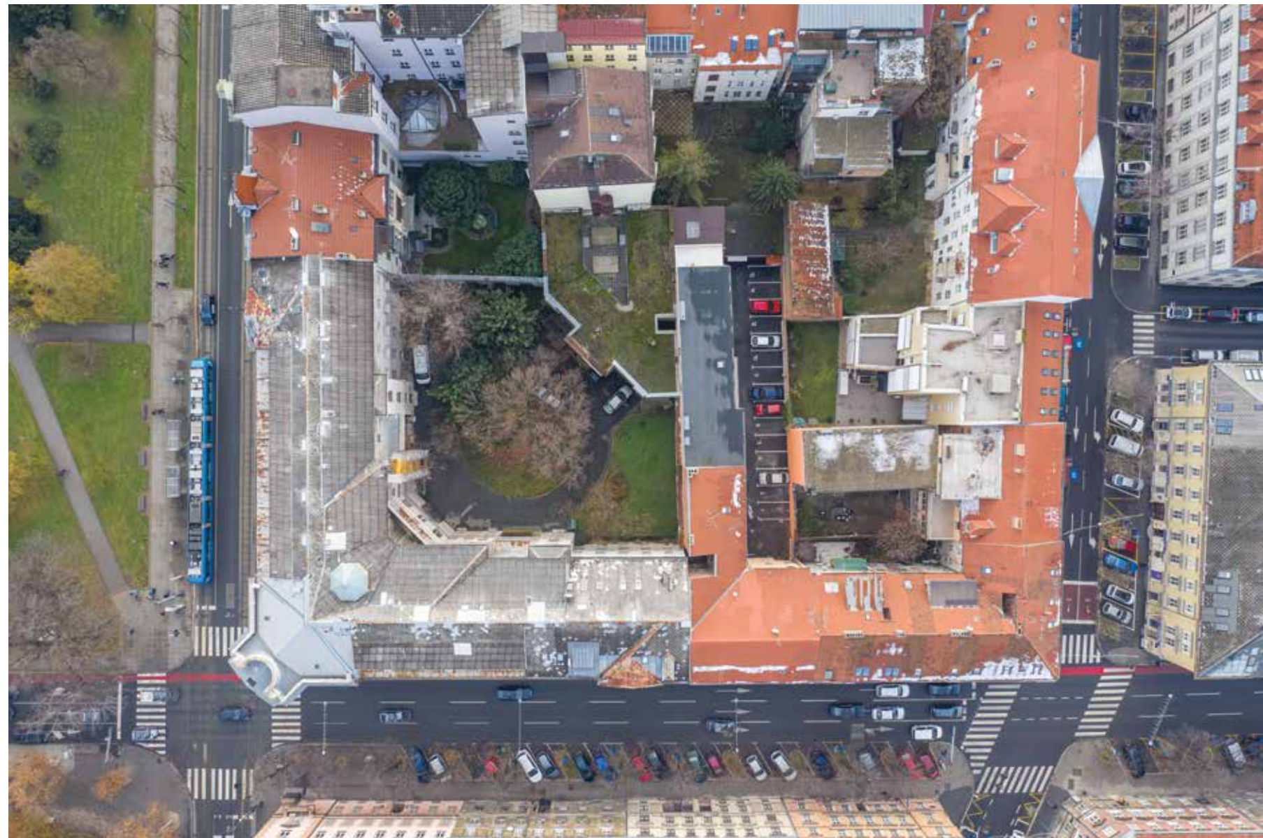
Ortogonalni pogled na blok s kompleksom palače Vranjanzany-Dobrinović
