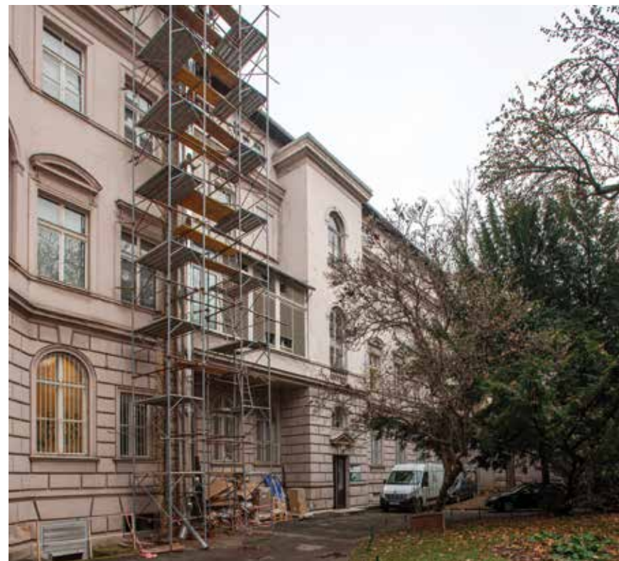
Dvorišna pročelja sjevernog i istočnog krila
