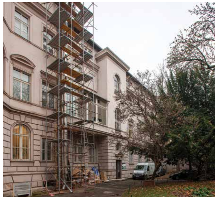
Dvorišna pročelja sjevernog i istočnog krila
