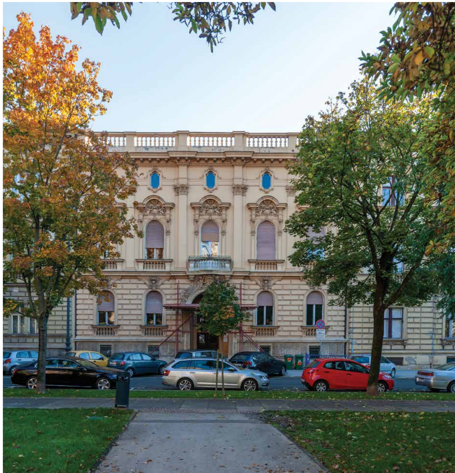
Zapadno ulazno pročelje
