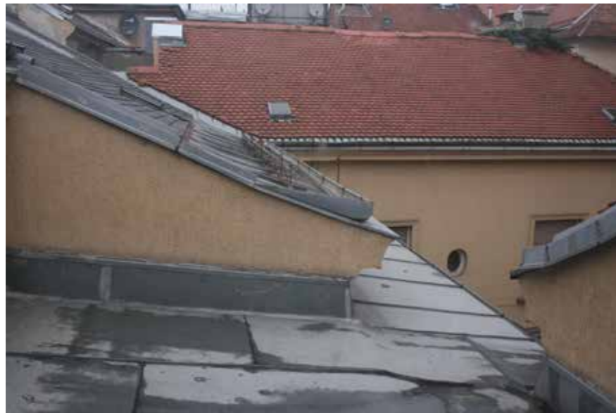
Središnji dio krovišta sa svjetlikom
