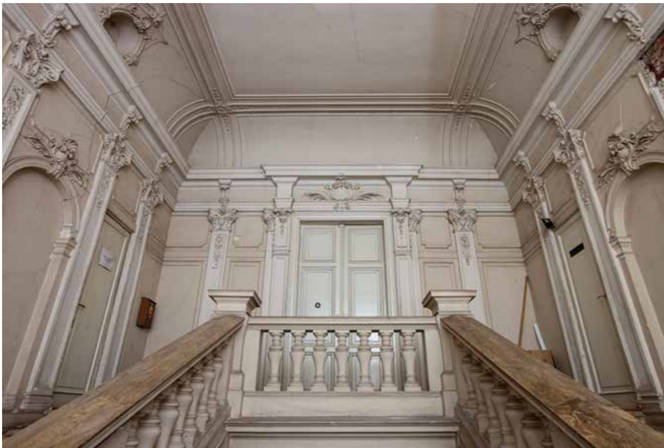
Stubište na prvom katu, ulaz u pročelne dvorane
