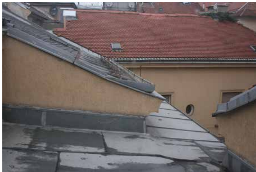
Središnji dio krovišta sa svjetlikom
