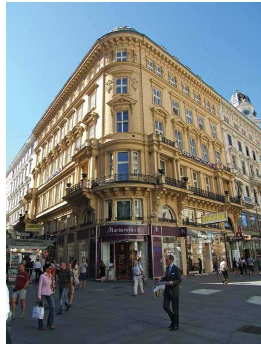
Najamna zgrada u Beču, Graben 7, Ludwig Tischler, 1875.
