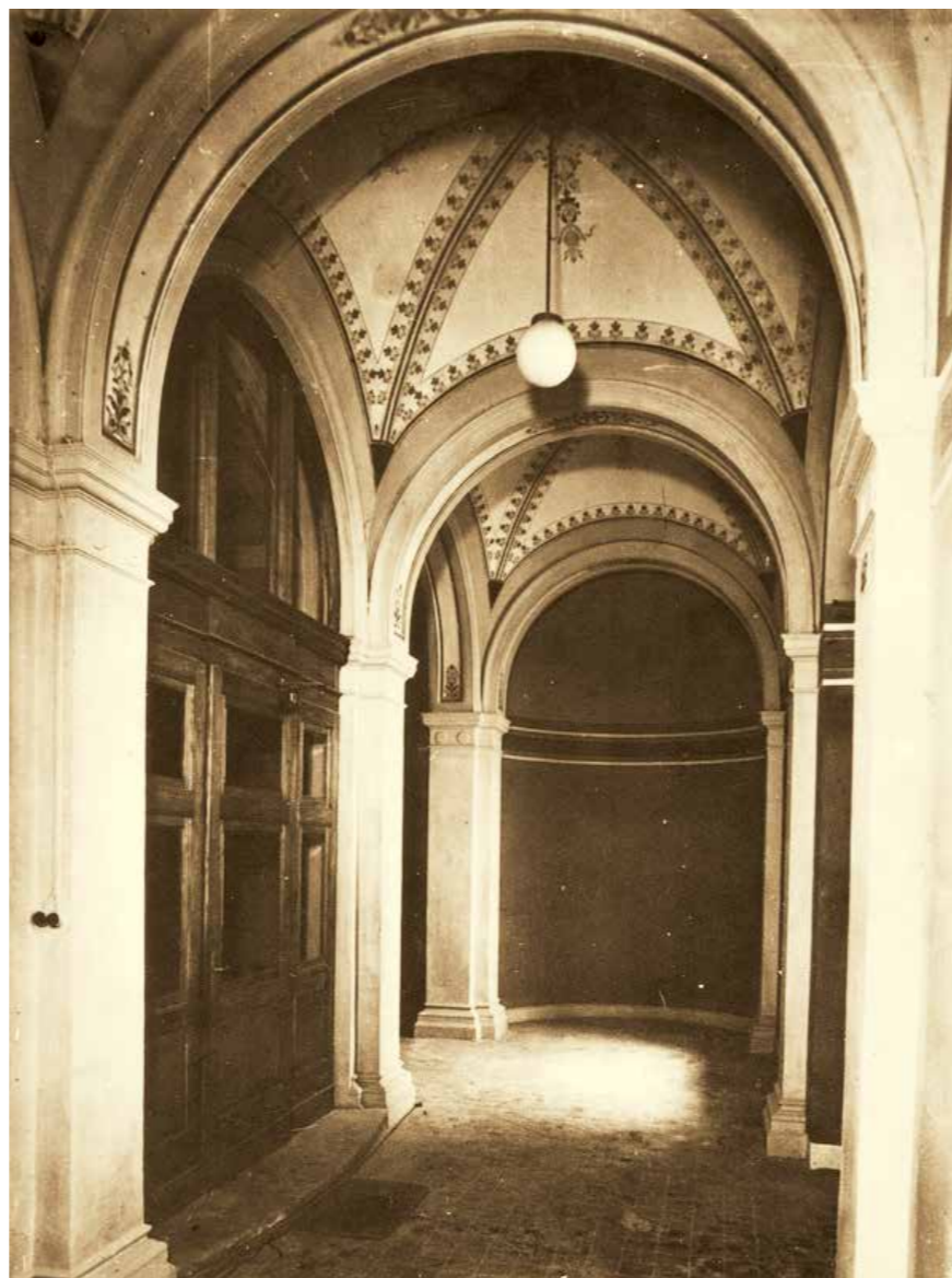
Ulazni prostor u prizemlju s vidljivim neorenesansnim oslikom, MGZ
