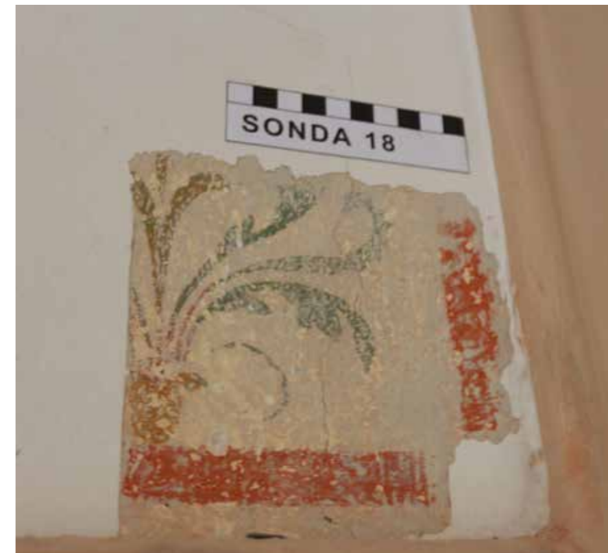
Sonda 18 na pojasnici u galeriji na drugom katu atrija (južni zid) s izvornim oslikom s motivom akanta
