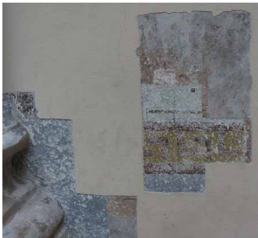
Sonda 23 u galeriji na drugom katu atrija (zapadni zid) s dvjema vidljivim fazama neorenesansnog oslika
