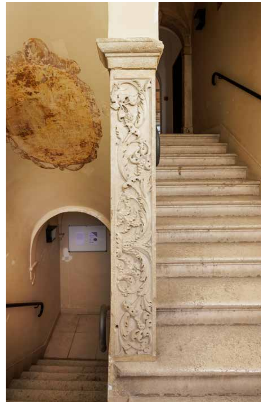
Renesansni pilastar sekundarno ugrađen na podestu između drugog i trećeg kata
