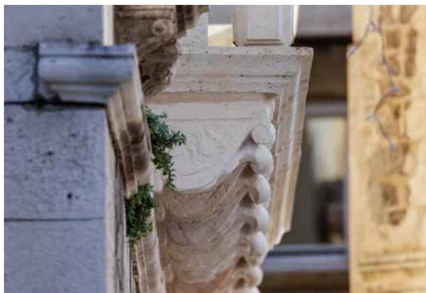
Konzole balkona na prvom katu
