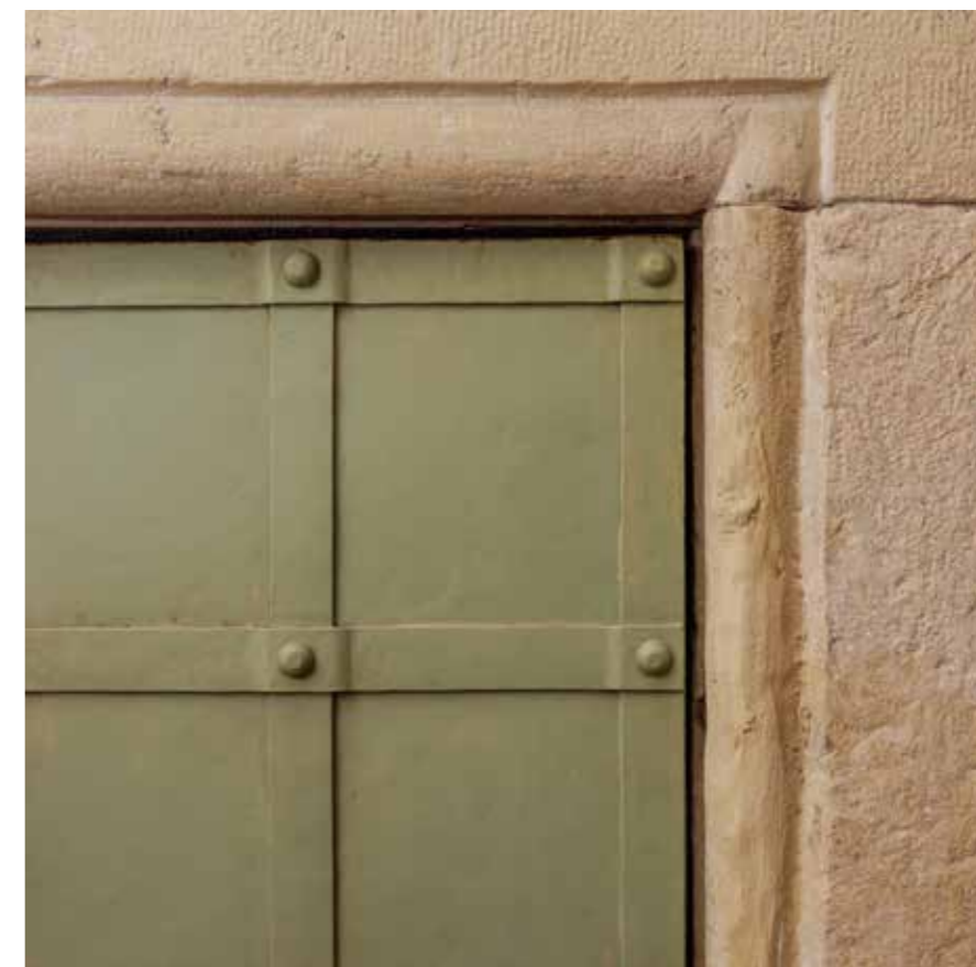
Portal spremišta ispod stuba, detalj
