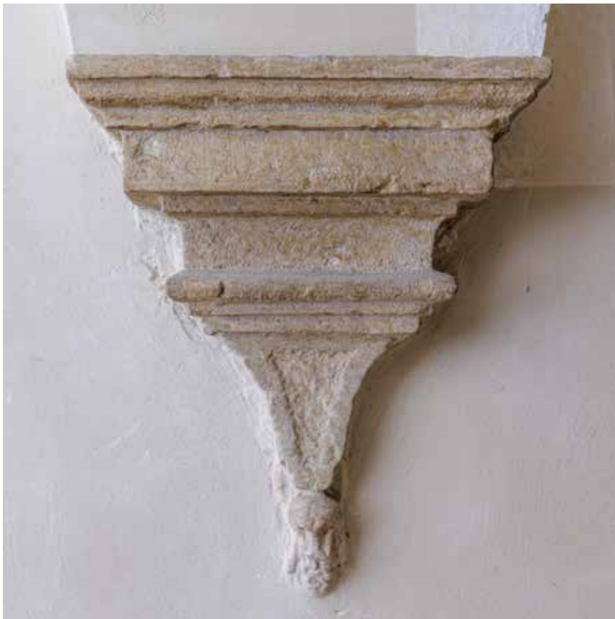
Konzola na podestu u prizemlju
