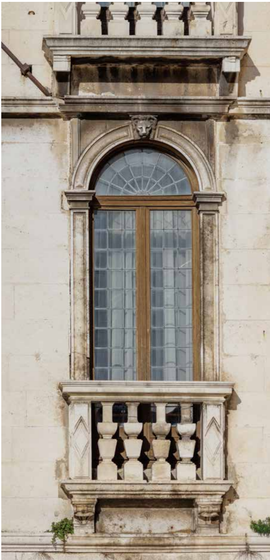
Južno pročelje, francuski prozor na prvom katu
