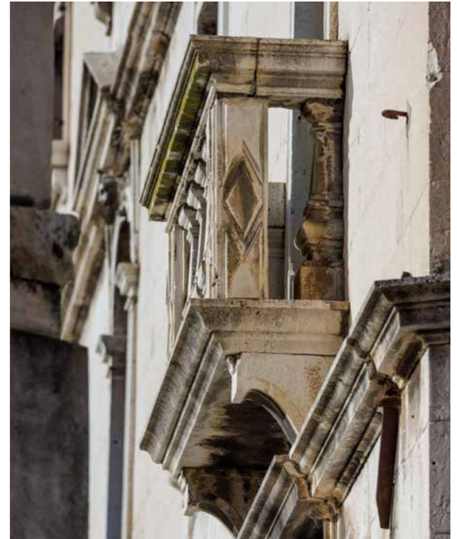
Ograda balkona na drugom katu
