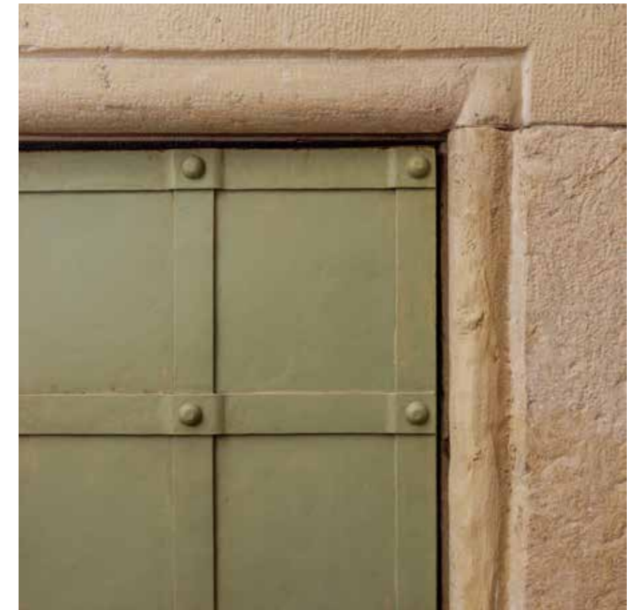
Portal spremišta ispod stuba, detalj
