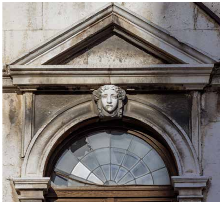
Balkonska vrata na prvom katu, detalj
