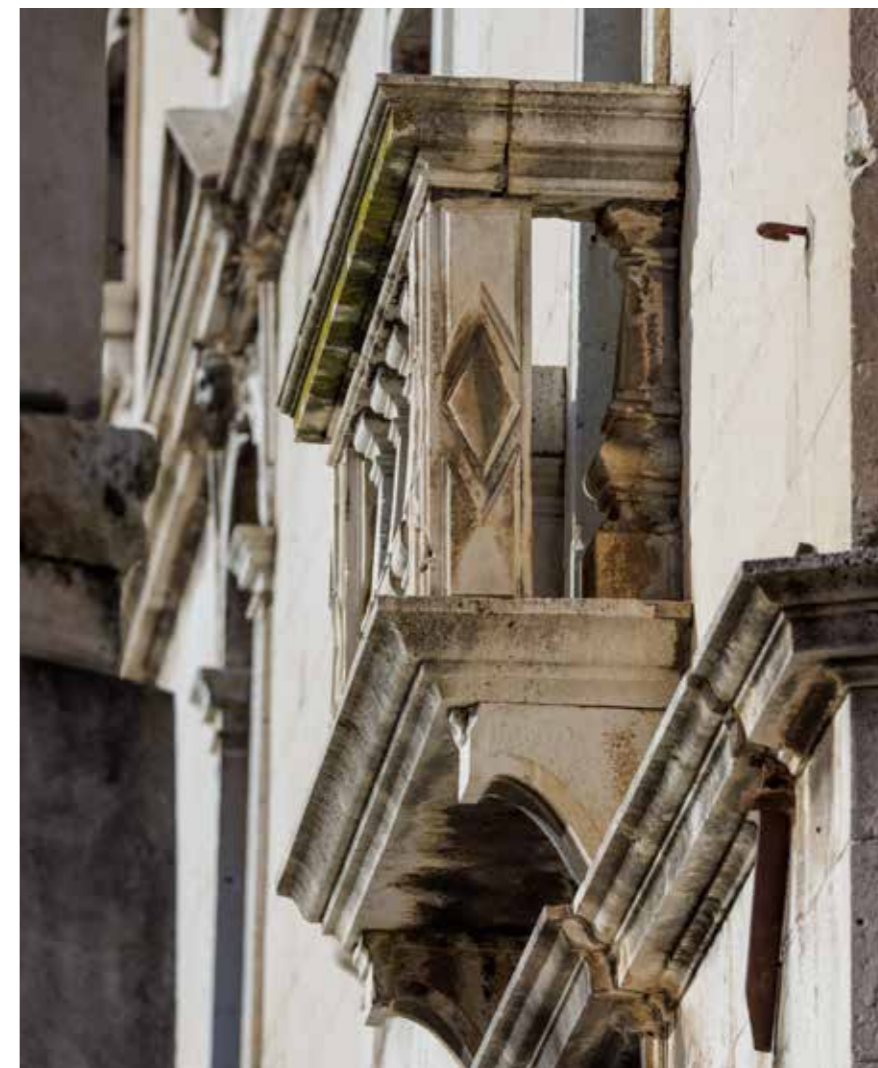
Ograda balkona na drugom katu
