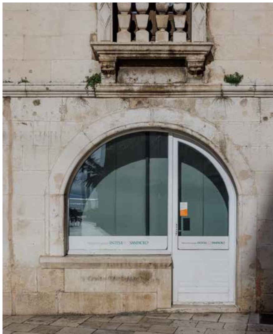
Južno pročelje, dućanski otvor u prizemlju
