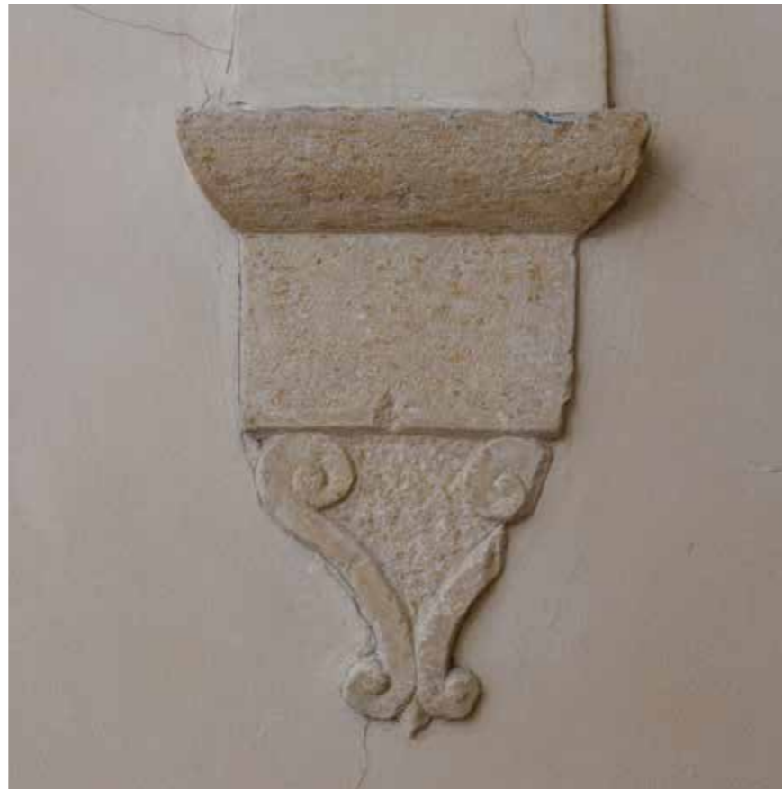
Konzola na podestu na prvom katu
