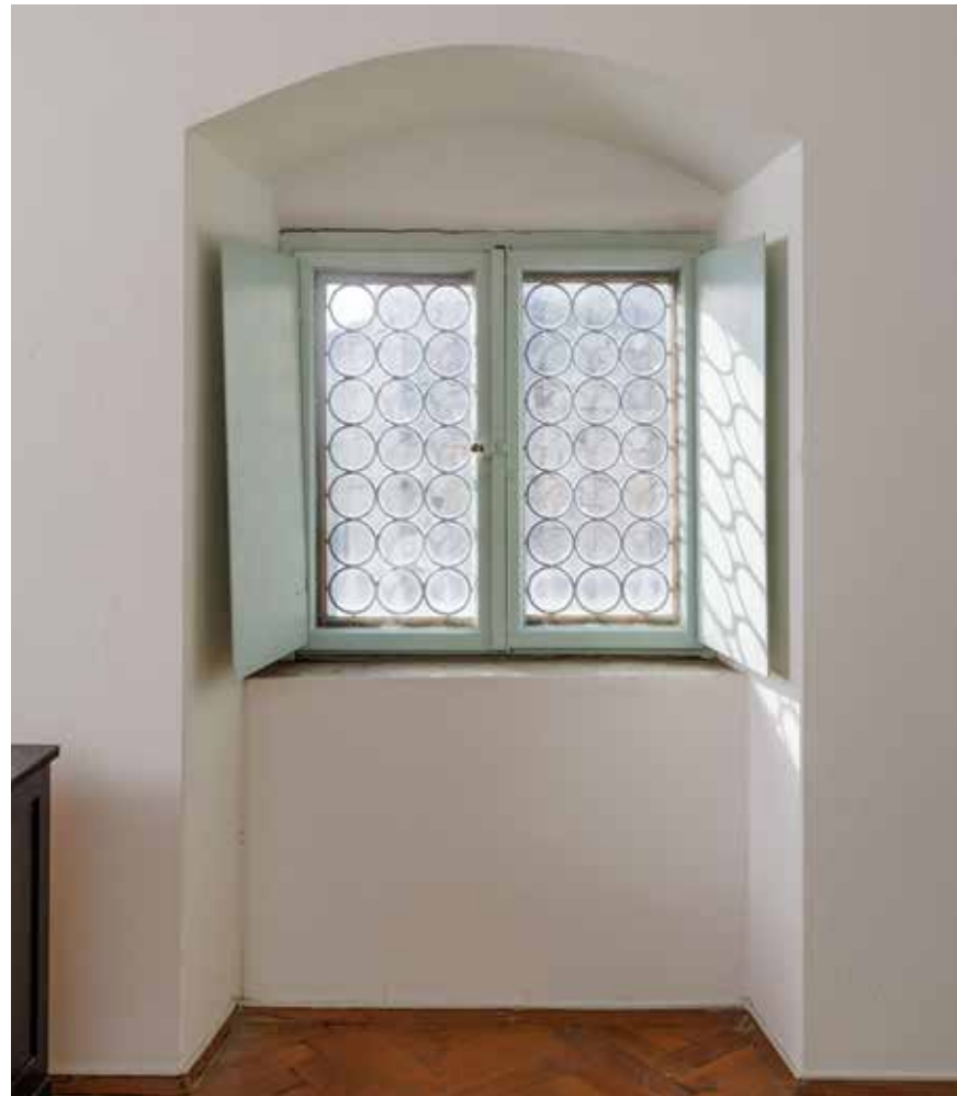
Prozor na trećem katu
