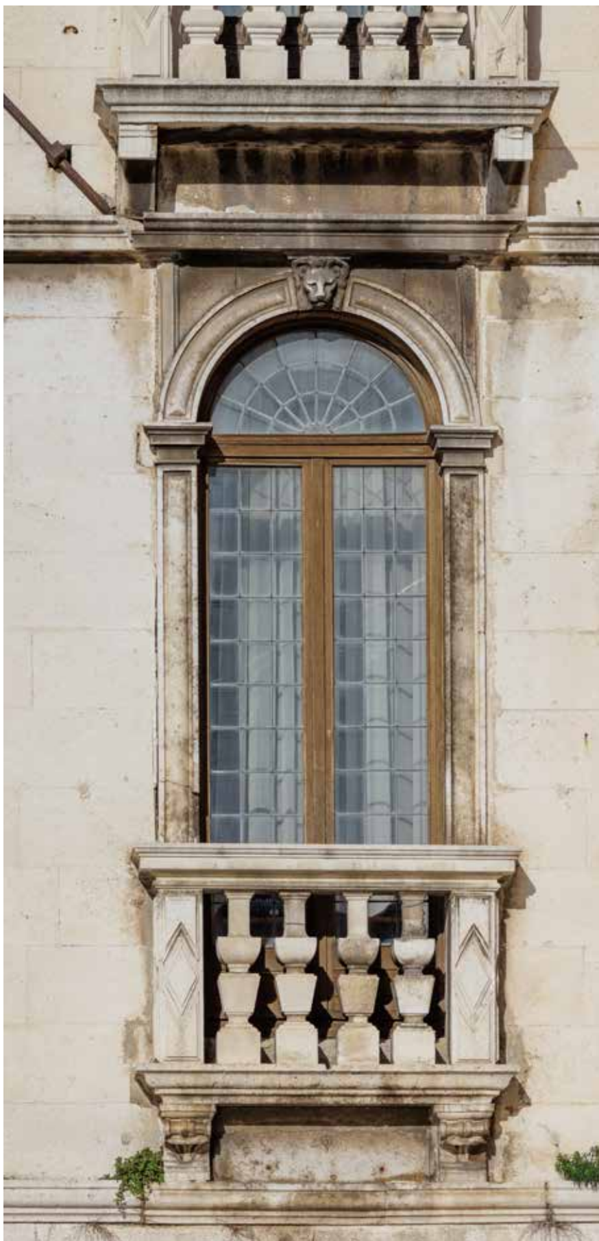
Južno pročelje, francuski prozor na prvom katu
