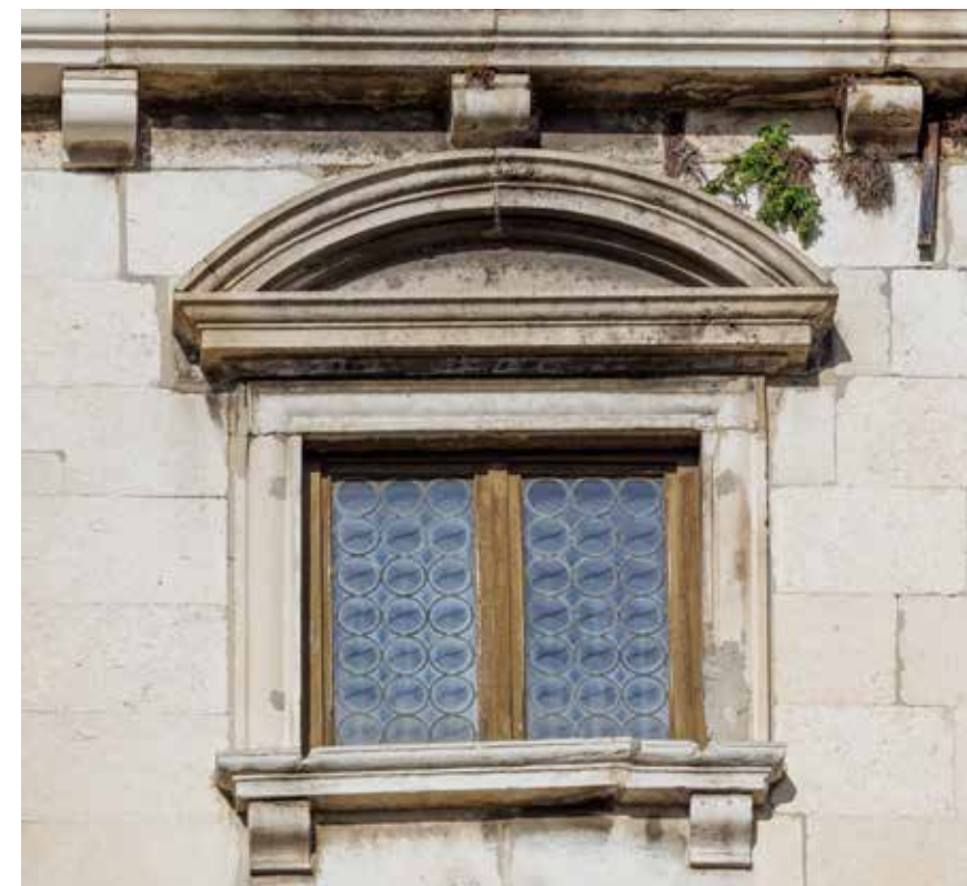
Prozor na trećem katu
