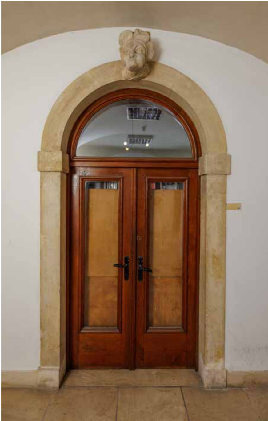
Portal na podestu stubišta u prizemlju
