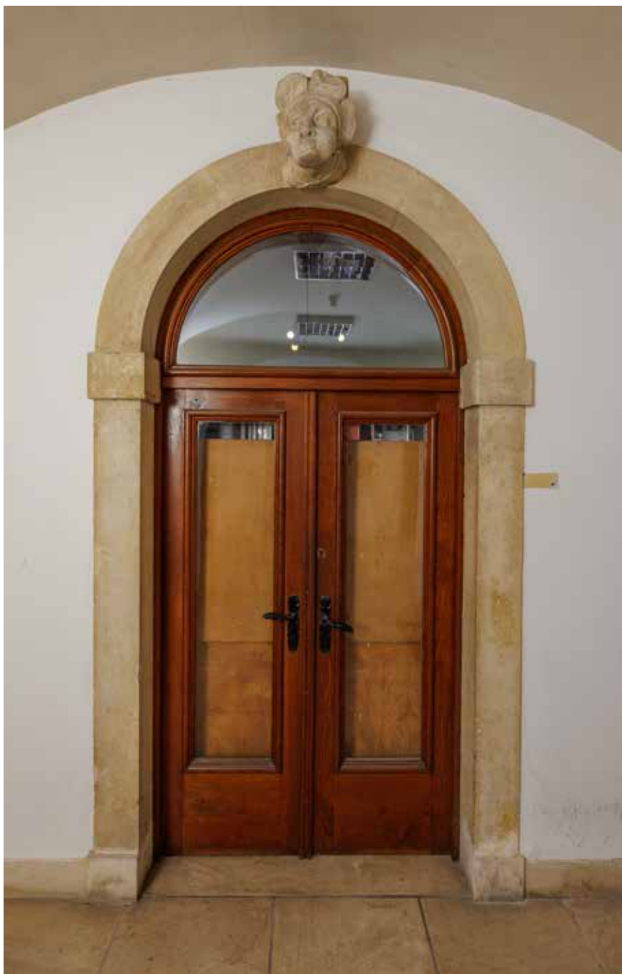
Portal na podestu stubišta u prizemlju
