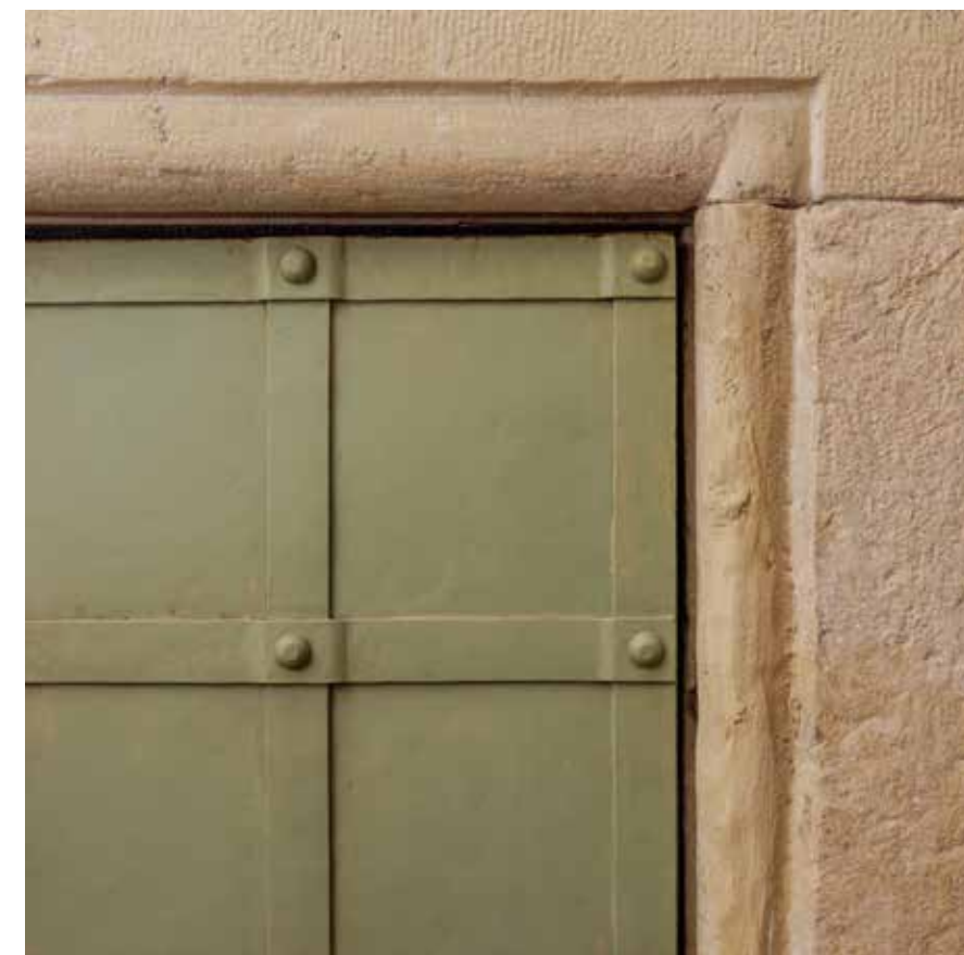
Portal spremišta ispod stuba, detalj
