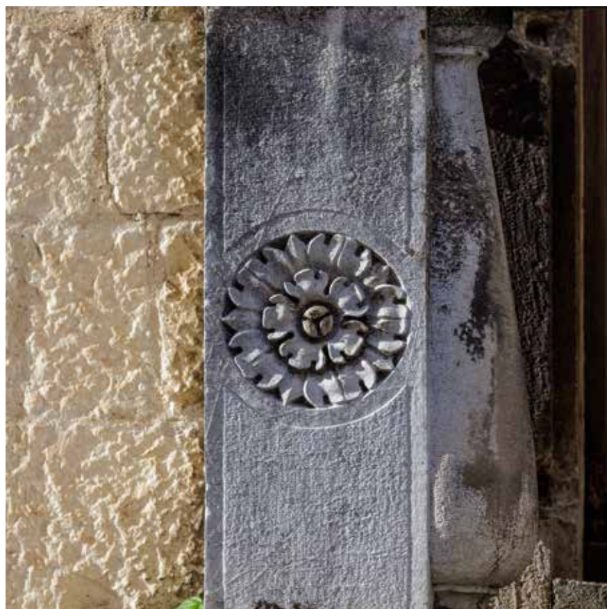
Balkon na prvom katu, detalj
