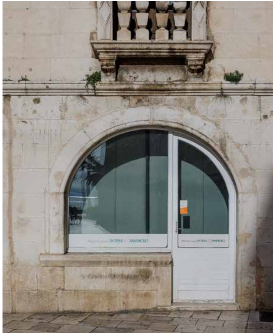
Južno pročelje, dućanski otvor u prizemlju
