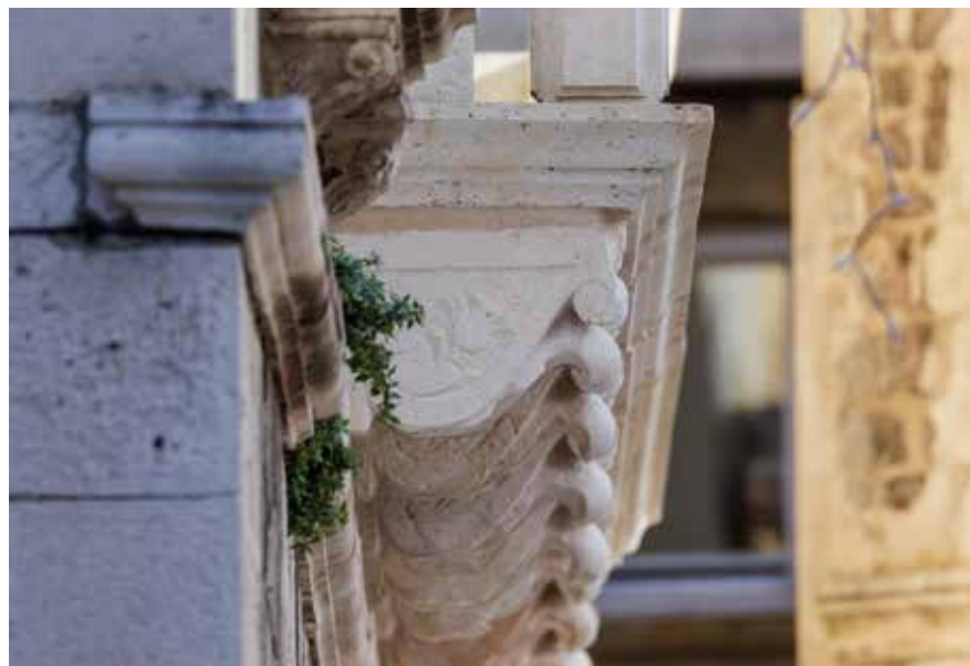
Konzole balkona na prvom katu
