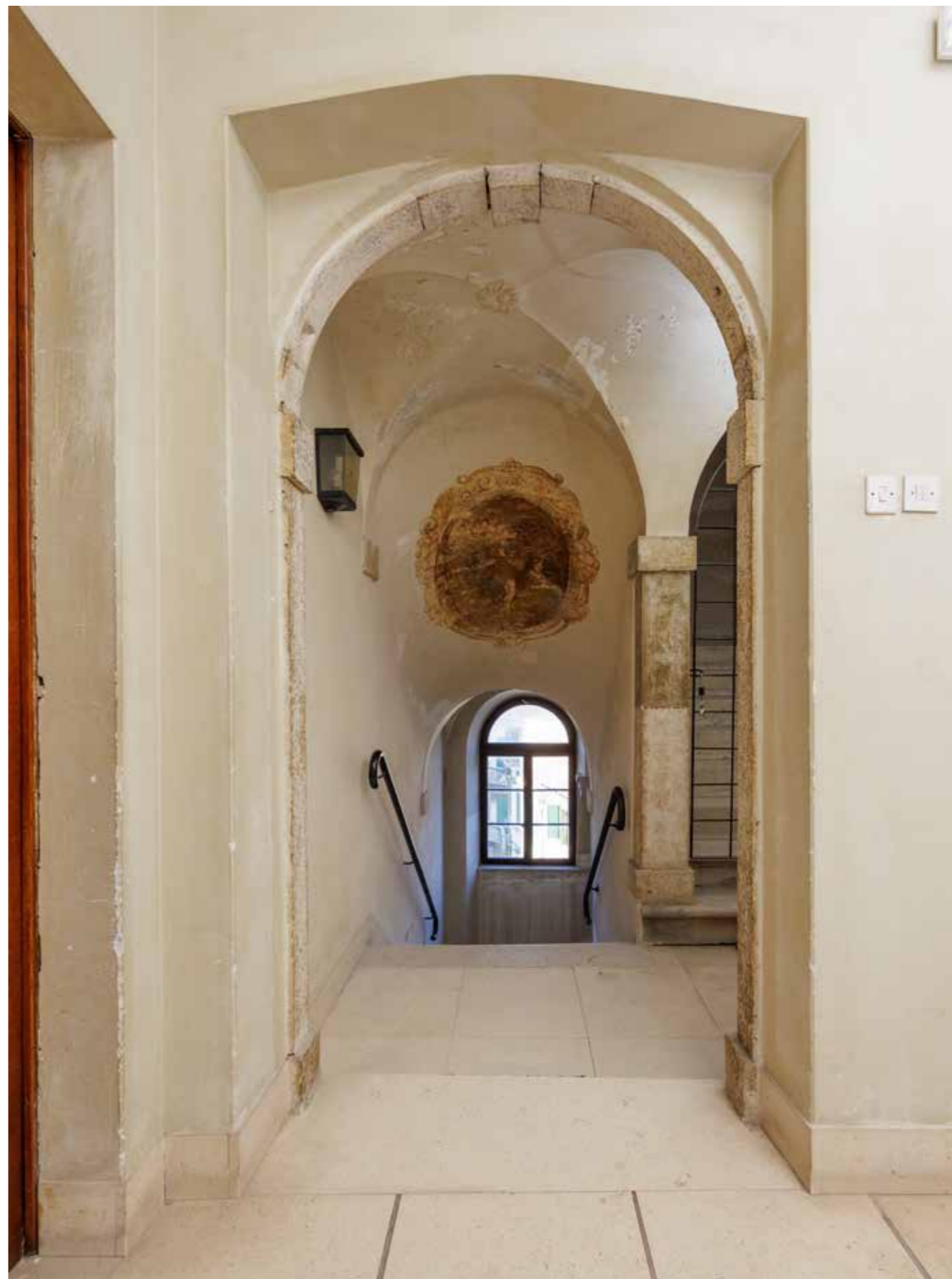
Pogled iz trećeg kata na stubište
