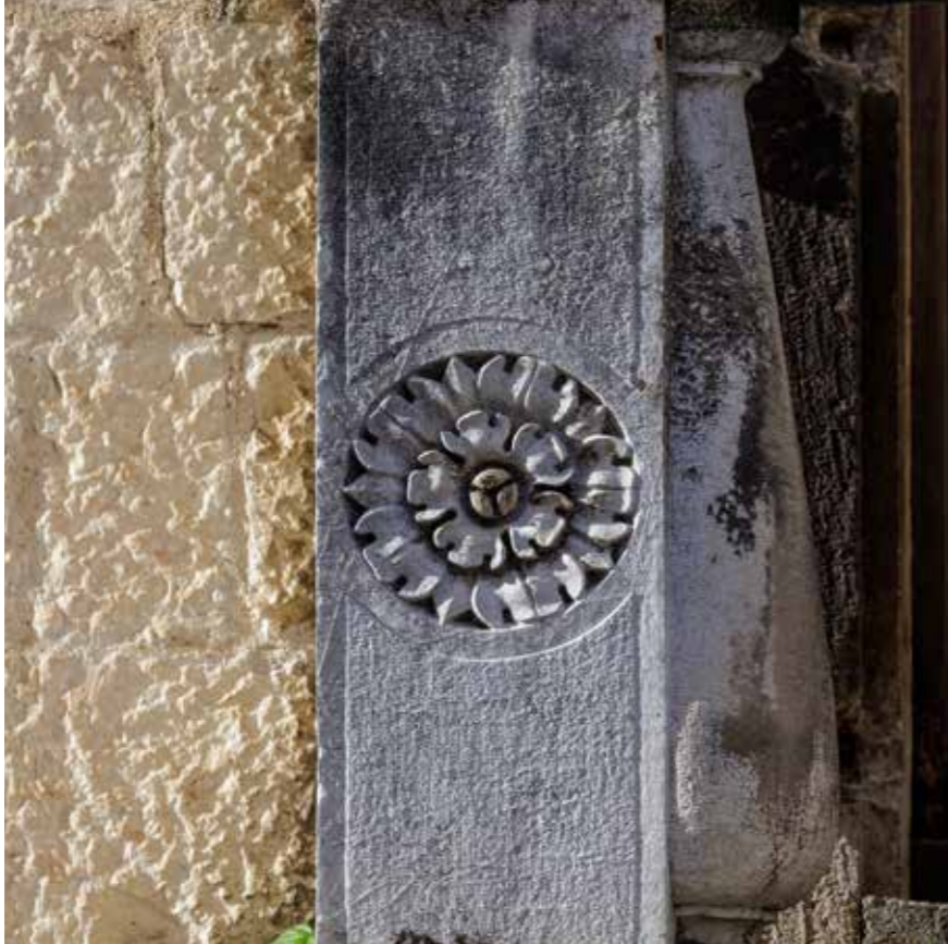
Balkon na prvom katu, detalj
