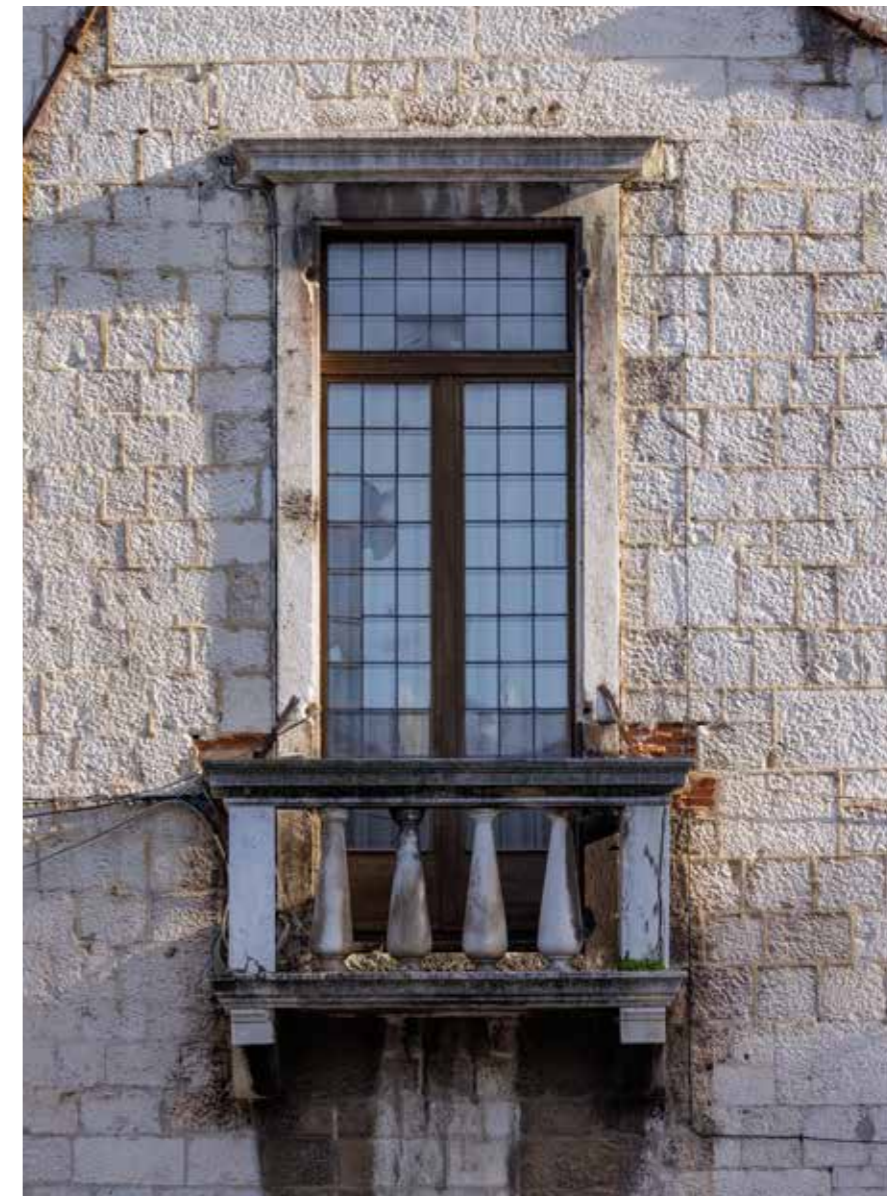
Balkon na prvom katu
