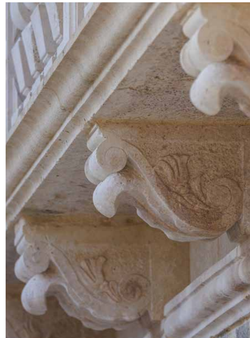
Konzole balkona na južnom pročelju nakon restauracije
