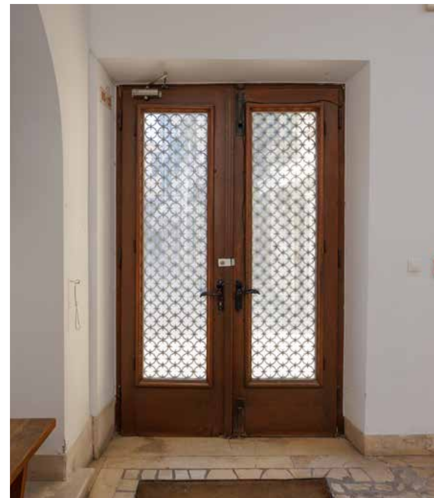
Vratnice glavnog portala palače
