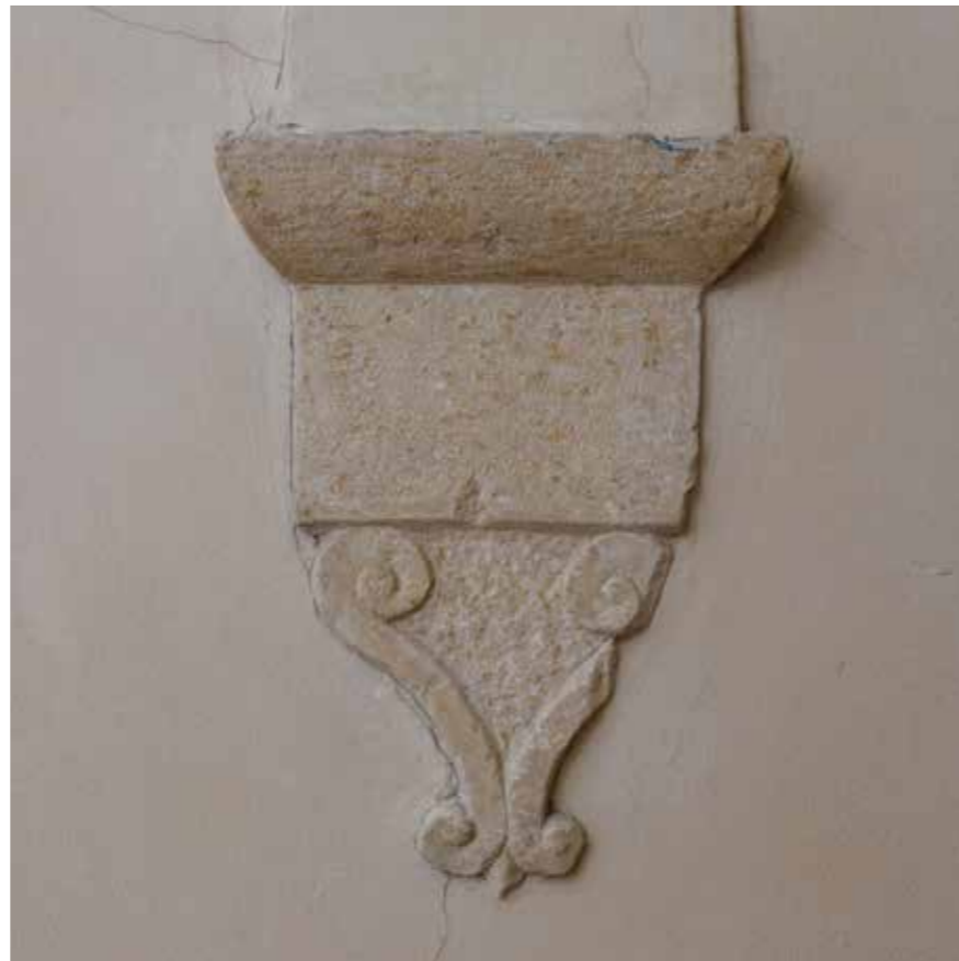
Konzola na podestu na prvom katu
