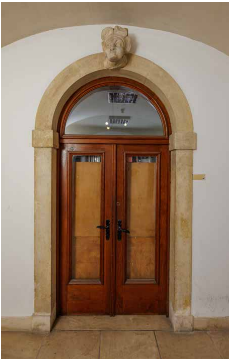
Portal na podestu stubišta u prizemlju
