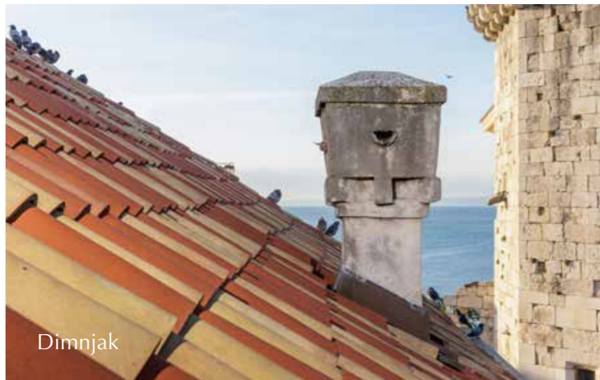
Krovište i terasa iznad nekadašnjeg atrija
