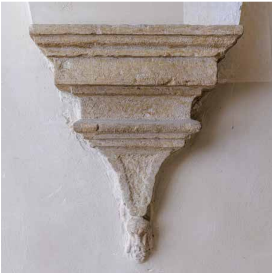
Konzola na podestu u prizemlju
