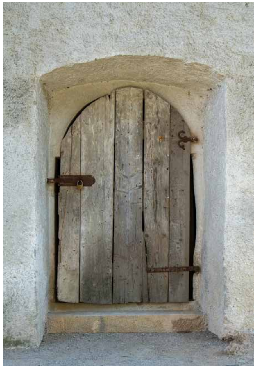
Ulazna vrata Žitnice na južnom pročelju
