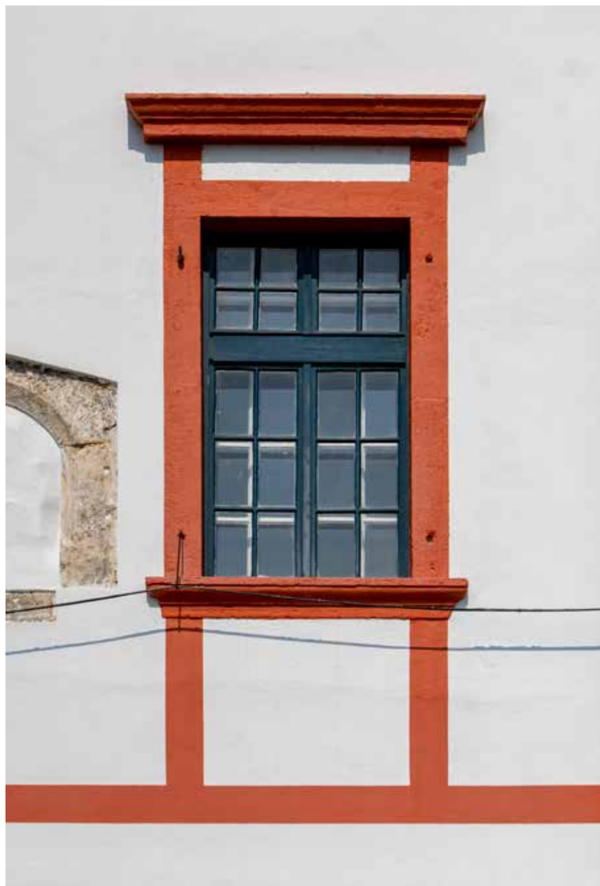
Prozor istočnog pročelja
