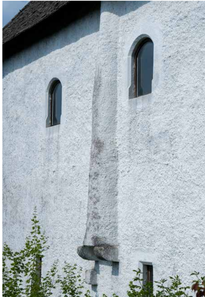
Dimnjak na zapadnom pročelju Žitnice
