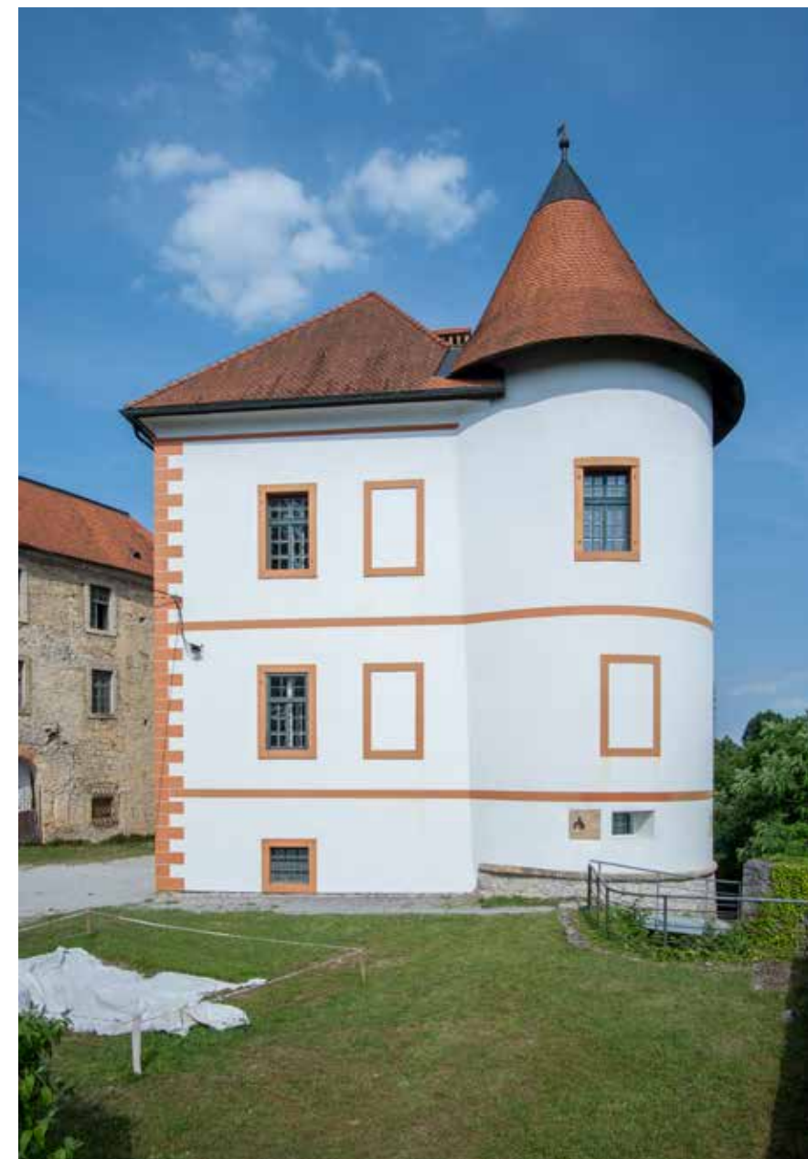
Zapadno pročelje južnog krila
