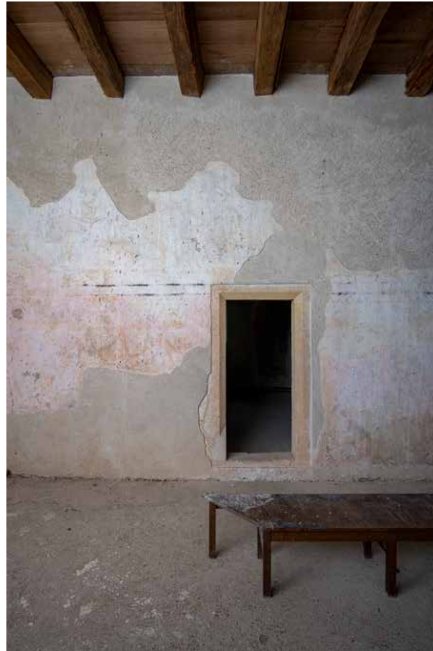
Razdjelni zid između prostorija prizemlja
