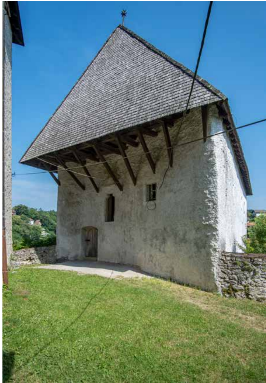
Glavno, južno pročelje Žitnice
