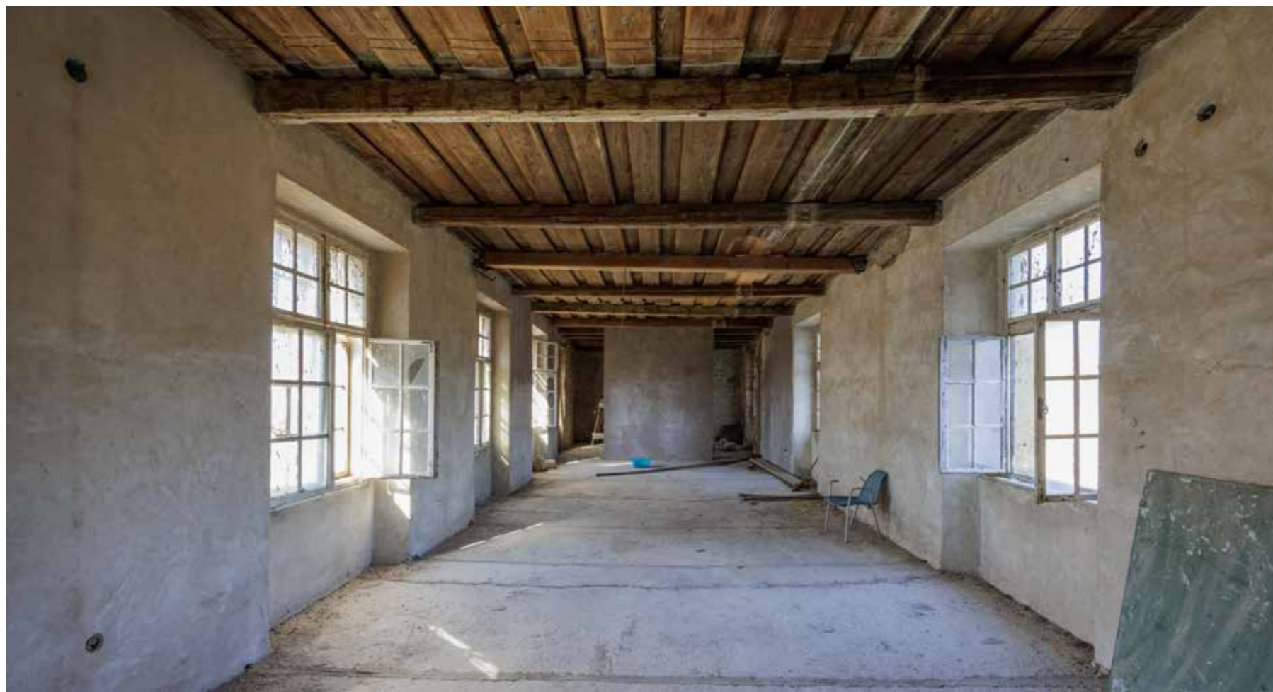
Unutrašnjost drugog kata u zapadnom dijelu sjevernog krila
