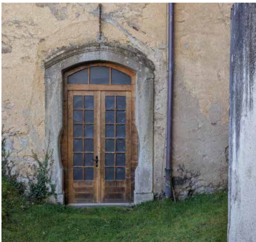
Arkade prvog kata sjevernog krila Zapadna vrata prizemne prostorije
