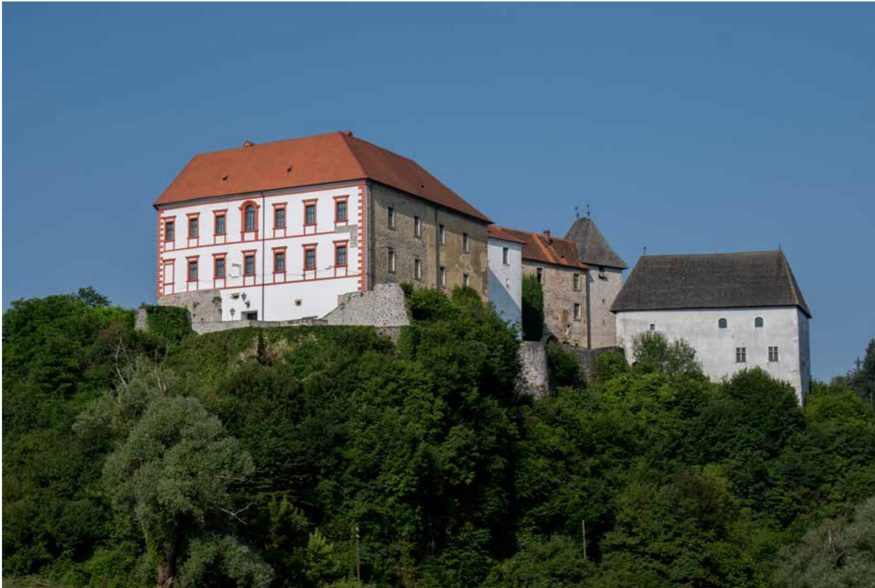
Pogled na istočno rezidencijalno krilo
