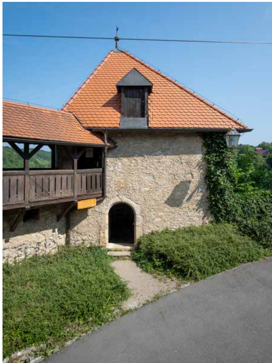
Južno pročelje oružarnice
