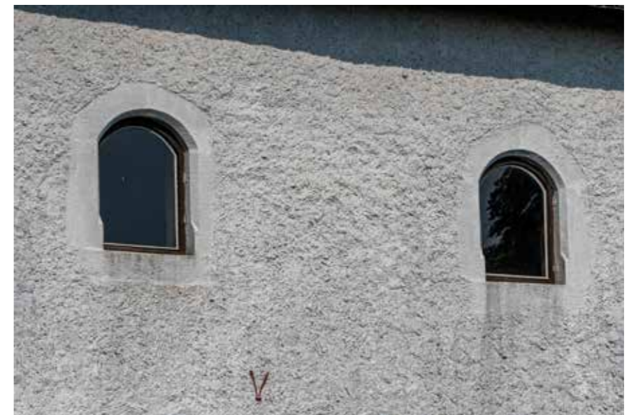
Gotički tzv. češki prozori istočnog pročelja Gotički prozori prvog kata istočnog pročelja
