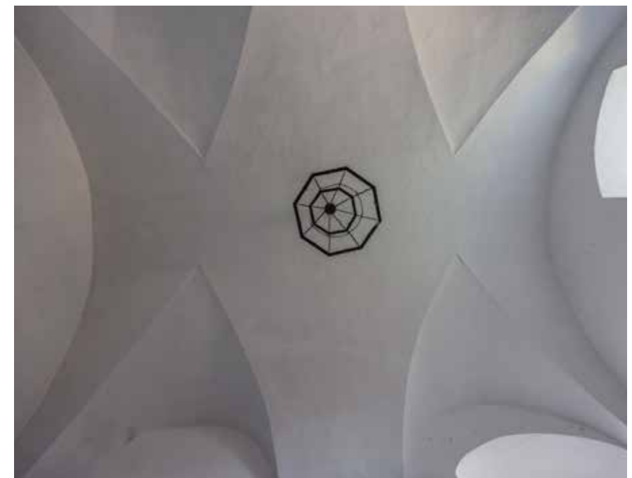
Prizemlje istočnog dijela sjevernog krila
