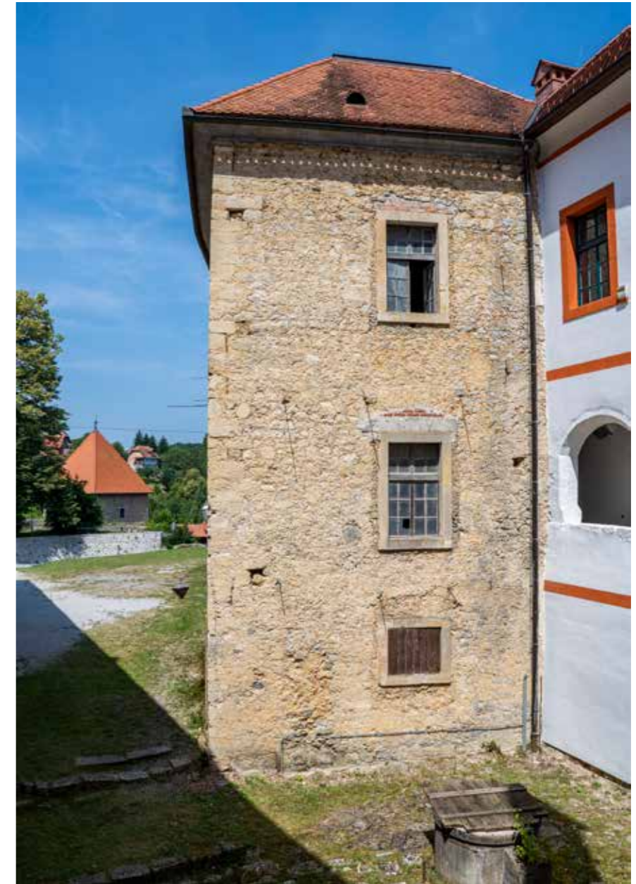
Istočno pročelje stubišta sjevernog krila
