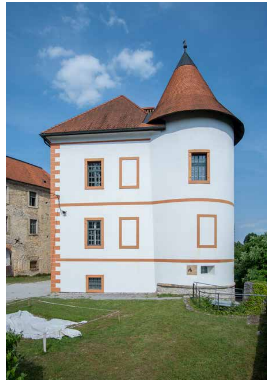
Zapadno pročelje južnog krila
