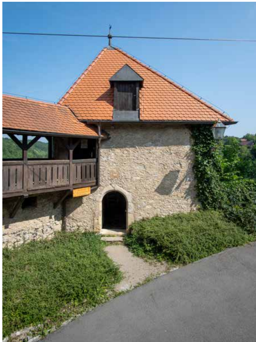
Južno pročelje oružarnice
