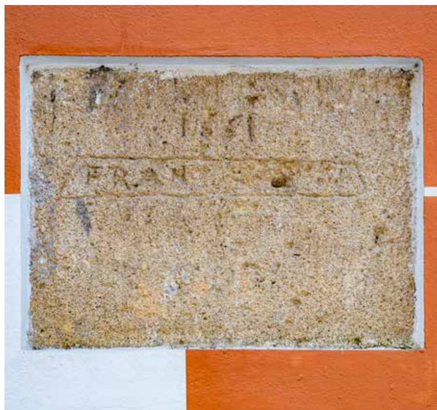
Sjeverno pročelje južnog krila
