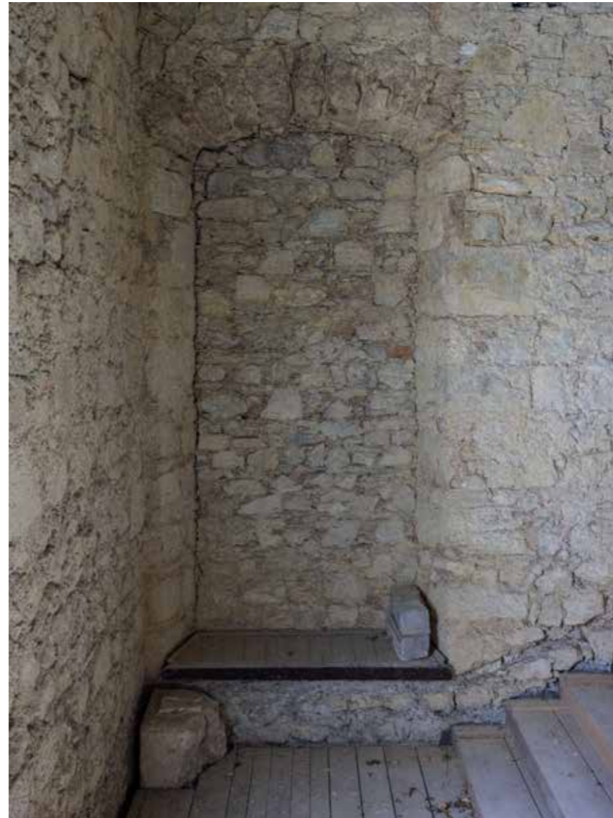
Zazidana ništa prolaza u južnom zidu stubišta
