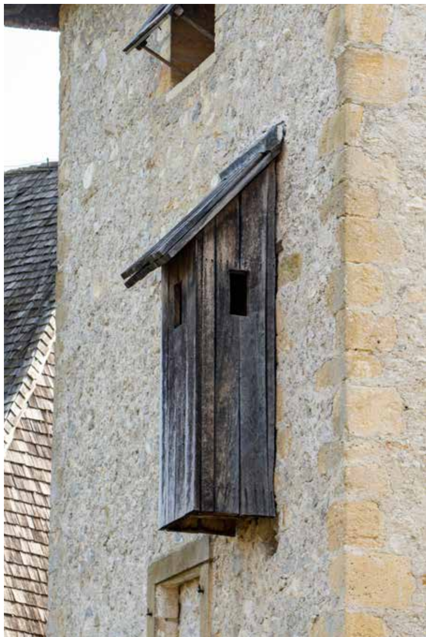
Zahod na zapadnom pročelju
