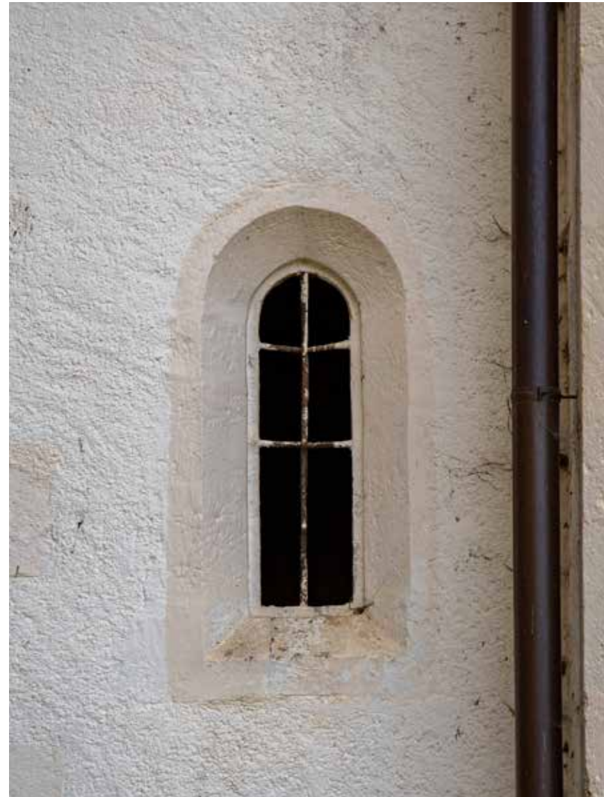
Prozor na sjevernom zidu
