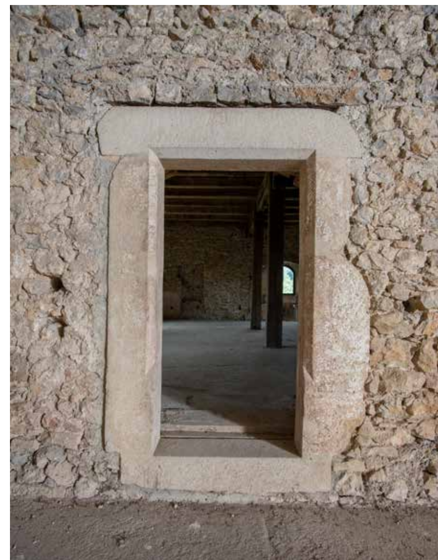
Prvi kat predvorja, pogled prema sjeveru
