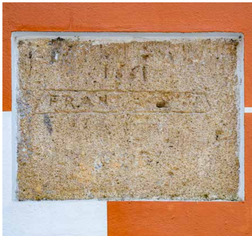
Sjeverno pročelje južnog krila
