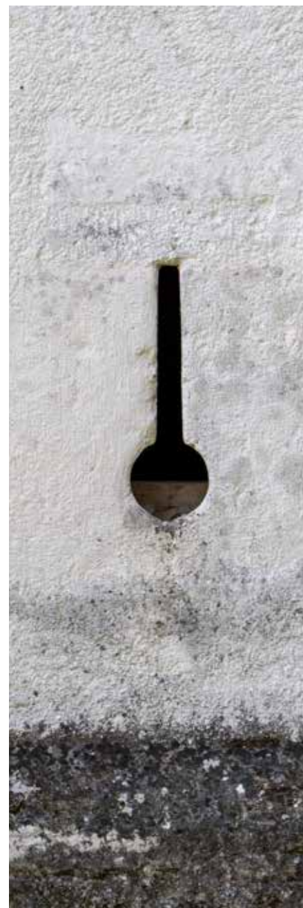
Puškarnica u obliku ključanice na zapadnom pročelju
