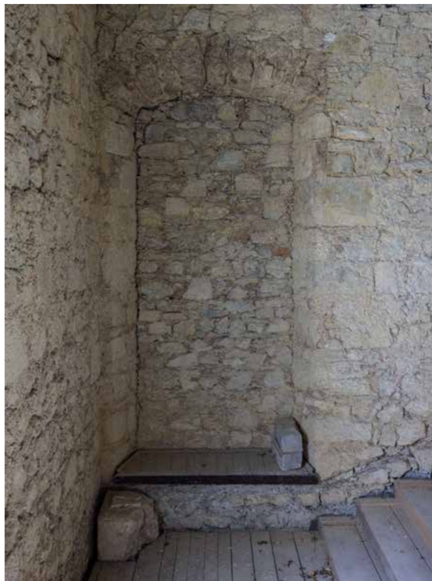
Zazidana ništa prolaza u južnom zidu stubišta
