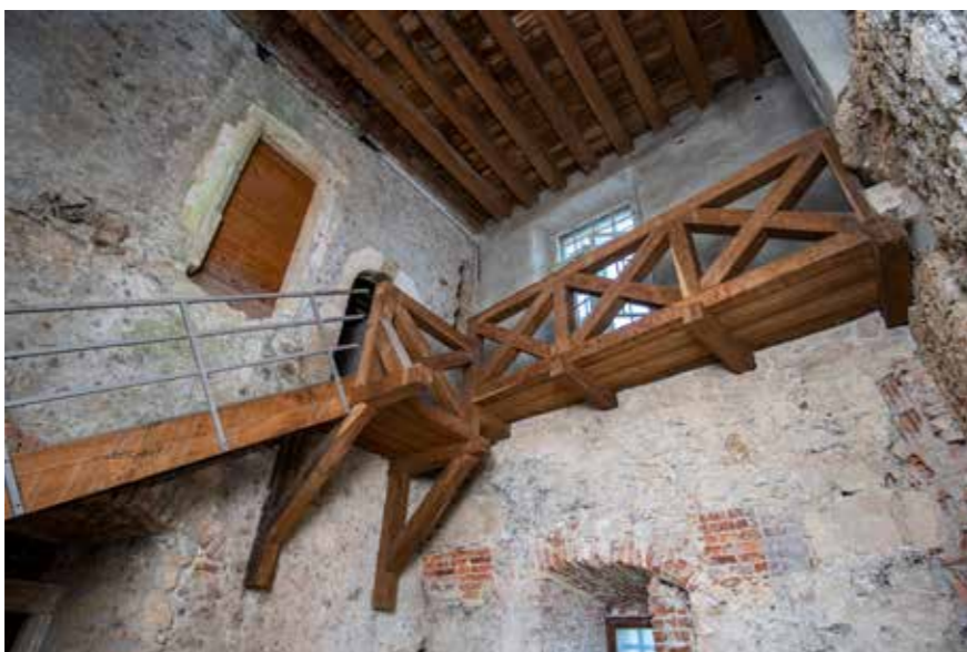
Dvokrako željezo-drveno stubište uz istočni zid branič-kule Pogled na ulazno, istočno pročelje
