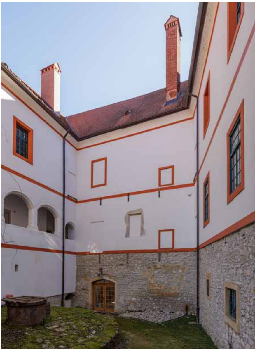
Zapadno pročelje istočnog krila
