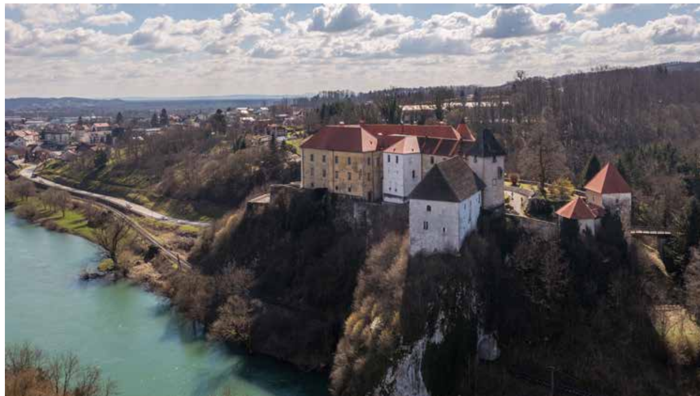
Pogled na Žitnicu sa sjeverozapada
