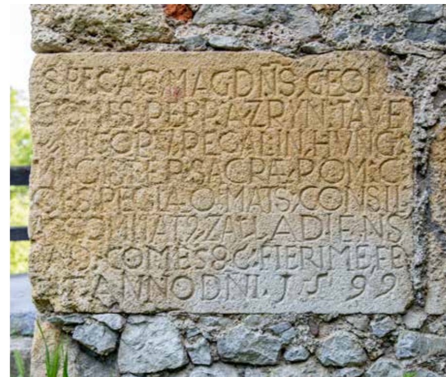
Natpis na bridu južnog pročelja ulazne kule s 1599. godinom
