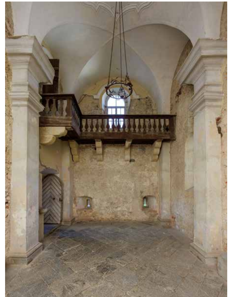
Pogled na zapadni zid
