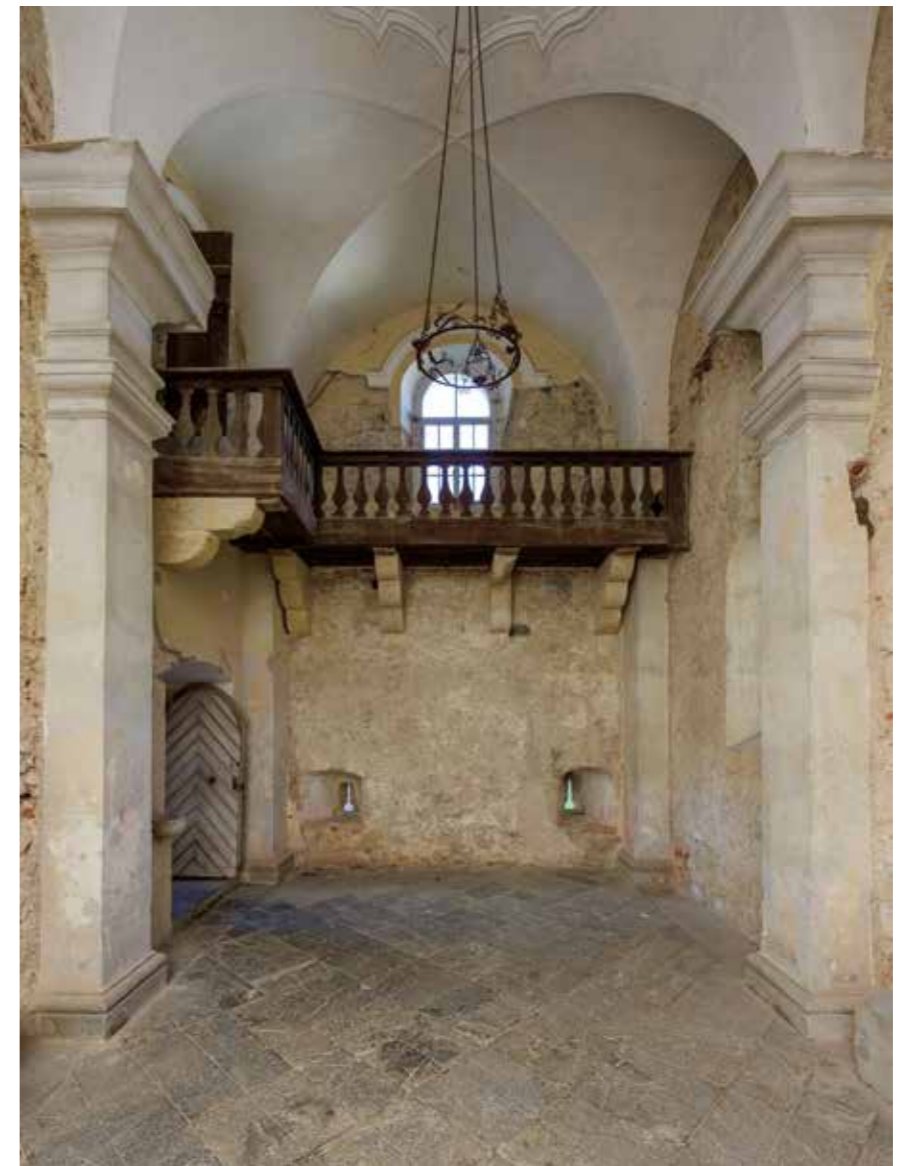
Pogled na zapadni zid
