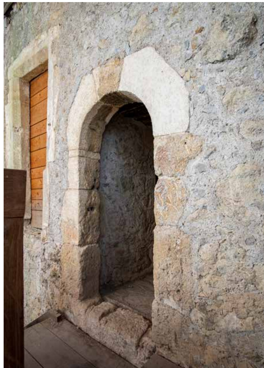
Romanički portal izvornog ulaza u branič-kulu desno i lijevo naknadni gotički ulaz na višoj koti
