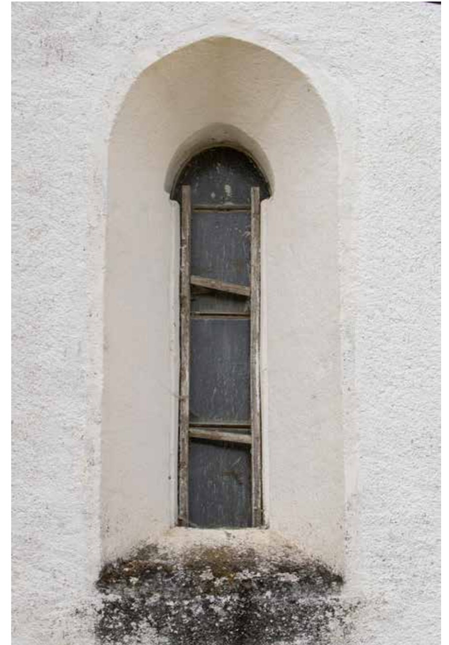
Gotički prozor na sjevernom pročelju
