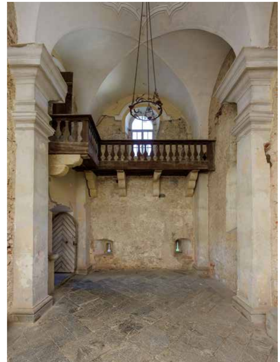
Pogled na zapadni zid
