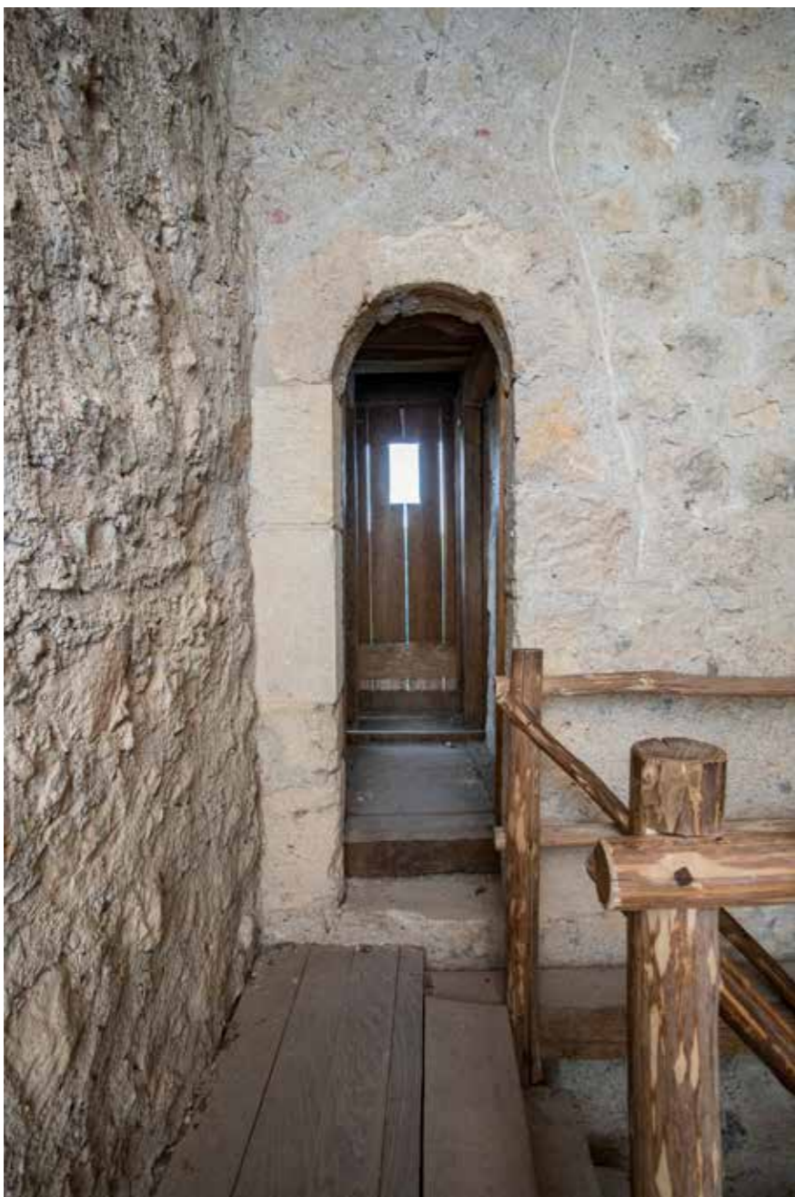
Otvor zahoda u zapadnom zidu
