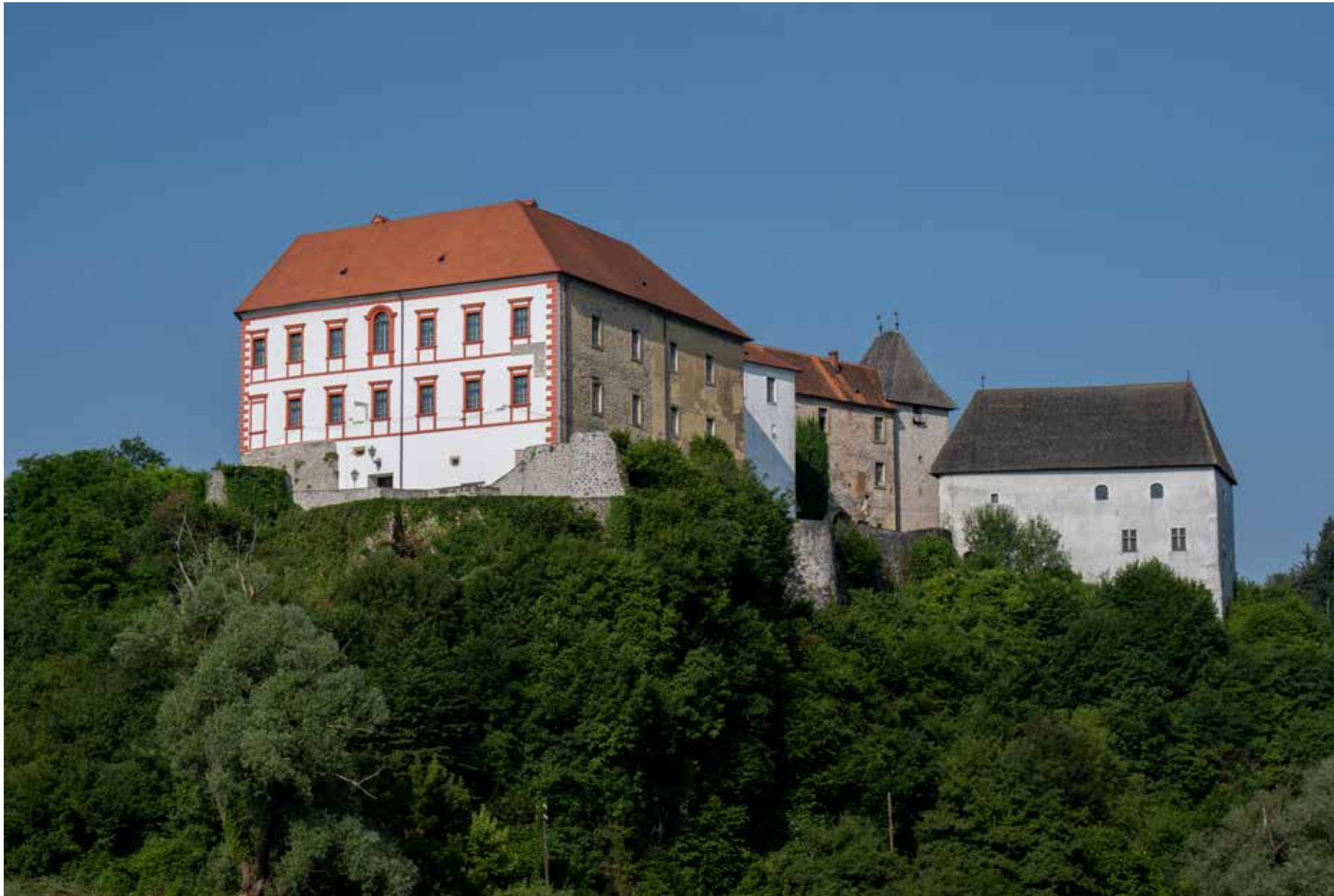
Pogled na istočno rezidencijalno krilo
