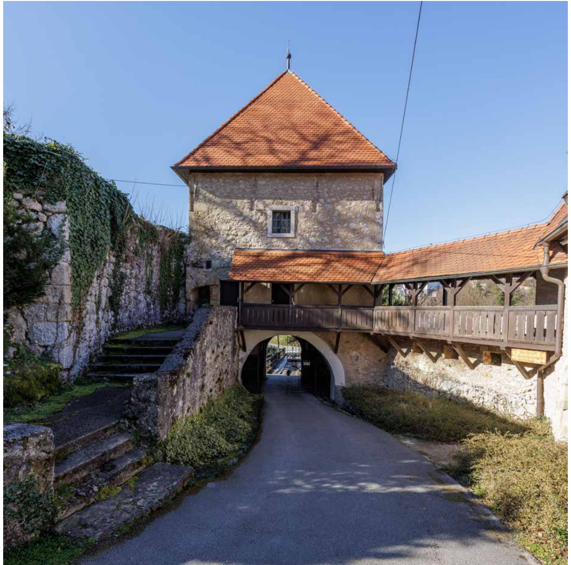
Istočno pročelje ulazne kule i ganjak koji je povezuje s oružarnicom
