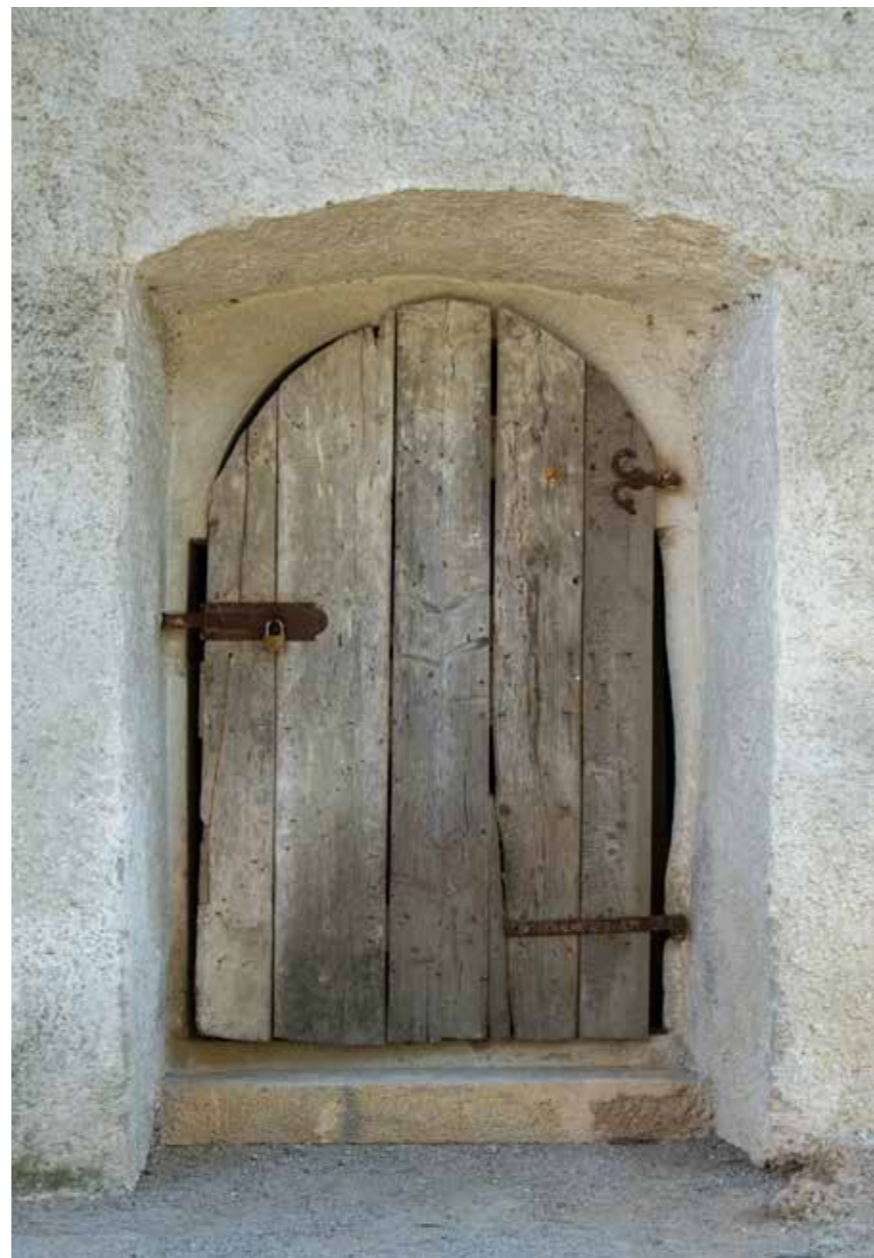
Ulazna vrata Žitnice na južnom pročelju
