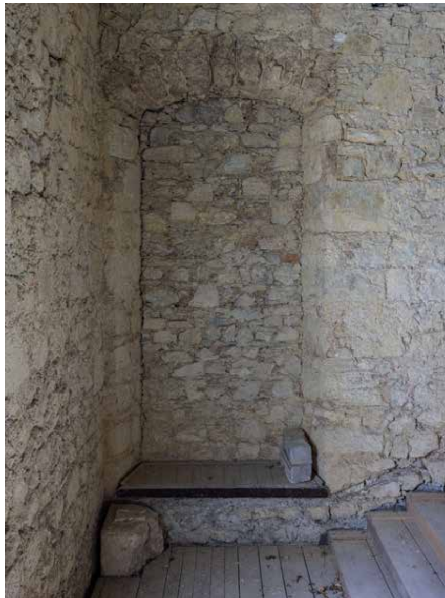
Zazidana ništa prolaza u južnom zidu stubišta
