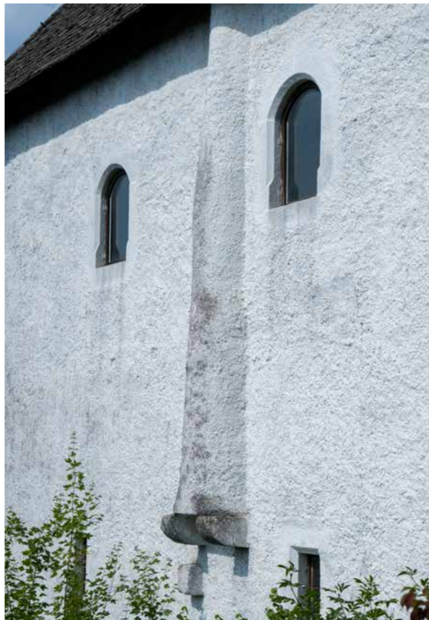
Dimnjak na zapadnom pročelju Žitnice
