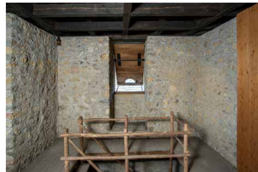
Stubište u unutrašnjosti branič-kule Prozor na zadnjem katu
