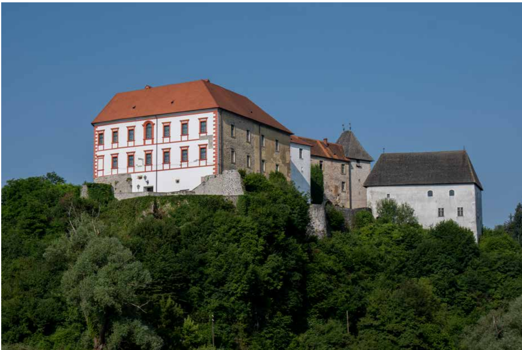
Pogled na istočno rezidencijalno krilo
