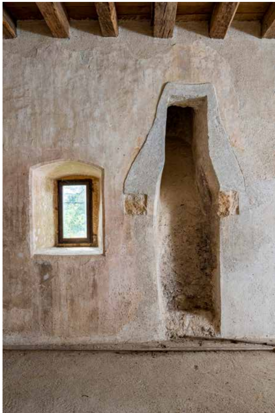
Prozor i ostatak niše kamina u zapadnom zidu zapadne prostorije prizemlja Žitnice
