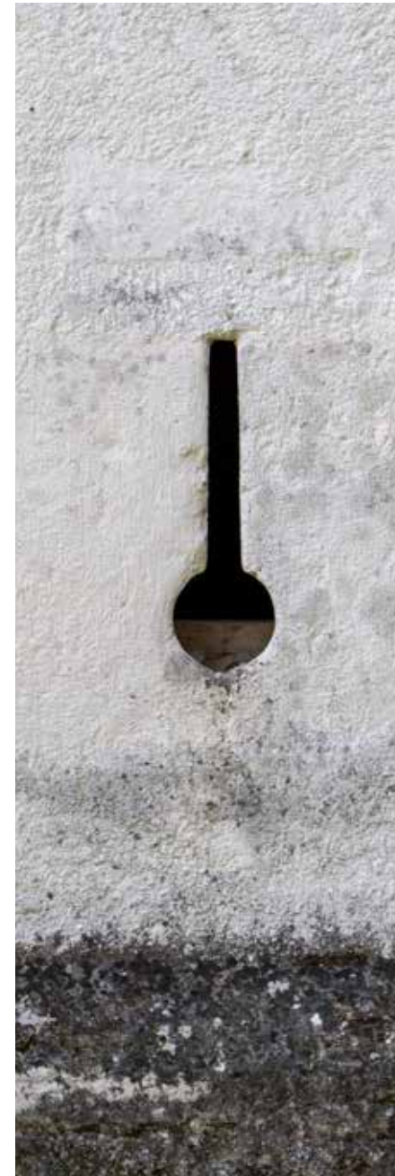
Puškarnica u obliku ključanice na zapadnom pročelju
