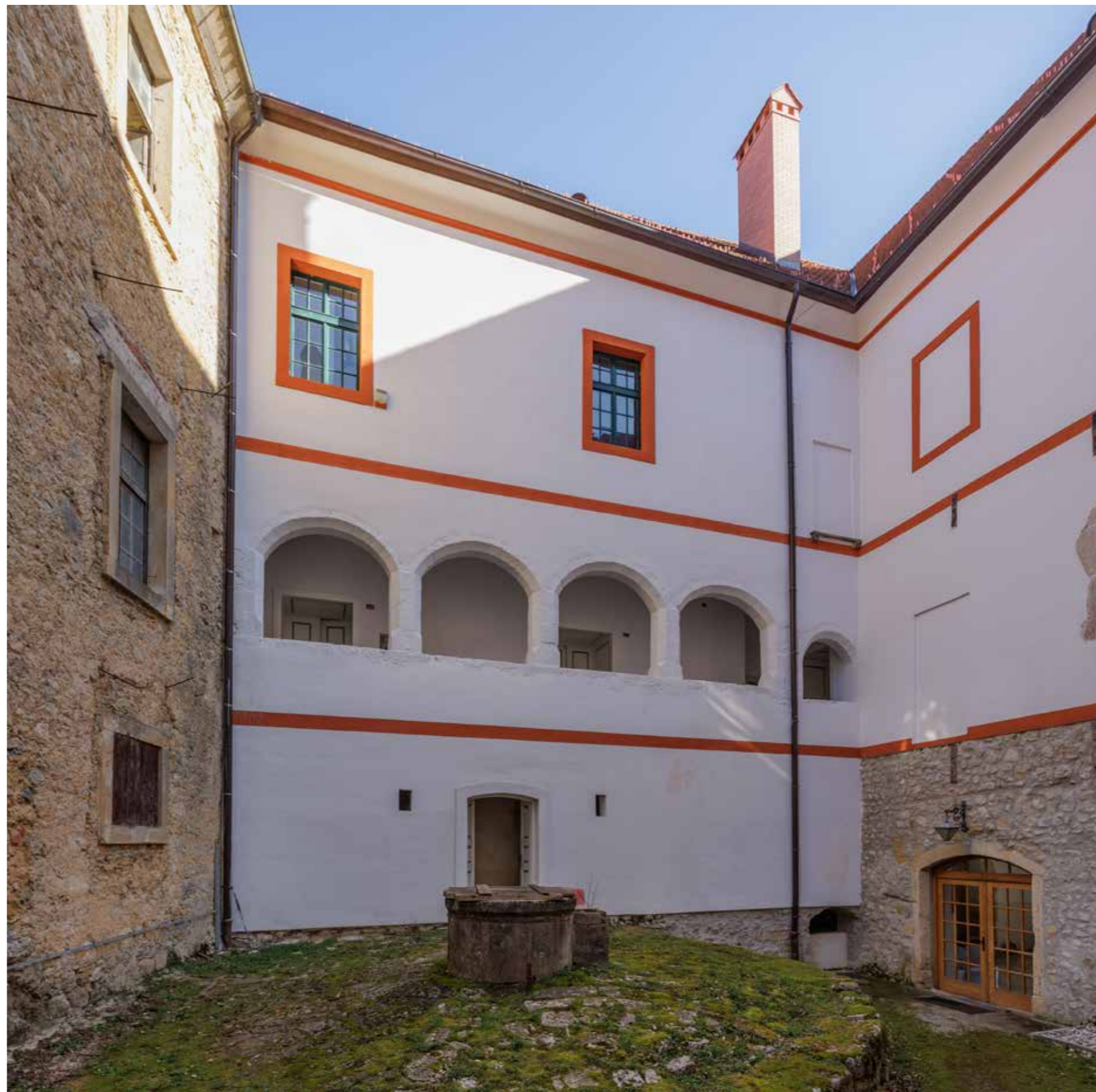
Istočni dio južnog pročelja sjevernog krila
