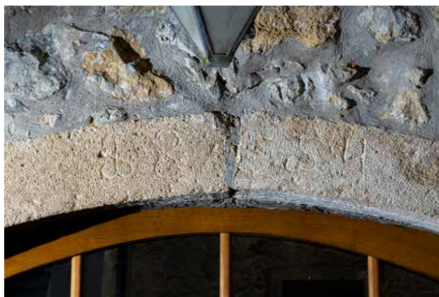
Prizemlje zapadnog pročelja
