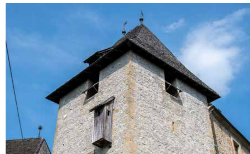
Pogled na sjeverno pročelje Dio zapadnog pročelja
