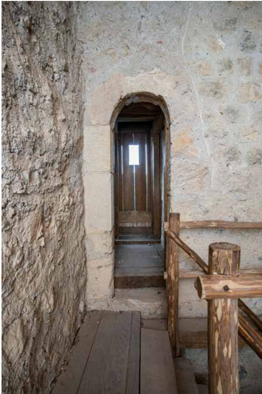
Otvor zahoda u zapadnom zidu
