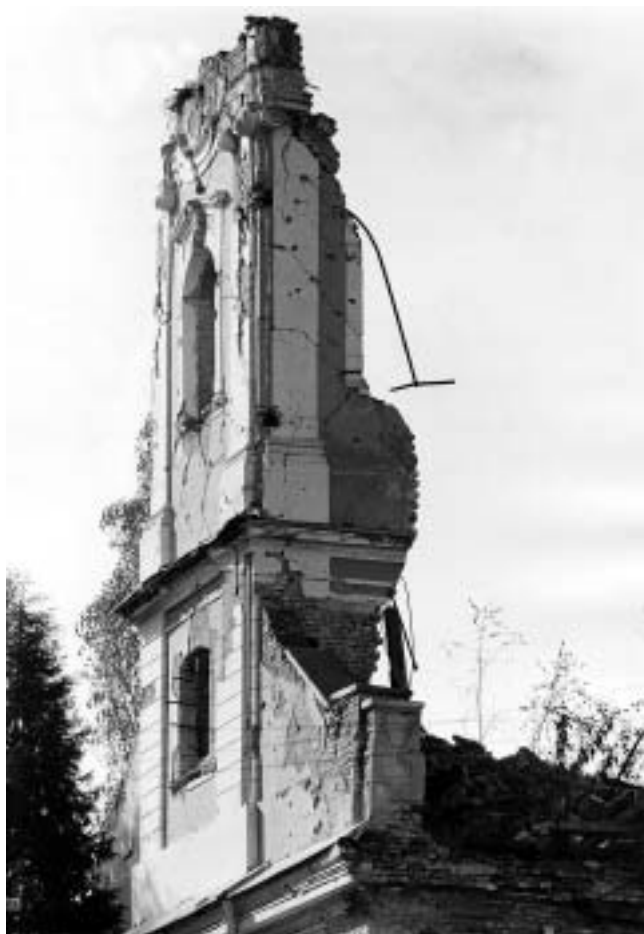
Jasenovac, župna crkva sv. Nikole — ruševni zvonik nakon oslobođenja. (Foto: Milan Drmić, Institut za povijest umjetnosti)
