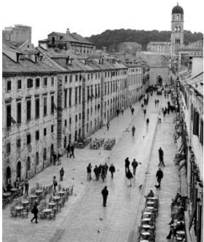
Placa, unificirana pročelja kuća, foto: Katarina Horvat-Levaj
