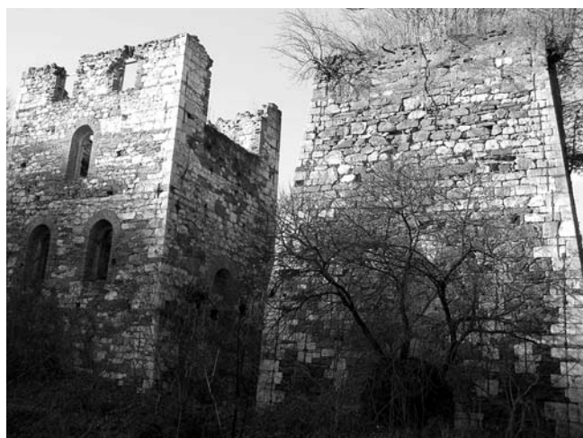
20. Bešlinec kraj Gvozdanskog, pogled na visoku peč (desno) i zgradu za obradu lijeva (lijevo)
