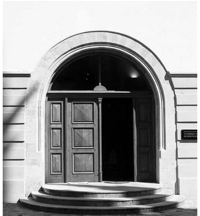
2. Zagreb, Nadbiskupski dvor, pogled na unutarnja vrata nekadašnje ulazne kule nakon adaptacije
