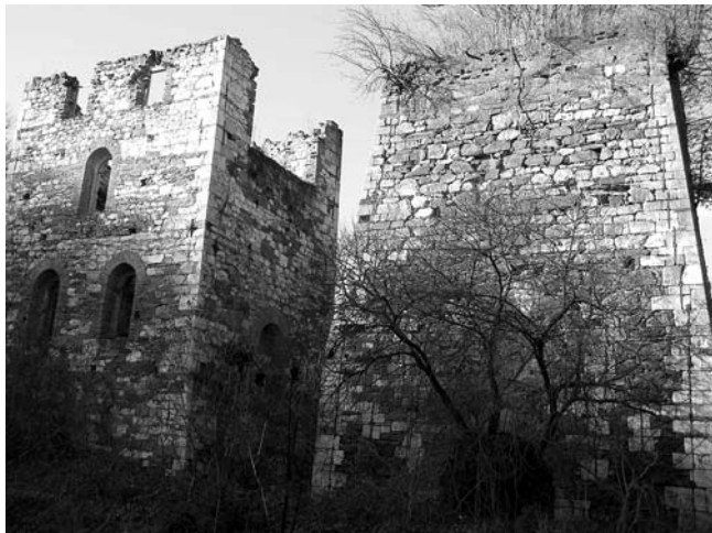
20. Bešlinec kraj Gvozdanskog, pogled na visoku peć (desno) i zgradu za obradu lijeva (lijevo)
