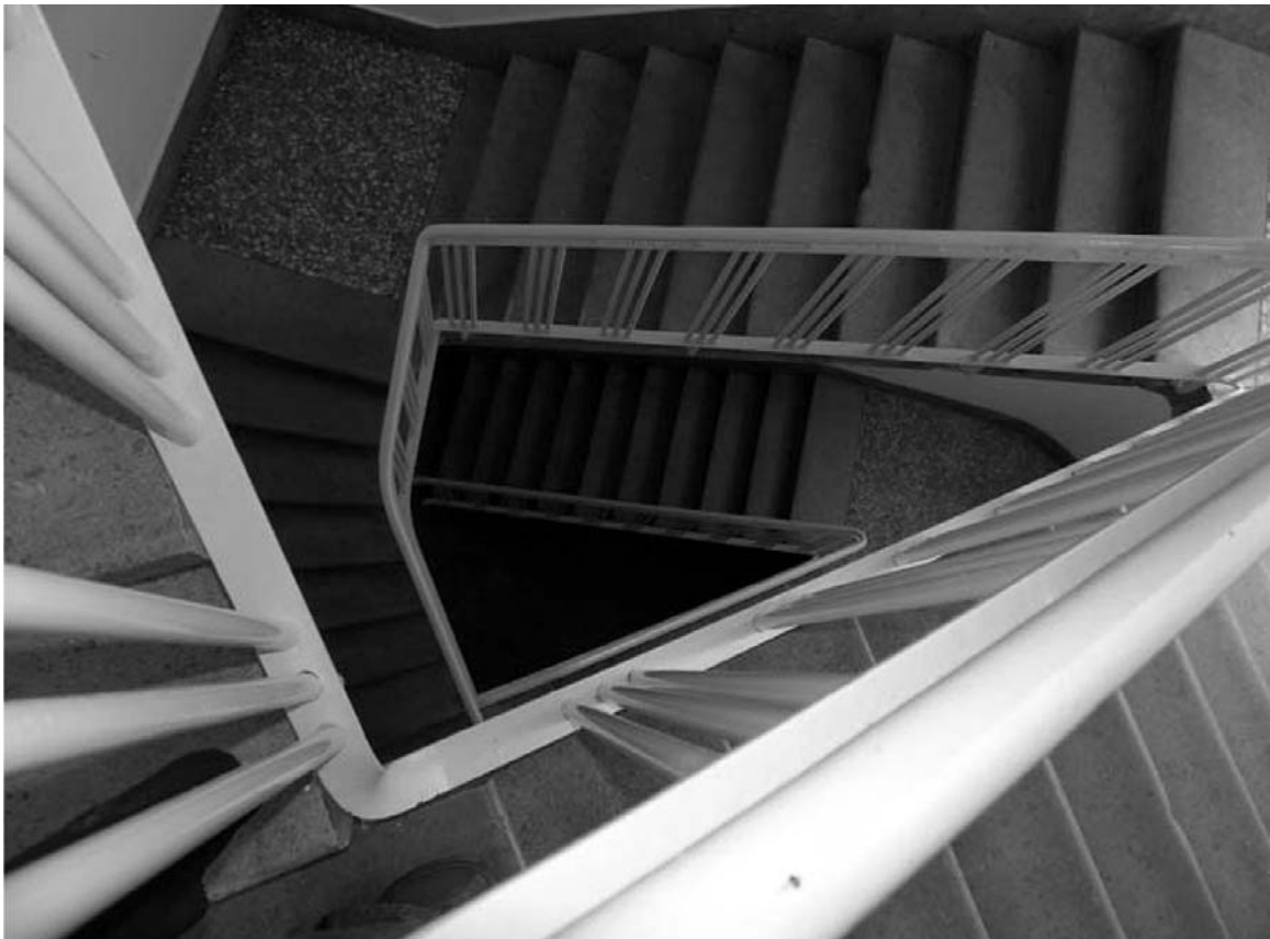
10. Državni arhiv Rijeka, Vodovodna ulica 2, Rijeka, detalji stepeništa
