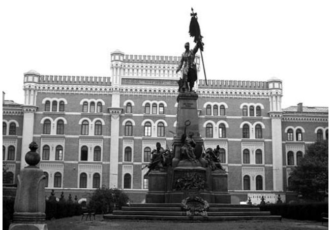
15. Obnovljena vojarna u Rossauu, Beč, 2005. Poslije 1918. vojarna je služila različitim svrhama i postupno propadala, a sedamdesetih godina proteklog stoljeća prijetilo joj je rušenje, no prevladalo je mišljenje da se zaštititi kao spomenik kulture. Devedesetih godina započela je sanacija i restauracija kompleksa, koji je napokon namijenjen uredima Ministarstva obrane i policije. Obnova je okončana 2005. godine.
