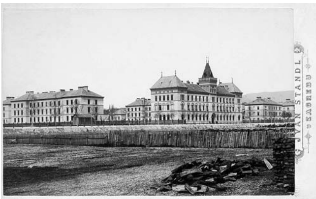
9. Pješачka vojarna, neposredno poslije izgradnje, foto: Ivan Standl
