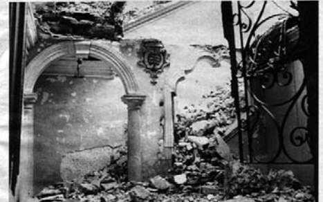
Zerstörtes Gebäude in Dubrovnik: „Dies tut uns von Herzen leid“
