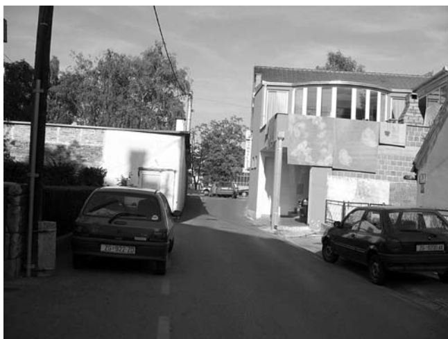
Ovako je izgradnja preko obje strane pločnika dovršila Belečku ulicu tik kraj Trešnjevačkog trga
