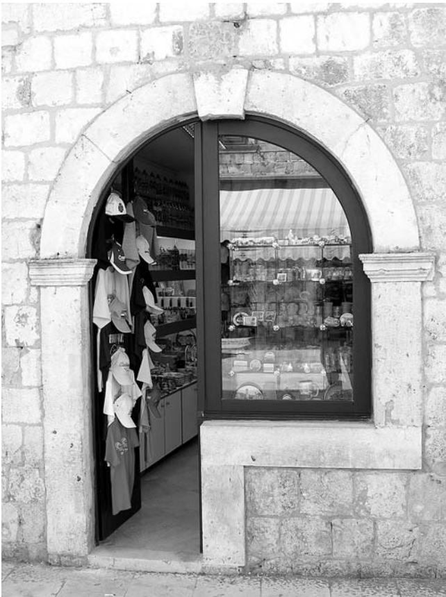
Tradicionalno oblikovanje »vrata na koljeno« na dubrovačkoj glavnoj ulici Placi sa suvenirskom ponudom, ožujka 2006. (foto: A. Baće)
