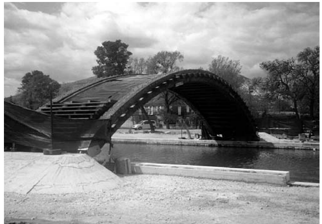
Novi drveni pješački most preko Foše na zapadnom kraju. Zbog nepotrebno velike visine ozbiljno se nametnuo neposrednom okolišu. Pored toga uspon stepenicama bitno ograničava njegovu upotrebljivost za starije i invalidne osobe.
