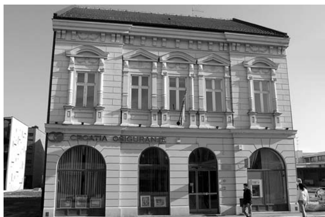
4. Vukovar, zgrada »Croatia osiguranje«: faksimilna rekonstrukcija potpuno srušene građevine izvedena na temelju prijeratne fotodokumentacije (foto: Đ. Šimičić, HRZ, 2001.)
