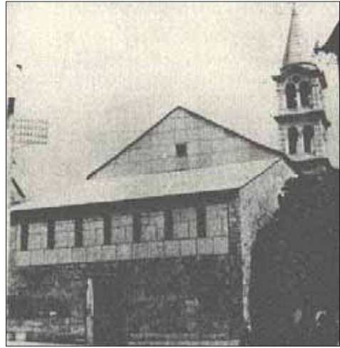
Sanacija porušenog pročelja 1945.
