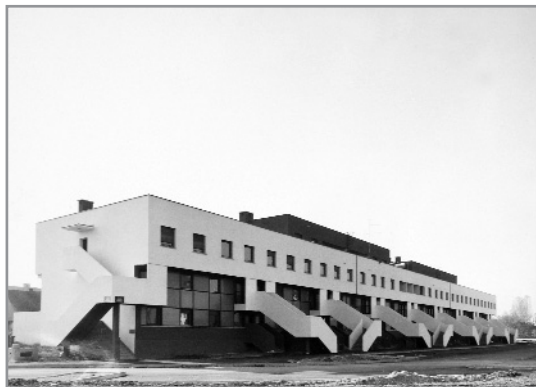
Jarun, Prikilova 3-17, stambeni niz (Tomislav Odak, 1979.-1984.), ulično pročelje
