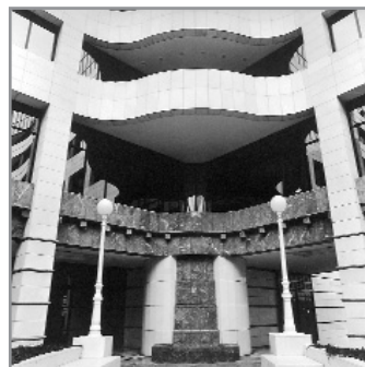
Avenija V. Holjevca, poslovna zgrada INA - Trgovina (Velimir Neidhardt, 1986.-1988.), detalj dvorišnog pročelja
