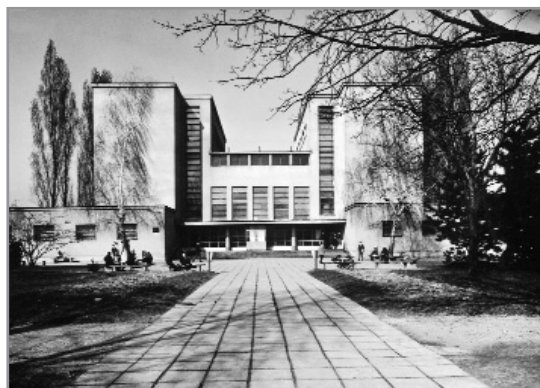
Škola na Jordanovcu (1930.), pročelje
