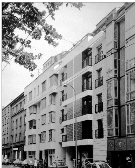
Republike Austrije, tri višestambene zgrade (Branko Kincl, 1976.-1983.)
