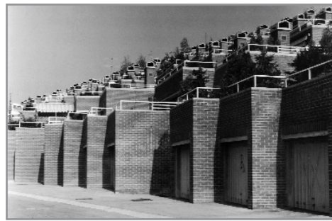
Kajfešova brijeg, stambeni nizovi (Ante Marinović-Uzelac, 1980.-1987.), pogled na terase
