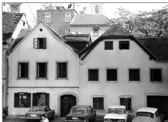
Tkalčičeva 48-50, korektno obnovljena pročelja 70-ih godina
