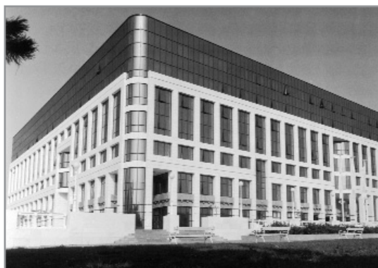
Avenija V. Holjevca, poslovna zgrada INA - Trgovina (Velimir Neidhardt, 1986.-1988.), pročelje
