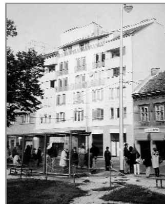
Ilica 158, stambena zgrada (Boris Duplančić, 1989.-1993.)
