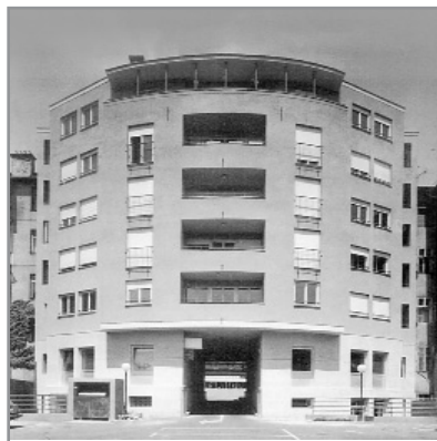
Ilica 147, stambena zgrada (Boris Duplančić, 1988.-1993.), dvorišno pročelje
