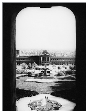
Glavni kolodvor, pogled sa zgrade Umjetničkog paviljona
