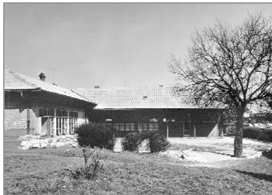
Laščina, obdanište (Ivan Zemljak, 1935.), terasa i trijem pred blagovaonicom nakon što je izmijenjen pokrov krova
