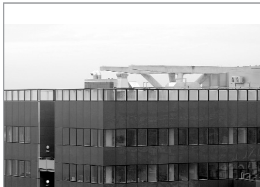
Slavonska avenija, Hypo banka (Thom Mayne, 2003.-2006.), infrastrukturna nadgradnja
