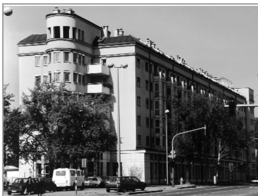
Maksimirska ulica-Svetice, stambeno-poslovna zgrada na Ružmarinki (Željko Jagić, Hrvojkja Paljan, 1985.-1988.), južno i istočno pročelje
