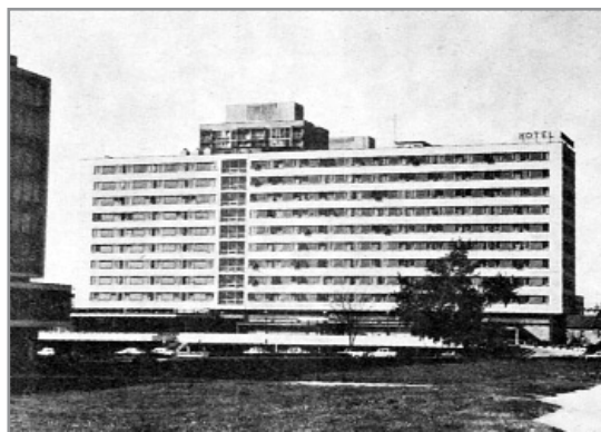
Vukovarska-Miramarska 24, Hotel “Internacional” (Božidar Tušek, 1959.), istočno pročelje
