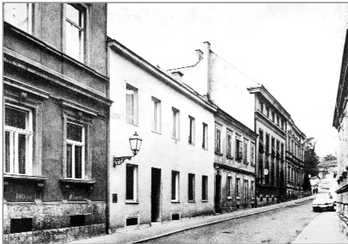
Jurjevska ulica, obiteljska stambena kuća (Stjepan Planić, 1932.)
