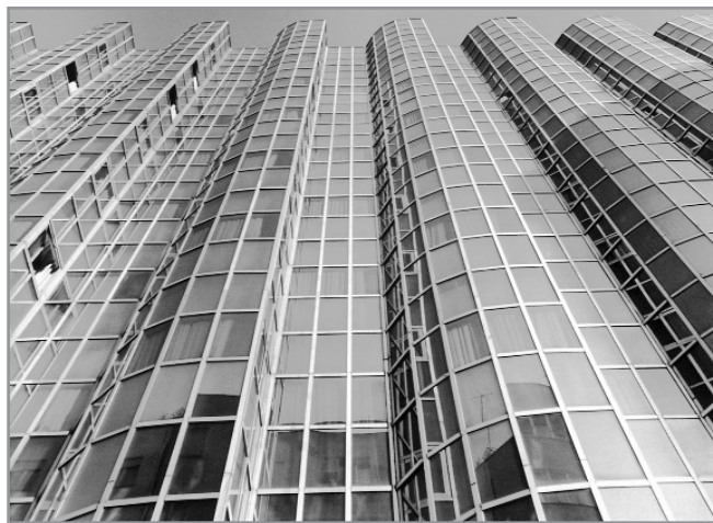
Gajeva 3, Hotel Dubrovnik II (Ines i Nikola Filipović, 1979.-1982.), detalj pročelja
