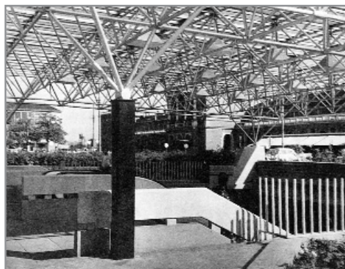
Konstrukcija nad sjevernim ulazom
