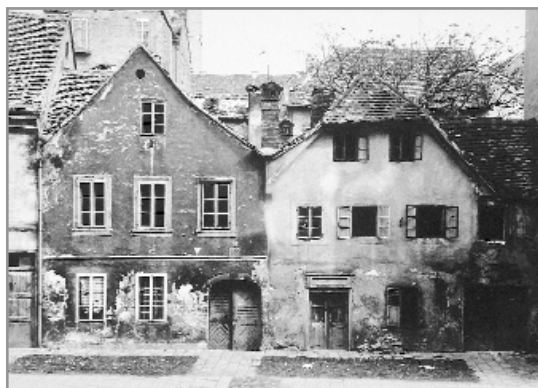
Tkalčičeva 48-50, stanje prije obnove pročelja
