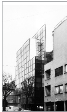
Vončinina 2, poslovna zgrada (Grujo Golijanin, 1968.-1983.), detalj pročelja
