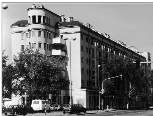
Maksimirska ulica-Svetice, stambeno-poslovna zgrada na Ružmarinki (Željko Jagić, Hrvojka Paljan, 1985.-1988.), južno i istočno pročelje
