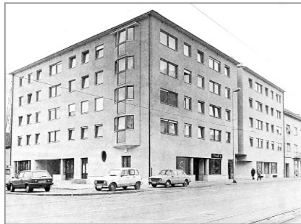
Ozaljska ulica, stambena zgrada (Dražen Posavec, Helena Knifić, Mario Volović, 1981.-86.)
