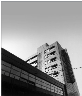
Petračićeva 4, poslovna zgrada Sport Heruc (Jasna Nosso, Lujo Schwerer, 1984.-1987.), dio istočnog pročelja
