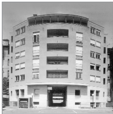
Ilica 147, stambena zgrada (Boris Duplančić, 1988.-1993.), dvorišno pročelje
