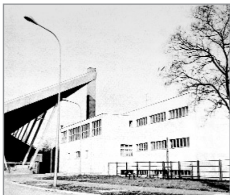
Jakićeva ulica, škola, zapadno - glavno pročelje, stanje nakon izgradnje istočne tribine stadiona u Maksimiru, uklonjeni su ulaz i stubište (1975.)
