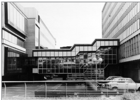
Avenija Vukovar 78, spojni most zgrade INA (Zlatko Jurić, 1984.-1988.)
