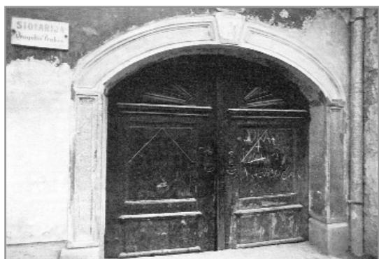
Tkalčićeva 24, kameni portal popravljen cementnom žbukom
