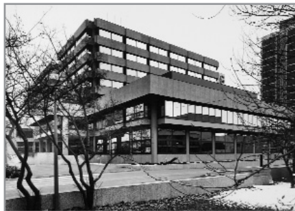
Vukovarska 72, poslovna zgrada FINA (Aleksandar Dragomanović, Radovan Nikšić, 1969.-1981.), sjeverno pročelje
