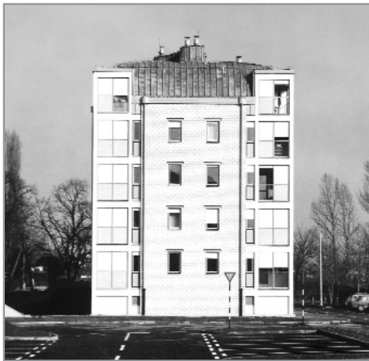
Borongaj, stambena zgrada Aero (Tomislav Odak, 1987.- 1990.) bočno pročelje
