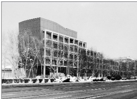
Avenija Dubrovnik, poslovna zgrada carina i Intereurope na Zagrebačkom velesajmu (Đivo Dražić, Edvin Šmit, 1990.-1991.), južno pročelje
