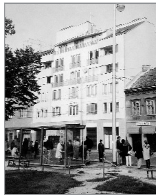
Ilica 158, stambena zgrada (Boris Duplančić, 1989.-1993.)
