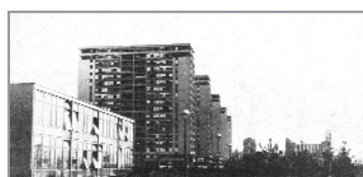
Siget, istočna strana naselja. U prednjem je planu južno pročelje Osnovne škole "Većeslav Holjevac", a iza nje niz stambenih šesnaestokatnica arh. Feldmana i Zlatara, sasvim desno je obris franjevačke crkve u gradnji
