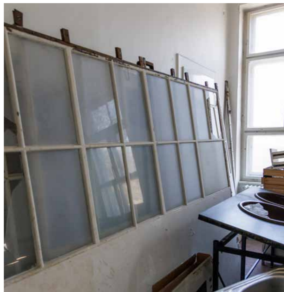
Slika 33. Pomične pregrade unutar prostorija
