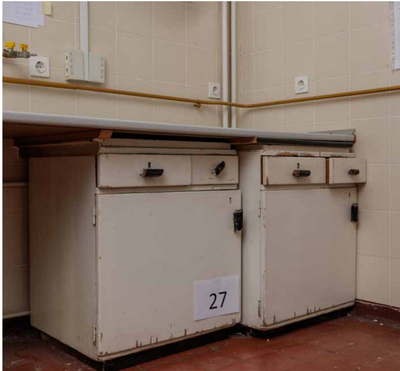
Slika 27. Laboratorijski podpultni ormarići
