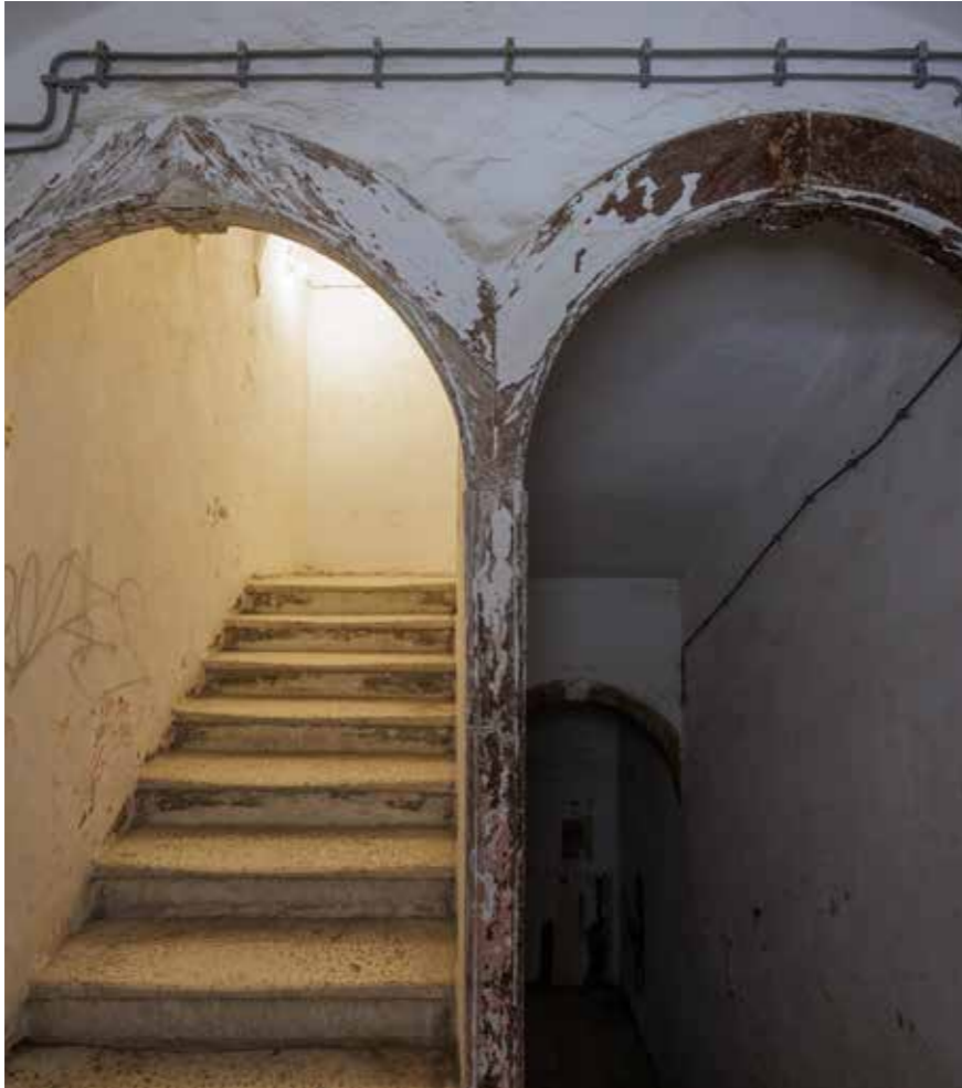
Detalji drvenih lukova u stubištu
