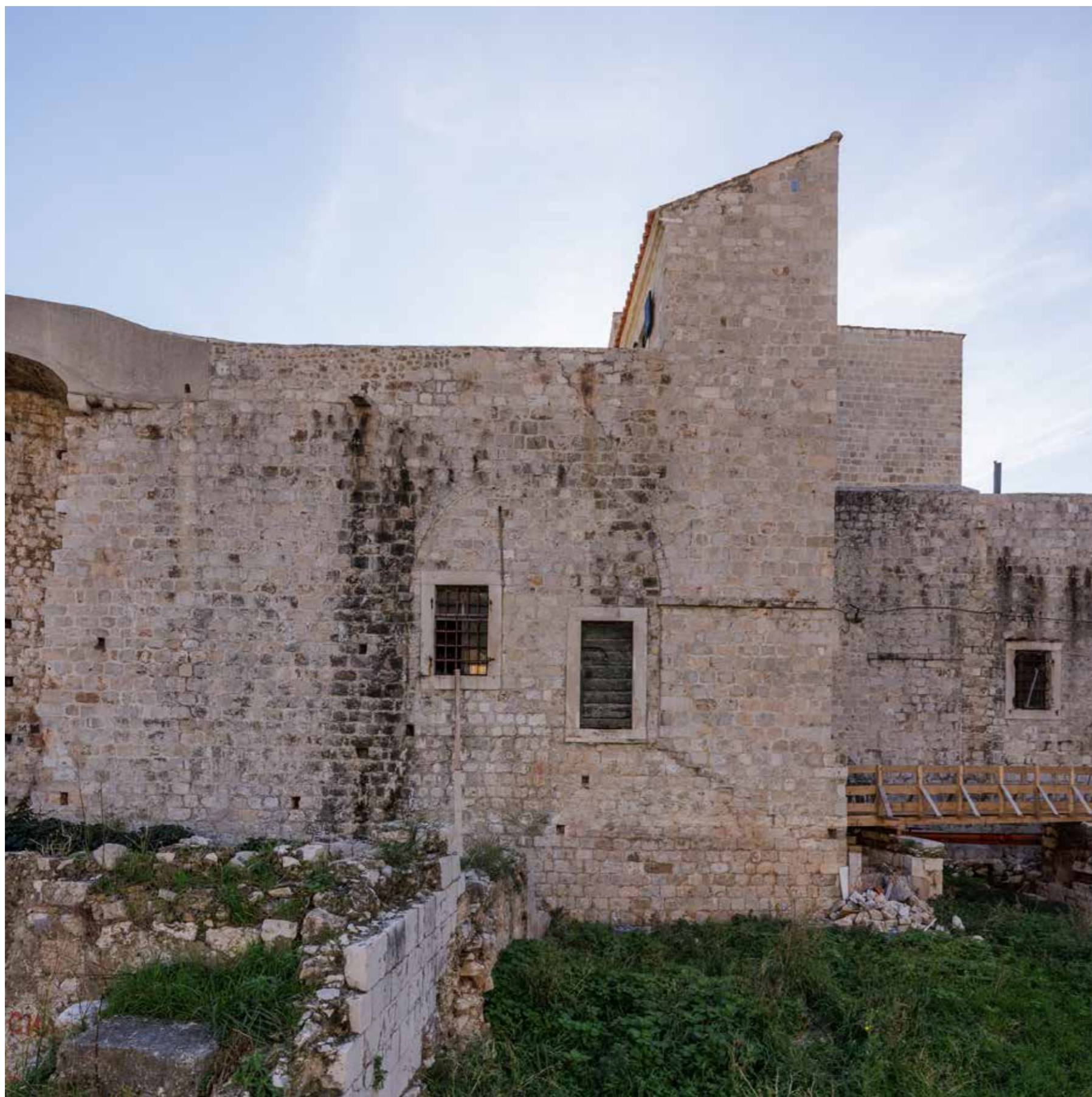
Bastion Sv. Spasitelja, sjeverno pročelje s vidljivim zazidanim lučnim otvorima i naknadnim prozorima
