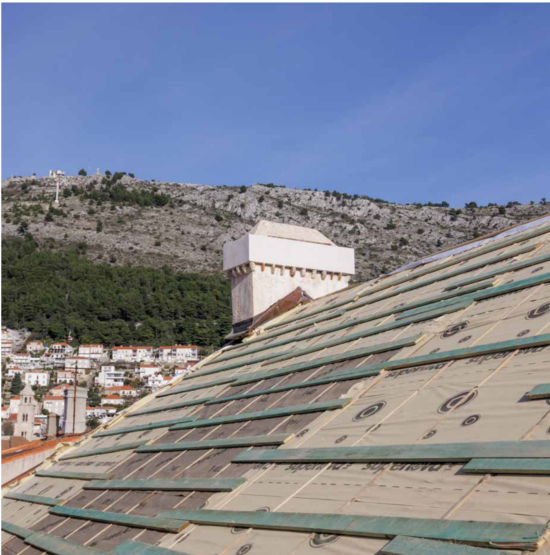
Zgrada nekadašnjeg zatvora, krov tijekom obnove 2022.
