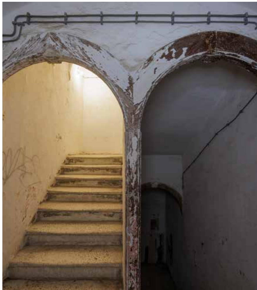
Detalji drvenih lukova u stubištu
