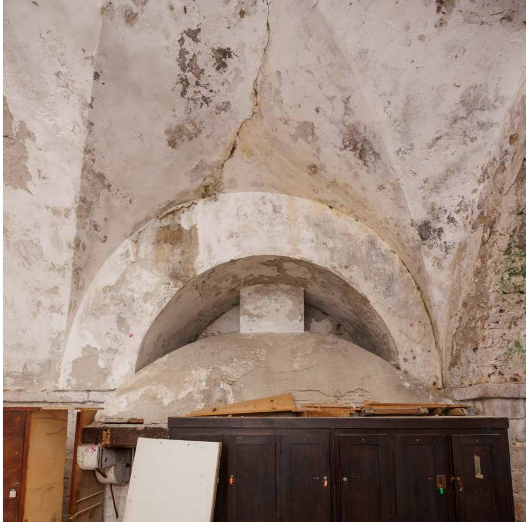
Detalj nape kamina
