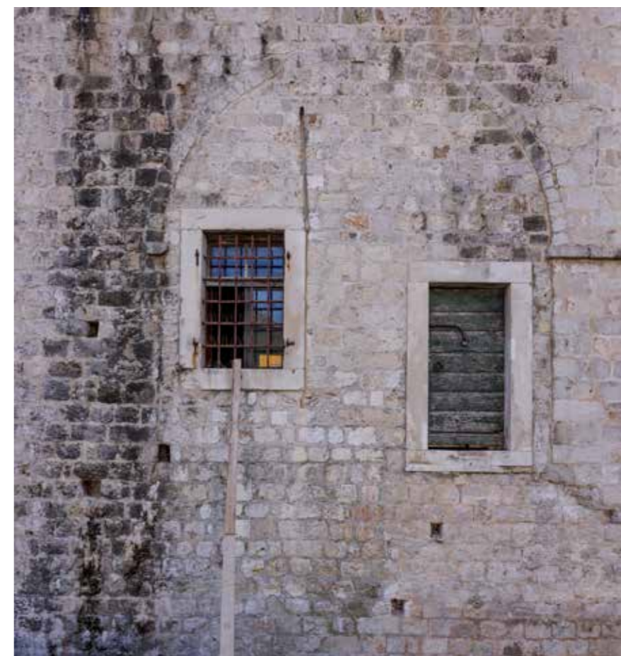
Zazidani lučni otvor na sjevernom pročelju
