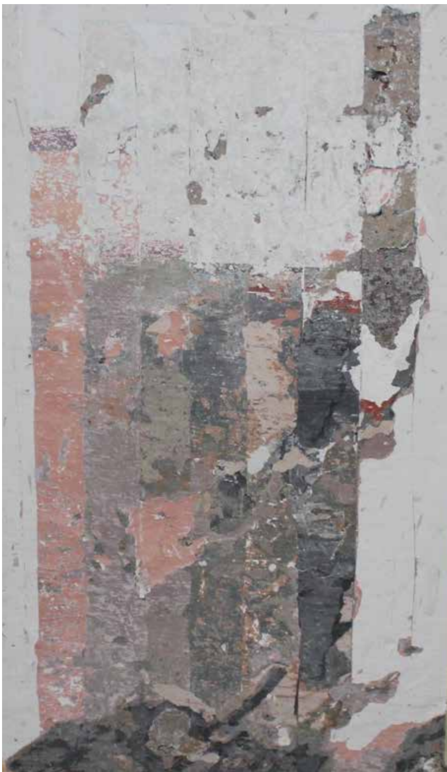
Restauratorske sonde na zidu, kamenom okviru te drvenom luku u stubištu zgrade nekadašnjeg zatvora, Izveštaj konzervatorsko-restauratorskih istražnih radova , Omega engineering, 2019.
