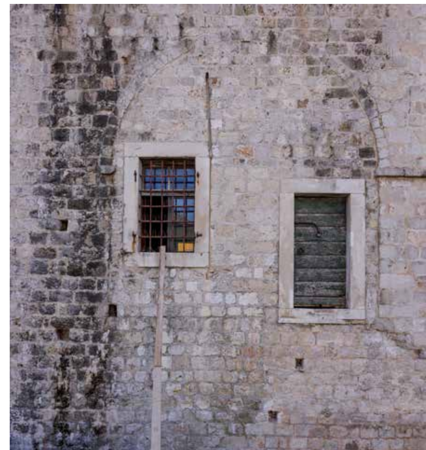
Zazidani lučni otvor na sjevernom pročelju
