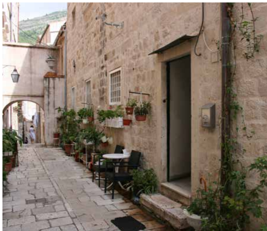
Zgrada nekadašnjeg zatvora, zapadno pročelje, prizemna zona
