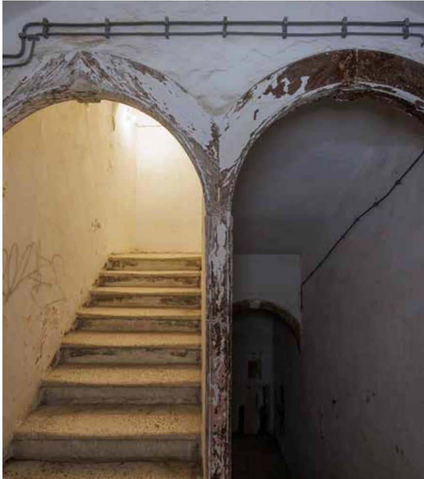
Detalji drvenih lukova u stubištu
