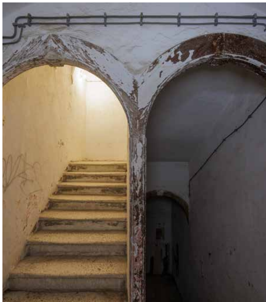
Detalji drvenih lukova u stubištu
