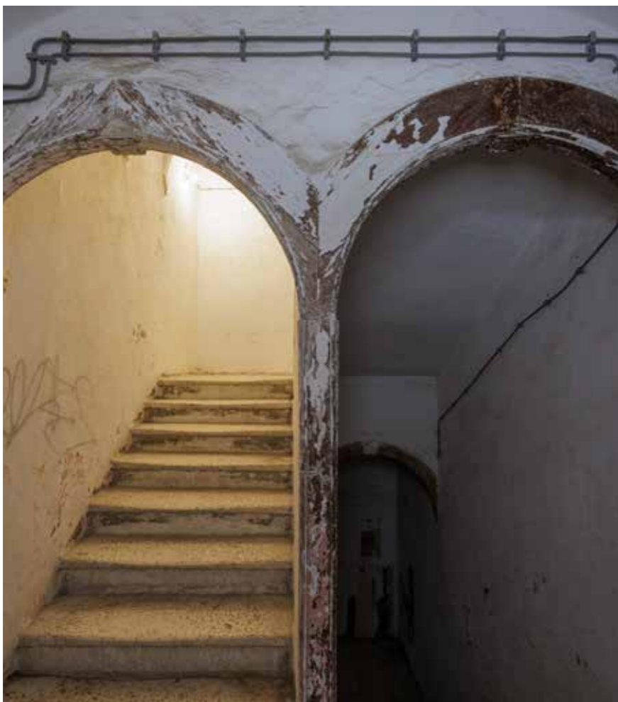
Detalji drvenih lukova u stubištu
