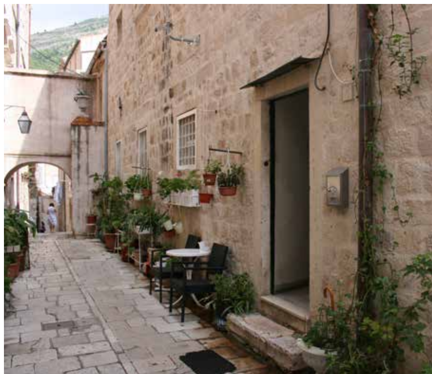
Zgrada nekadašnjeg zatvora, zapadno pročelje, prizemna zona
