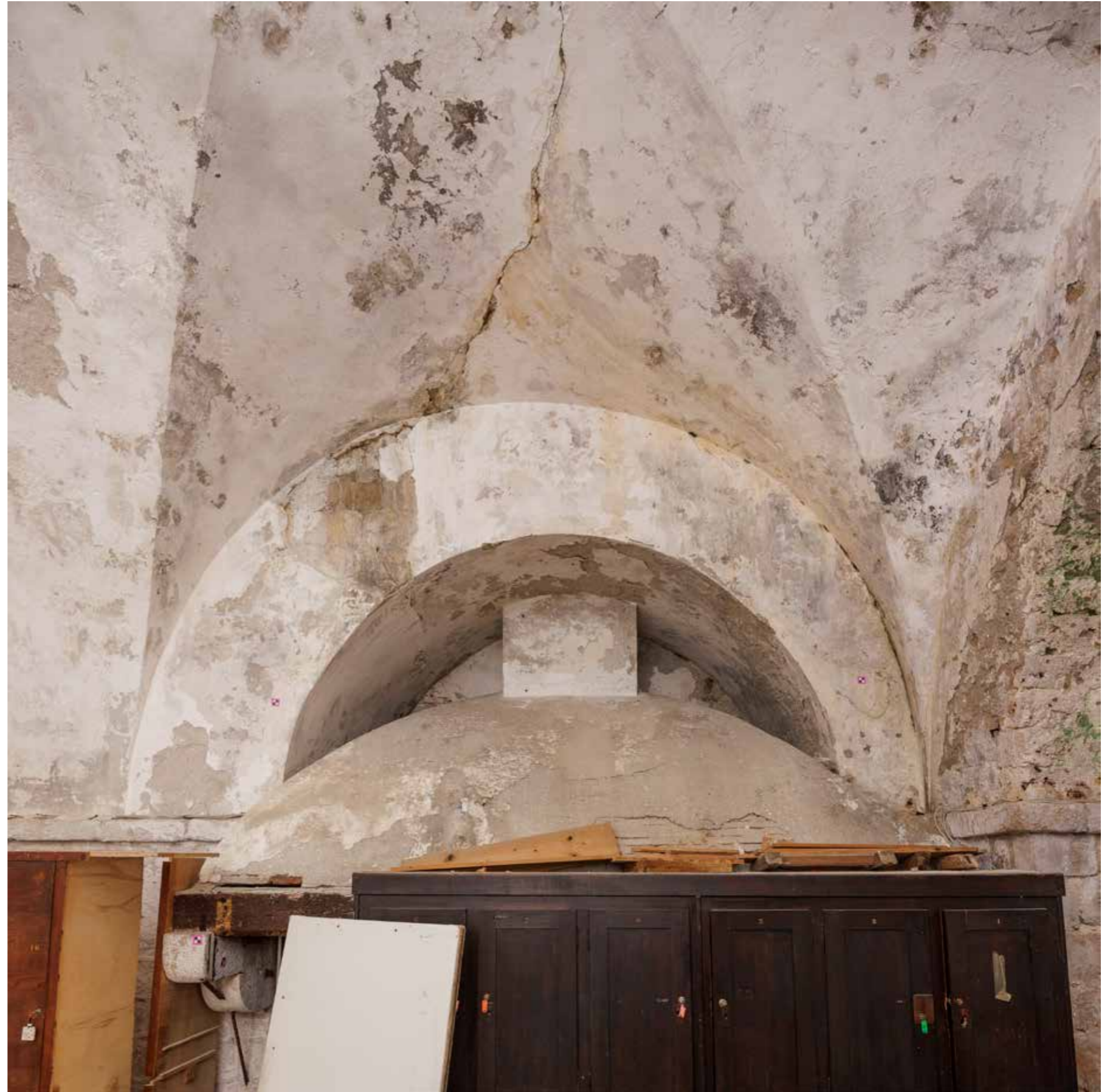
Detalj nape kamina
