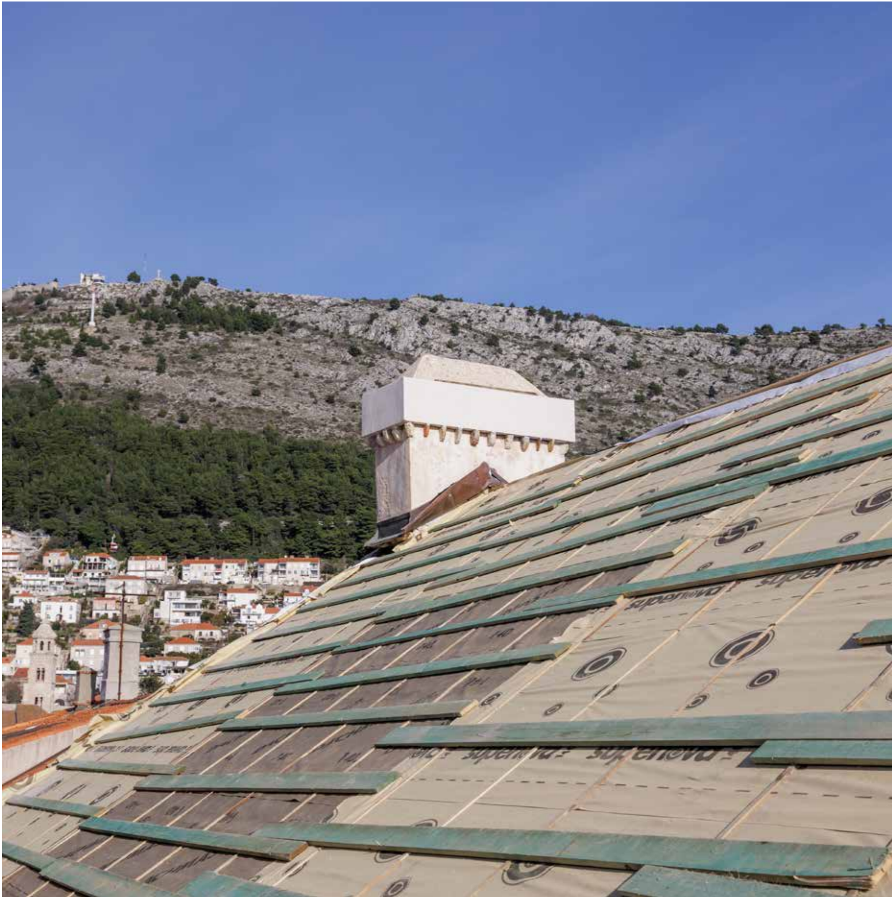
Zgrada nekadašnjeg zatvora, krov tijekom obnove 2022.
