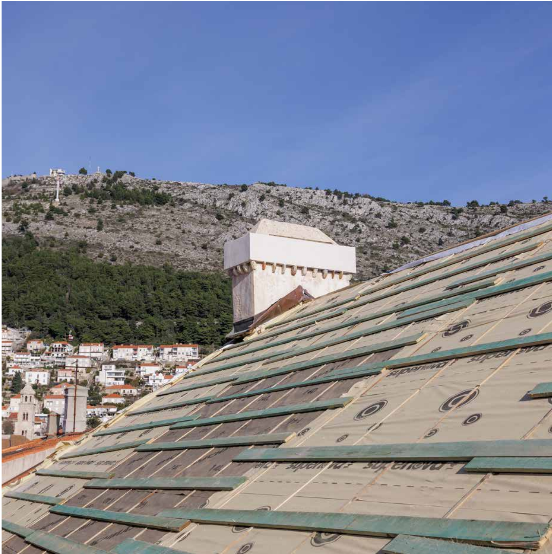
Zgrada nekadašnjeg zatvora, krov tijekom obnove 2022.
