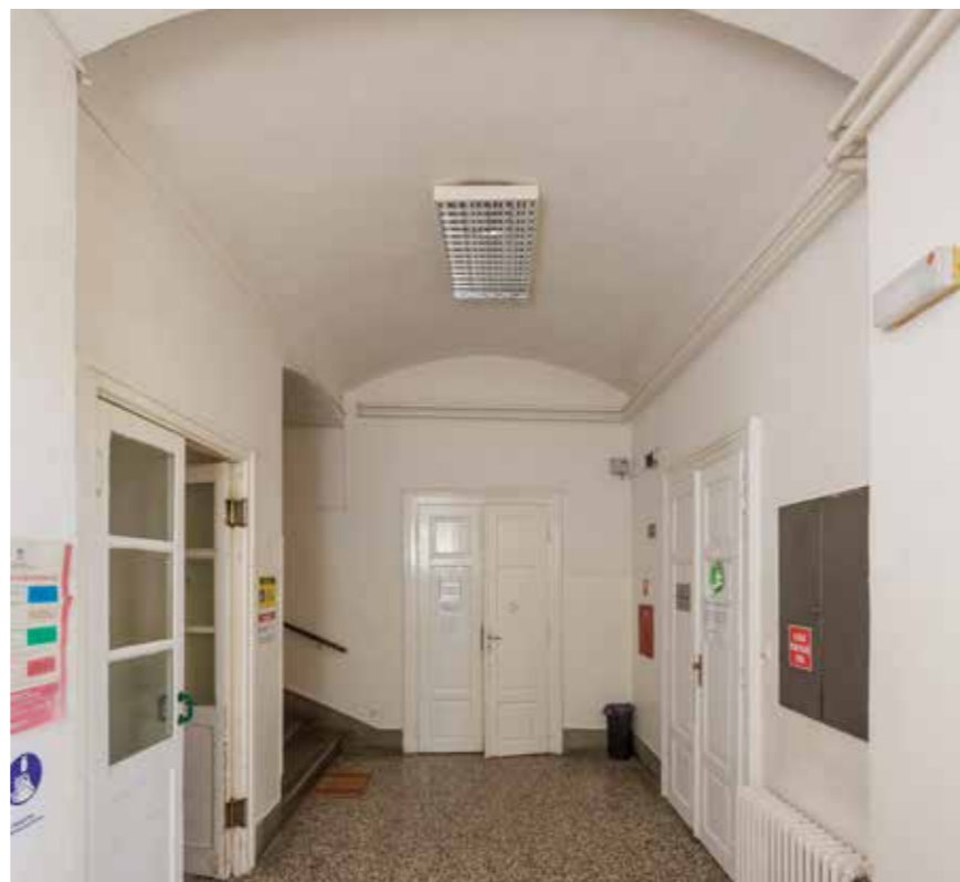
Hodnik ispred stubišta u bočnom istočnom krilu
