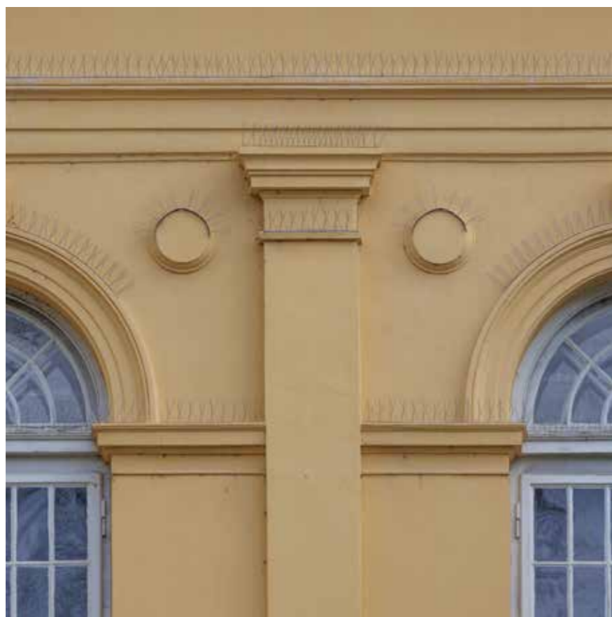
Toskanski pilastri na drugom katu južnog pročelja
