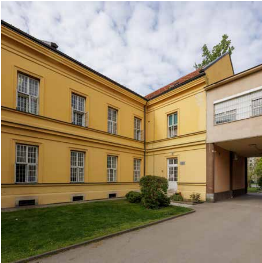
Spoj zapadnog krila i dogradnje
