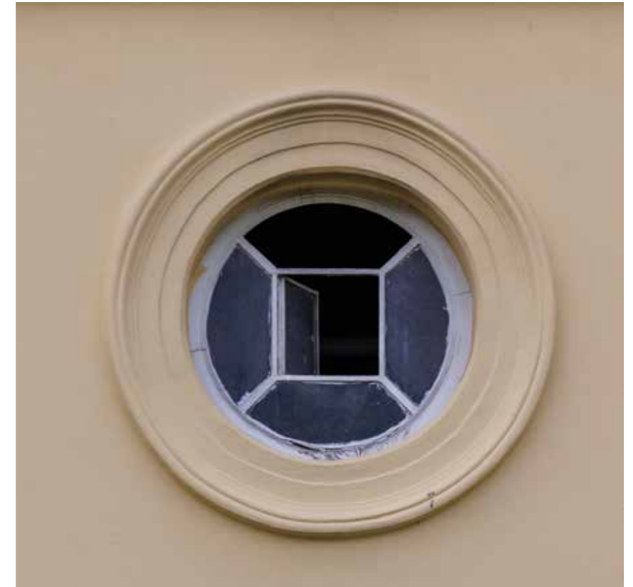
Okrugli prozor na sjevernom pročelju
