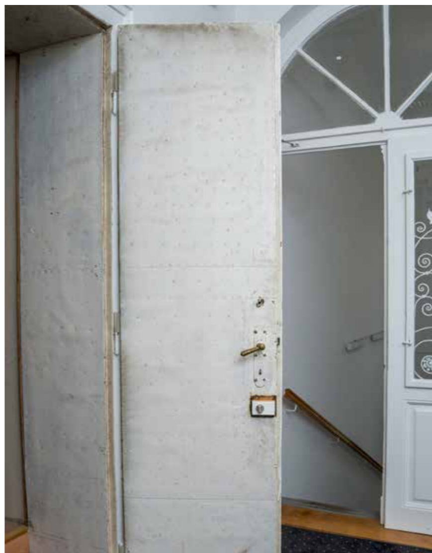
Vatrobrana vrata pema potkrovlju
