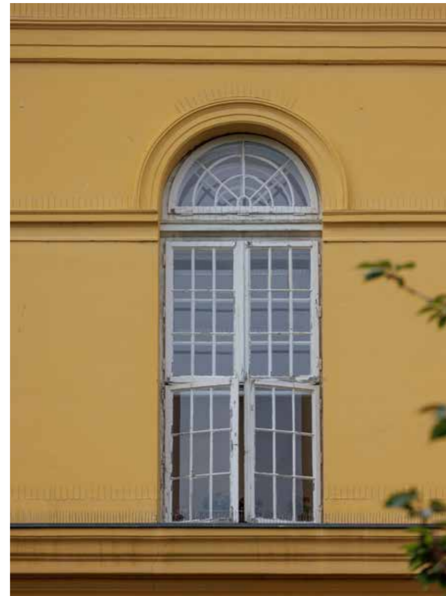
Prozor nekadašnje svečane dvorane na sjevernom pročelju
