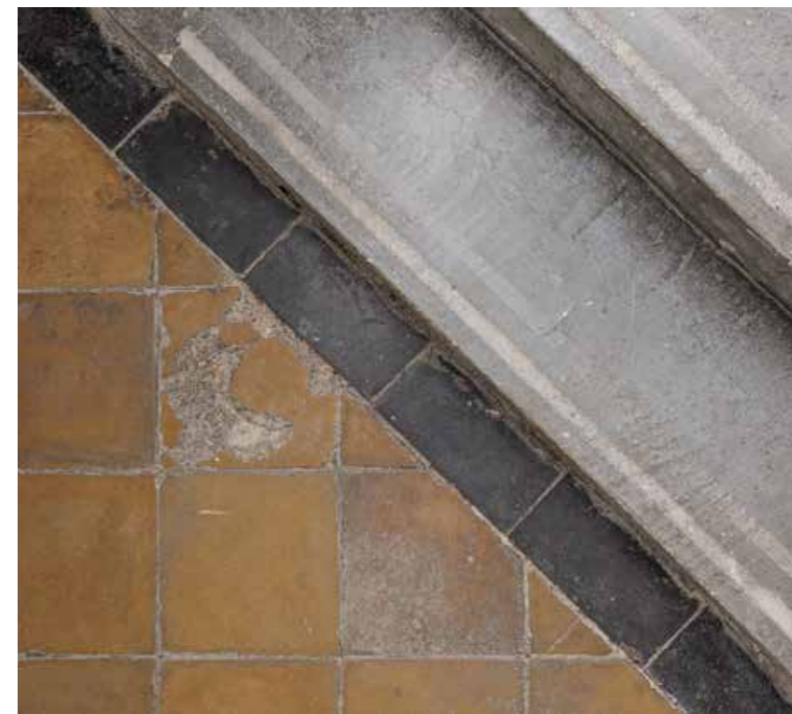
Podne pločice podesta i obložene kamene stube
