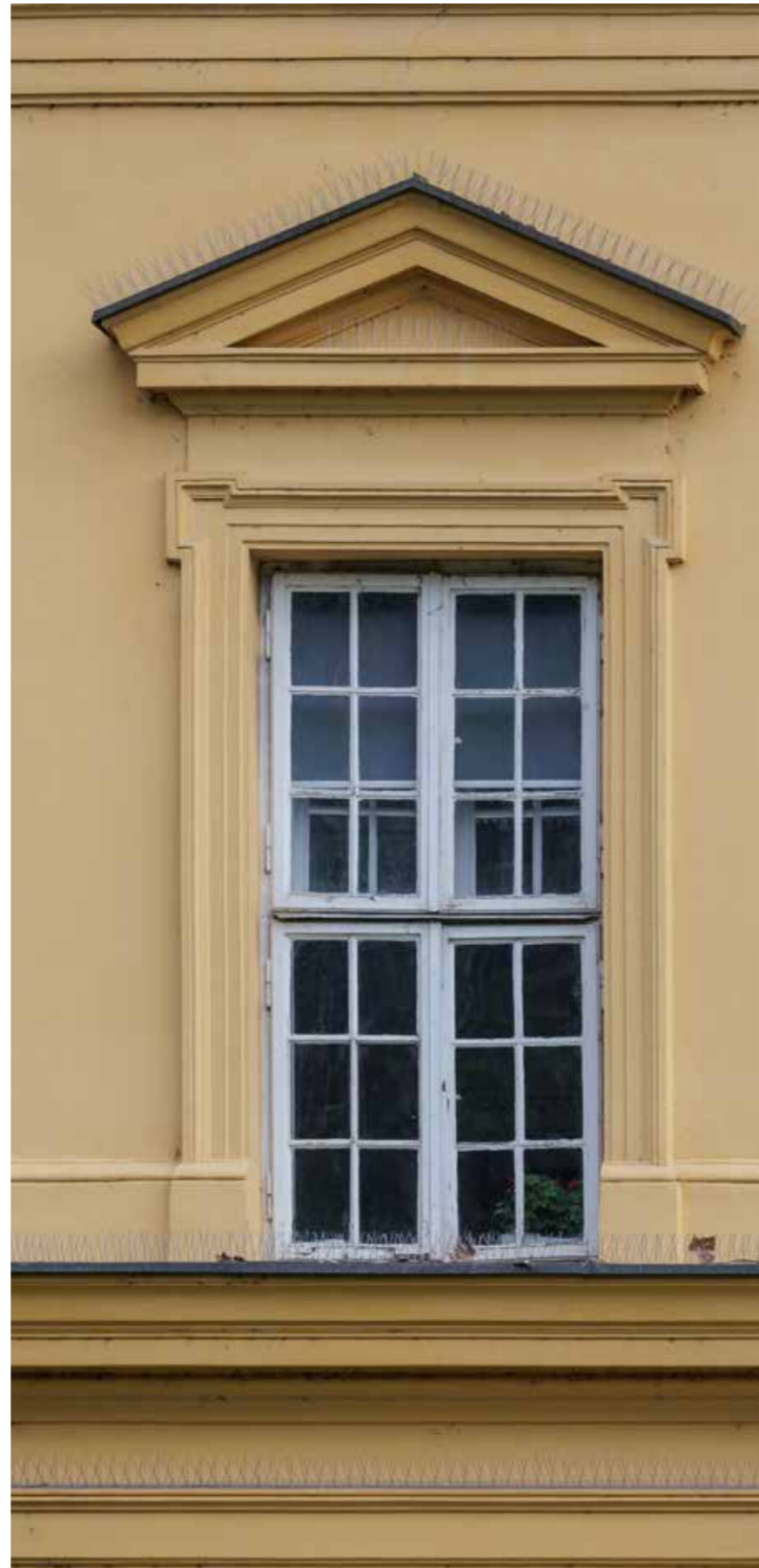
Prozor na rizalitu drugog kata južnog pročelja
