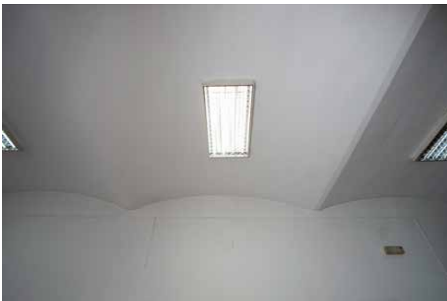
Svodovi u hodniku istočnog krila
