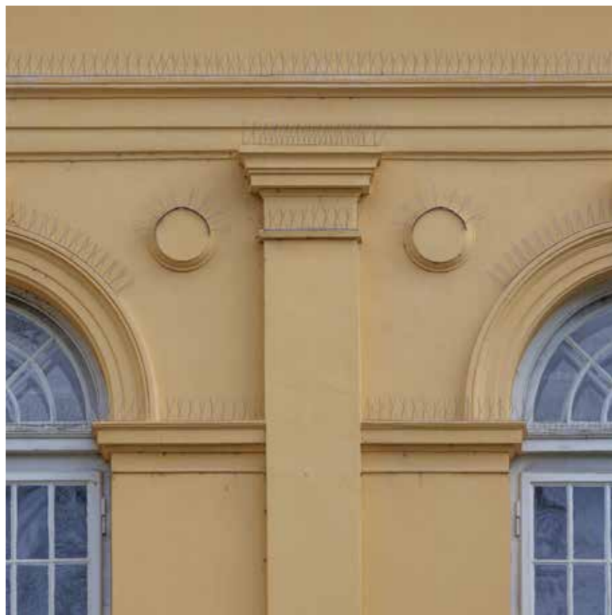
Toskanski pilastri na drugom katu južnog pročelja
