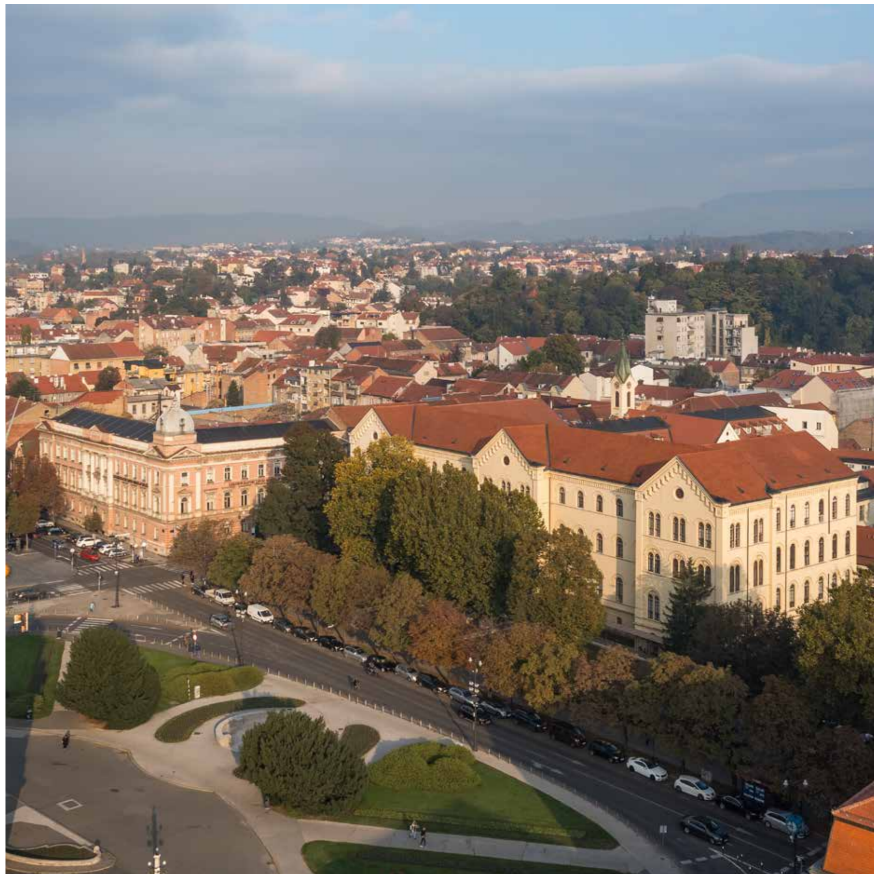
Nekadašnja Opća zemaljska bolnica (sada zgrada Rektorata Sveučilišta u Zagrebu), Ludwig Zittel, 1856.
