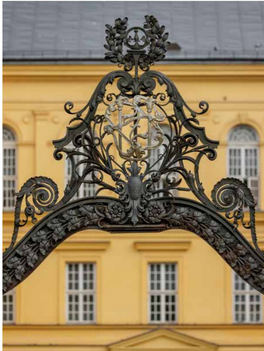
Ulazni portal u bolnički kompleks, detalji
