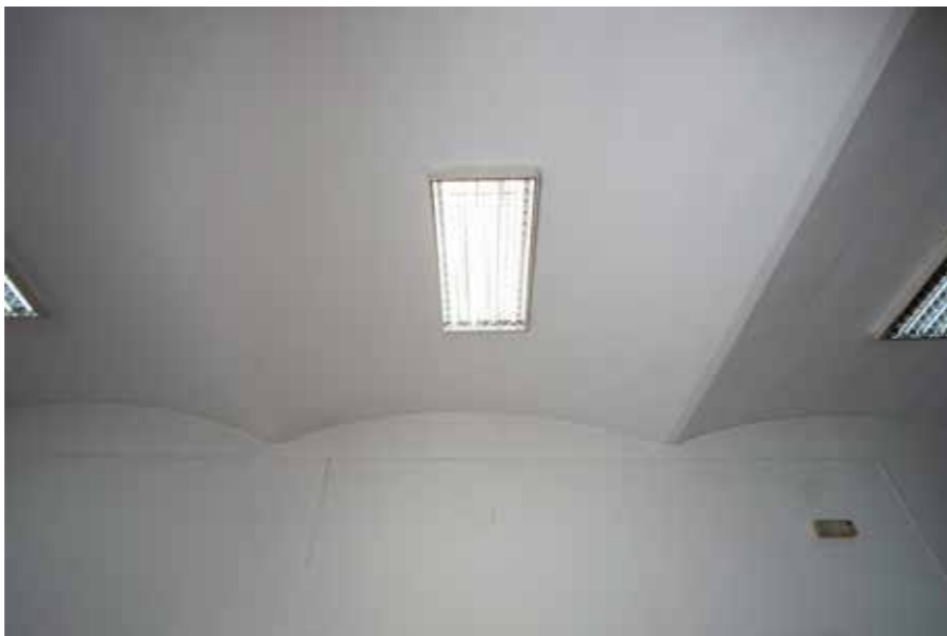
Svodovi u hodniku istočnog krila
