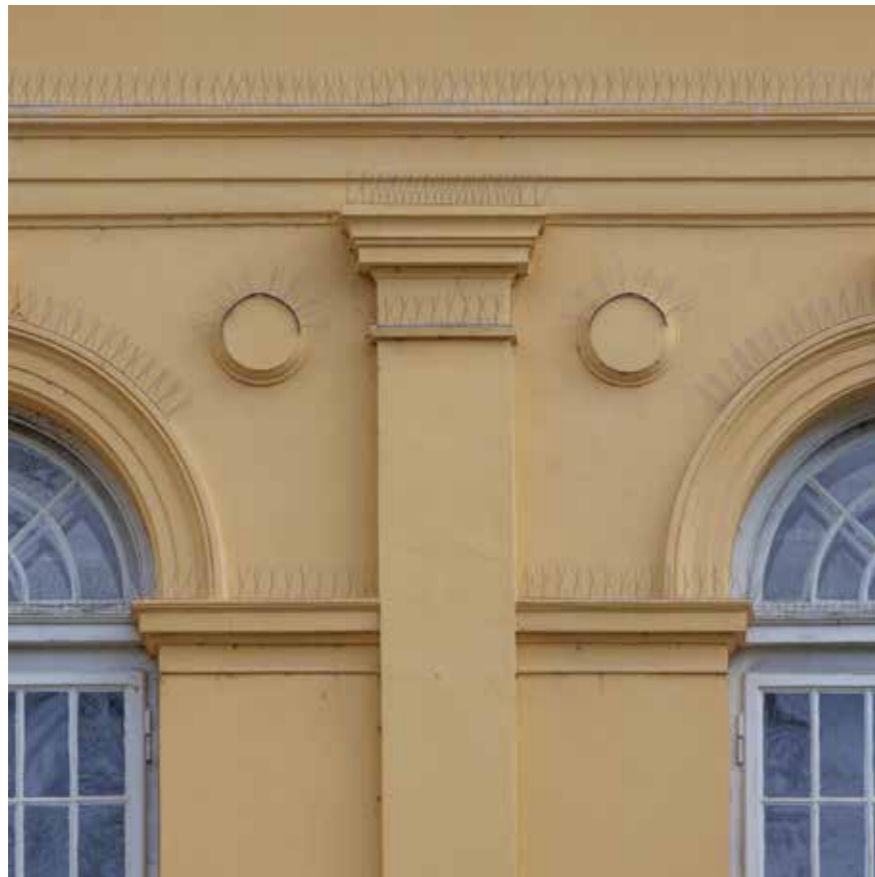
Toskanski pilastri na drugom katu južnog pročelja
