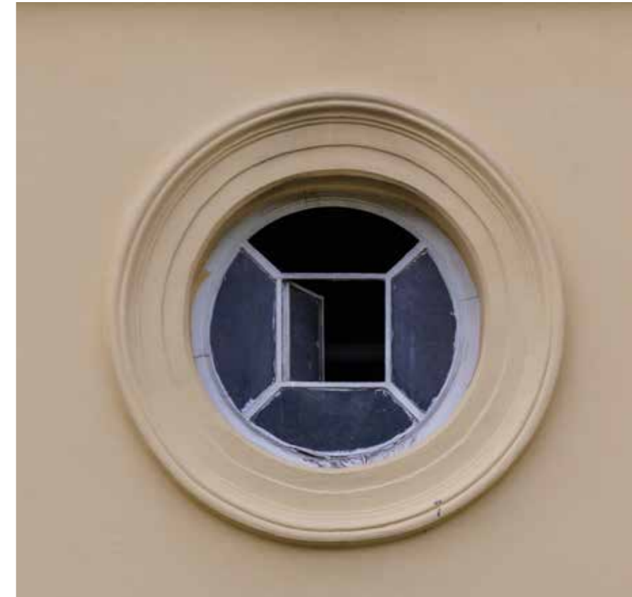
Okrugli prozor na sjevernom pročelju
