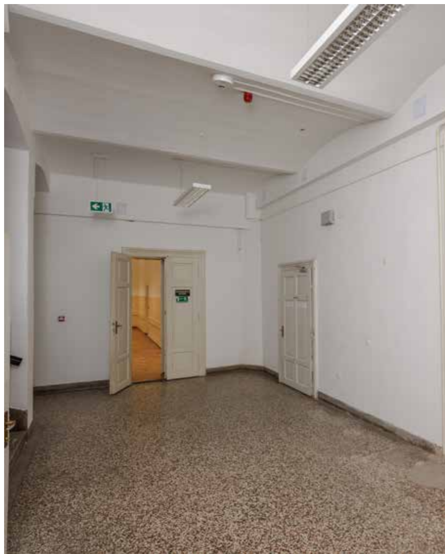
Pretprostor istočnog stubišta
