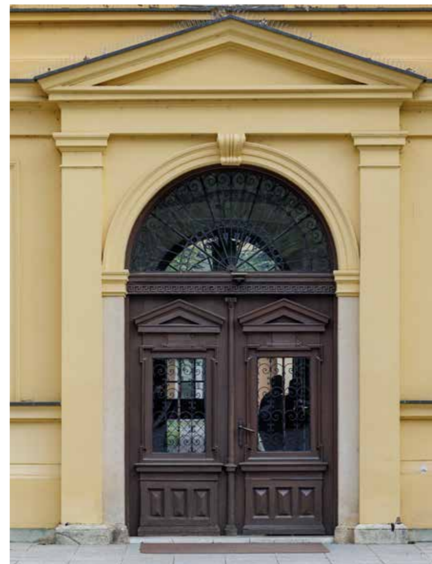
Glavni ulaz u zgradu
