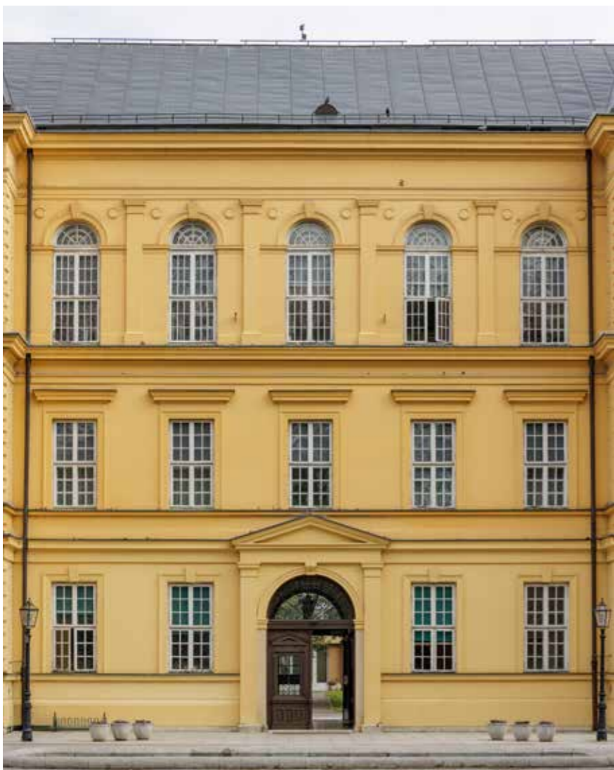
Središnji dio južnog pročelja
