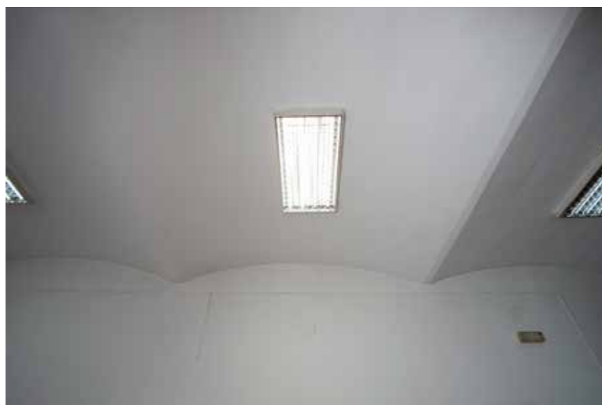
Svodovi u hodniku istočnog krila
