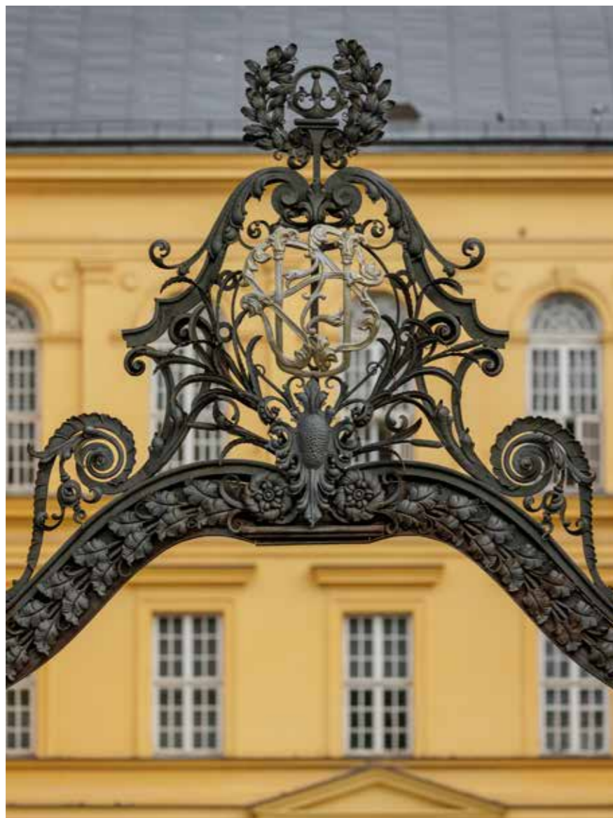
Ulazni portal u bolnički kompleks, detalji
