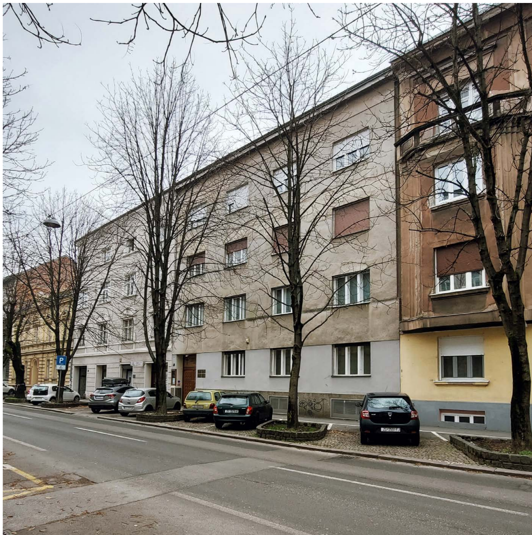
Sl. 3. Glavna stambeno-poslovna trokatnica s dvoranom u nizu ugrađenih zgrada u Prilazu Gjure Deželića
