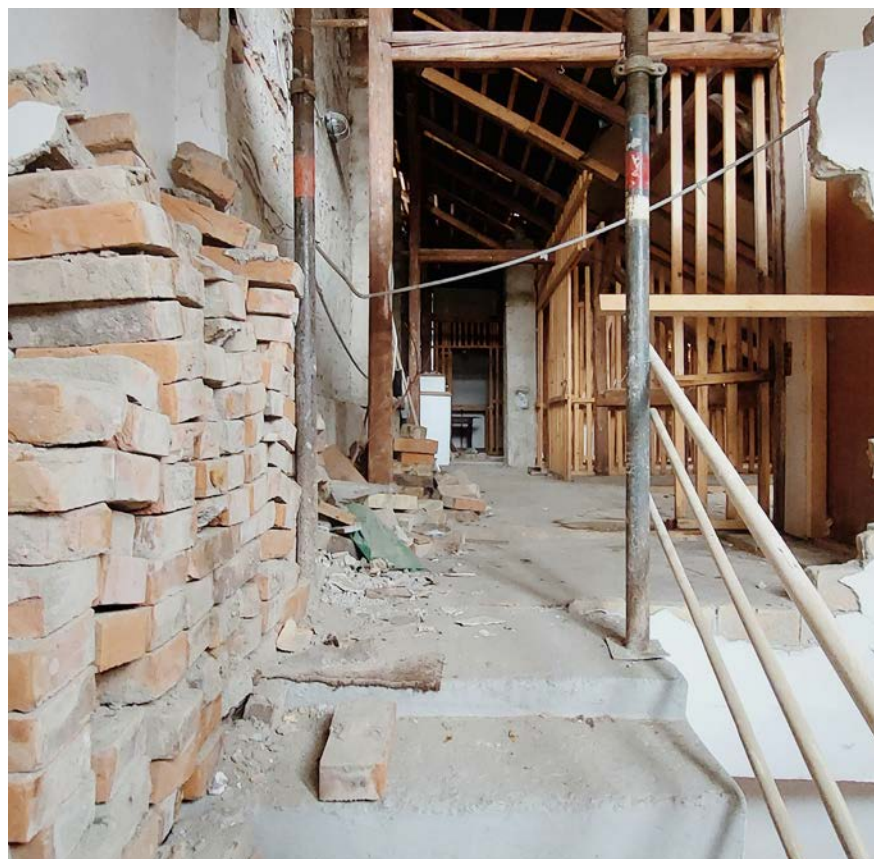
Sl. 33. Pristup potkrovlju sa stubišta
