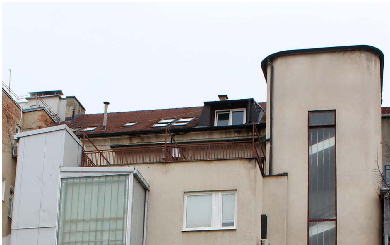
Sl. 7. Pogled na krov, pad prema dvorišnoj strani
