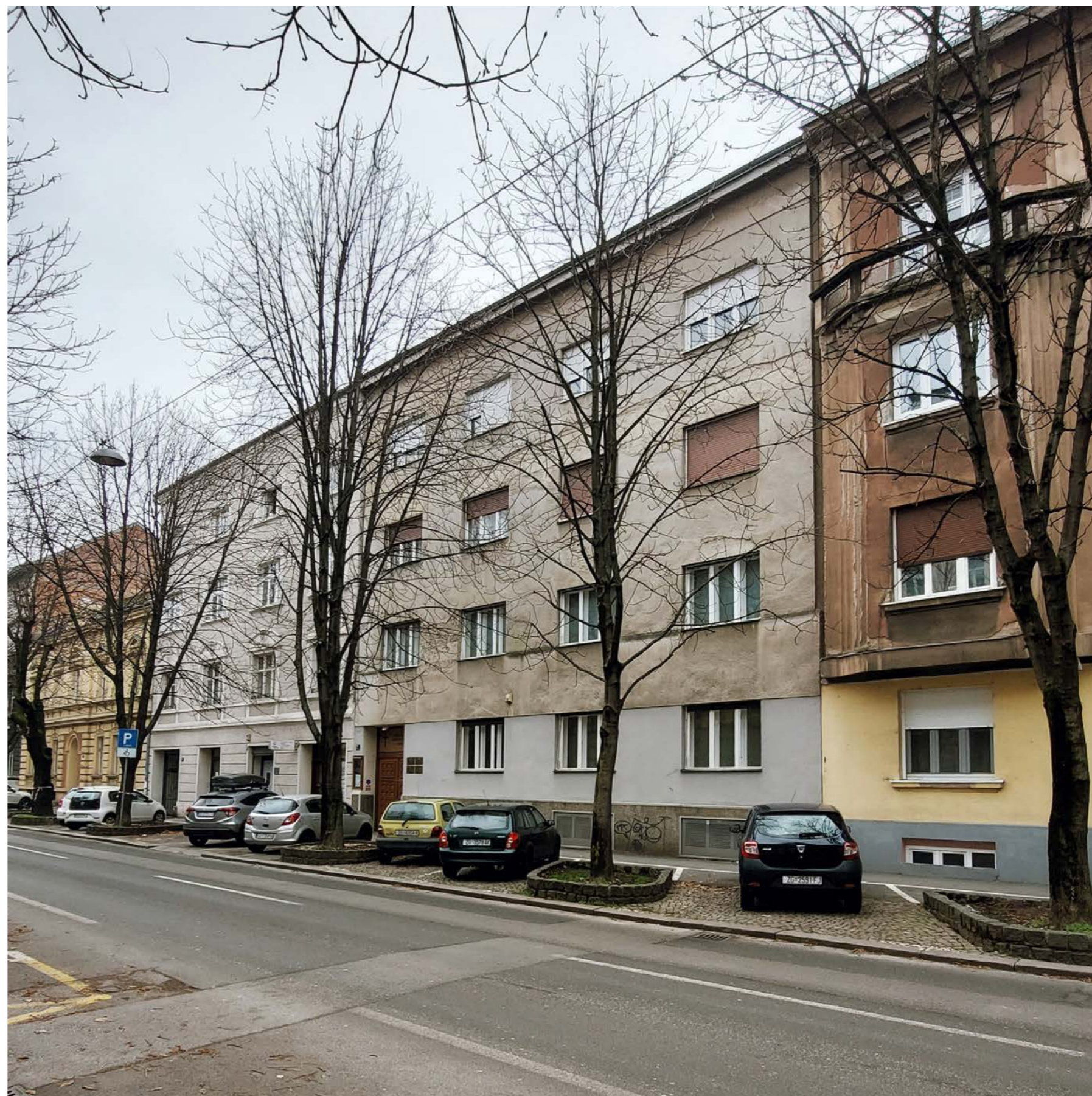
Sl. 3. Glavna stambeno-poslovna trokatnica s dvoranom u nizu ugrađenih zgrada u Prilazu Gjure Deželića
