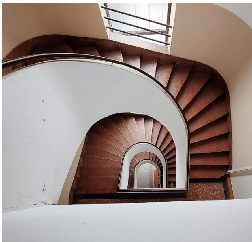
Sl. 27. Glavno stubište, pogled kroz etaže
