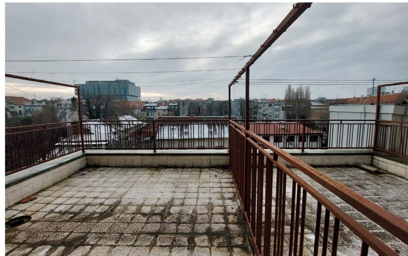
Sl. 8. Terasa kojom je na trećem katu zaključen istak zgrade prema dvorištu
