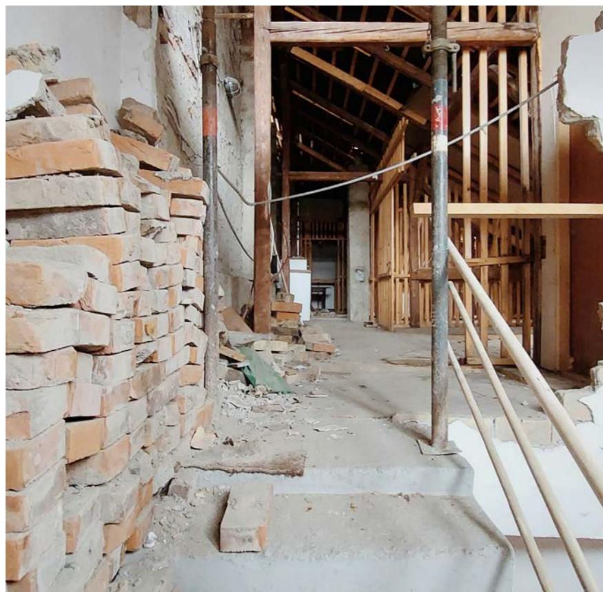
Sl. 33. Pristup potkrovlju sa stubišta
