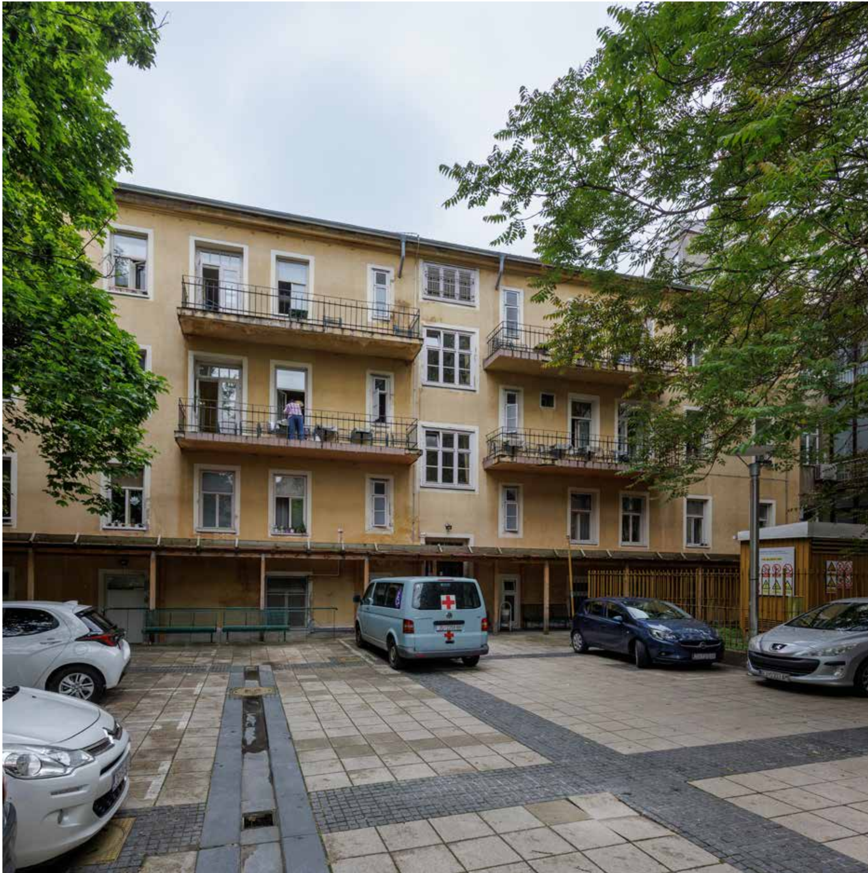
Sjeverno dvorišno pročelje s balkonima
