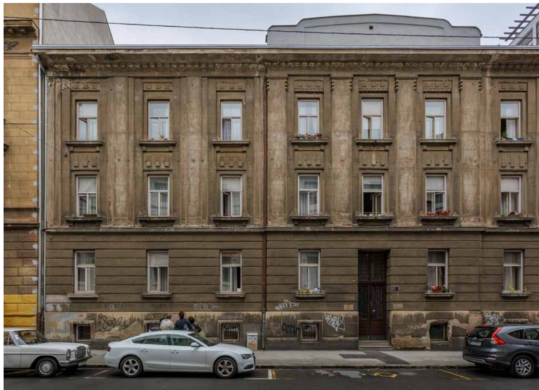
Južno ulično pročelje
