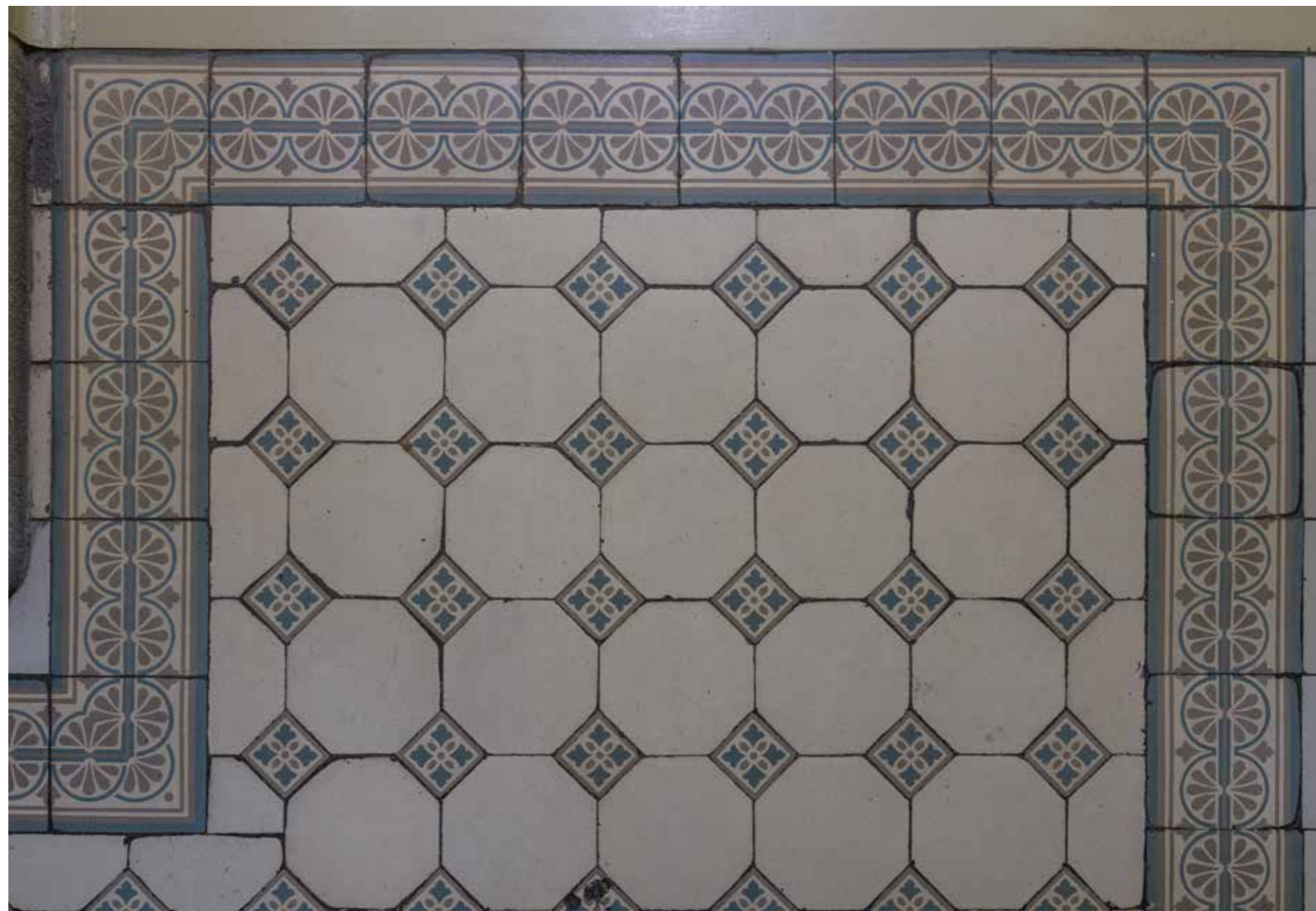
Popločenje podesta u stubištu
