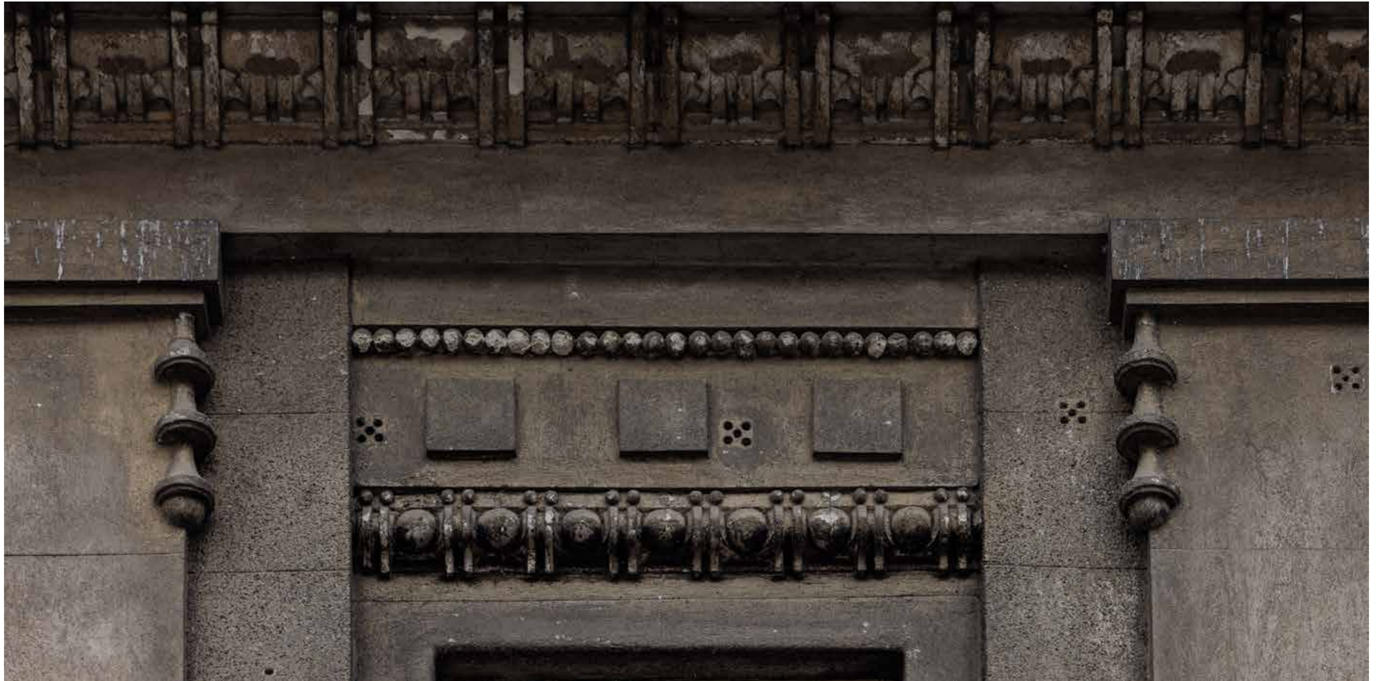
Južno pročelje, detalj secesijske arhitektonske plastike i dekoracije
