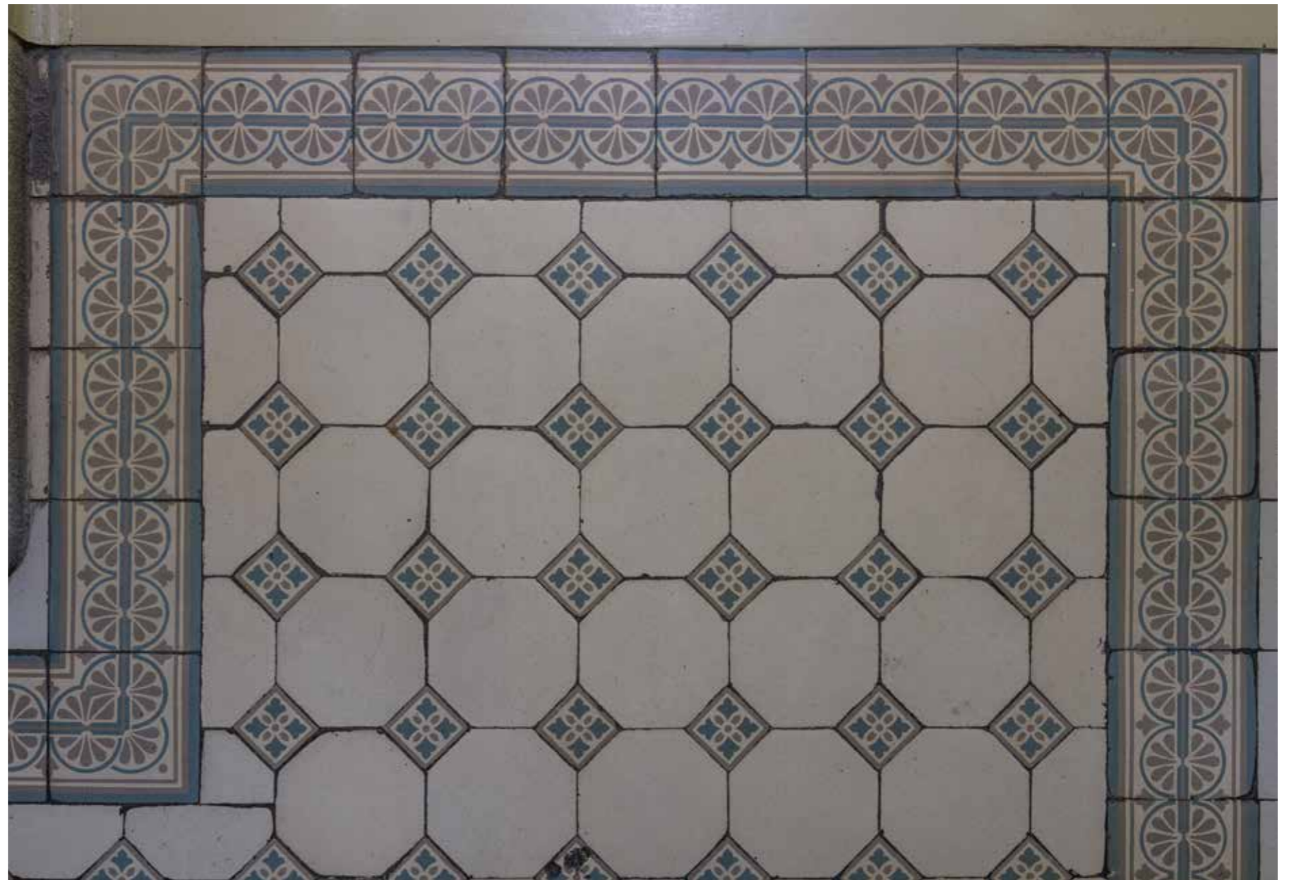
Popločenje podesta u stubištu
