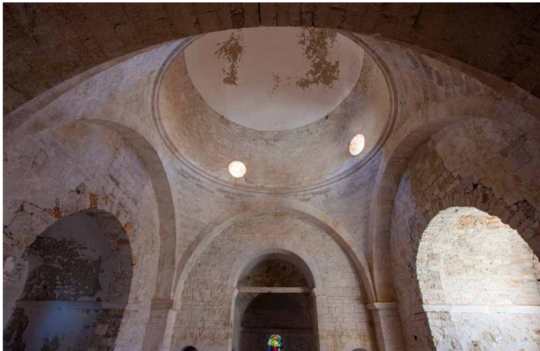
Romanička crkva, pogled na kupolu
