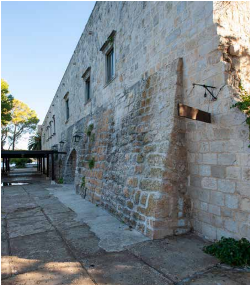
Zapadno krilo, zapadno pročelje s naknadno podignutim potpornim zidom
