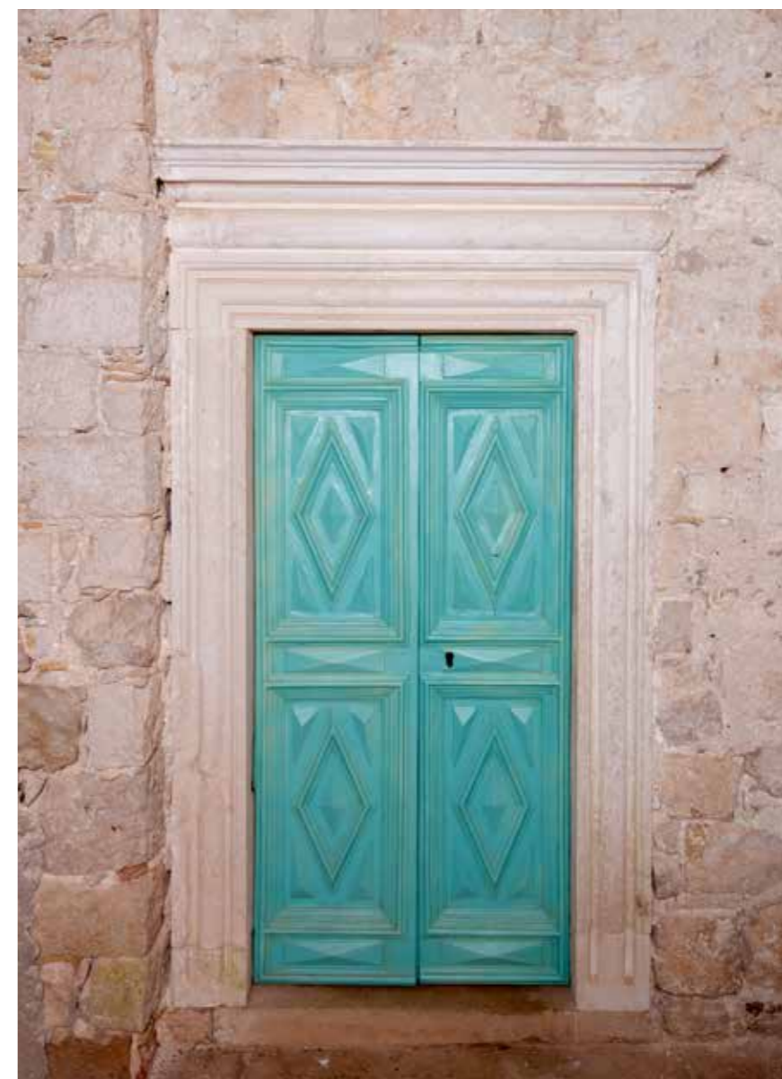
Portal između južne kapele i sakristije s baroknim vratnicama
