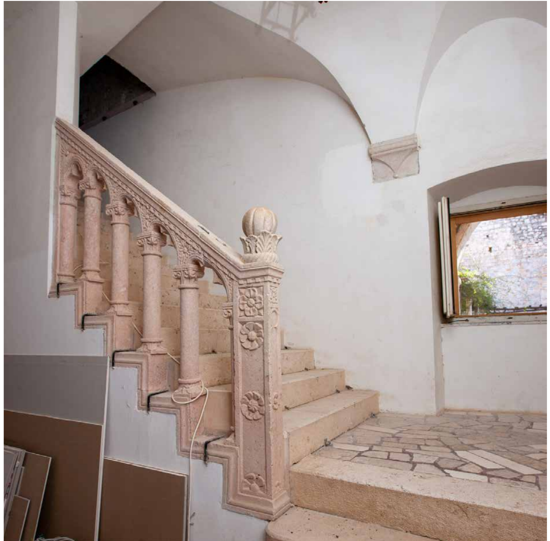
Zapadno krilo, stubište na srednjoj razini
