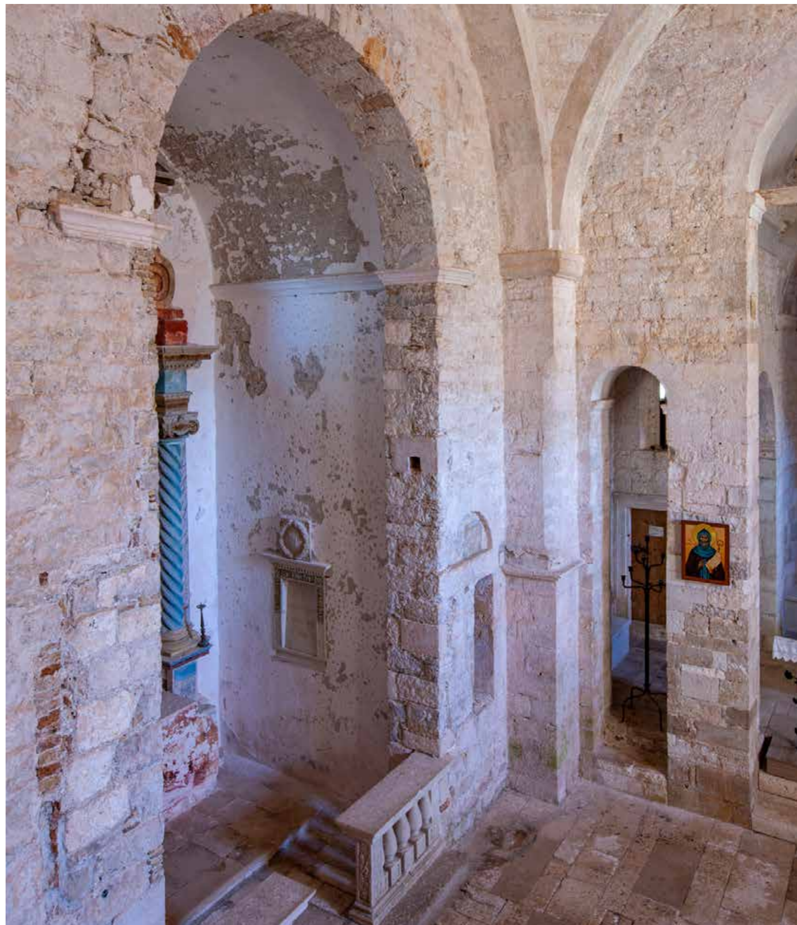
Sjeverna barokna bočna kapela
