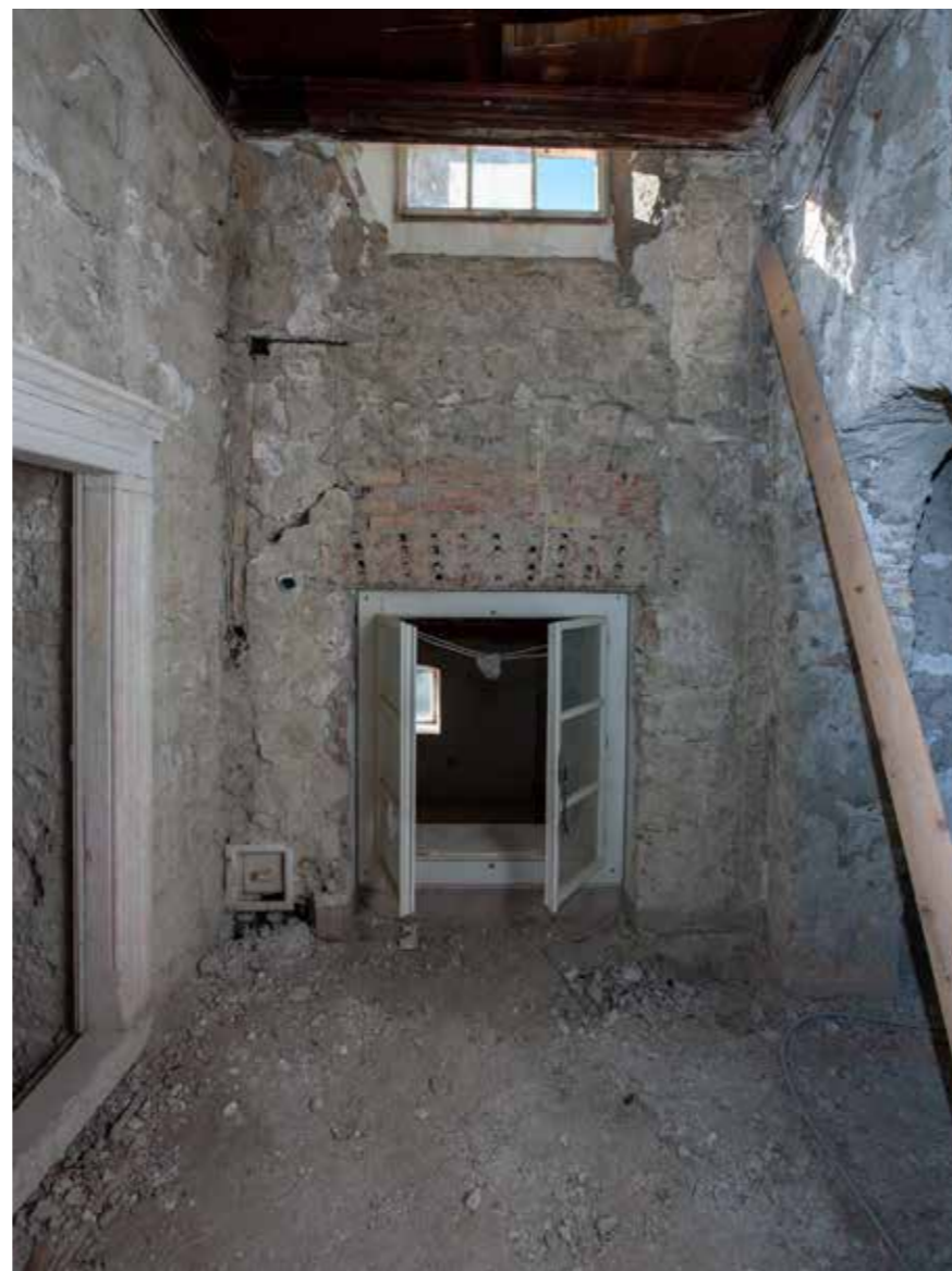
Središnji hodnik, pogled prema južnoj strani sa zazidanim lučnim otvorom
