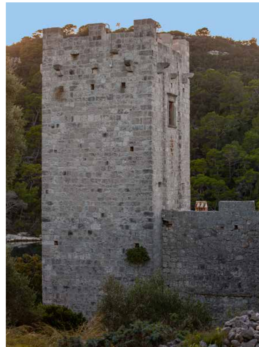
Jugoistočna kula, istočno i sjeverno pročelje
