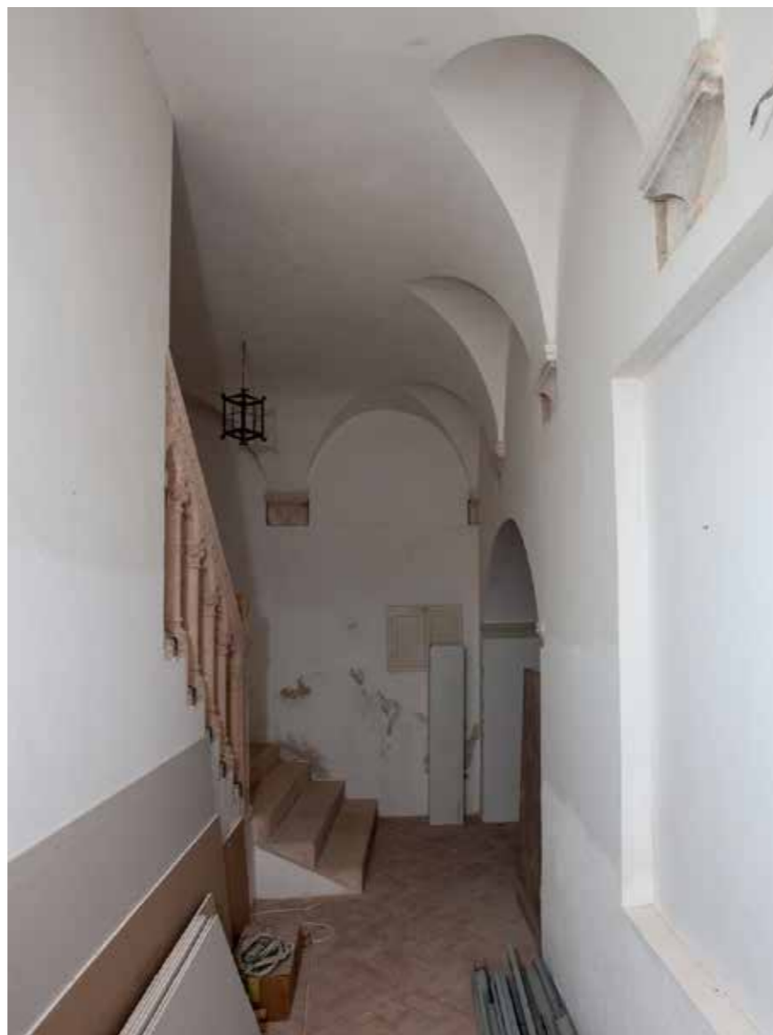
Svodovi uz stubište, detalji
