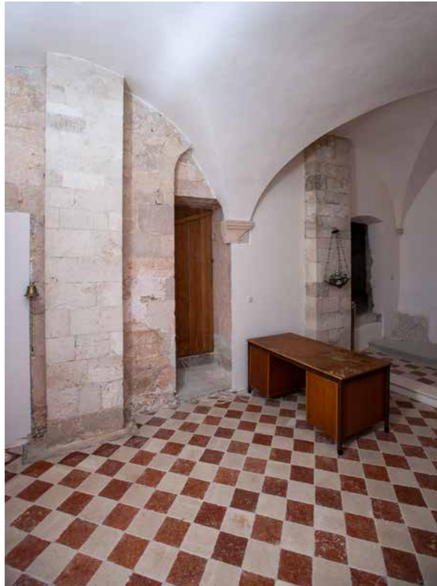
Sakristija, pogled na južno pročelje crkve
