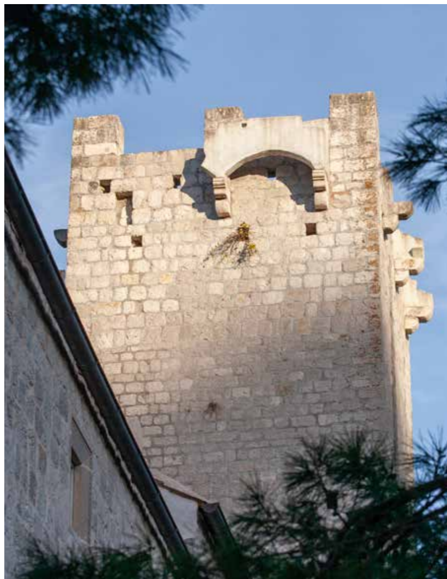
Jugoistočna kula, ostatci obrambenog kruništa (breteše)
