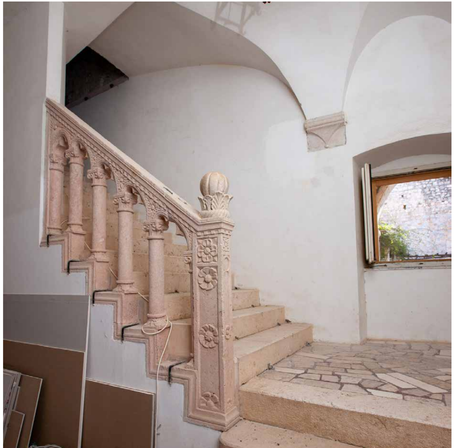
Zapadno krilo, stubište na srednjoj razini
