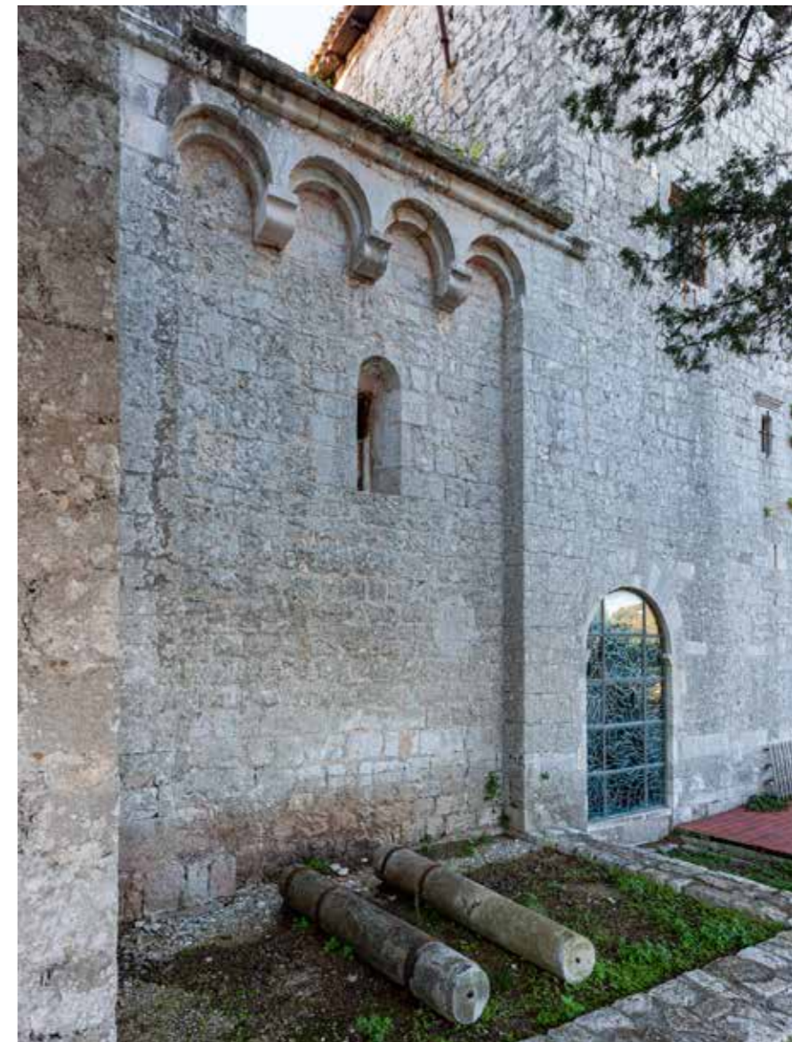
Sjeverno pročelje ulaznog prostora crkve
