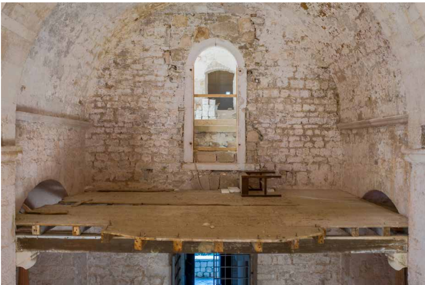
Pjevalište, stanje tijekom restauracije ograde
