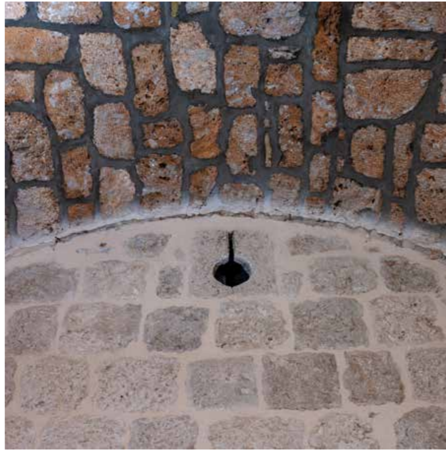
Strijelnica pod svodom najjužnijeg traveja trijema
