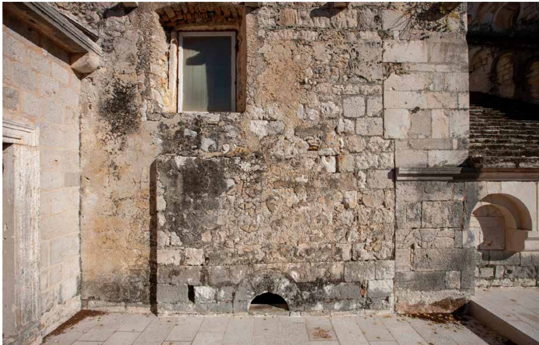
Gotički zvonik, južno pročelje s tragovima faza gradnje
