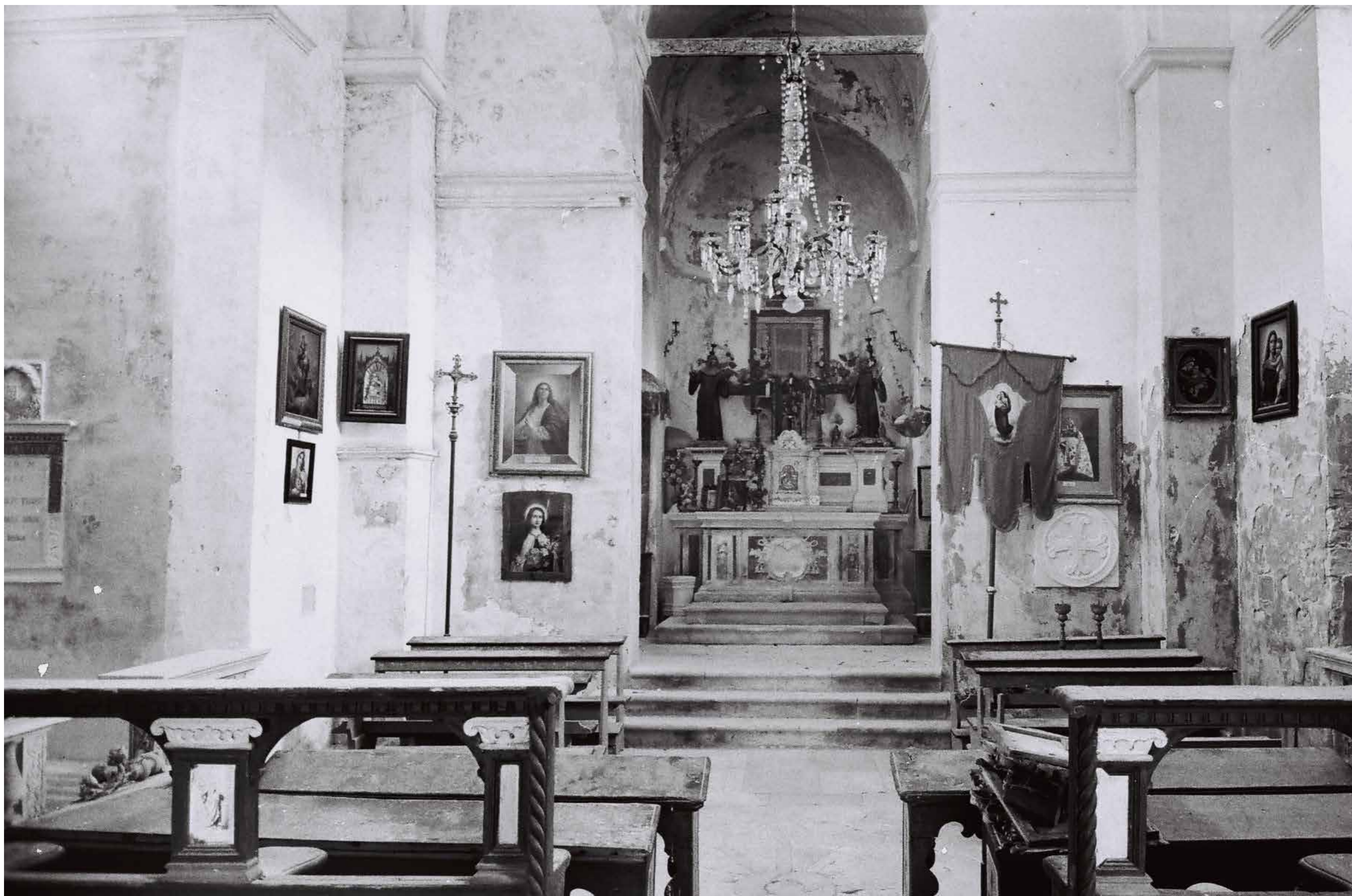
Pogled na svetište s glavnim oltarom prije demontaže, foto: Jerko Marasović, 1948.
