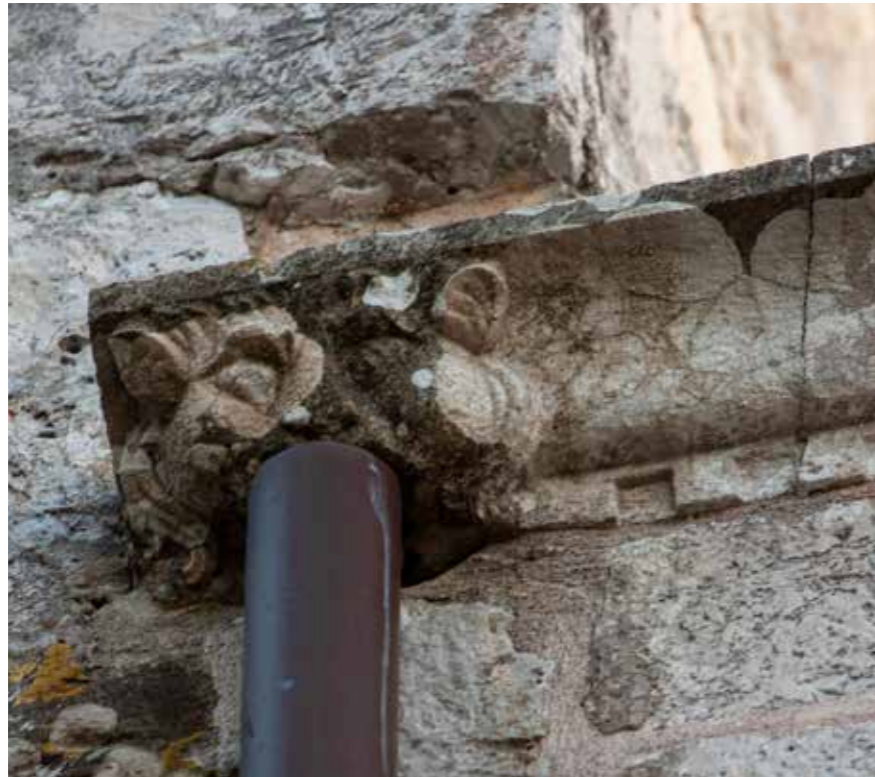
Maskeron na potkrovnom vijencu sjevernog pročelja ulaznog trakta s trijemom
